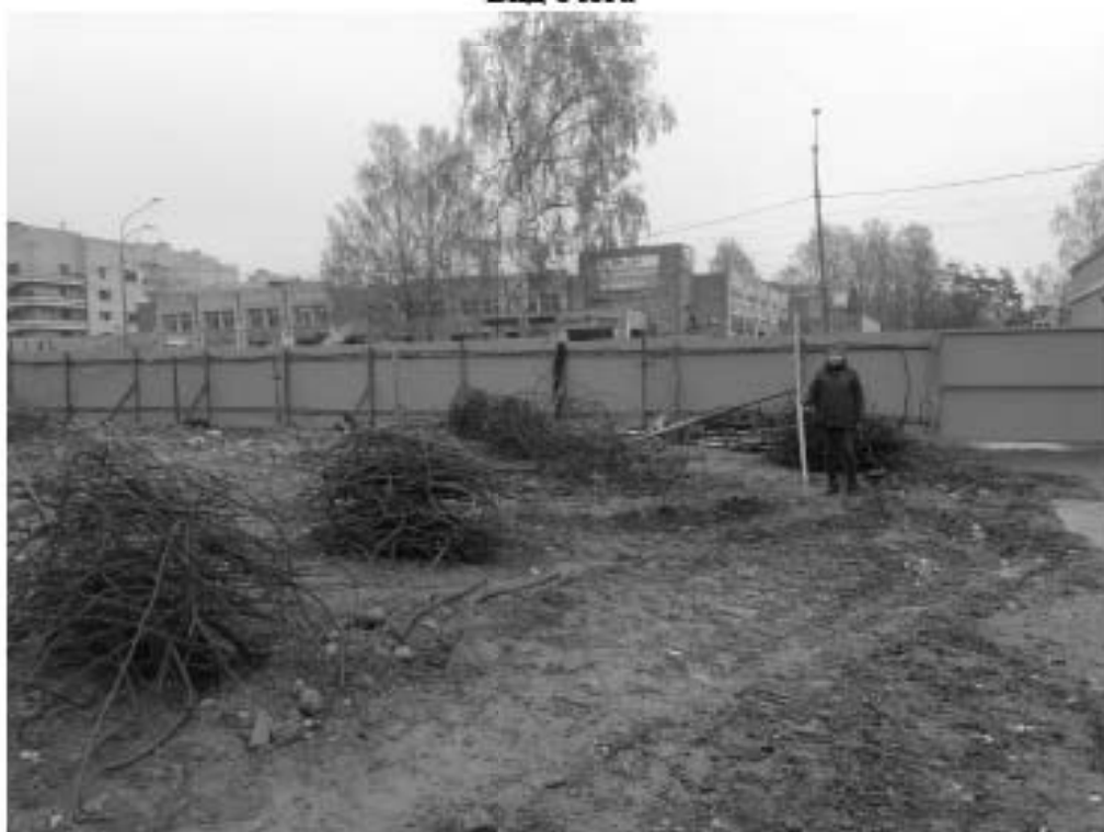
Рис. 17. г. Санкт-Петербург, Курортный район, г. Зеленогорск. Участок с кадастровым номером 78:38:0022464:1148 Точка фотофиксации 2 Общий вид на территорию демонтажа бетонной постройки Вид с запада
