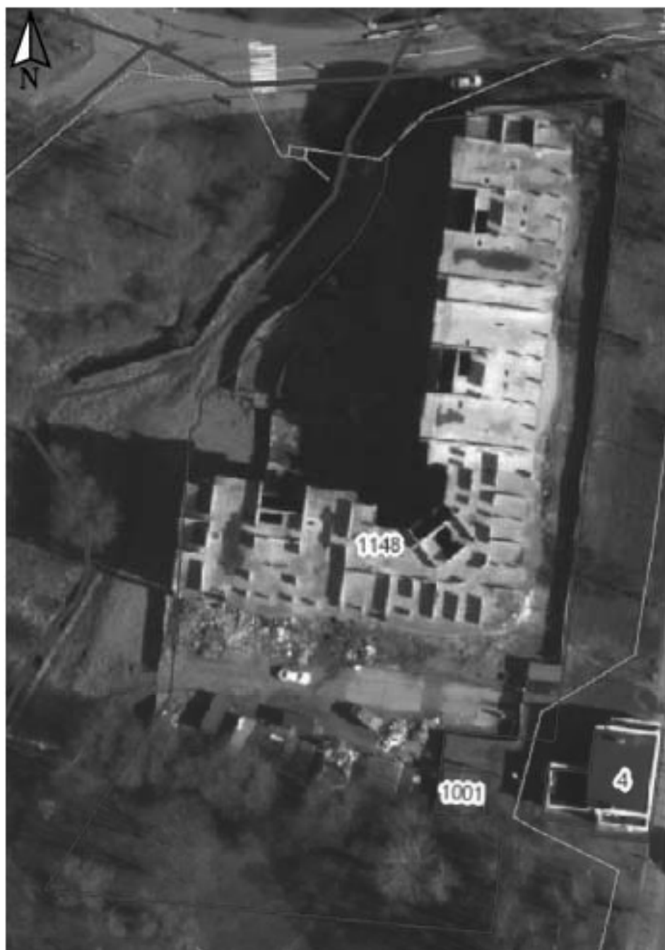
Рис. 3. г. Санкт-Петербург, Курортный район, г. Зеленогорск. Участок с кадастровым номером 78:38:0022464:1148 на карте Росреестра (обозначен красной границей). Недостроенное здание по адресу пр. Ленина, д. 38, лит. А. Дата обращения 15.11.2022.
