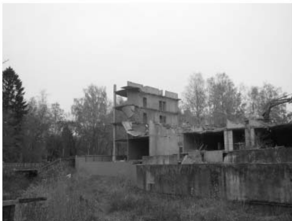
Рис. 20. г. Санкт-Петербург, Курортный район, г. Зеленогорск. Участок с кадастровым номером 78:38:0022464:1148 Точка фотофиксации 3. Общий вид на площадку демонтажа бетонной постройки Вид с северо-запада
