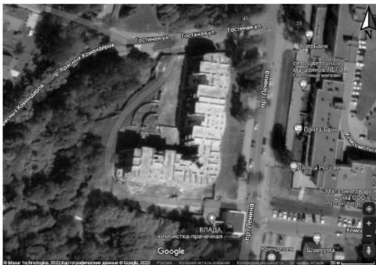
Рис. 4. г. Санкт-Петербург, Курортный район, г. Зеленогорск. Недостроенное здание по адресу пр. Ленина, д. 38, лит. А на карте Google/ Дата обращения 15.11.2022.
