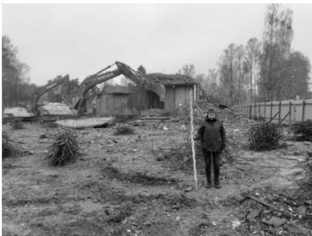
Рис.16. г. Санкт-Петербург, Курортный район, г. Зеленогорск. Участок с кадастровым номером 78:38:0022464:1148 Точка фотофиксации 2 Общий вид на территорию демонтажа бетонной постройки Вид с юга
