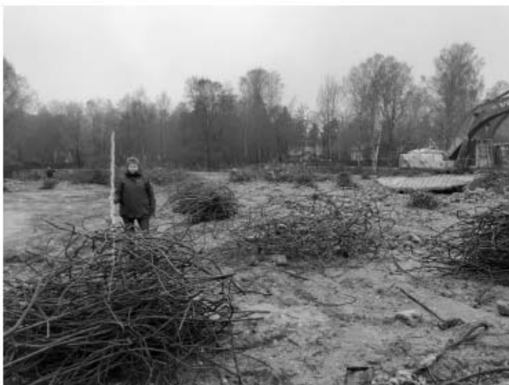
Рис. 18. г. Санкт-Петербург, Курортный район, г. Зеленогорск. Участок с кадастровым номером 78:38:0022464:1148 Точка фотофиксации 2 Общий вид на территорию демонтажа бетонной постройки Вид с востока
