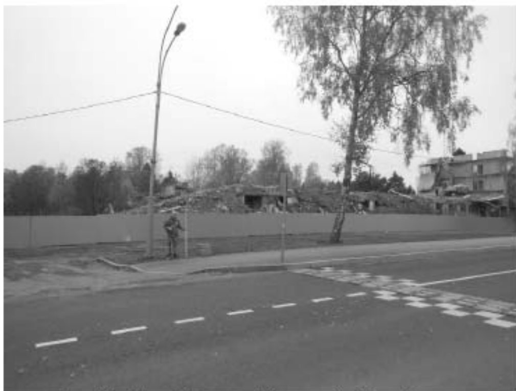
Рис. 14. г. Санкт-Петербург, Курортный район, г. Зеленогорск. Участок с кадастровым номером 78:38:0022464:1148 Точка фотофиксации 1 Общий вид на территорию демонтажа бетонной постройки Вид с востока
