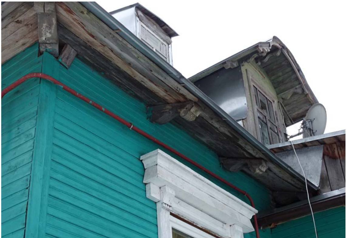
Илл. 24. Юго-западный фасад. Фрагмент. Фотография 2021 г.
