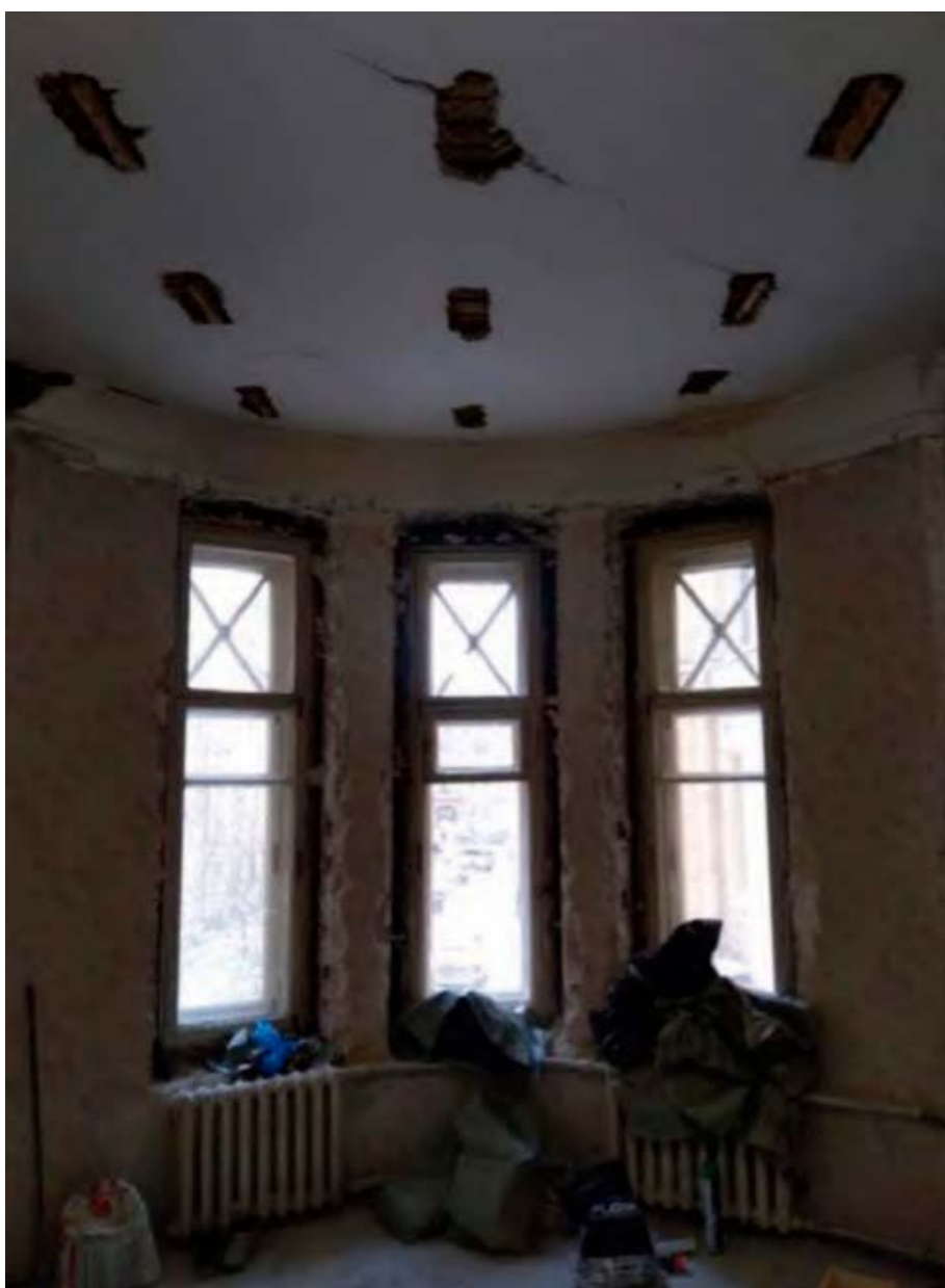
7. Помещение №6 квартиры №72 в уровне 2-го этажа объекта культурного наследия регионального значения «Дом, где в 1917 г. жил Джон Рид», расположенного по адресу: г. Санкт-Петербург, ул. Рубинштейна, д. 23, литера А. 10.09.2021.
