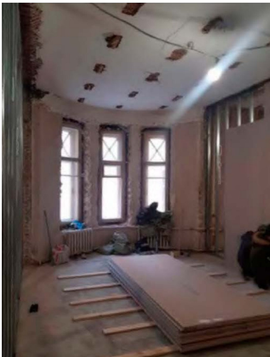
6. Помещение №6 квартиры №72 в уровне 2-го этажа объекта культурного наследия регионального значения «Дом, где в 1917 г. жил Джон Рид», расположенного по адресу: г. Санкт-Петербург, ул. Рубинштейна, д. 23, литера А. 10.09.2021.
