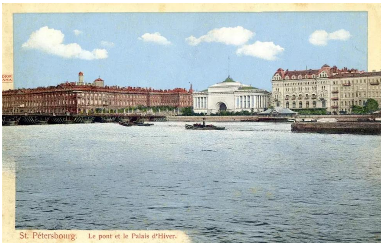
Илл. 13. Дворцовый мост и Адмиралтейская набережная. 1902-1908 гг. (источник: https://pastvu.com/p/182491 ).
