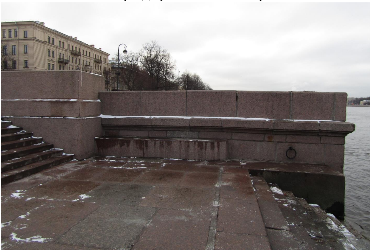
Фото 6. Вид на промежуточную площадку лестничных маршей объекта культурного наследия федерального значения «Спуск Дворцовый со львами и пристанью».
