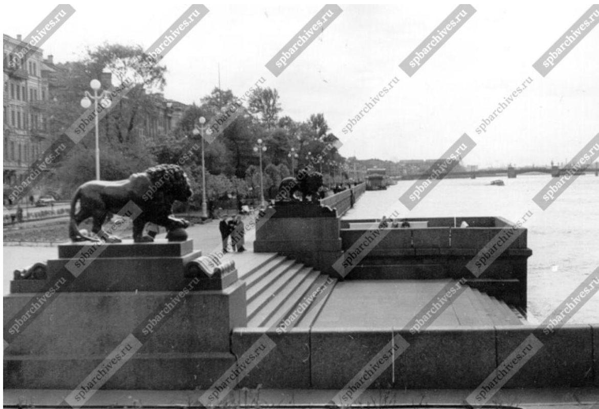
Илл. 23. Дворцовый гранитный спуск на Адмиралтейской набережной (1820-1824 гг, инженер А.Д. Готман, 1832 г. - скульптуры львов и постаменты, архитектор Л.И. Шарлемань). Конец 1950-х – начало 1960-х (источник: ЦГАКФФД СПб. Фотодокумент Ар 198194).
