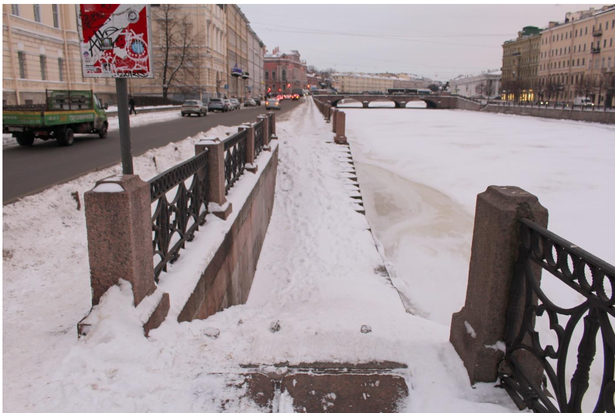
Фото 5. Вид на лестничные марши и нижнюю площадку спуска № 2 с севера.
