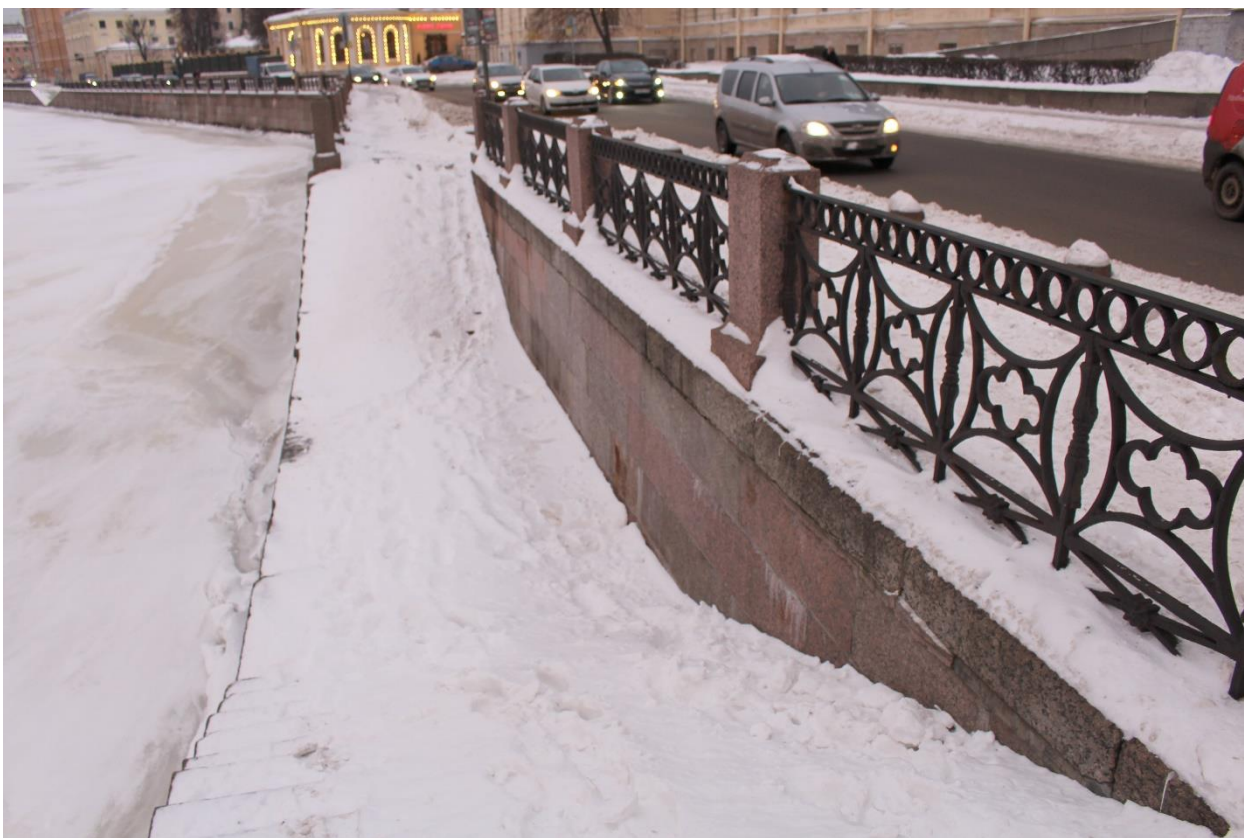
Фото 9. Вид на подпорную стенку и нижнюю площадку спуска № 2 с юга.
