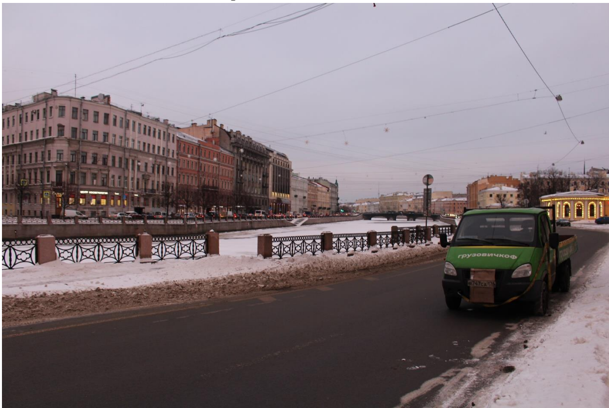
Фото 1. Вид на правобережный спуск № 2 объекта культурного наследия федерального значения «Набережные со спусками» с юго-востока.
