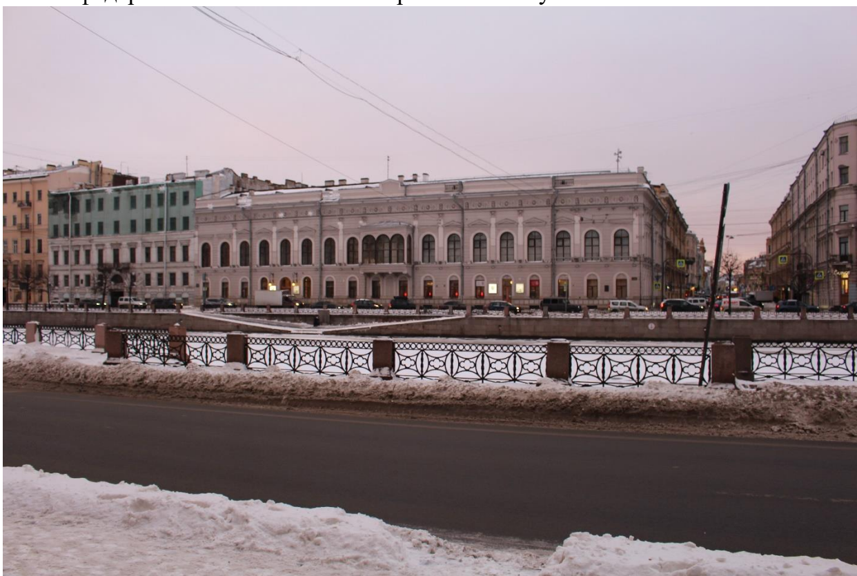
Фото 2. Вид на правобережный спуск № 2 объекта культурного наследия федерального значения «Набережные со спусками» с востока.
