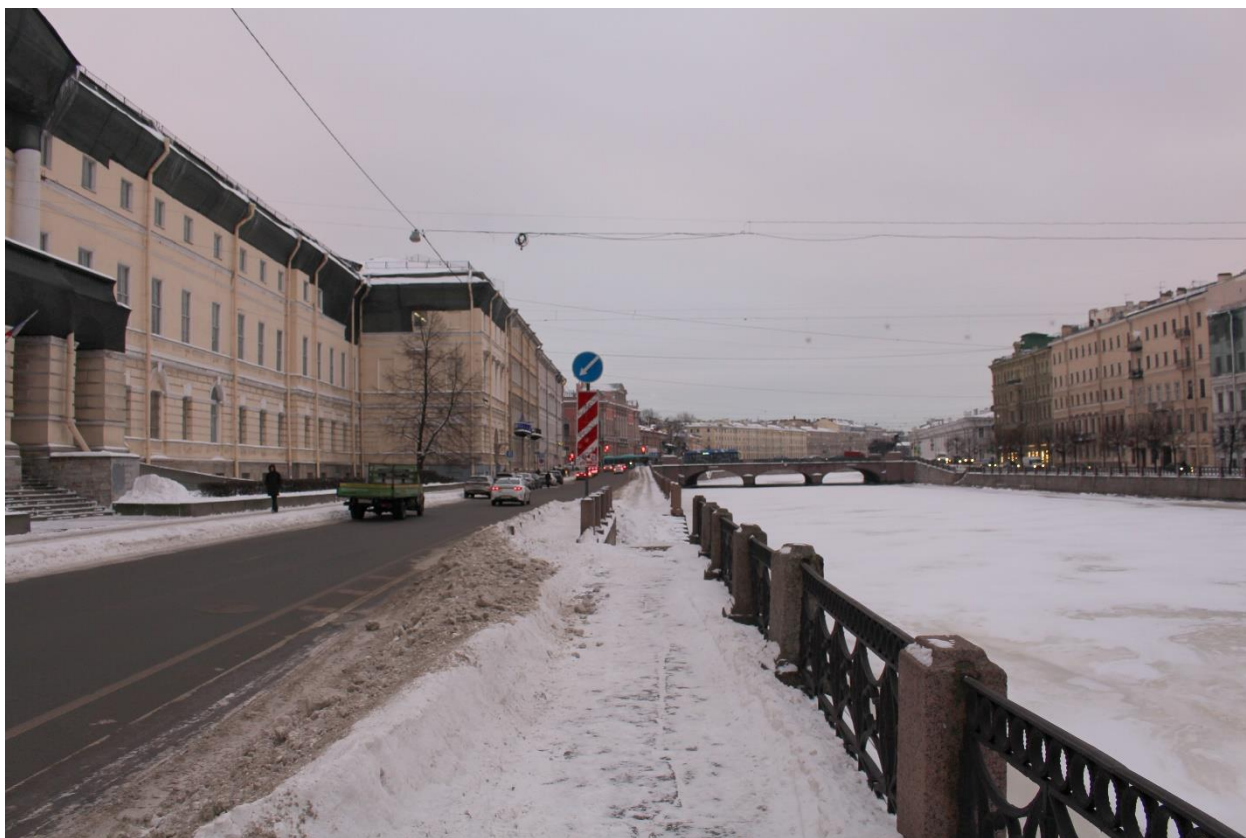
Фото 3. Вид на правобережный спуск № 2 объекта культурного наследия федерального значения «Набережные со спусками» с севера.
