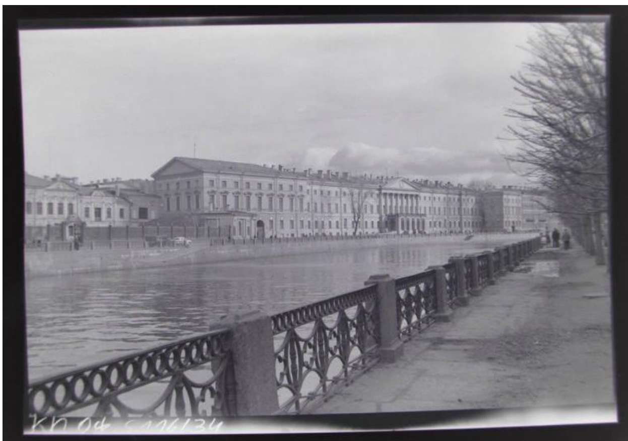
Илл. 25. Екатерининский институт. Вид на главный фасад с набережной. 1970-е гг. (источник: госкаталог.рф № 10872307).
