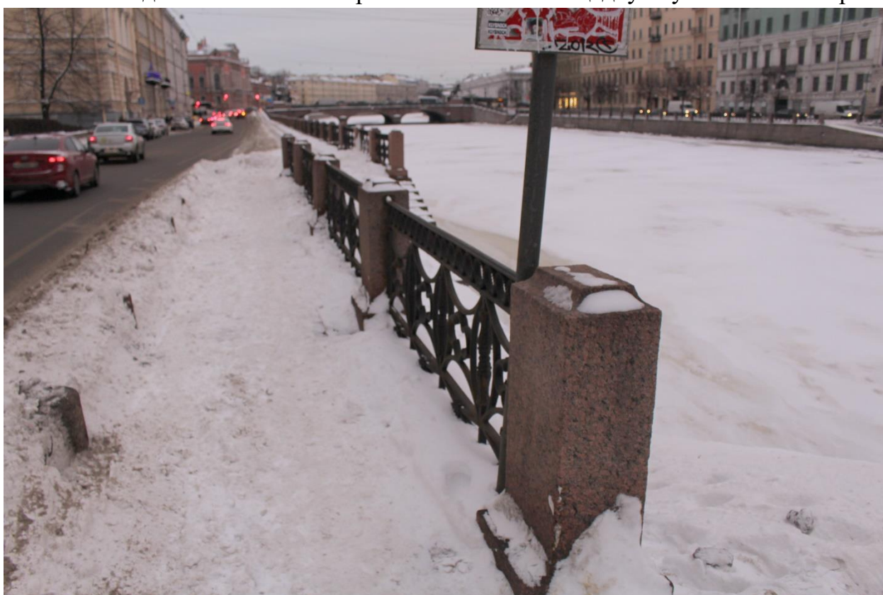
Фото 6. Вид на ограждение спуска № 2 с севера.
