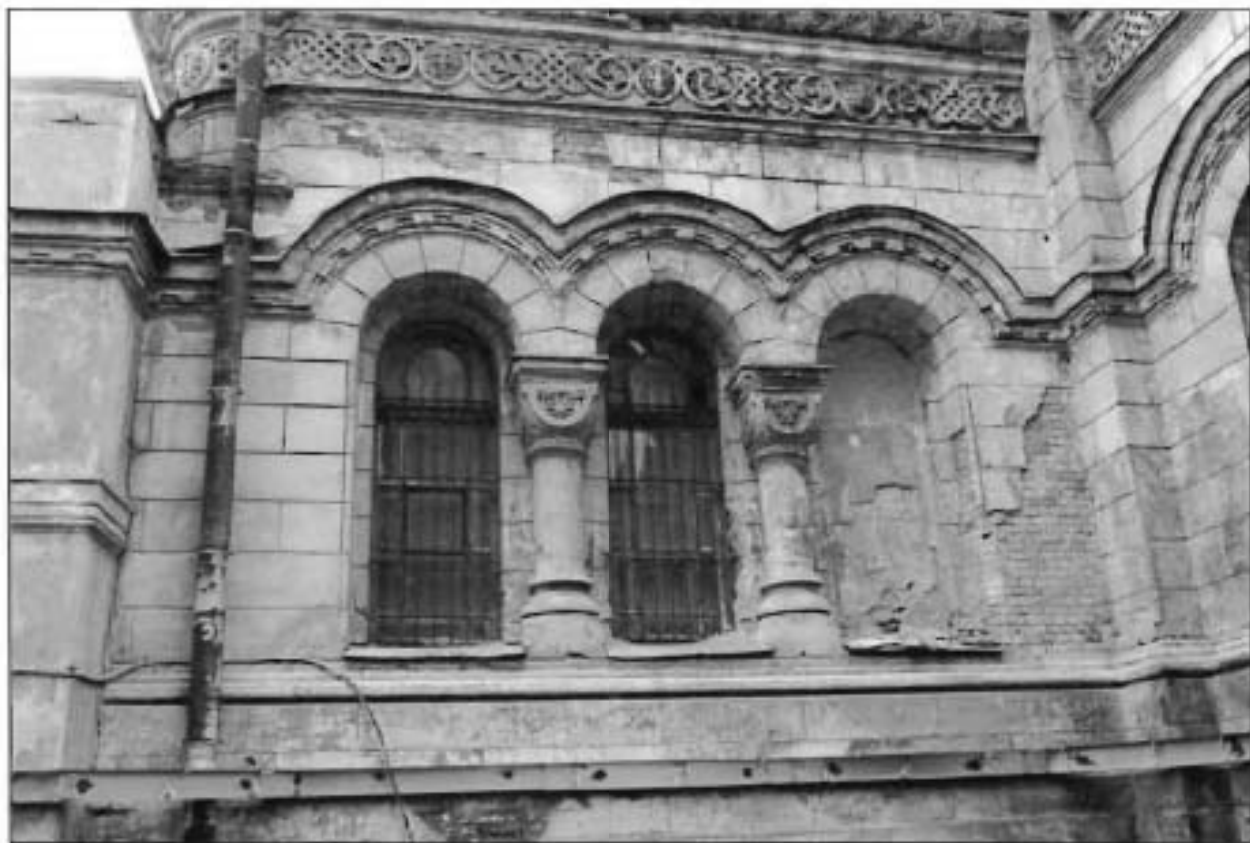
9. Западный фасад. Фрагмент.
