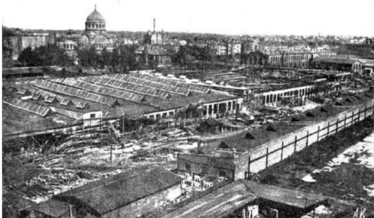
Илл. 70 Строительство нового цеха на заводе «Севкабель». 1930-е гг. // ЦГА КФФД СПб. Шифр: Вр 815.
