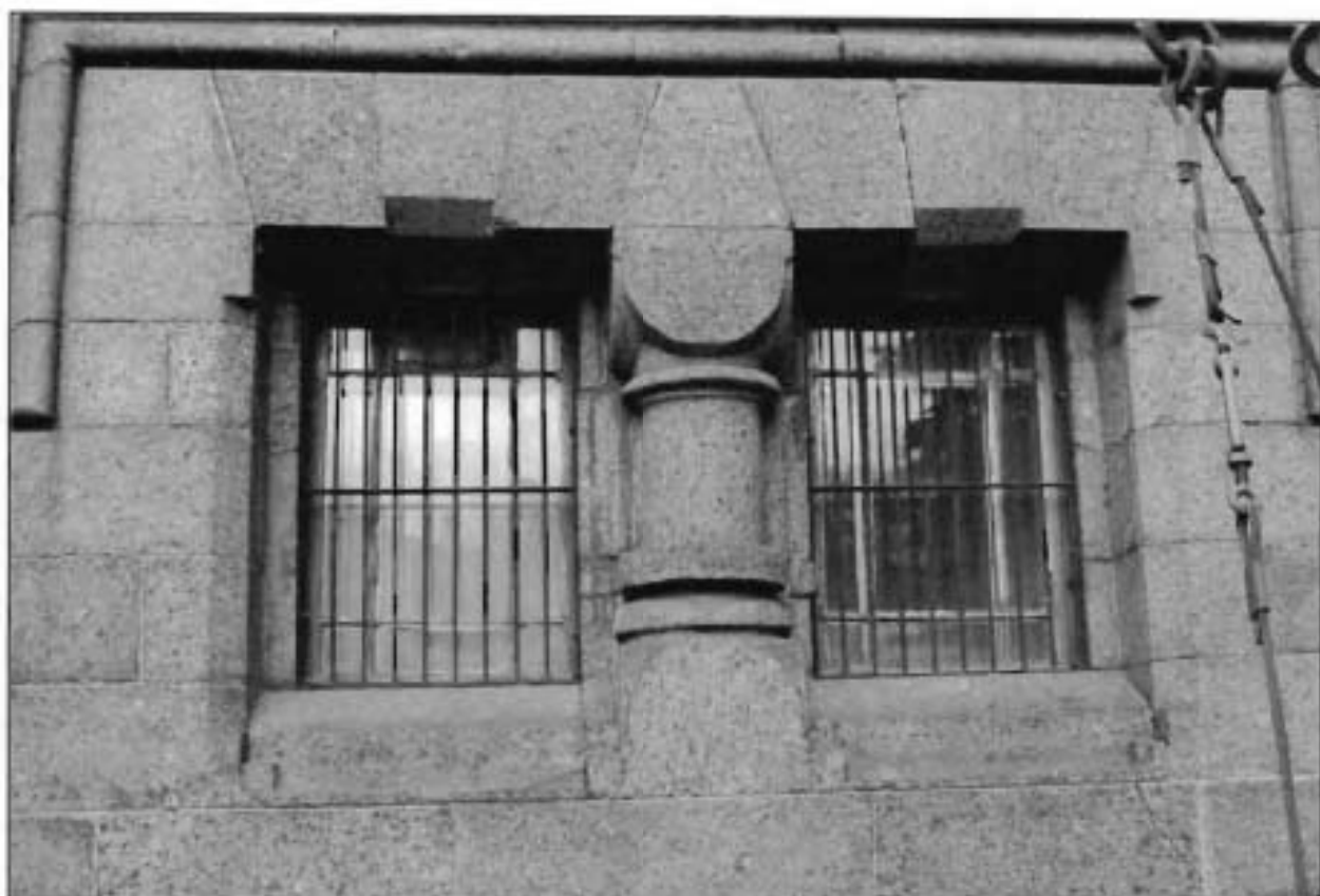
8. Южный фасад. Фрагмент. Окна притвора первого яруса.
