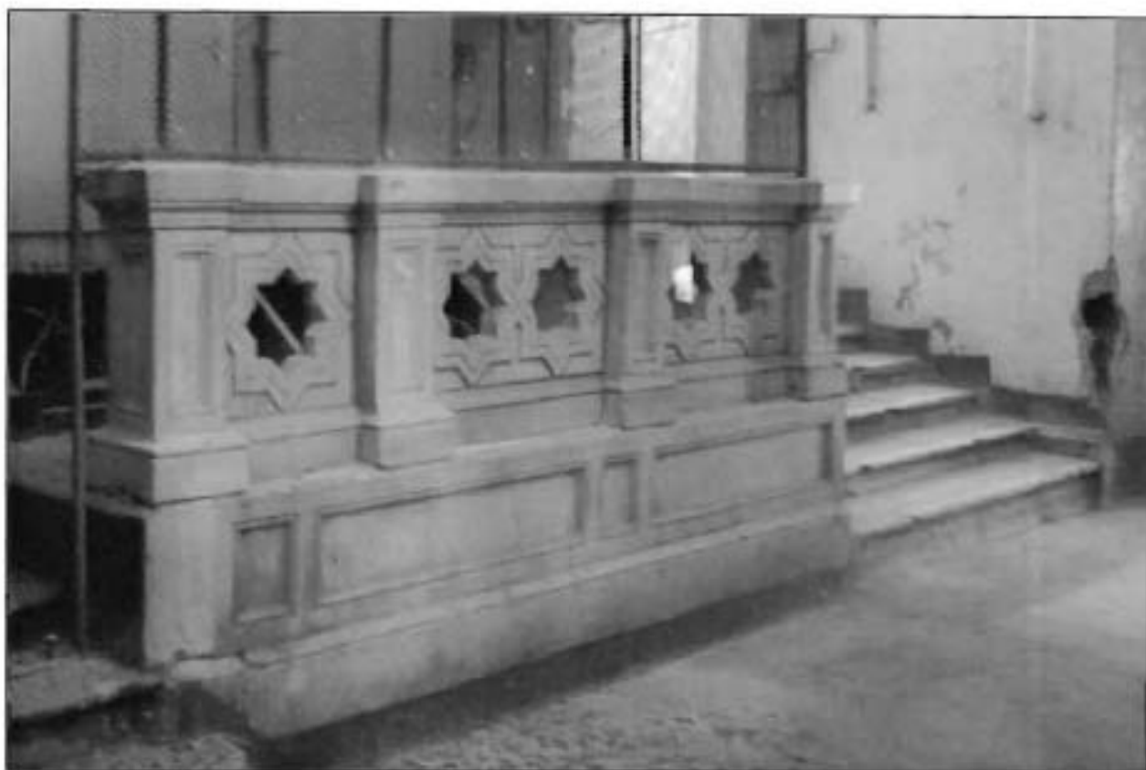
14. Интерьер. Фрагмент. Солея с ограждением.
