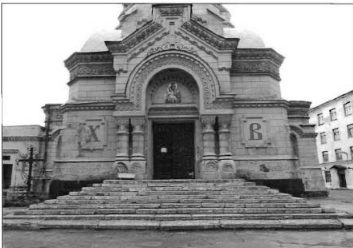
5. Западный фасад. Фрагмент.
