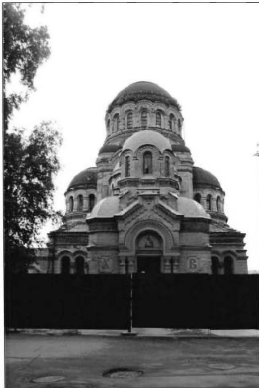
1. Западный фасад. Общий вид.
