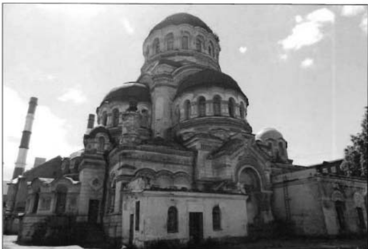
2. Общий вид с северо-востока.
