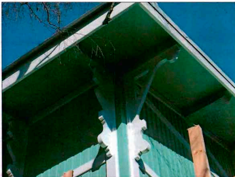
Фото 3. Южный фасад. Фрагмент. Кронштейны венчающего карниза.
