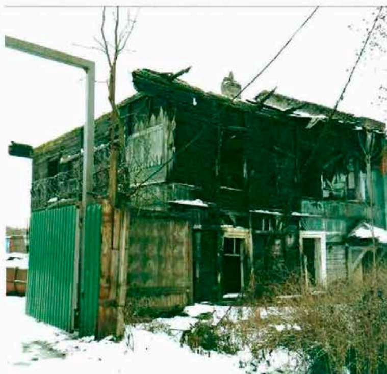
Фото 4. Северный и западный фасад.
