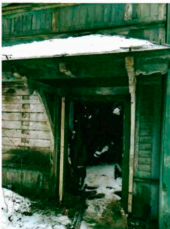
Фото 3. Крыльцо западного фасада.
