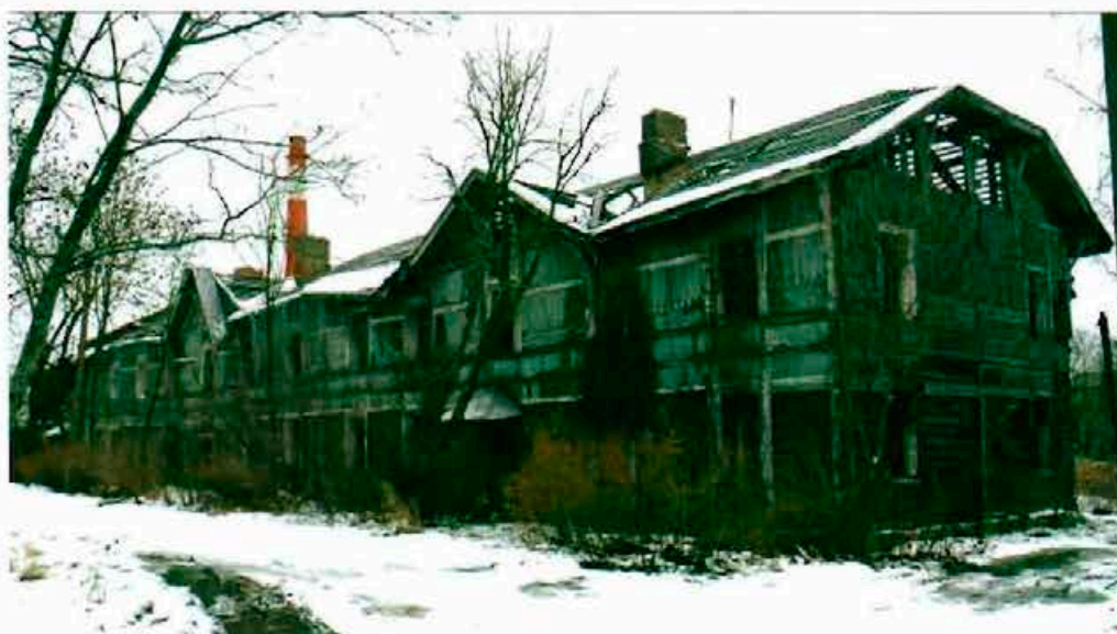
Фото 1. Южный и западный фасад.
