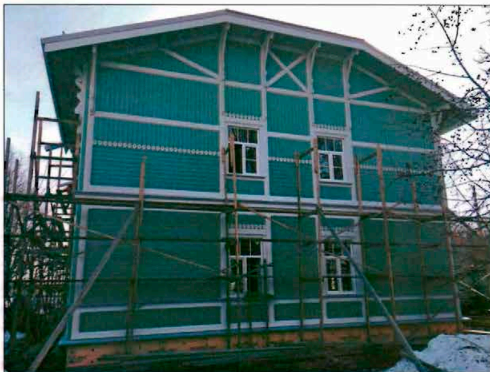
Фото 2. Южный фасад. Общий вид.
