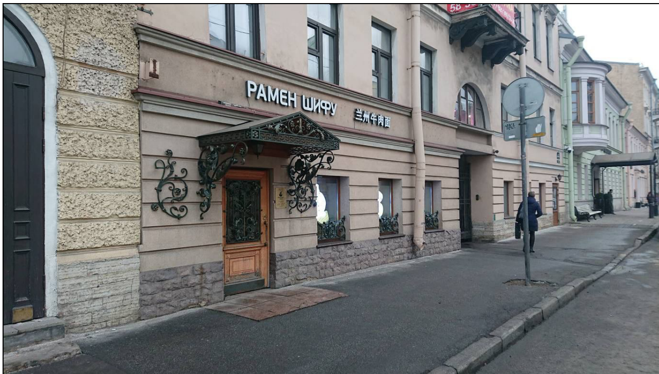
19. Фрагмент лицевого фасада здания («Дом И.М. Барышева») со стороны 8-й линии В.О.
