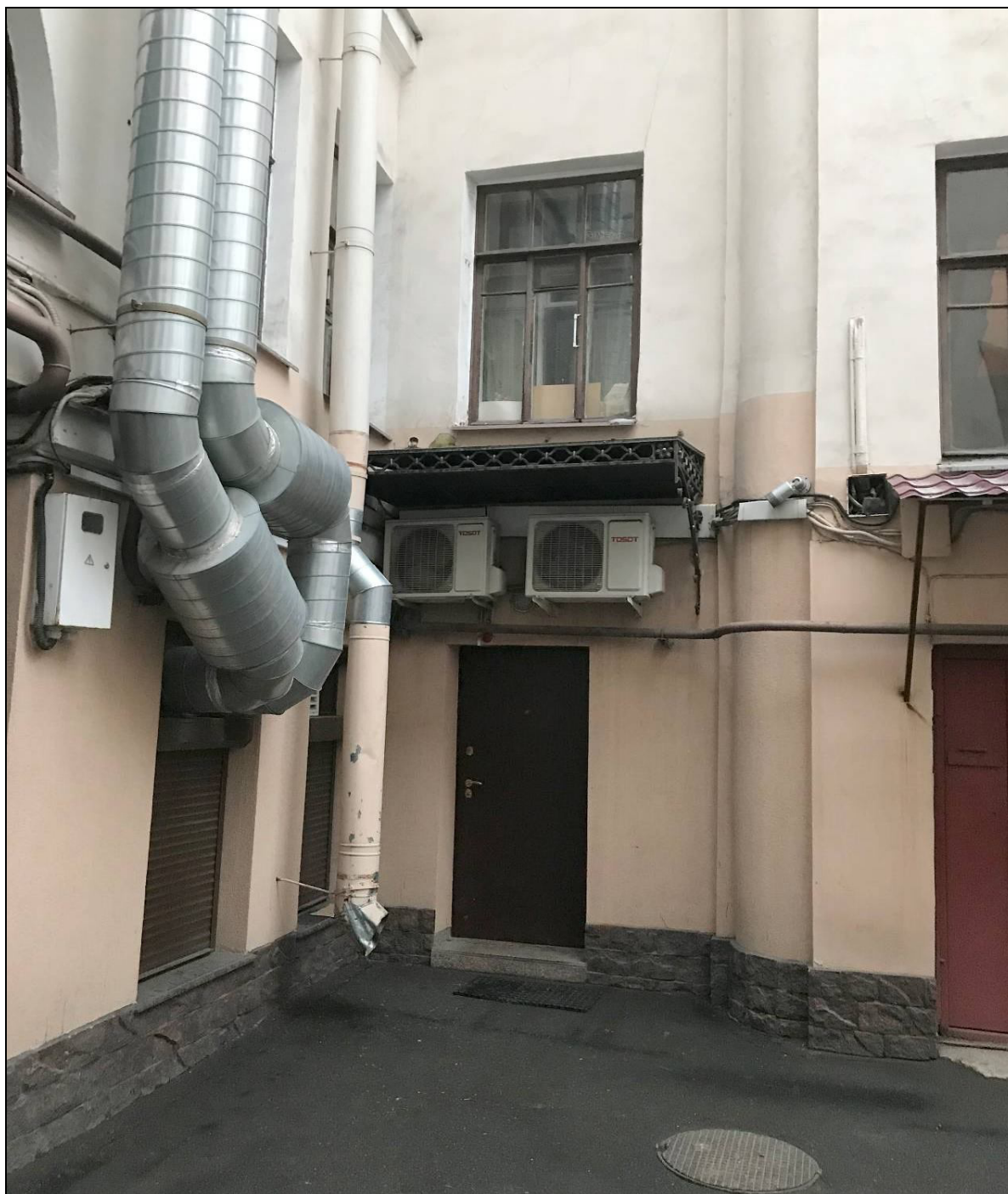
6. Дворовый фасад лицевого флигеля и дворовой фасад дворового флигеля. Фрагмент. Входная дверь в нежилое помещение 1-Н. Дата съемки 29.10.2021 г.
