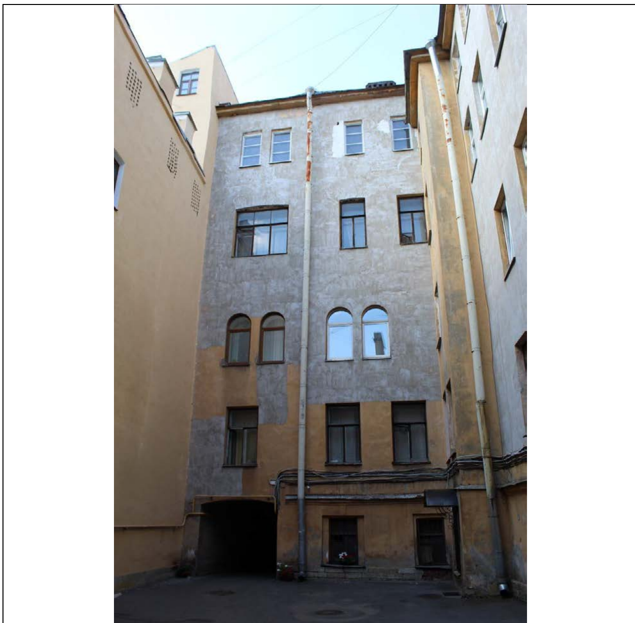
13. Дом А. Ф. Пеля. Шпалерная ул., 5. Северный двор. Дворовый фасад лицевого корпуса. Вид с юга. Фото: эксперт А. А. Кононов, 26.04.2021.
