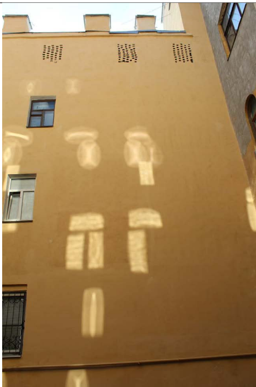
19. Дом А. Ф. Пеля. Шпалерная ул., 5. Северный двор. Западный фасад дворового флигеля здания по Шпалерной ул., 3. Фрагмент. Фото: эксперт А. А. Кононов, 26.04.2021.
