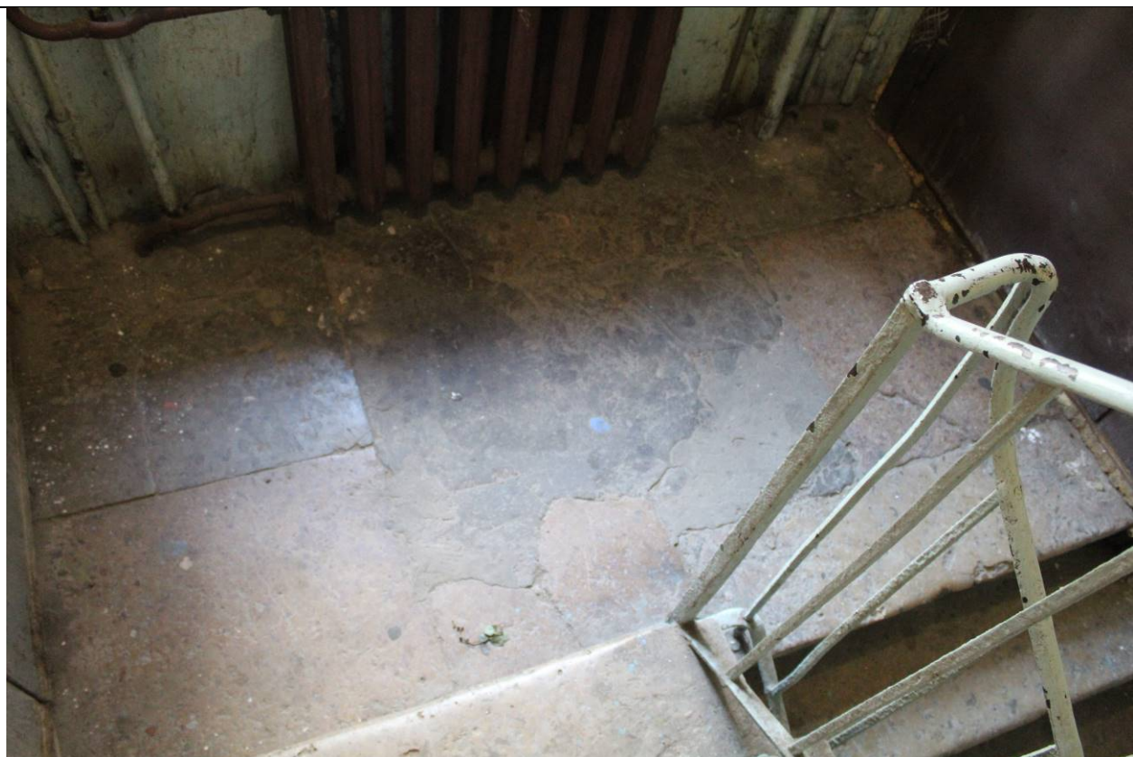
7. Дом А. Ф. Пеля. Шпалерная ул., 5. Южный двор. Юго-западный дворовый флигель. Площадка лестницы между 2 и 3 этажами. Фото: эксперт А. А. Кононов, 26.04.2021.
