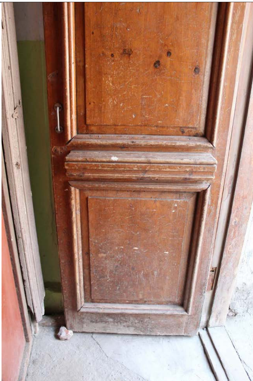
4. Дом А. Ф. Пеля. Шпалерная ул., 5. ЛК-1. Заполнение дверного проема. Фрагмент. Фото: эксперт А. А. Кононов, 26.04.2021.
