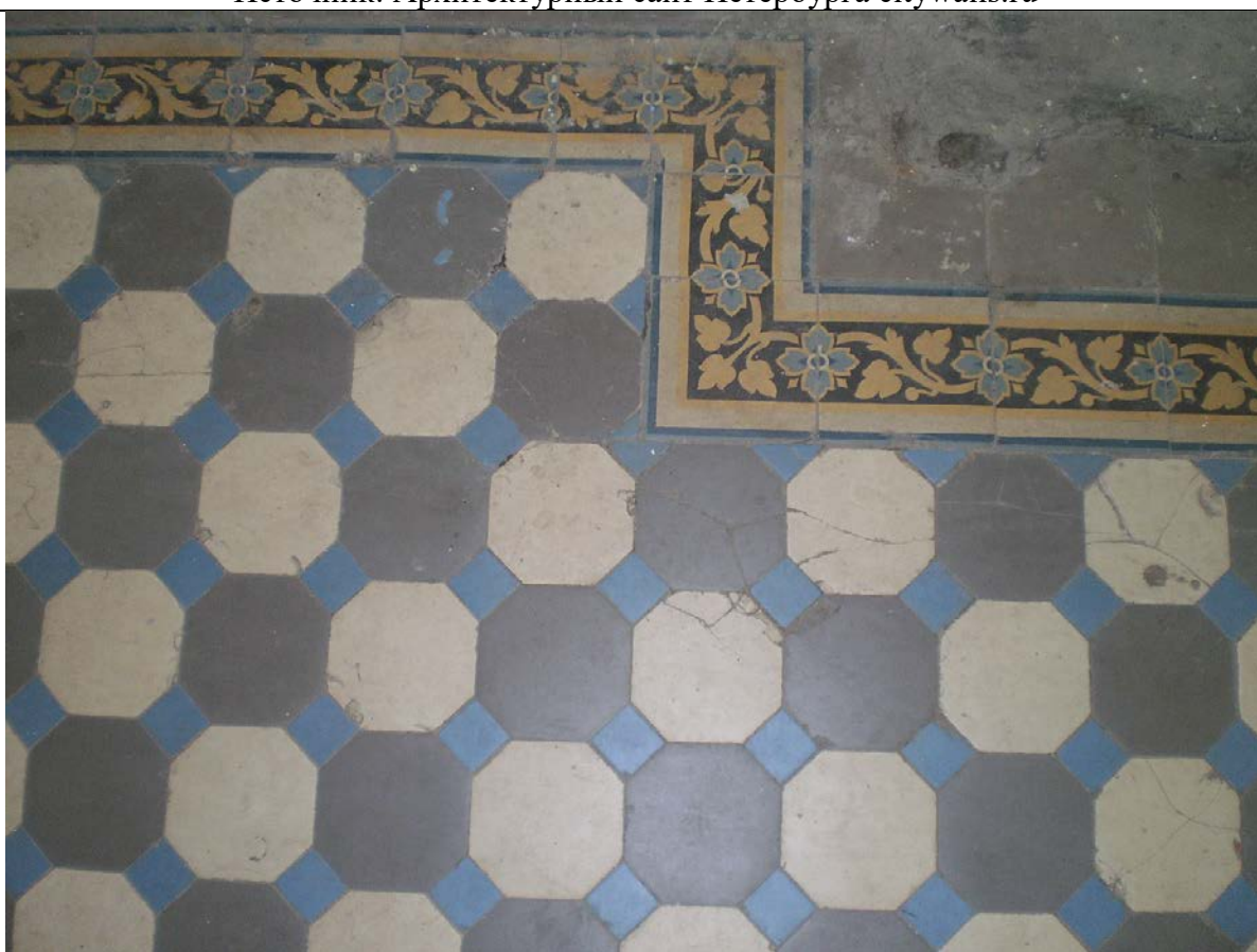
98. Дом по Шпалерной ул., д. 5. Парадная лестница. 2012. Источник: Архитектурный сайт Петербурга citywalls.ru
