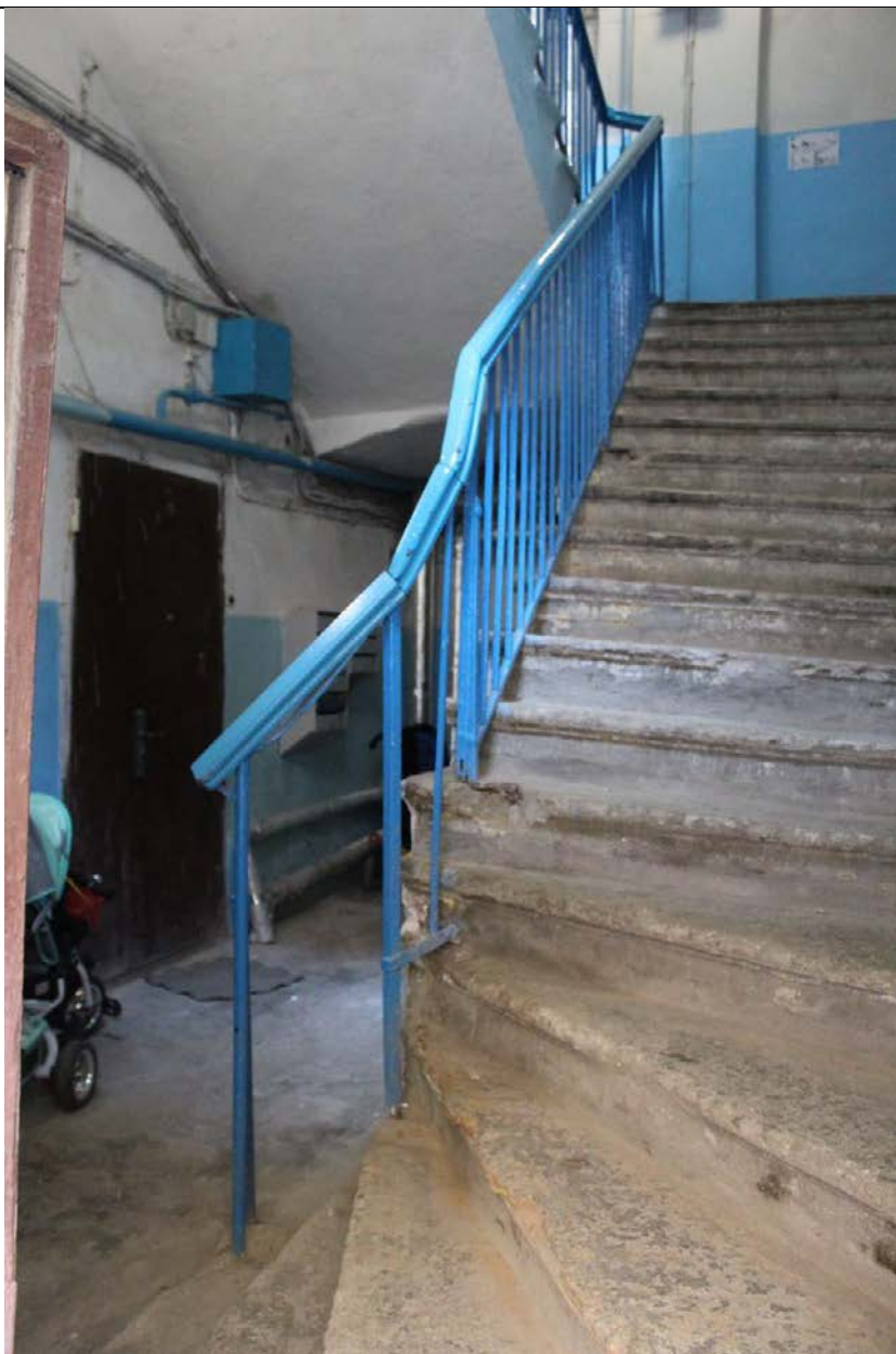
3. Дом А. Ф. Пеля. Шпалерная ул., 5. ЛК-2. Вид на площадку 1 этажа. Фото: эксперт А. А. Кононов, 26.04.2021.
