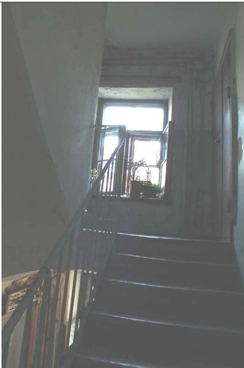
5. Дом А. Ф. Пеля. Шпалерная ул., 5. Южный двор. Юго-западный дворовый флигель. Лестничный марш между 2 и 3 этажами. Фото: эксперт А. А. Кононов, 26.04.2021.
