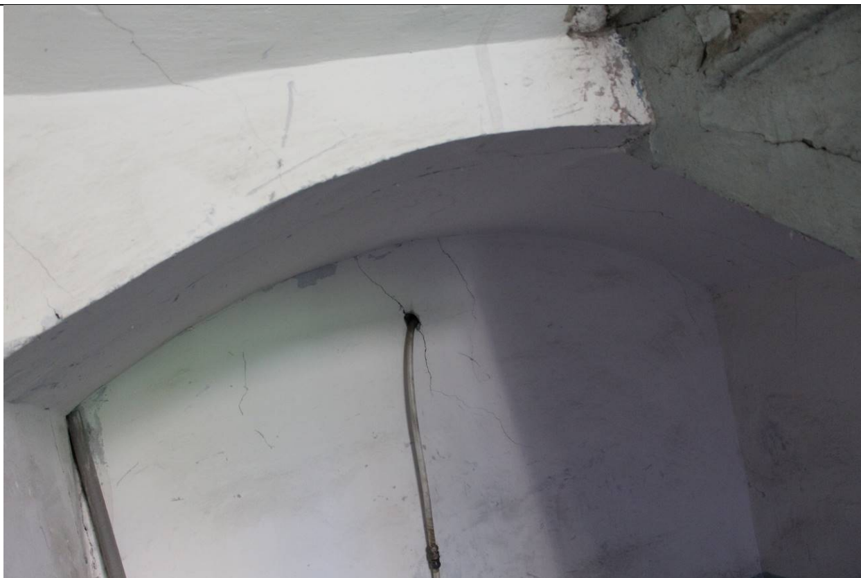
8. Дом А. Ф. Пеля. Шпалерная ул., 5. Южный двор. Юго-западный дворовый флигель. Своды перекрытия 2 этажа. Фото: эксперт А. А. Кононов, 26.04.2021.
