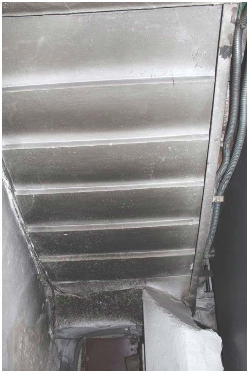
11. Дом А. Ф. Пеля. Шпалерная ул., 5. ЛК-1. Лестница по косоурам. Фото: эксперт А.А. Кононов, 26.04.2021.
