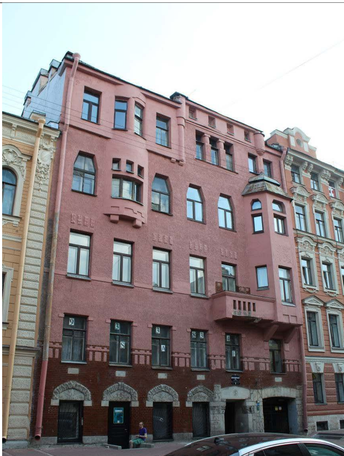
2. Дом А. Ф. Пеля. Шпалерная ул., 5. Общий вид с севера. Фото: эксперт А. А. Кононов, 26.04.2021.
