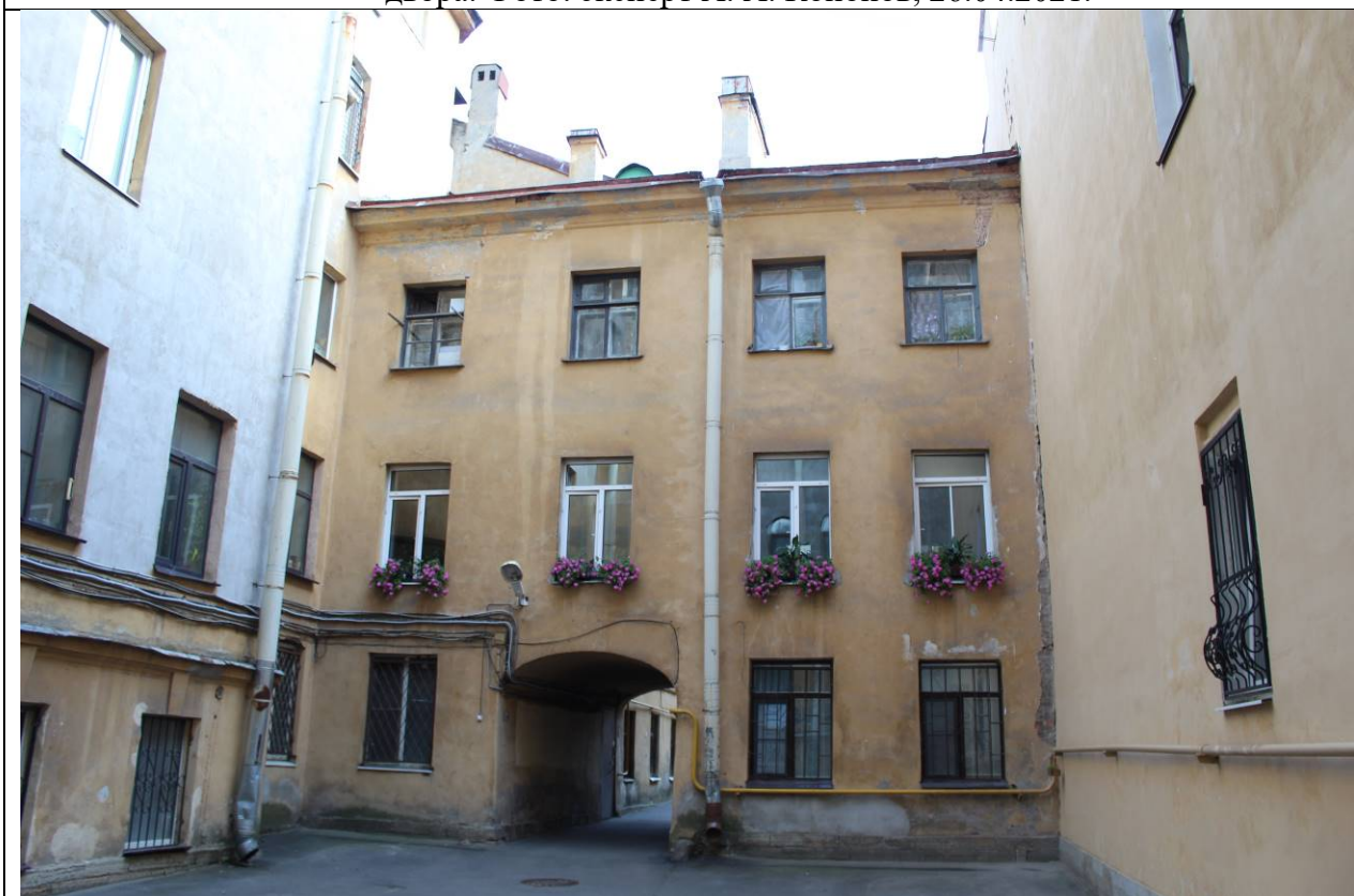
12. Дом А. Ф. Пеля. Шпалерная ул., 5. Северный двор. Центральный дворовый флигель. Общий вид. Фото: эксперт А. А. Кононов, 26.04.2021.
