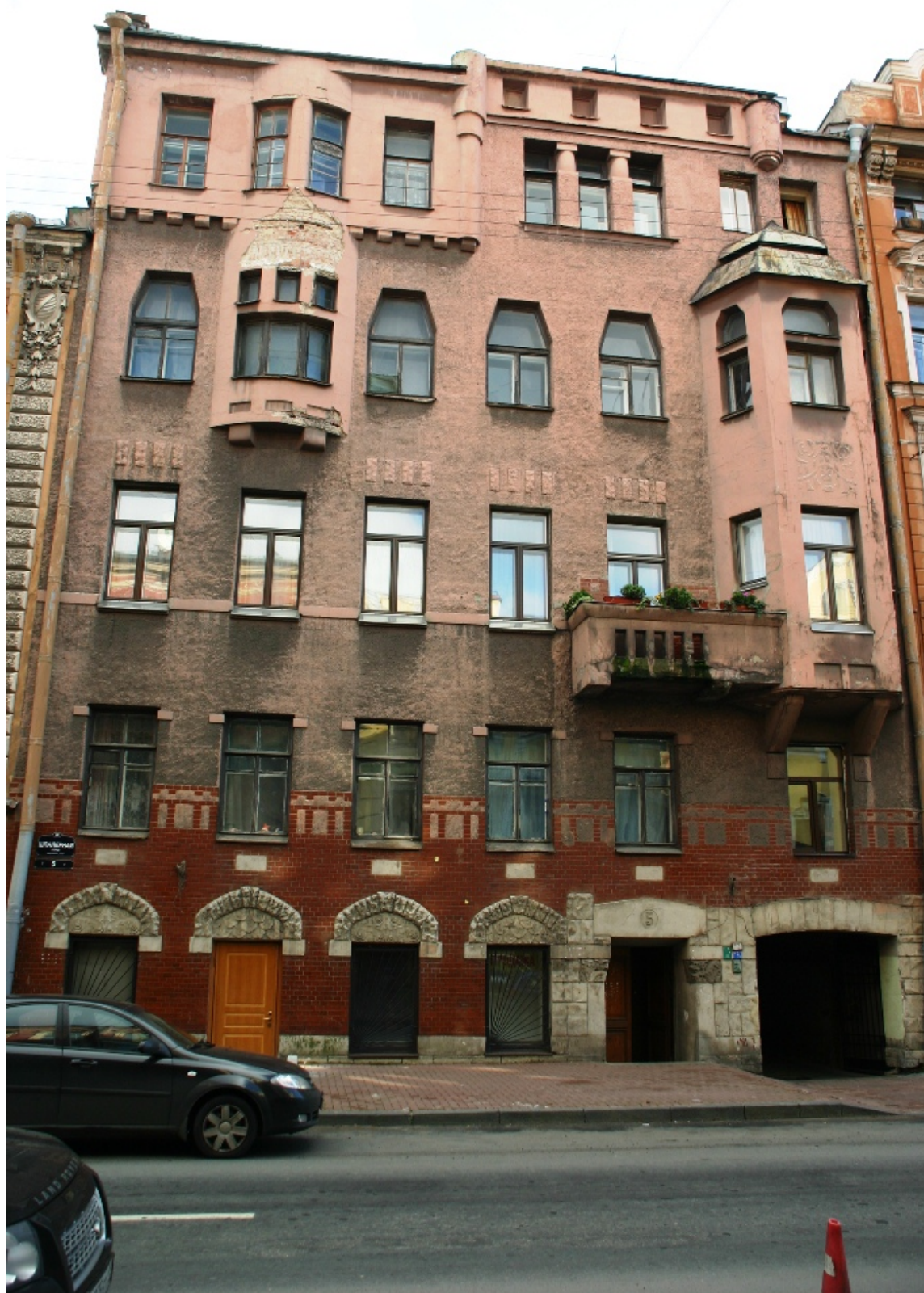
66. Фасад здания по Шпалерной ул., 5. 2011.
