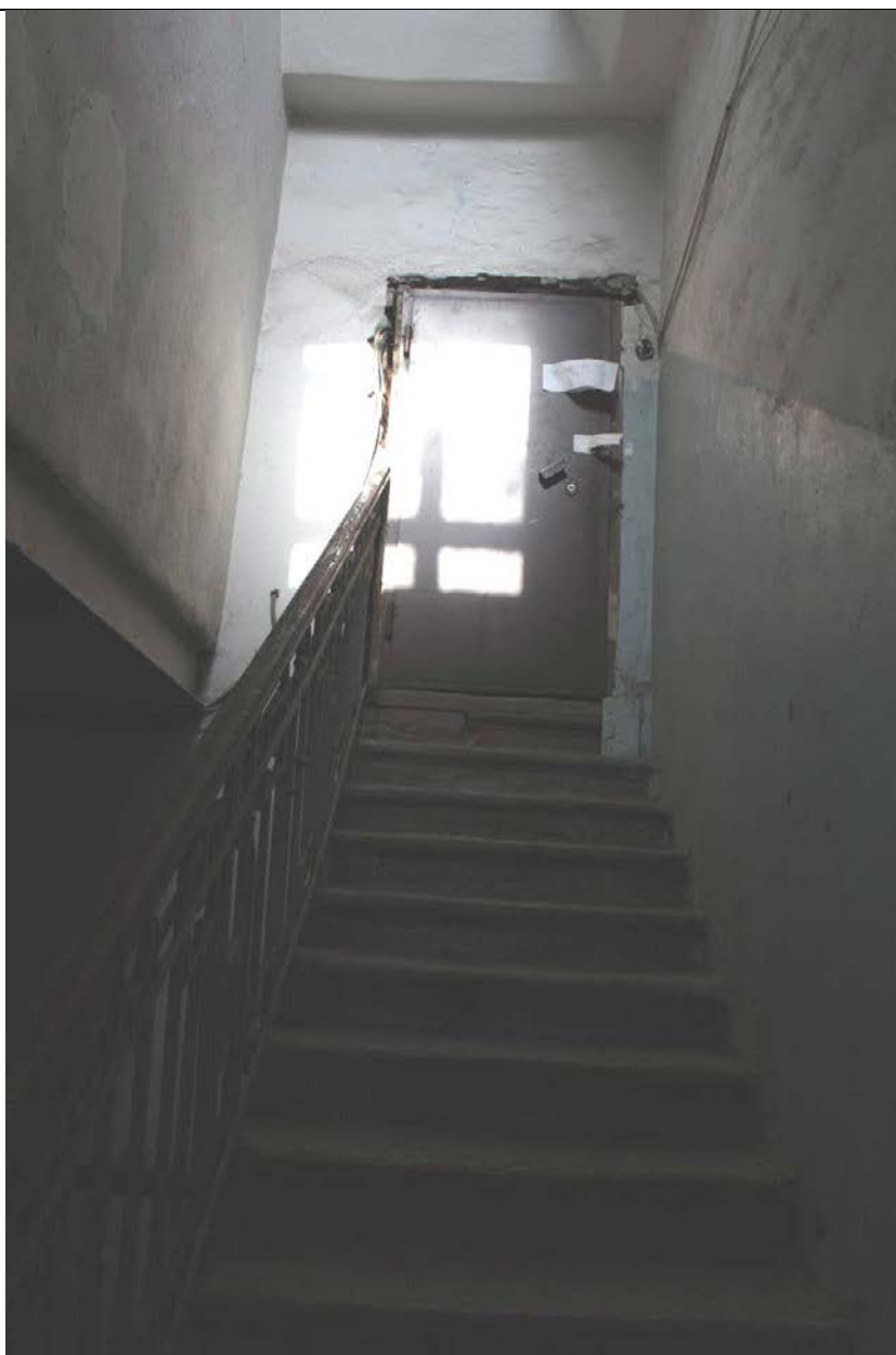
20. Дом А. Ф. Пеля. Шпалерная ул., 5. ЛК-1. Лестничные марши на чердак. Фото: эксперт А. А. Кононов, 26.04.2021.
