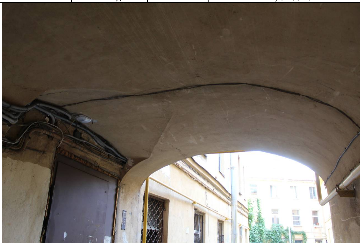
21. Дом А. Ф. Пеля. Шпалерная ул., 5. Воротный проезд в центральном дворе в флигеле. Своды. Фрагмент. Фото: эксперт А. А. Кононов, 01.06.2021.
