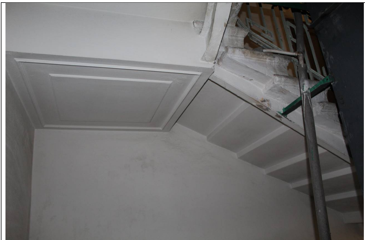
16. Дом А. Ф. Пеля. Шпалерная ул., 5. ЛК-1. Подшивка лестничной площадки и фрагмент лестницы по косоурам. Фото: эксперт А. А. Кононов, 26.04.2021.
