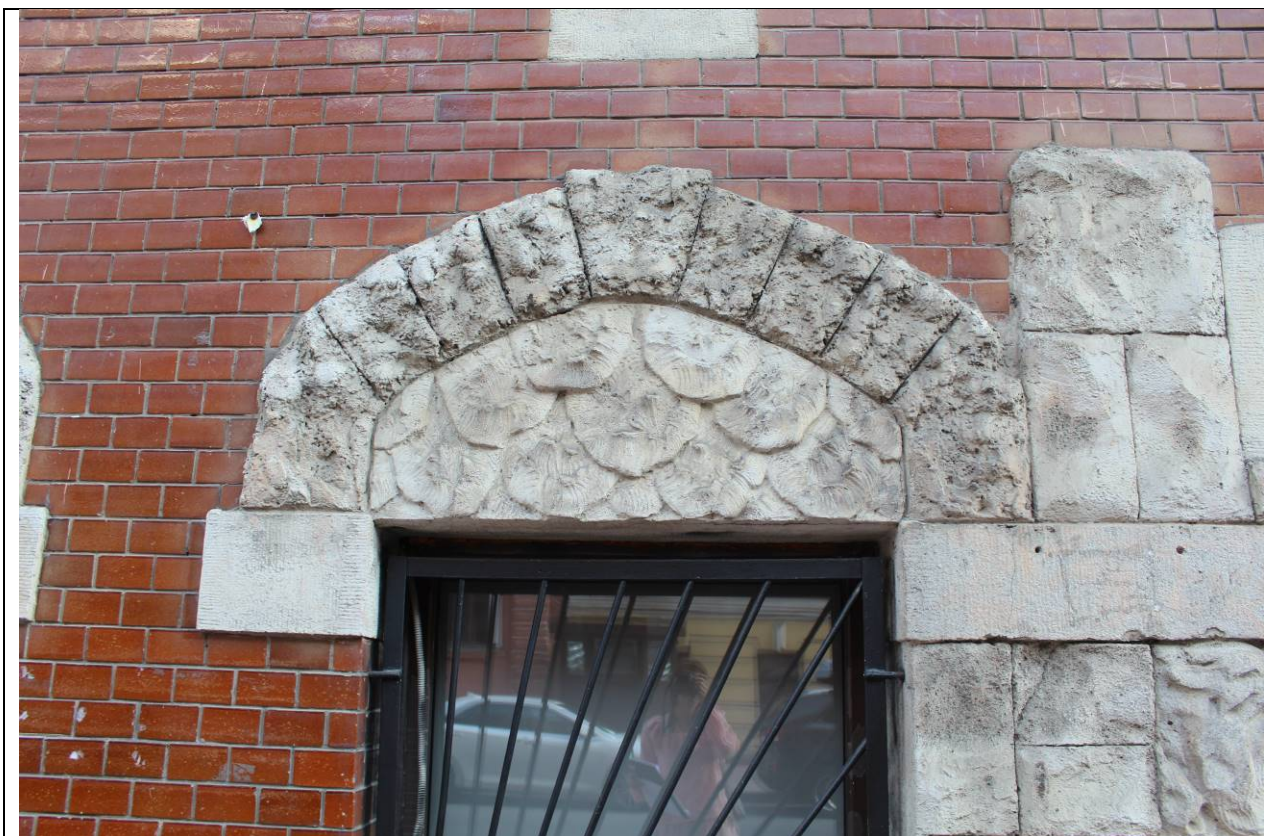
9. Дом А. Ф. Пеля. Шпалерная ул., 5. Фрагмент лицевого фасада. Оформление оконного проема. Фото: эксперт А. А. Кононов, 26.04.2021.
