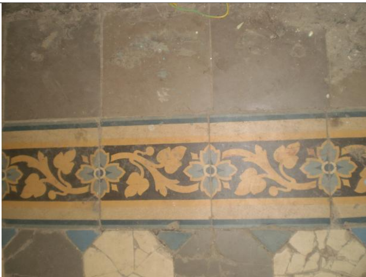
97. Дом по Шпалерной ул., д. 5. Парадная лестница. 2012. Источник: Архитектурный сайт Петербурга citywalls.ru
