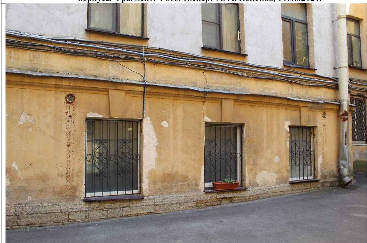
17. Дом А. Ф. Пеля. Шпалерная ул., 5. Северный двор. Северо-восточный дворный флигель. Фрагмент. Вид с северо-запада. Фото: эксперт А. А. Кононов, 26.04.2021.
