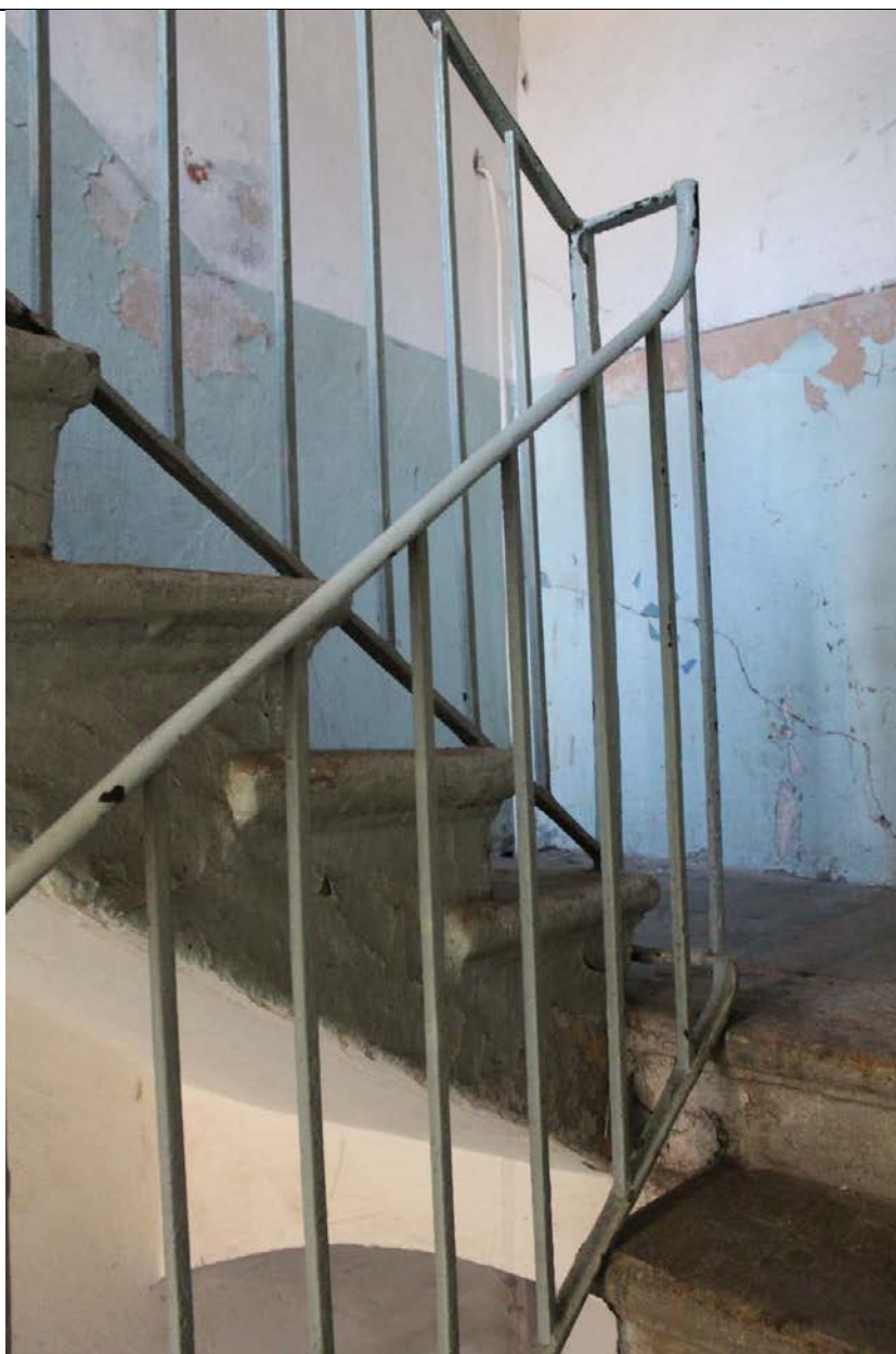
4. Дом А. Ф. Пеля. Шпалерная ул., 5. Южный двор. Юго-западный дворовый флигель. Ограждение лестничного марша между 1 и 2 этажами. Фото: эксперт А. А. Кононов, 26.04.2021.
