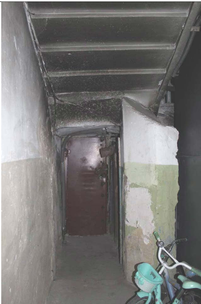
10. Дом А. Ф. Пеля. Шпалерная ул., 5. ЛК-1. Перекрытие и лестница по косоурам. Фото: эксперт А. А. Кононов, 26.04.2021.
