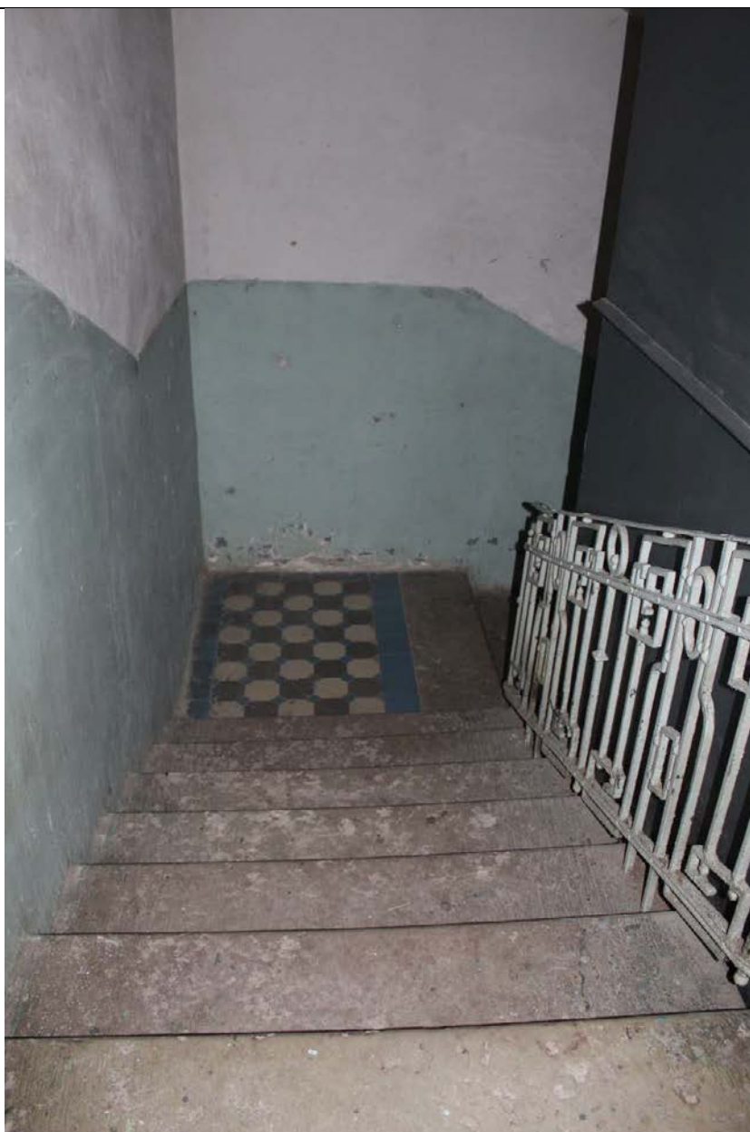
13. Дом А. Ф. Пеля. Шпалерная ул., 5. ЛК-1. Лестничный марш на 2 этаж и промежуточная площадка. Фото: эксперт А. А. Кононов, 26.04.2021.
