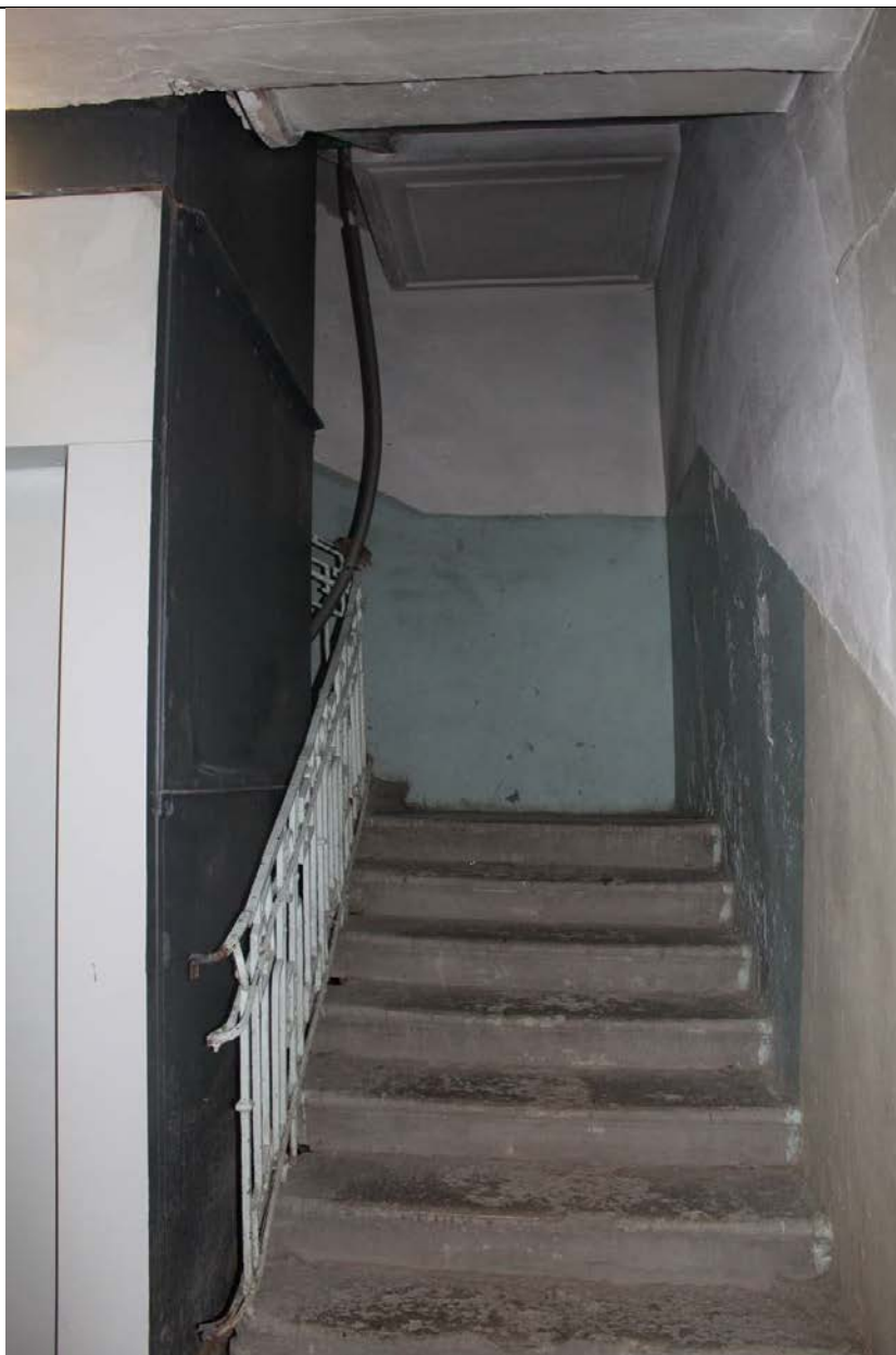
9. Дом А. Ф. Пеля. Шпалерная ул., 5. ЛК-1. Лестничный марш на 2 этаж. Фото: эксперт А. А. Кононов, 26.04.2021.
