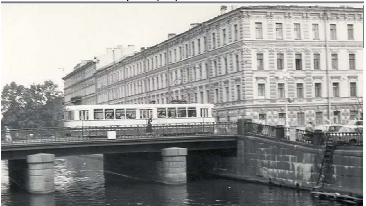
4. Крюков канал. Мост Декабристов. 1976-1980
