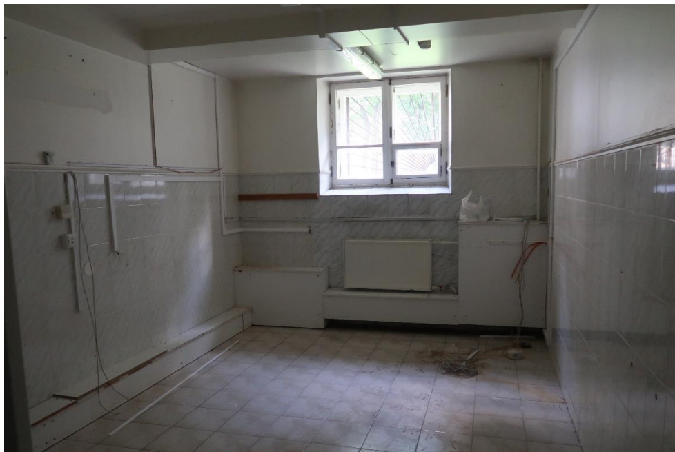
13. Выявленный объект культурного наследия «Изоляционный павильон» по адресу: г. Санкт-Петербург, ул. Кирочная д. 41, лит. Е, входящий в состав выявленного объекта культурного наследия «Комплекс зданий Клинического института вел. кн. Елены Павловны» по адресу: Санкт-Петербург, ул. Кирочная д. 41, литеры А, В, Д, Е, О (Кирочная ул., 41; Парадная ул., 2). Помещение цокольного этажа. Общий вид.
