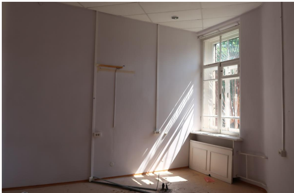
17. Выявленный объект культурного наследия «Изоляционный павильон» по адресу: г. Санкт-Петербург, ул. Кирочная д. 41, лит. Е, входящий в состав выявленного объекта культурного наследия «Комплекс зданий Клинического института вел. кн. Елены Павловны» по адресу: Санкт-Петербург, ул. Кирочная д. 41, литеры А, В, Д, Е, О (Кирочная ул., 41; Парадная ул., 2). Первый этаж. Помещение первого этажа. Фрагмент интерьера.
