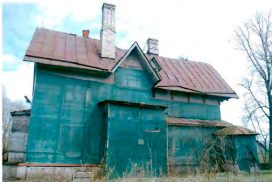
3. Вид на южный фасад.
