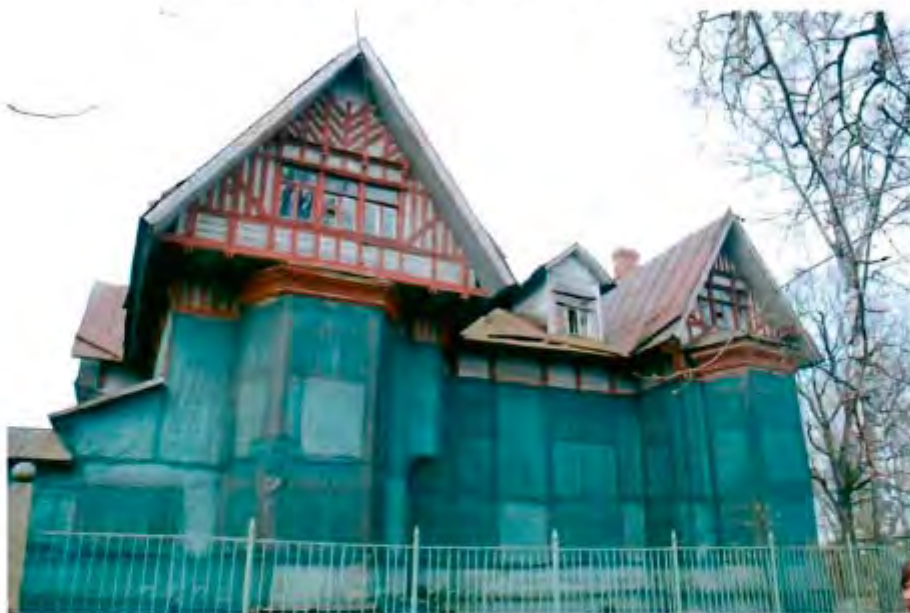
2. Вид на западный фасад.
