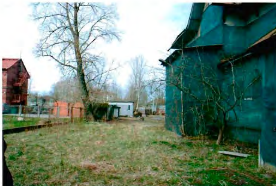
6. Вид на территорию со стороны южного фасада.
