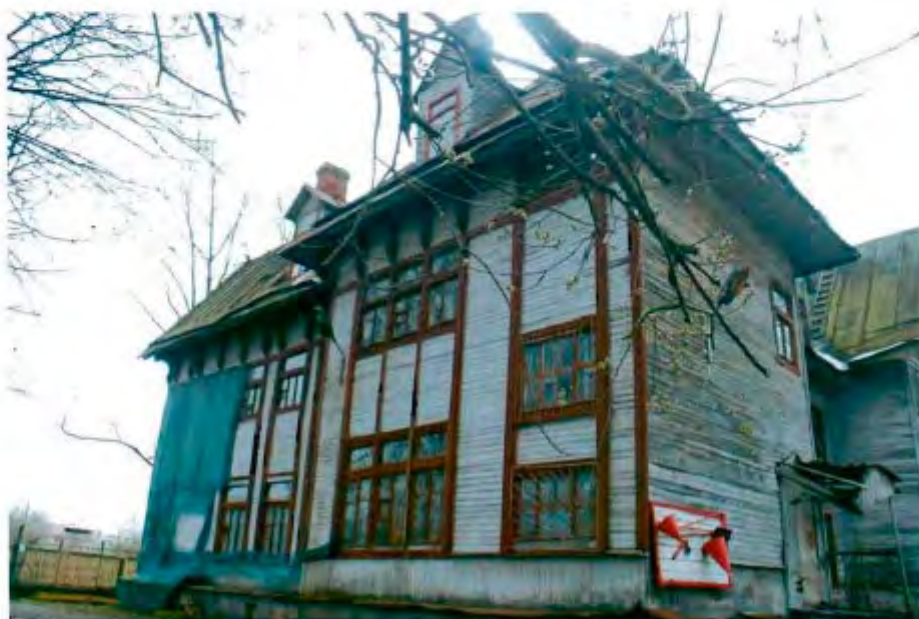
4. Вид на северный фасад.
