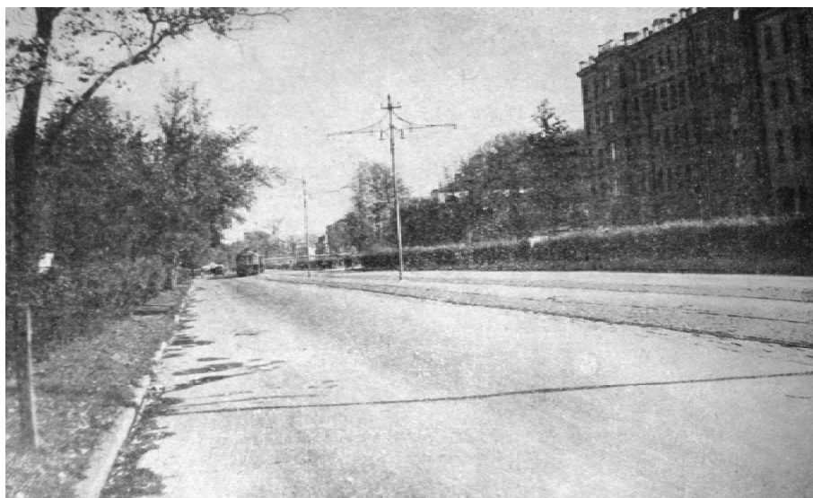
8. Большой проспект Васильевского острова после реконструкции. Ленинград. «Искусство». М.-Л. 1943 г.
