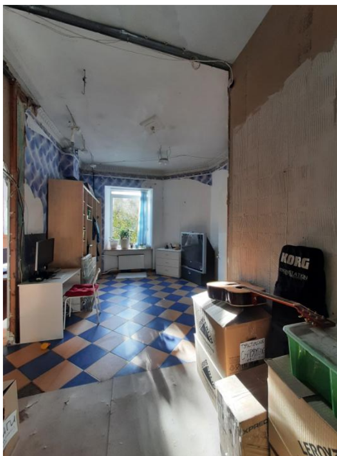
Фото 12 Интерьер квартиры № 81 выявленного объекта культурного наследия «Дом Б.Е. Фурмана»
