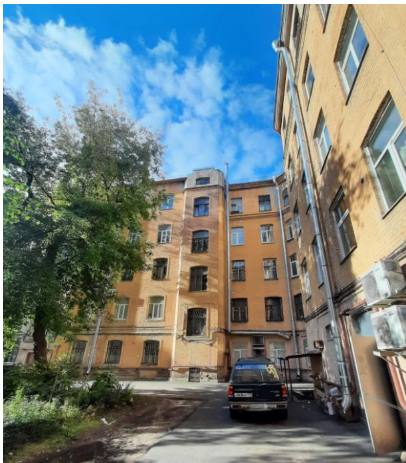
Фото 5 Фрагмент дворового фасада выявленного объекта культурного наследия «Дом Б.Е. Фурмана»
