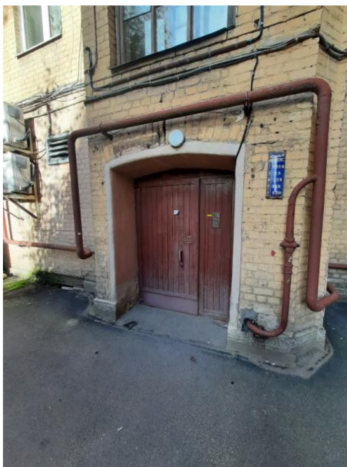
Фото 6 Фрагмент дворового фасада выявленного объекта культурного наследия «Дом Б.Е. Фурмана»
