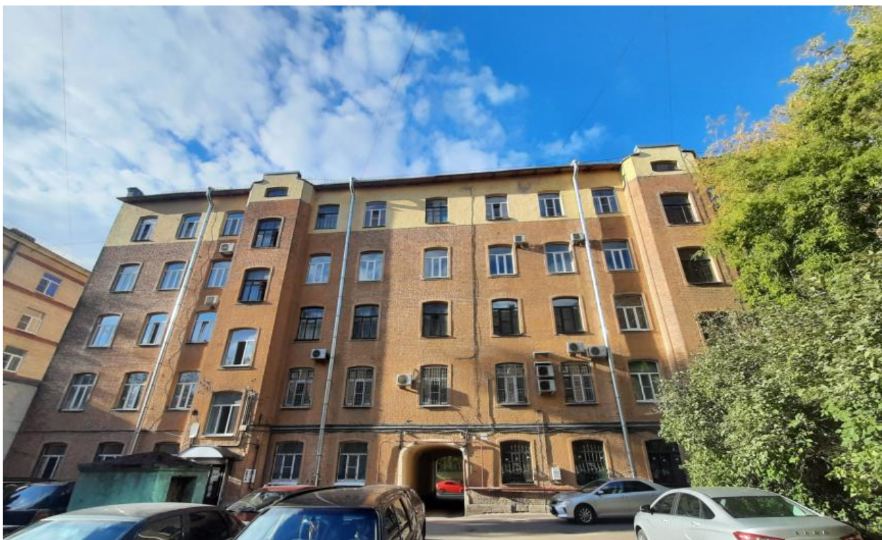
Фото 3 Фрагмент дворового фасада выявленного объекта культурного наследия «Дом Б.Е. Фурмана»
