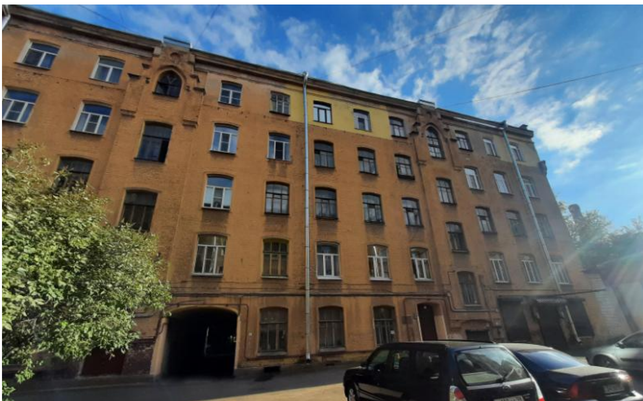
Фото 4 Фрагмент дворового фасада выявленного объекта культурного наследия «Дом Б.Е. Фурмана»
