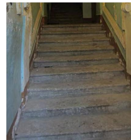
парадная лестница –местоположение, габариты, тип(двухмаршевая с поворотом),конструкция (на косоурах),материал ступеней (лещаднаяплита),
