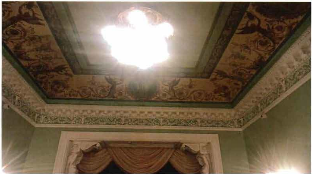
2. Помещение 2-го этажа (16-Н).
