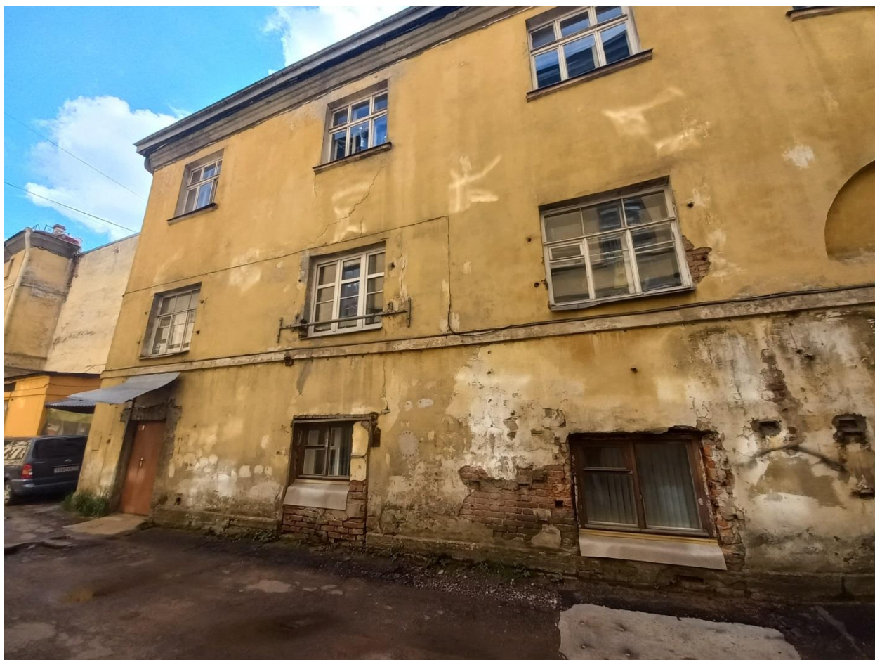
Фото 4. Фасад здания литер Б.
