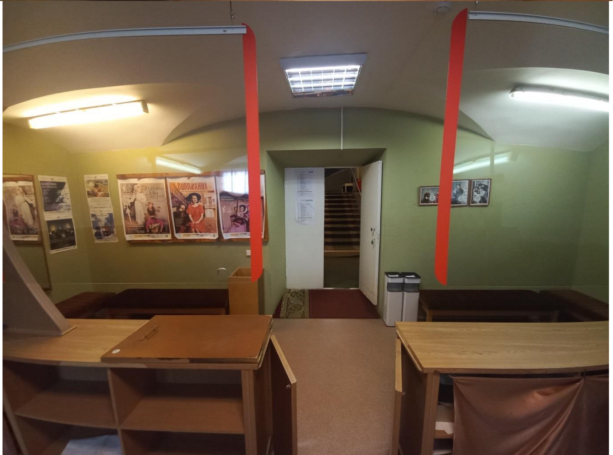
Фото 5 и 6. Помещение 1. Гардероб.
