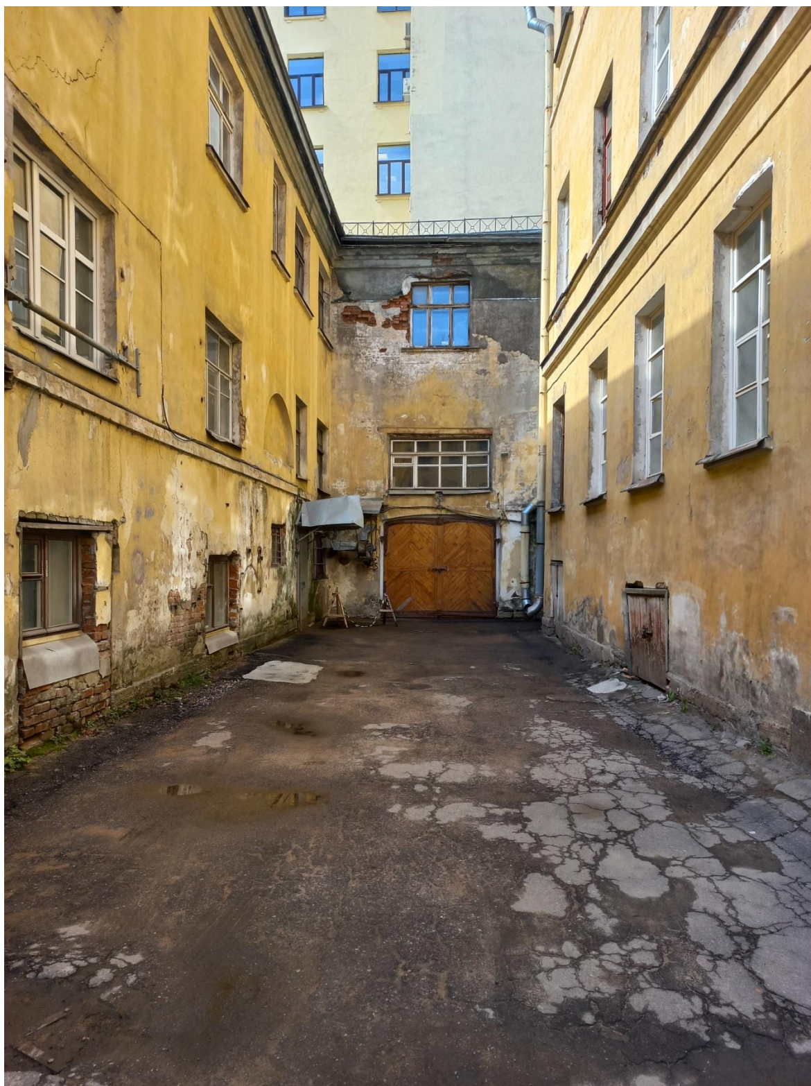
Фото 1. Здания литер А,Б. Северная часть дворовой территории.
