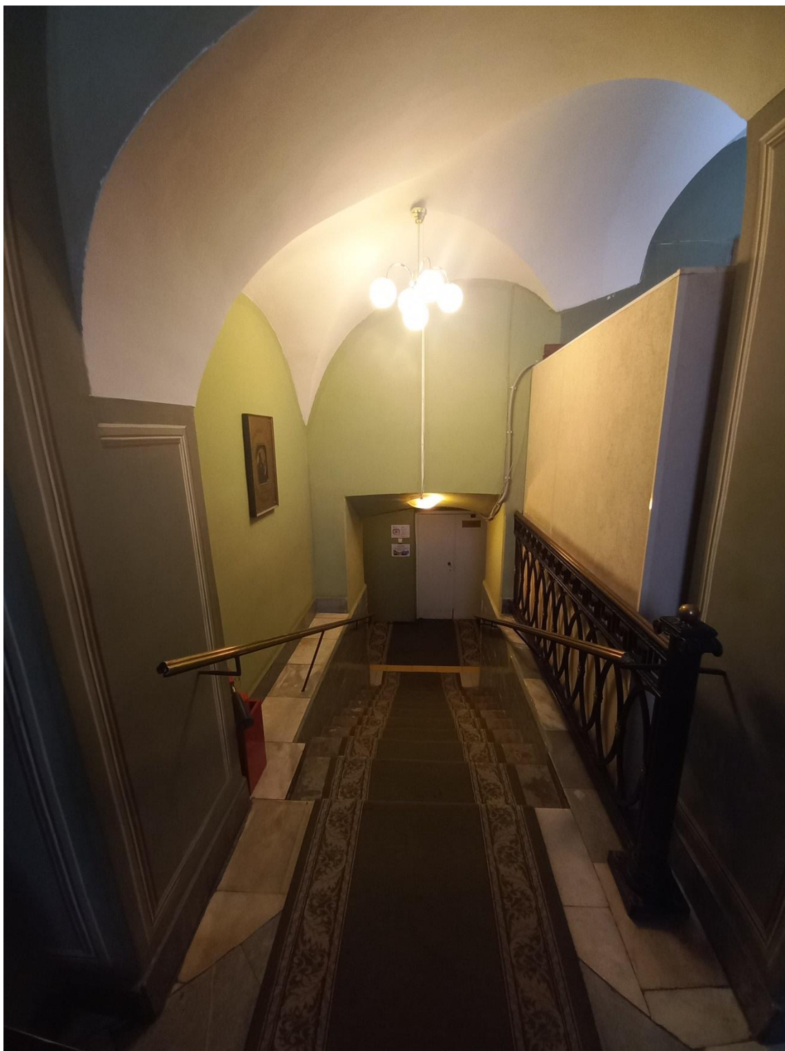
Фото 1. Лестница на нижний этаж.
