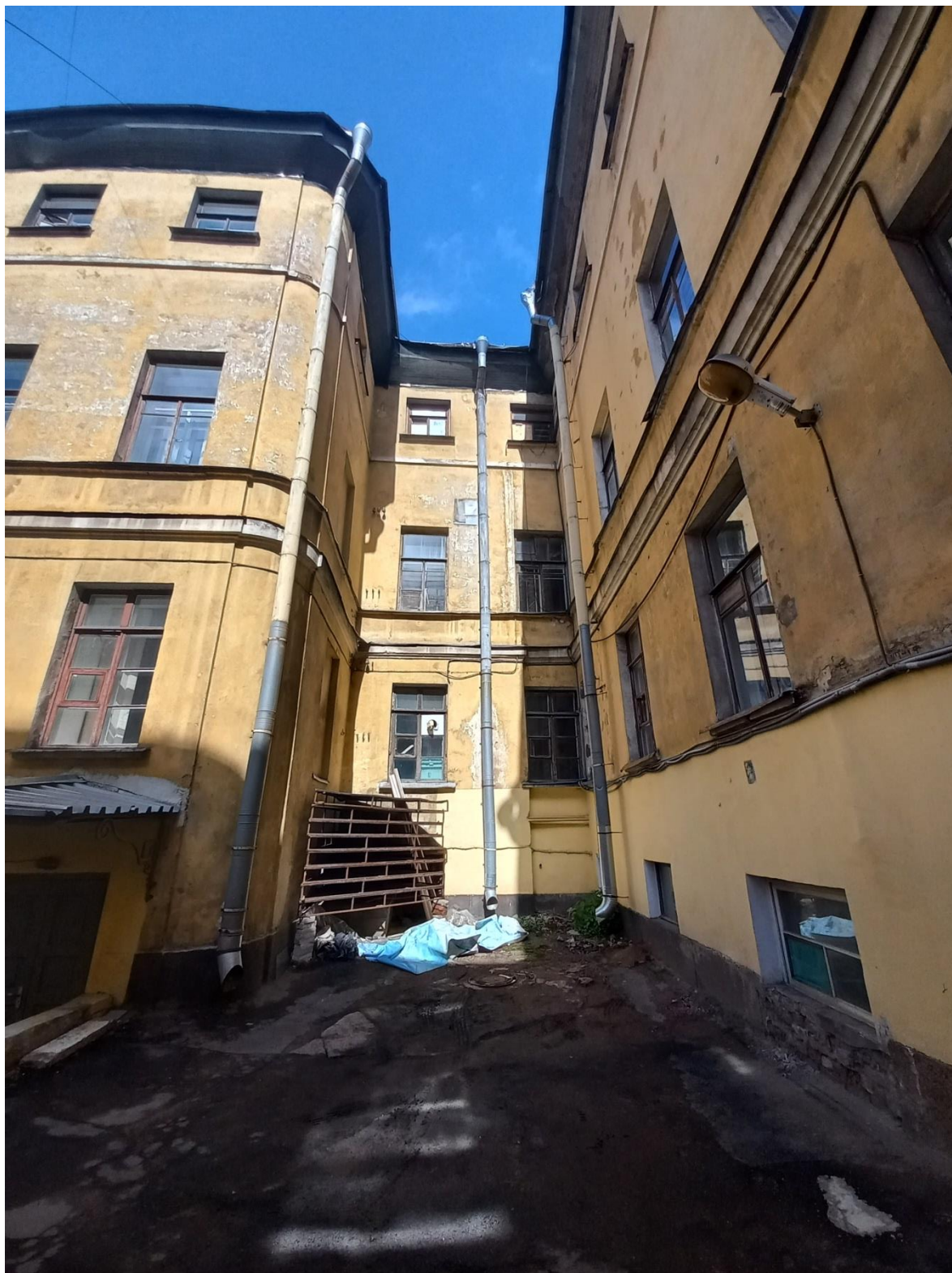
Фото 9. Фасад здания лит. А, южная часть.
