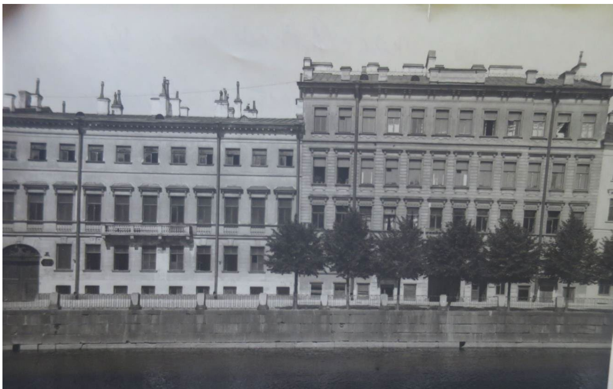
23. Набережная реки Фонтанки. Вид домов №39 и №41. Фотография. 1948 г. Архив КГИОП. Инв. № 21377/1.
