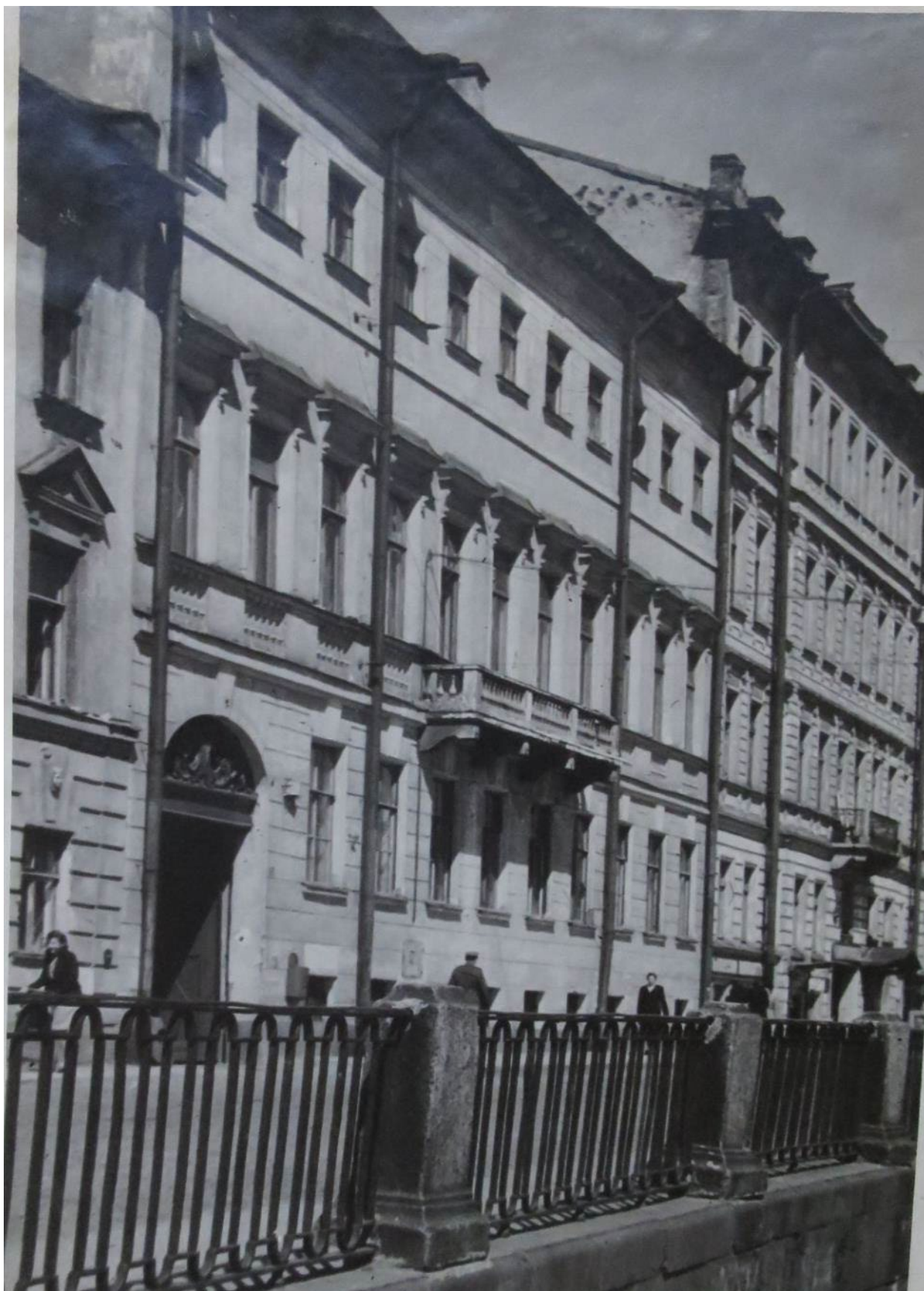
21. Дом Ильиных - О.А. Кочневой. Главный фасад. Вид вдоль набережной реки Фонтанки. Фотография. 1940-е гг. Архив КГИОП. Инв. № 17727.
