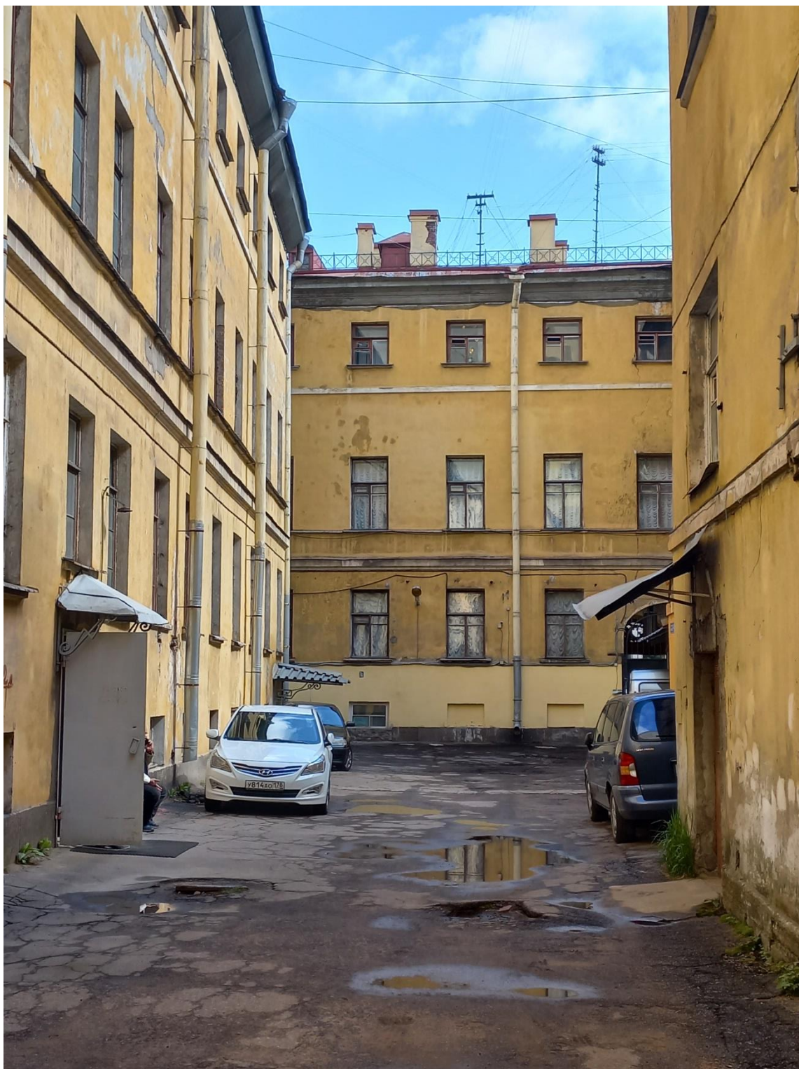
Фото 6. Территория внутреннего двора. Южная часть.
