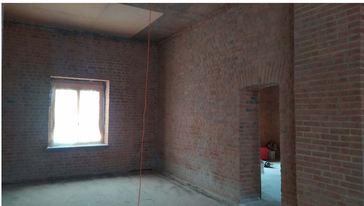
7. Помещение №1 (3-Н) в уровне 1-го этажа объекта культурного наследия регионального значения «Службы при дворце О.В. Гогенфельзен (Палей)», расположенного по адресу: Санкт-Петербург, г. Пушкин, Московский пер. д. 7/20, литера А. 04.11.2022.
