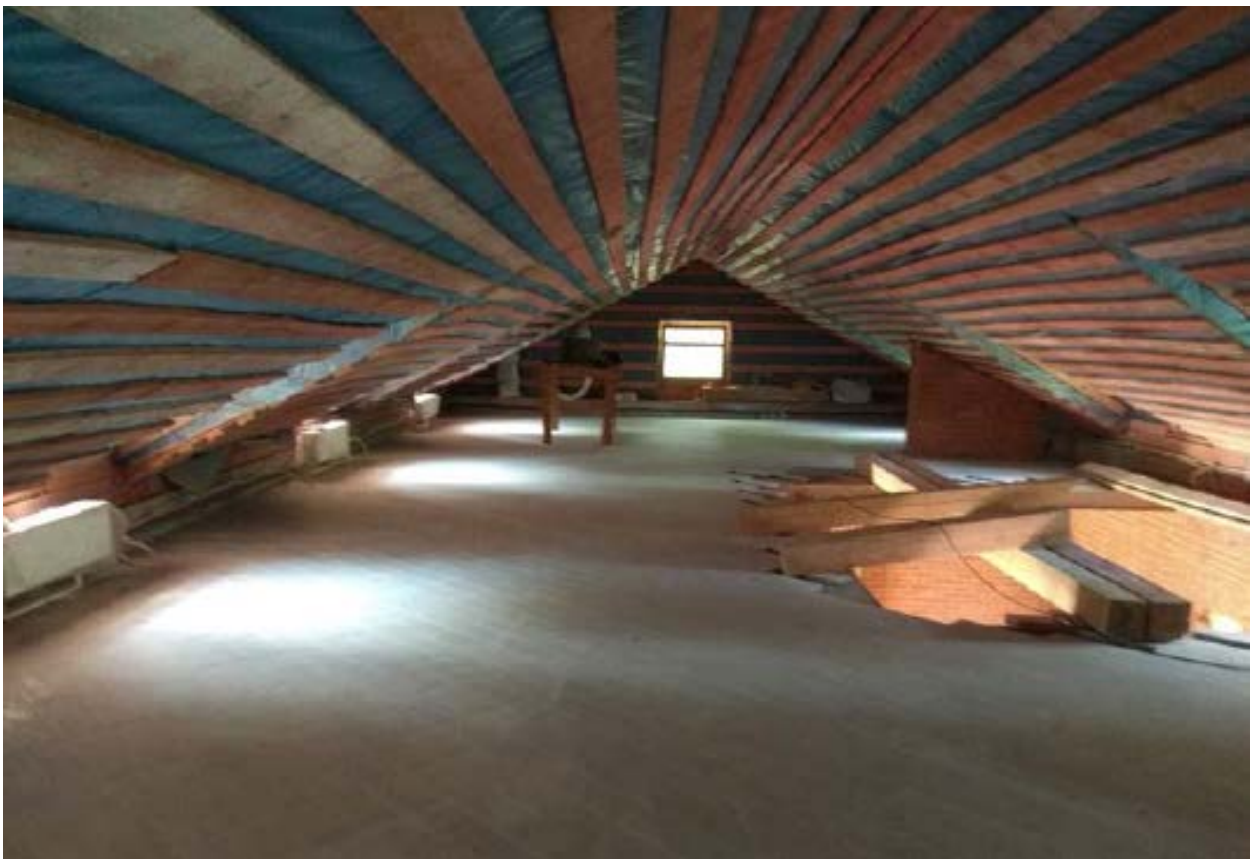
12. Чердак объекта культурного наследия регионального значения «Службы при дворце О.В. Гогенфельзен (Палей)», расположенного по адресу: Санкт-Петербург, г. Пушкин, Московский пер. д. 7/20, литера А. 04.11.2022.
