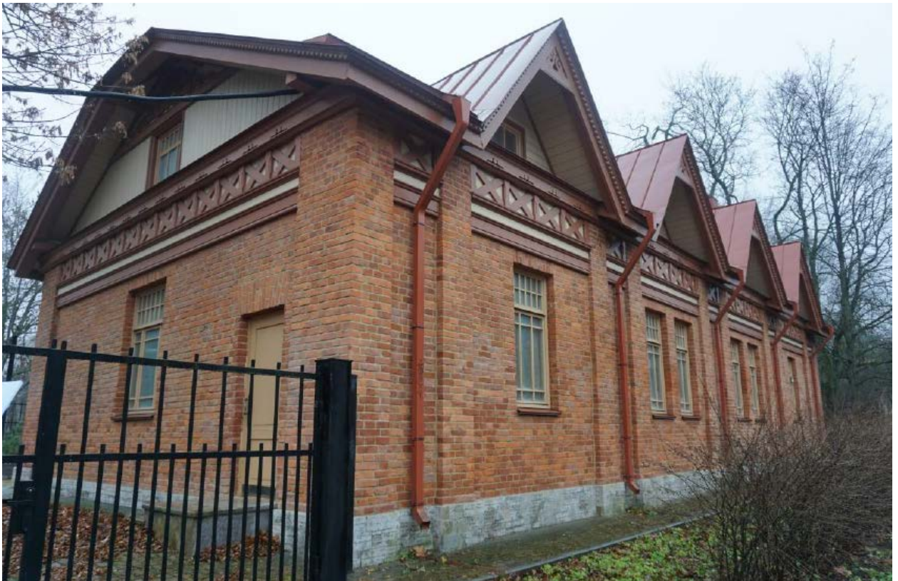
1. Юго-восточный и северо-восточный фасады. объекта культурного наследия регионального значения «Службы при дворце О.В. Гогенфельзен (Палей)», расположенного по адресу: Санкт-Петербург, г. Пушкин, Московский пер. д. 7/20, литера А. 04.11.2022.
