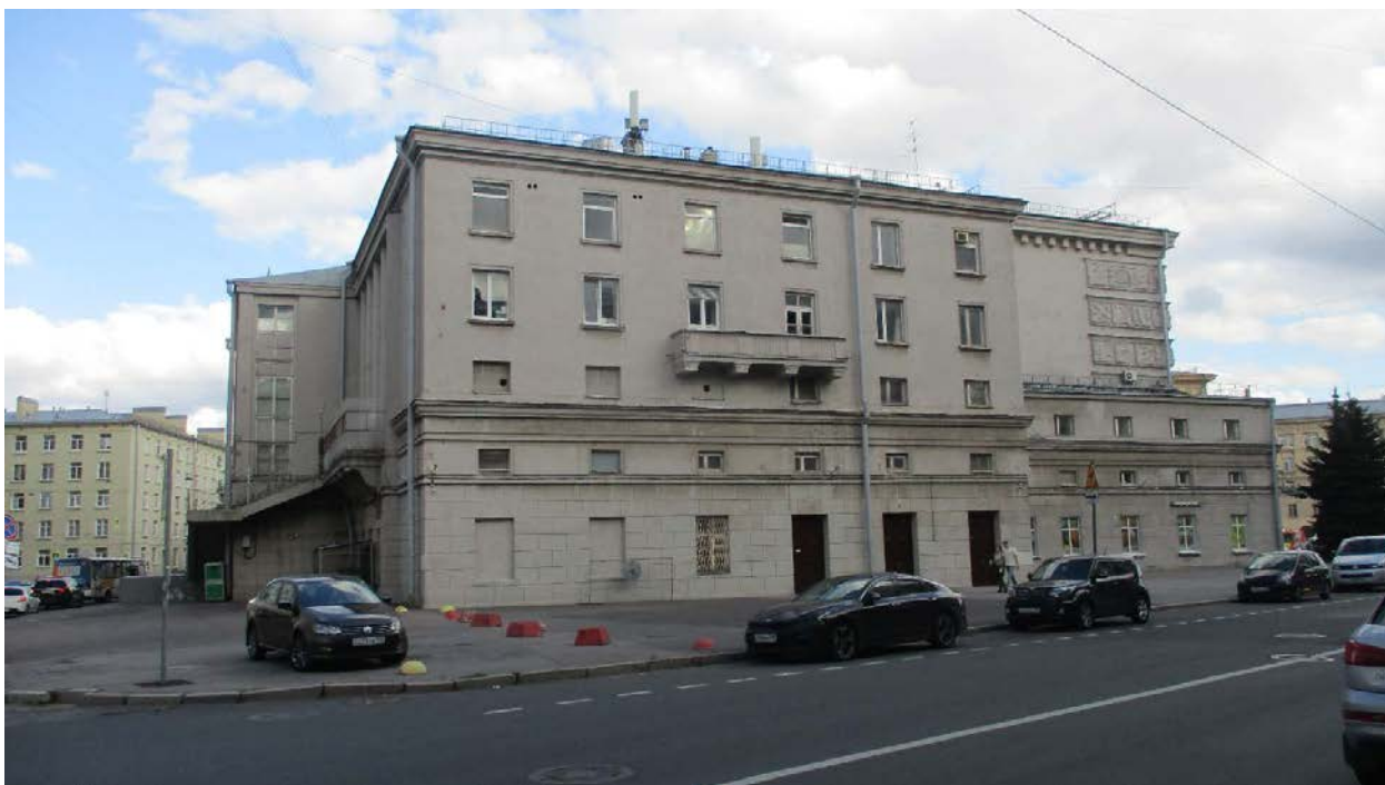
7. г.Санкт-Петербург, Кондратьевский проспект, дом 44, литера А. Общий вид с северо-запада.
