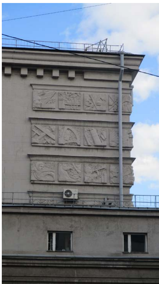
16. г.Санкт-Петербург, Кондратьевский проспект, дом 44, литера А. Фрагмент западного фасада.
