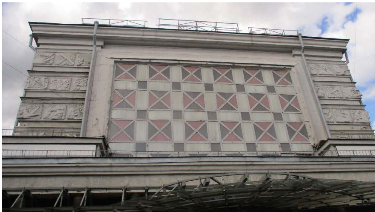
13. г.Санкт-Петербург, Кондратьевский проспект, дом 44, литера А. Фрагмент южного фасада.
