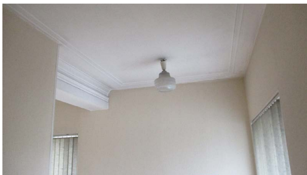
35. г.Санкт-Петербург, Кондратьевский проспект, дом 44, литера А. Интерьер. Перекрытие площадки парадной лестницы
