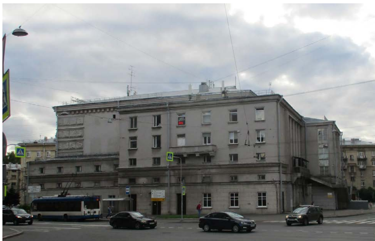
4. г.Санкт-Петербург, Кондратьевский проспект, дом 44, литера А. Общий вид с востока.
