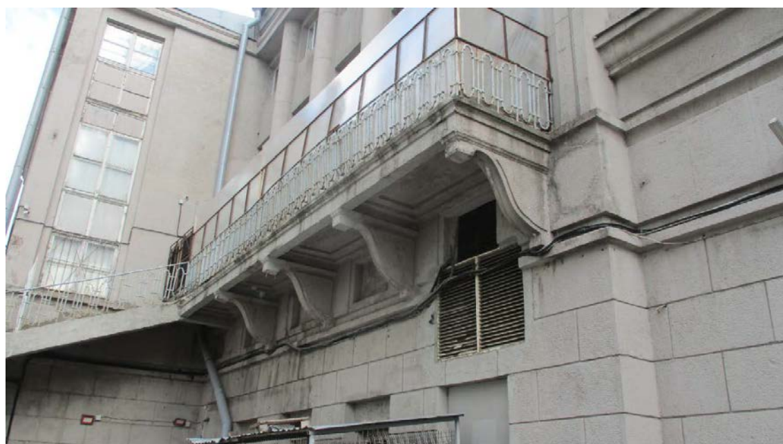
12. г.Санкт-Петербург, Кондратьевский проспект, дом 44, литера А. Балкон северного фасада.
