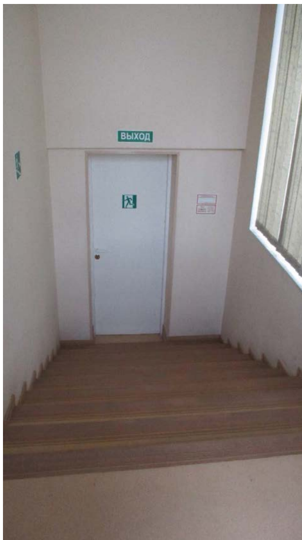
36. г.Санкт-Петербург, Кондратьевский проспект, дом 44, литера А. Интерьер. Фрагмент парадной лестницы.
