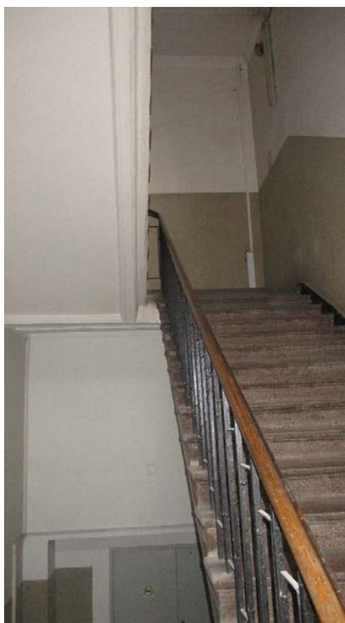
28. г.Санкт-Петербург, Кондратьевский проспект, дом 44, литера А. Интерьер. Лестница.
