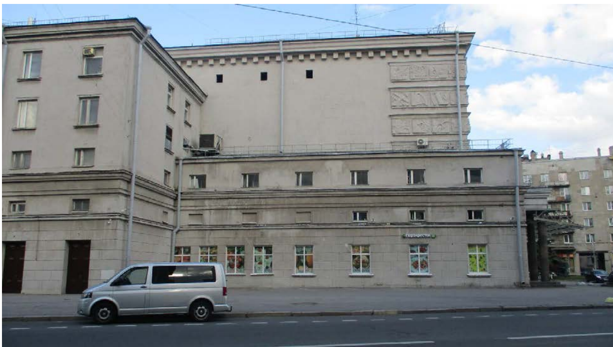
8. г.Санкт-Петербург, Кондратьевский проспект, дом 44, литера А. Фрагмент западного фасада.
