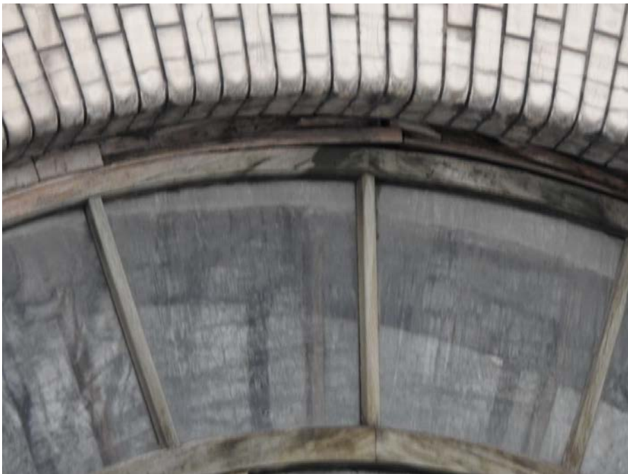
8. «Главное здание», входящее в состав объекта культурного наследия федерального значения «Институт ортопедический», Александровский парк, д.5 литера А. Главный вход. Фрагмент. Фото 11.03.2021 г.
