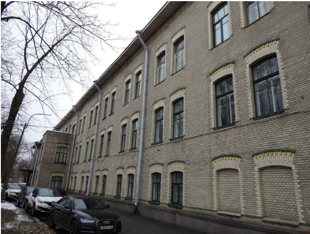
1. «Главное здание», входящее в состав объекта культурного наследия федерального значения «Институт ортопедический», Александровский парк, д.5 литера А. Юго-западный фасад. Общий вид. Фото 11.03.2021 г.
