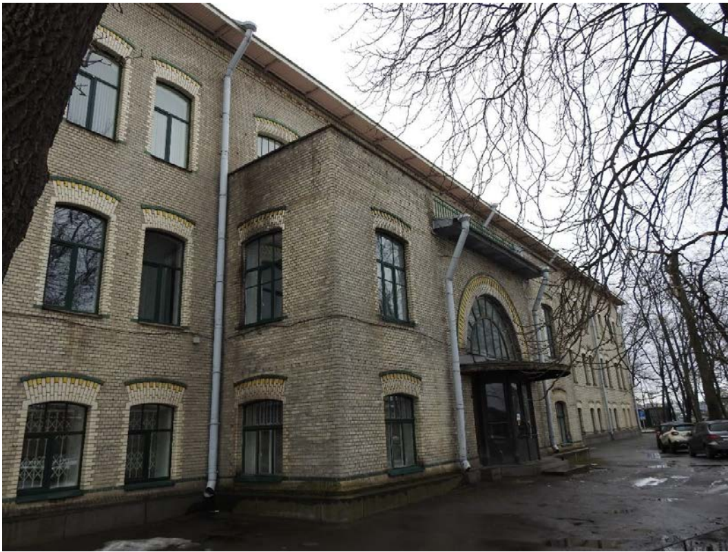
3. «Главное здание», входящее в состав объекта культурного наследия федерального значения «Институт ортопедический», Александровский парк, д.5 литера А. Юго-западный фасад. Фрагмент. Фото 11.03.2021 г.
