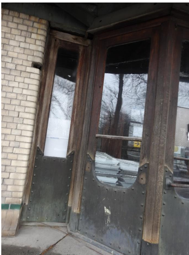
12. «Главное здание», входящее в состав объекта культурного наследия федерального значения «Институт ортопедический», Александровский парк, д.5 литера А. Главный вход. Фрагмент. Фото 11.03.2021 г.
