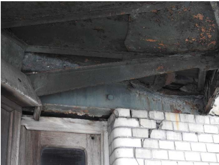
10. «Главное здание», входящее в состав объекта культурного наследия федерального значения «Институт ортопедический», Александровский парк, д.5 литера А. Главный вход. Фрагмент. Фото 11.03.2021 г.
