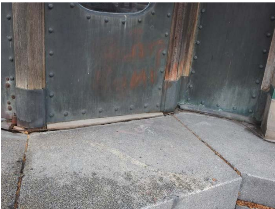
15. «Главное здание», входящее в состав объекта культурного наследия федерального значения «Институт ортопедический», Александровский парк, д.5 литера А. Главный вход. Фрагмент. Фото 11.03.2021 г.
