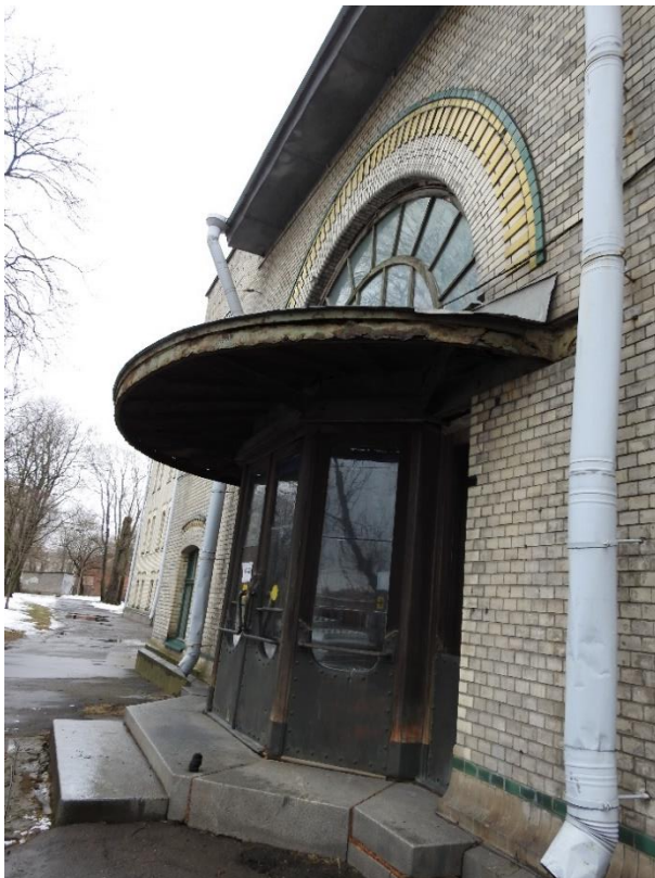
6. «Главное здание», входящее в состав объекта культурного наследия федерального значения «Институт ортопедический», Александровский парк, д.5 литера А. Главный вход. Общий вид. Фото 11.03.2021 г.
