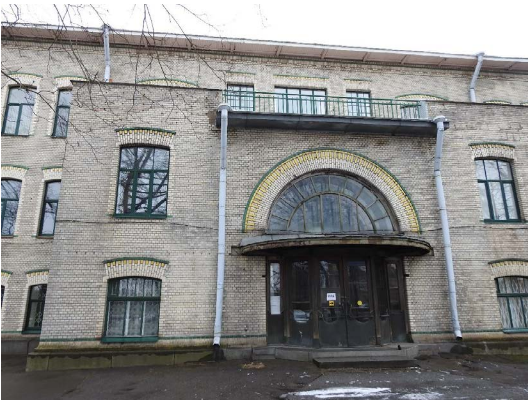
4. «Главное здание», входящее в состав объекта культурного наследия федерального значения «Институт ортопедический», Александровский парк, д.5 литера А. Юго-западный фасад. Фрагмент. Фото 11.03.2021 г.
