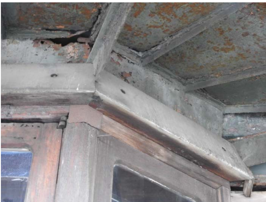
11. «Главное здание», входящее в состав объекта культурного наследия федерального значения «Институт ортопедический», Александровский парк, д.5 литера А. Главный вход. Фрагмент. Фото 11.03.2021 г.
