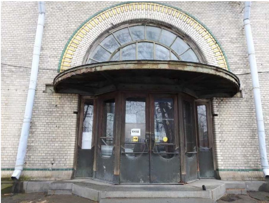
5. «Главное здание», входящее в состав объекта культурного наследия федерального значения «Институт ортопедический», Александровский парк, д.5 литера А. Главный вход. Общий вид. Фото 11.03.2021 г.
