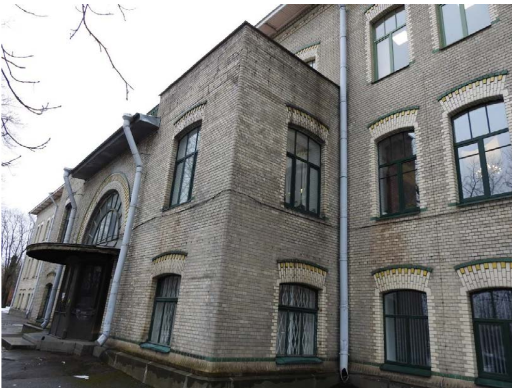
2. «Главное здание», входящее в состав объекта культурного наследия федерального значения «Институт ортопедический», Александровский парк, д.5 литера А. Юго-западный фасад. Фрагмент. Фото 11.03.2021 г.
