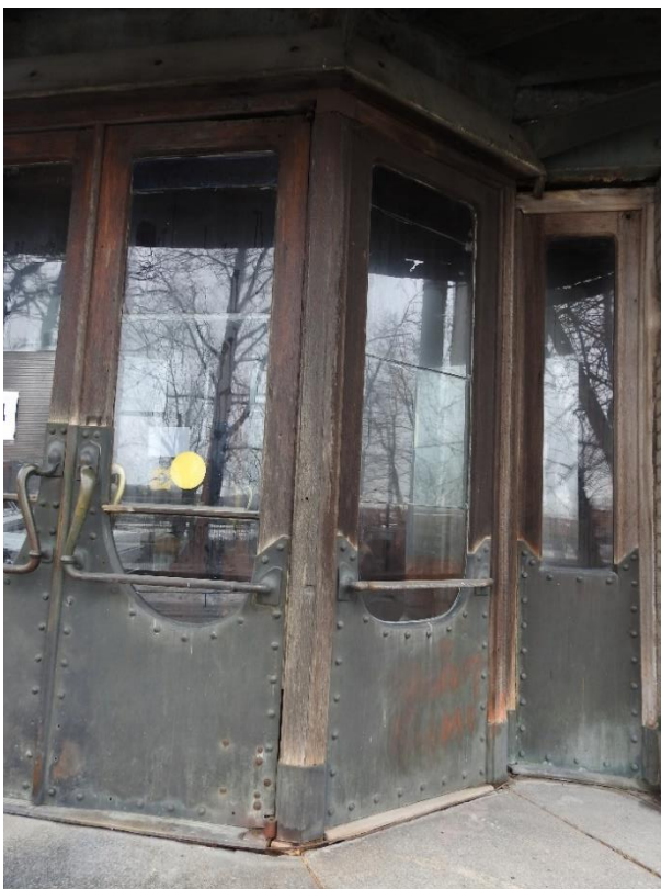
14. «Главное здание», входящее в состав объекта культурного наследия федерального значения «Институт ортопедический», Александровский парк, д.5 литера А. Главный вход. Фрагмент. Фото 11.03.2021 г.
