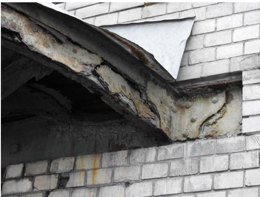
18. «Главное здание», входящее в состав объекта культурного наследия федерального значения «Институт ортопедический», Александровский парк, д.5 литера А. Главный вход. Фрагмент. Фото 11.03.2021 г.
