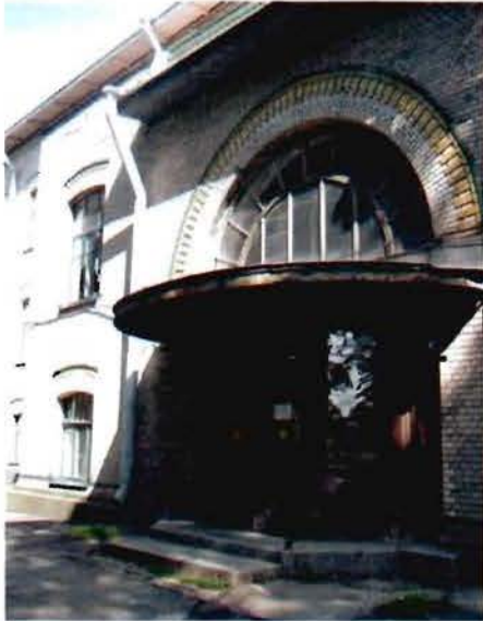
4. Ризалит и тамбур входа с юго-западной стороны объекта культурного наследия.
