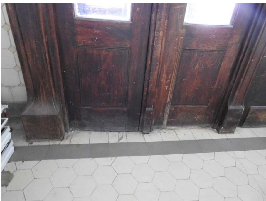
24. «Главное здание», входящее в состав объекта культурного наследия федерального значения «Институт ортопедический», Александровский парк, д.5 литера А. Главный вход. Фрагмент тамбура со стороны вестибюля. Фото 11.03.2021 г.
