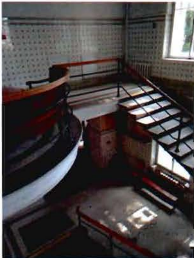
6. Лестница в юго-восточной части здания.
