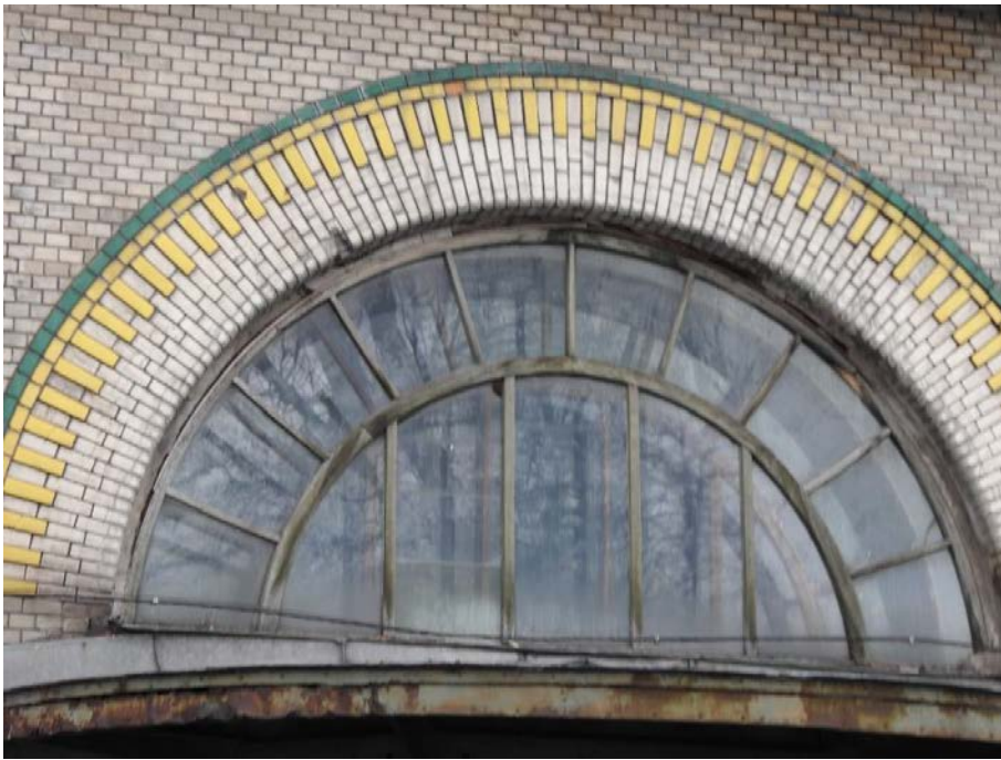
7. «Главное здание», входящее в состав объекта культурного наследия федерального значения «Институт ортопедический», Александровский парк, д.5 литера А. Главный вход. Фрагмент. Фото 11.03.2021 г.
