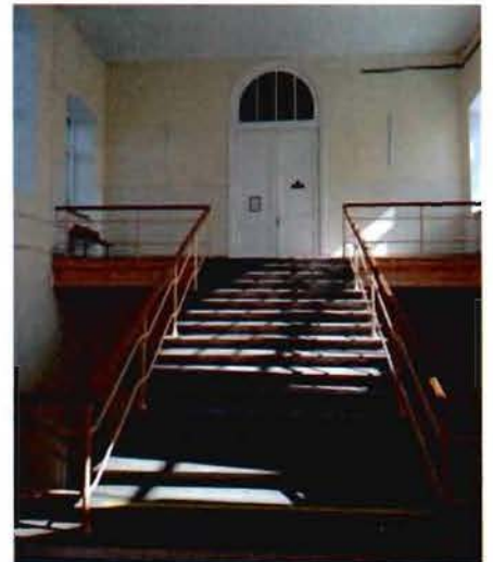
8. Лестница в центральной части здания.
