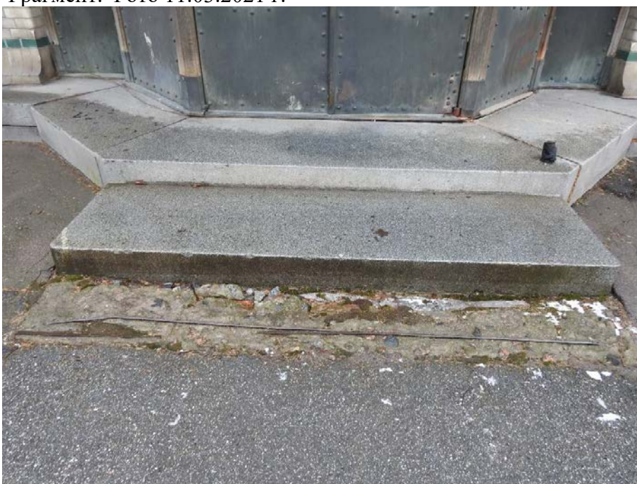
16. «Главное здание», входящее в состав объекта культурного наследия федерального значения «Институт ортопедический», Александровский парк, д.5 литера А. Главный вход. Фрагмент. Фото 11.03.2021 г.
