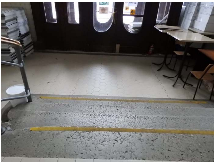
21. «Главное здание», входящее в состав объекта культурного наследия федерального значения «Институт ортопедический», Александровский парк, д.5 литера А. Лестница вестибюля парадной лестницы. Фрагмент. Фото 11.03.2021 г.
