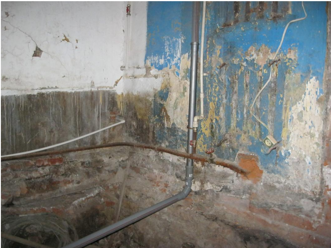
27. Выявленный объект культурного наследия «Дома И.А.Брылкина (2 здания)». Фрагмент внутреннего помещения квартиры. Ванная.
