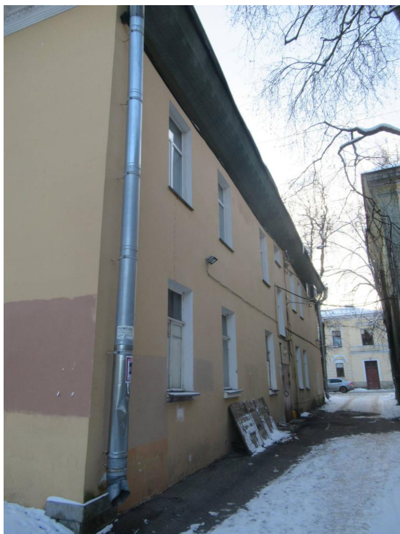
8. Выявленный объект культурного наследия «Дома И.А.Брылкина (2 здания)». Дворовый фасад здания (Средняя ул., 26/8). Вид с севера.
