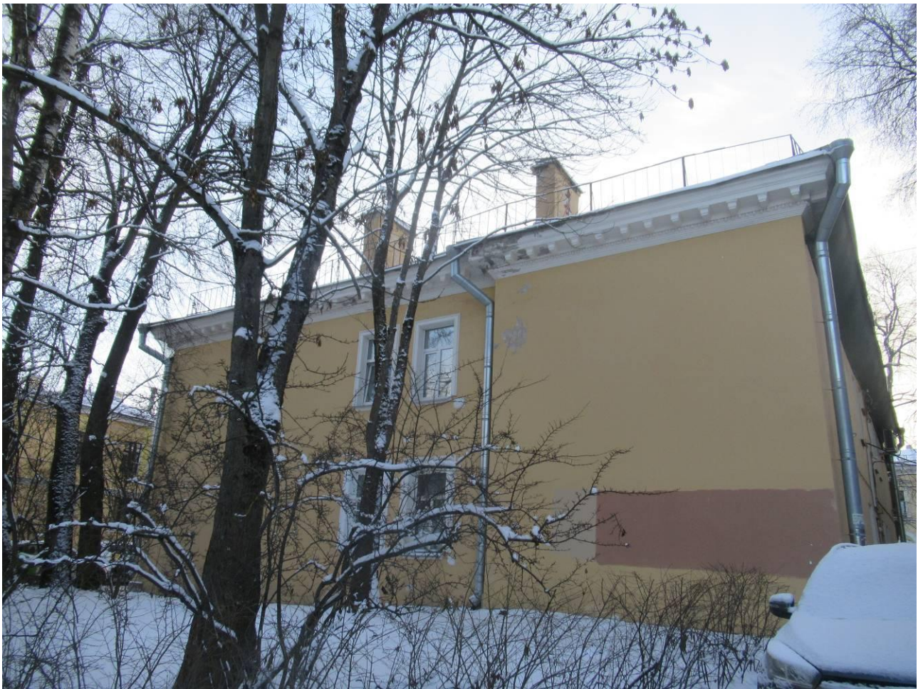
7. Выявленный объект культурного наследия «Дома И.А.Брылкина (2 здания)». Общий вид дворового фасада здания (Средняя ул., 26/8) с северо-востока.
