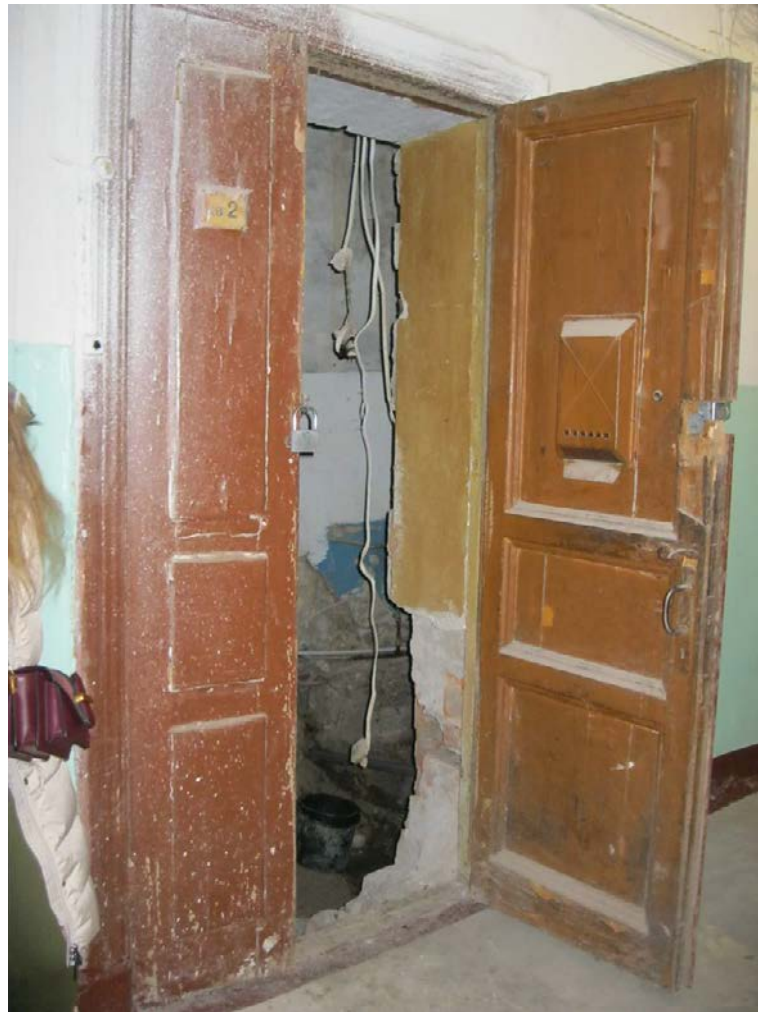
12. Выявленный объект культурного наследия «Дома И.А.Брылкина (2 здания)». Вход в квартиру с лестничной клетки.
