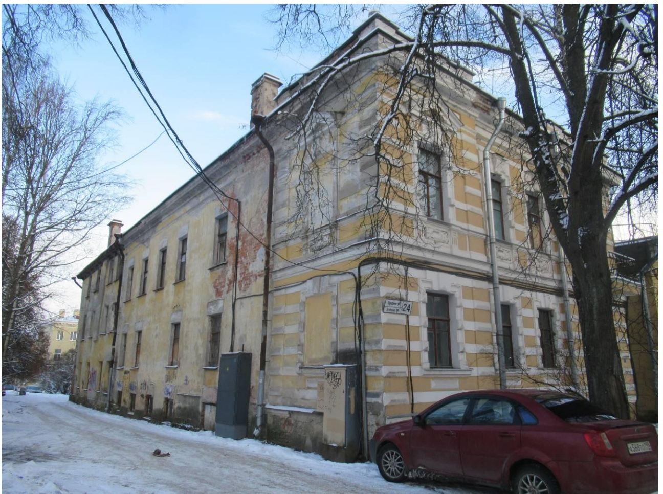
5. Выявленный объект культурного наследия «Дома И.А.Брылкина (2 здания)». Общий вид здания (Средняя ул., 24) со стороны Средней улицы.
