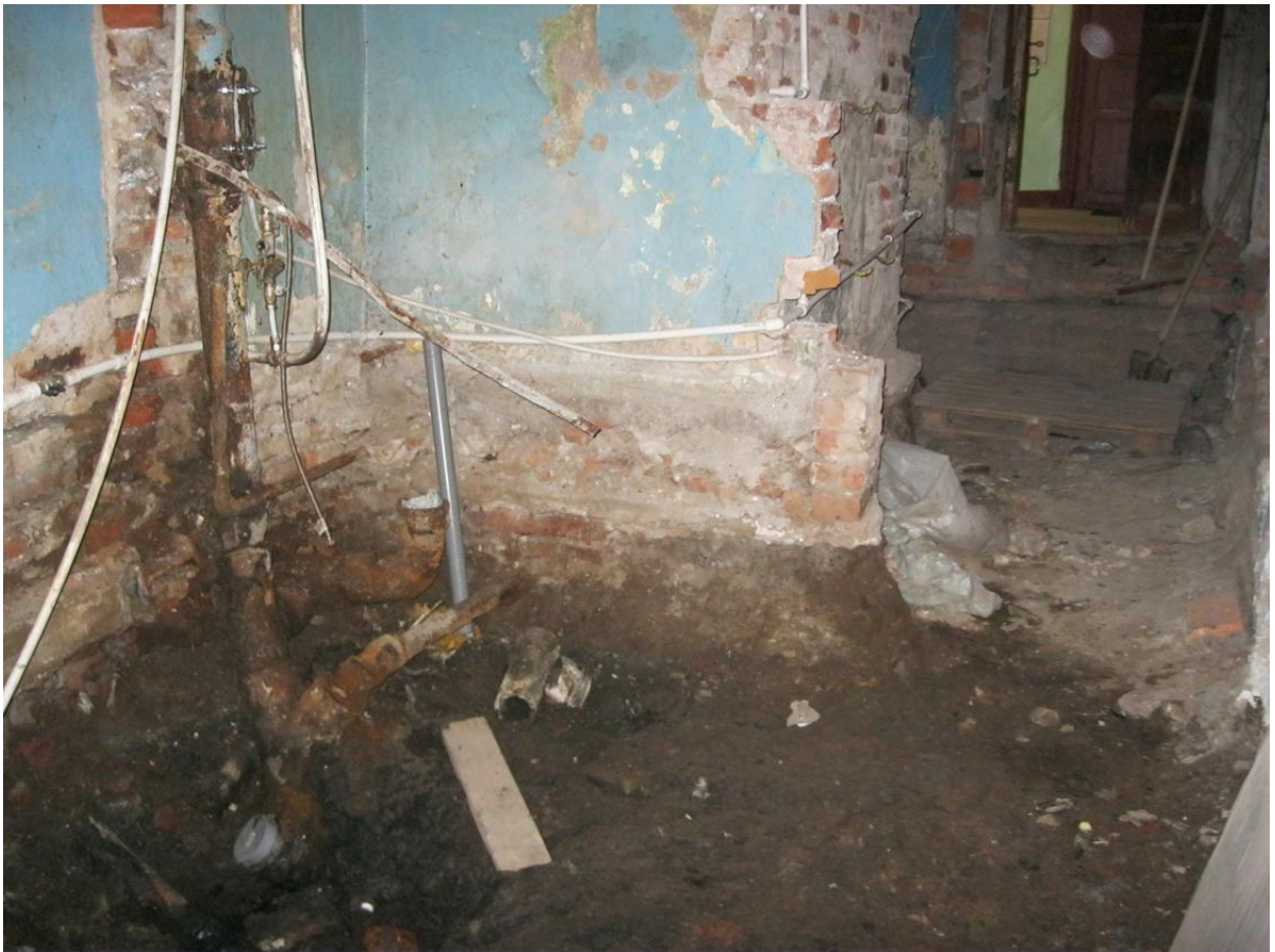
26. Выявленный объект культурного наследия «Дома И.А.Брылкина (2 здания)». Фрагмент внутреннего помещения квартиры. Туалет.
