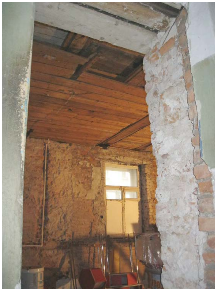
15. Выявленный объект культурного наследия «Дома И.А.Брылкина (2 здания)». Общий вид от входа в квартиру в сторону внутреннего помещения (комнаты).
