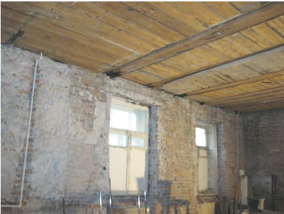
17. Выявленный объект культурного наследия «Дома И.А.Брылкина (2 здания)». Фрагмент внутреннего помещения квартиры. Вид в сторону окон.
