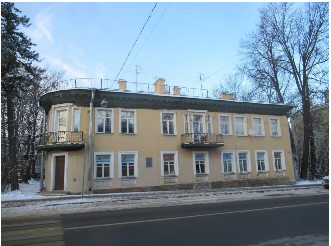
2. Выявленный объект культурного наследия «Дома И.А.Брылкина (2 здания)». Фасад со стороны Оранжерейной улицы.
