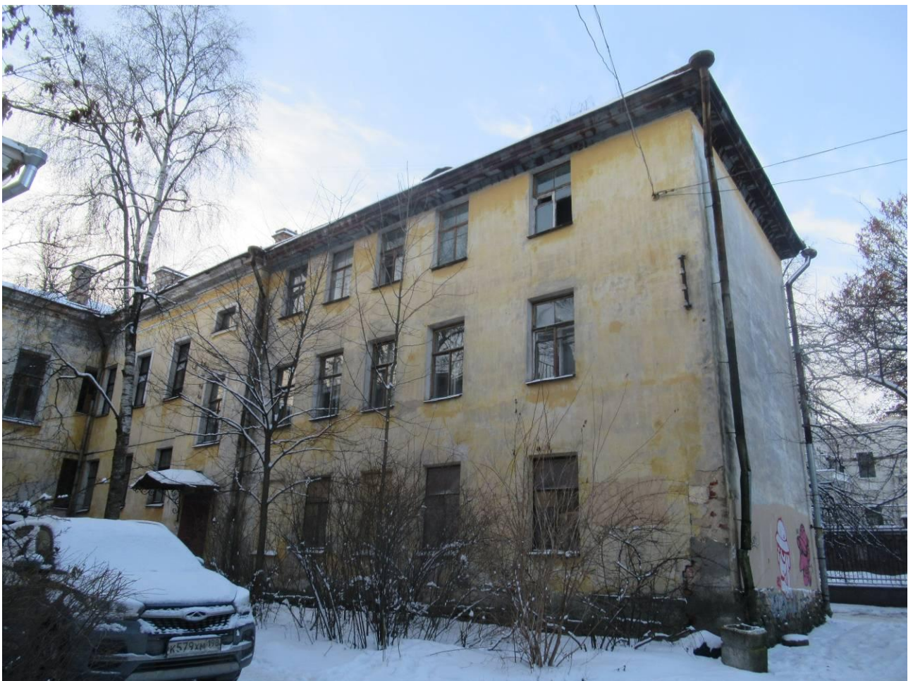
6. Выявленный объект культурного наследия «Дома И.А.Брылкина (2 здания)». Общий вид дворового фасада здания (Средняя ул., 24) с северо-востока.
