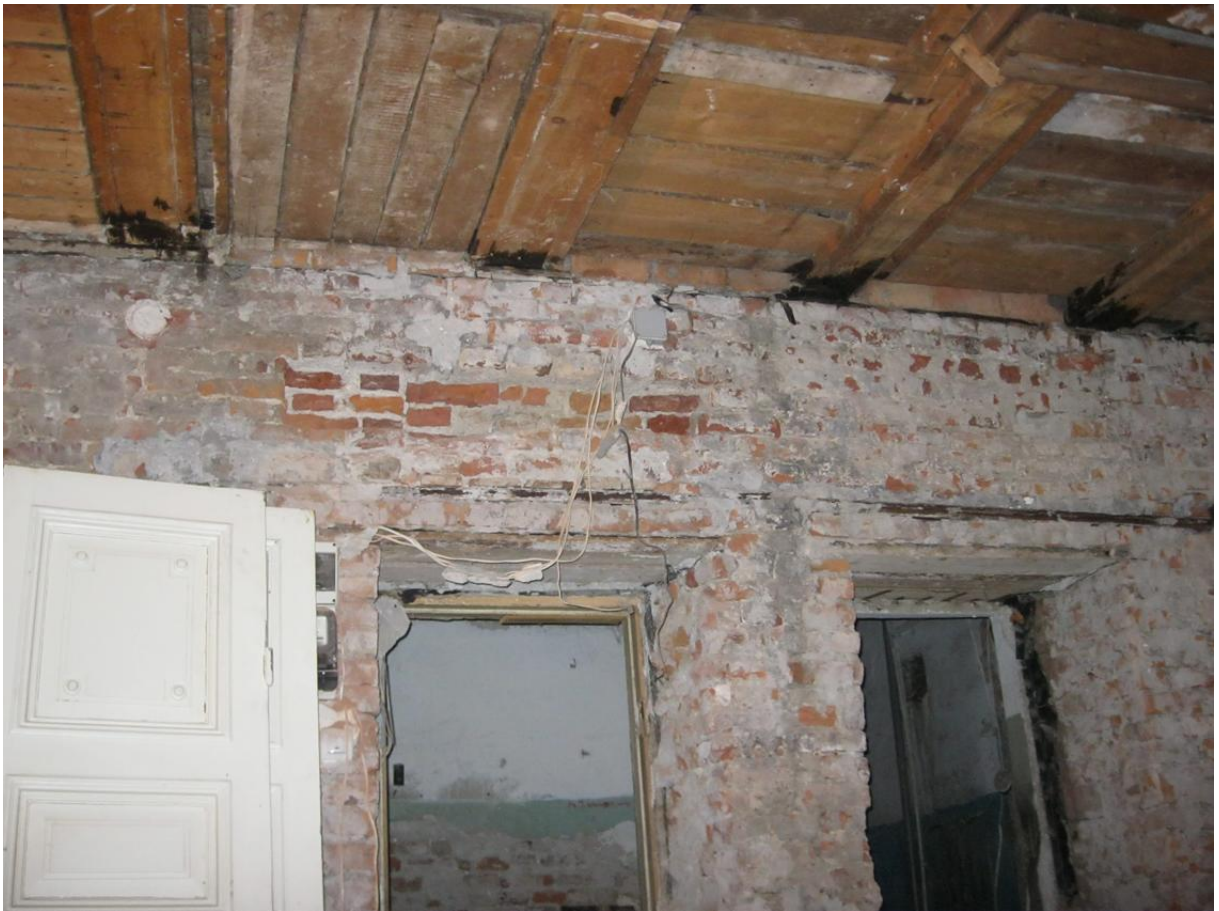
18. Выявленный объект культурного наследия «Дома И.А.Брылкина (2 здания)». Фрагмент внутреннего помещения квартиры.
