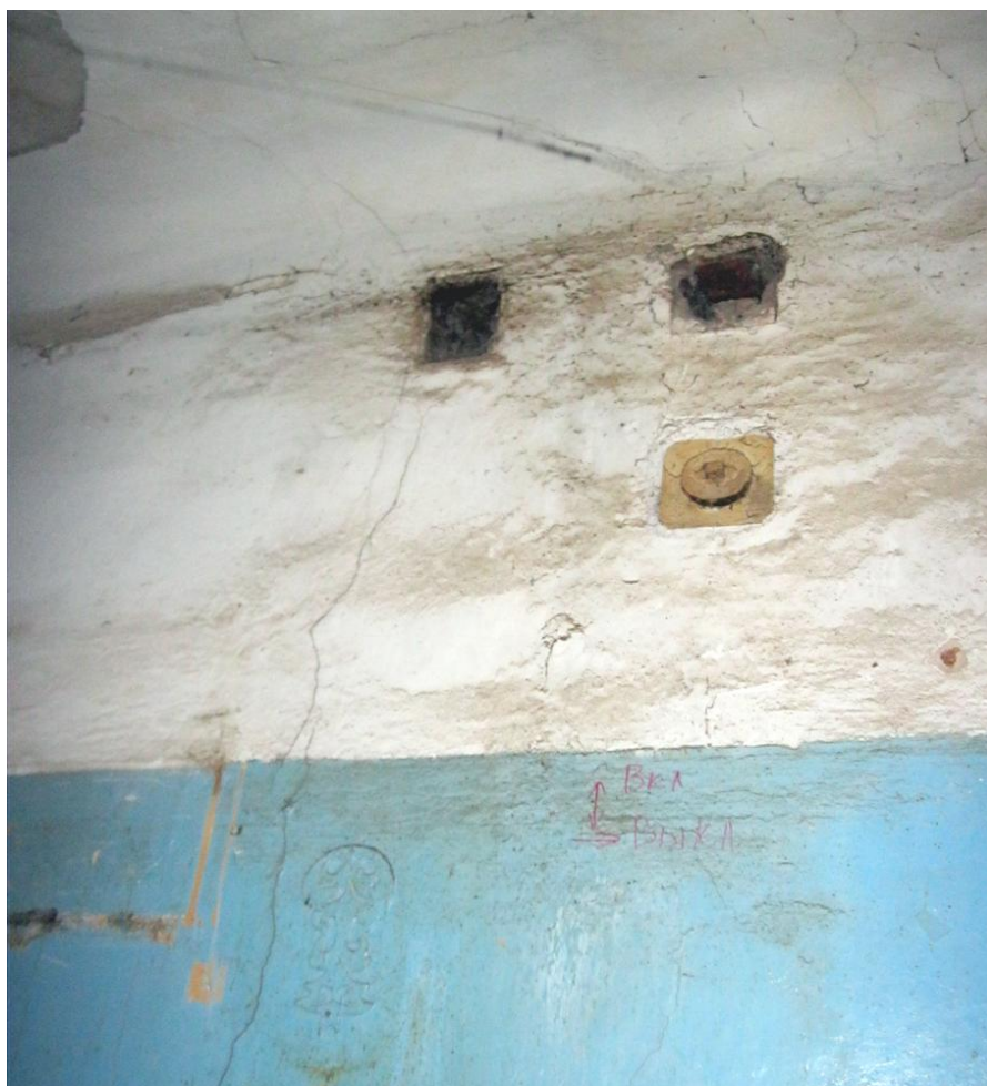
23. Выявленный объект культурного наследия «Дома И.А.Брылкина (2 здания)». Фрагмент внутреннего помещения квартиры. Кухня. Дымоходы.
