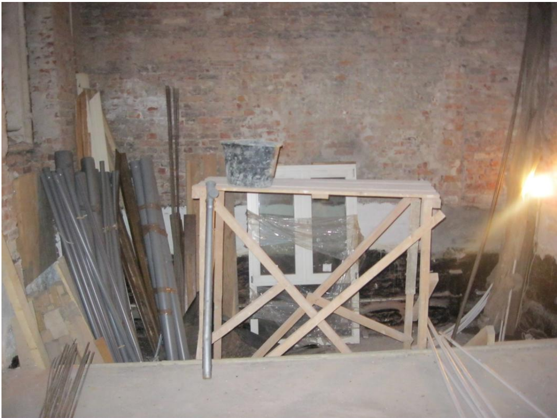
19. Выявленный объект культурного наследия «Дома И.А.Брылкина (2 здания)». Фрагмент внутреннего помещения квартиры.
