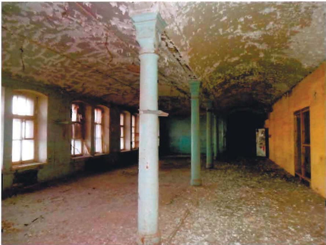
6. Чугунные колонны внутреннего каркаса.
