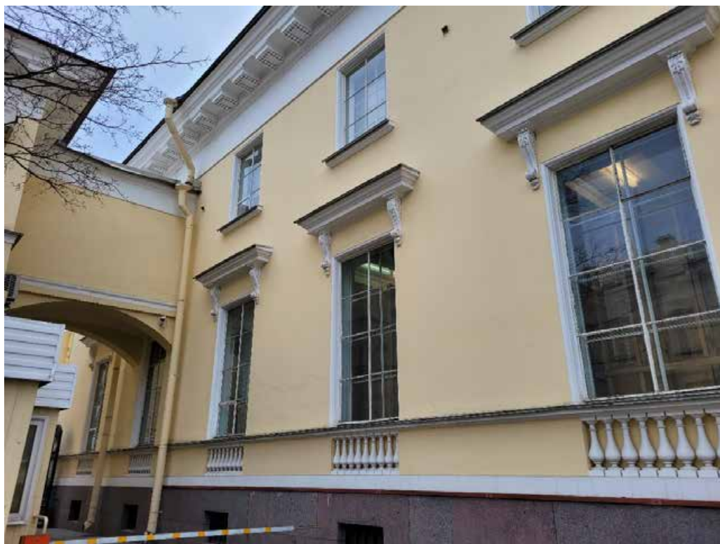
56. Вид на переходную галерею в уровне второго этажа между Флигелем служебным и Этнографическим музеем. ОКНФЗ «Корпус Этнографического отдела Русского музея (Этнографический музей)», входящий в состав ансамбля объекта ОКНФЗ «Дворец Великого князя Михаила Павловича (Русский музей Императора Александра III)», расположенный по адресу: Санкт-Петербург, ул. Инженерная, дом 4/1, литера Е (Инженерная ул., 4-а). Дата съемки: 28.02.2022.
