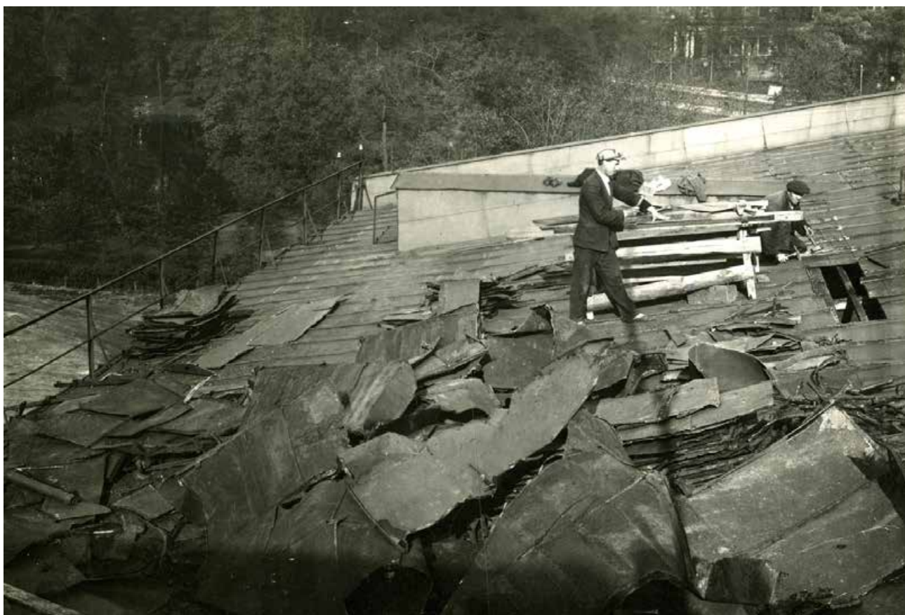
82. Ремонт крыши музея. 1945. https://ethnomuseum.ru/ .
