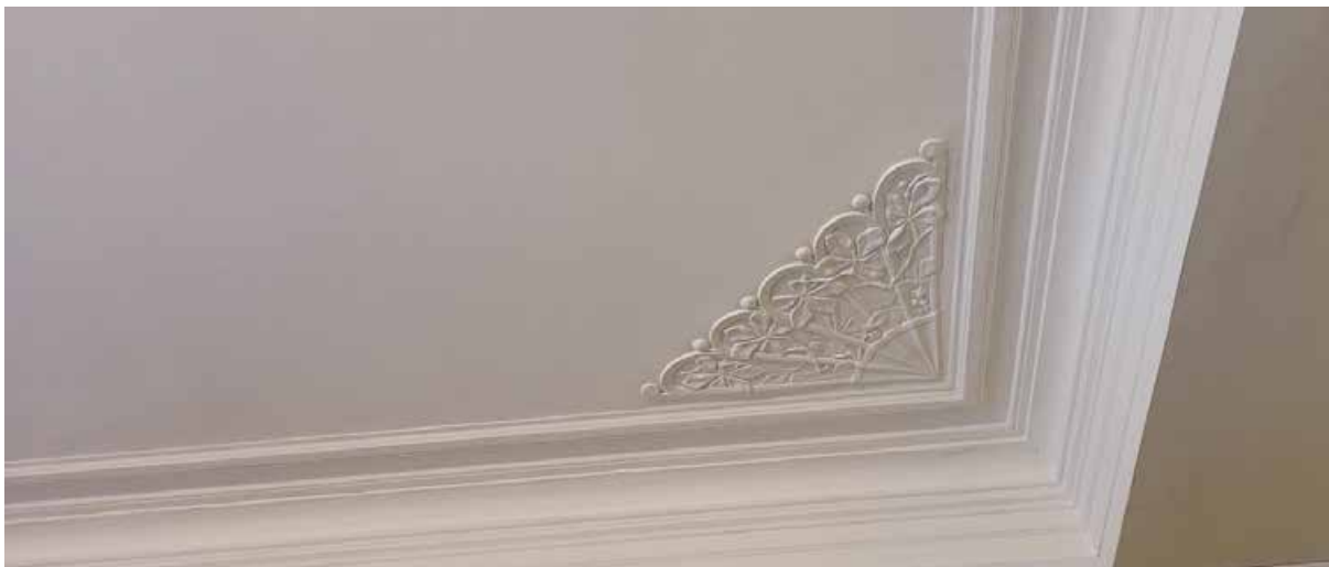
29. Оформление интерьера: профилированные лепные рама по периметру потолка, профилированный лепной карниз, лепные композиции по углам потолка. ОКНФЗ «Флигель служебный восточный Михайловского дворца (флигель Этнографического музея)», входящий в состав ансамбля ОКНФЗ «Дворец Великого князя Михаила Павловича (Русский музей Императора Александра III)», расположенный по адресу: Санкт-Петербург, ул. Инженерная, дом 4/1, литера М (Садовая ул., 1). Дата съемки: 28.02.2022.
