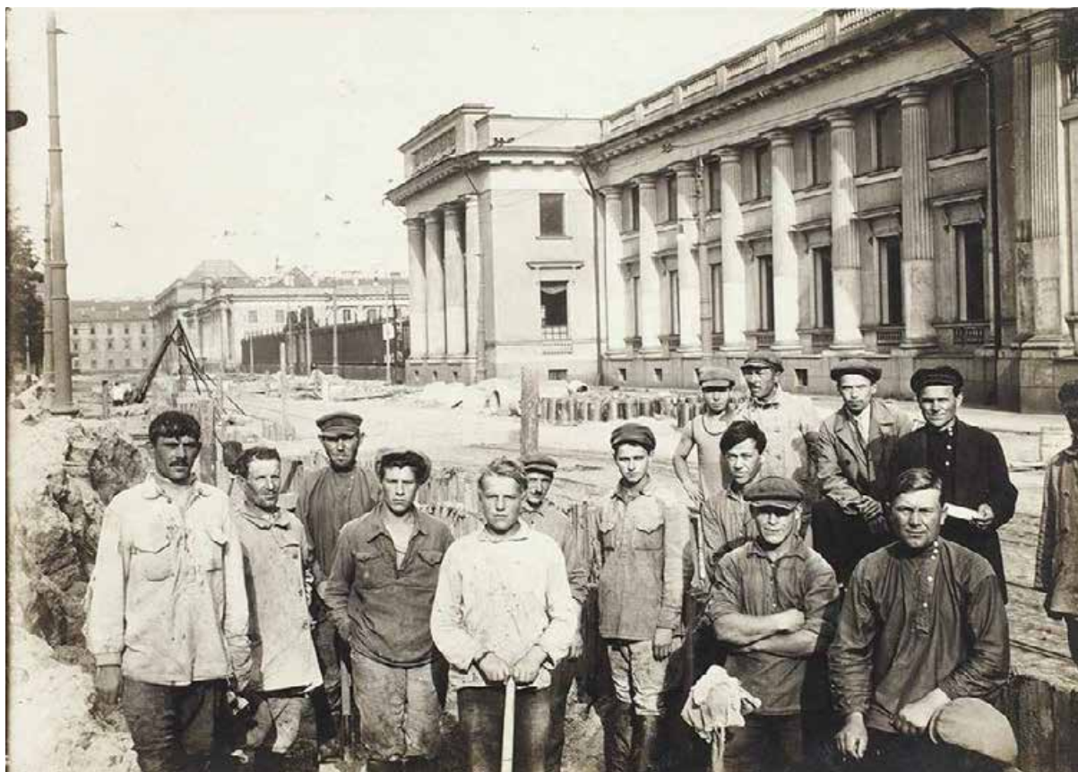
55. У Русского музея. Ведутся работы по прокладке коммуникаций и ремонту дорожного полотна. 1922. https://pastvu.com/ .
