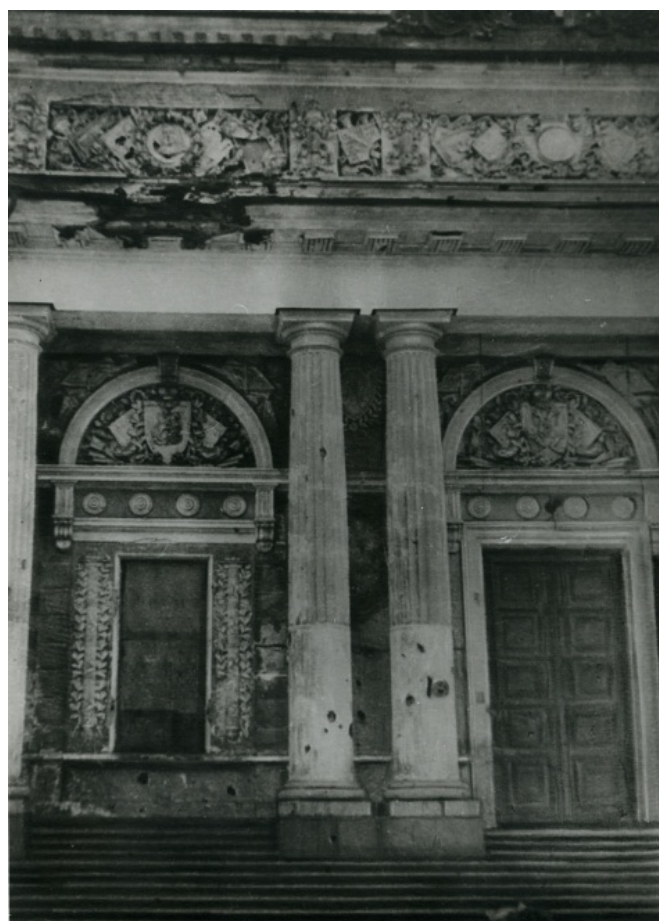
66. Центральный фасад здания музея во время войны со следами попадания артиллерийских снарядов. 1943. https://ethnomuseum.ru/ .
