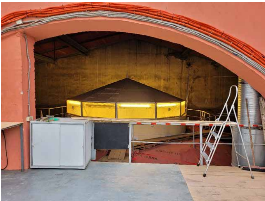
25. Сводчатое перекрытие. Фрагмент. ОКНФЗ «Корпус Этнографического отдела Русского музея (Этнографический музей)», входящий в состав ансамбля объекта ОКНФЗ «Дворец Великого князя Михаила Павловича (Русский музей Императора Александра III)», расположенный по адресу: Санкт-Петербург, ул. Инженерная, дом 4/1, литера Е (Инженерная ул., 4-а). Дата съемки: 28.02.2022.
