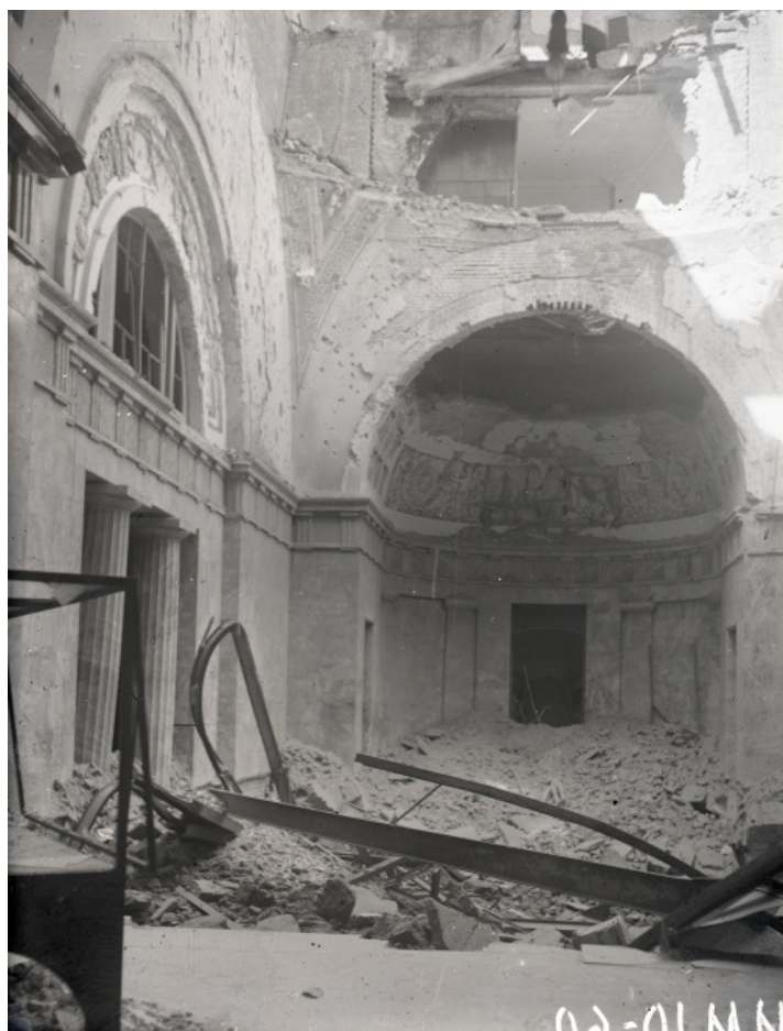
70. Аванзал музея, разрушенный после попадания фугасной бомбы во время бомбежки Ленинграда 5 декабря 1941 года. 1943. https://ethnomuseum.ru/ .
