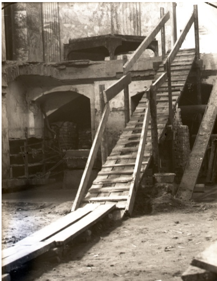
83. Переход над разрушенным перекрытием Аванзала. 1945. https://ethnomuseum.ru/ .
