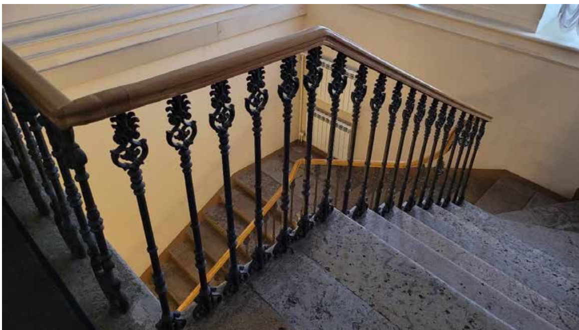
33. Историческая лестница с историческим материалом ограждения. ОКНФЗ «Флигель служебный восточный Михайловского дворца (флигель Этнографического музея)», входящий в состав ансамбля ОКНФЗ «Дворец Великого князя Михаила Павловича (Русский музей Императора Александра III)», расположенный по адресу: Санкт-Петербург, ул. Инженерная, дом 4/1, литера М (Садовая ул., 1). Дата съемки: 28.02.2022.
