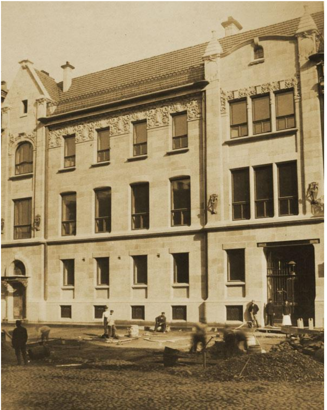
1. Дом Бажанова по ул. Николаевской, 72 в Санкт-Петербурге. Окончание строительства. Фото 1909 г.
