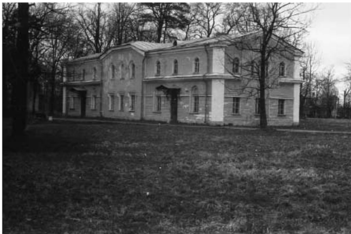
Илл. 129. Корпус служебный Коттеджа. 1995 г.
