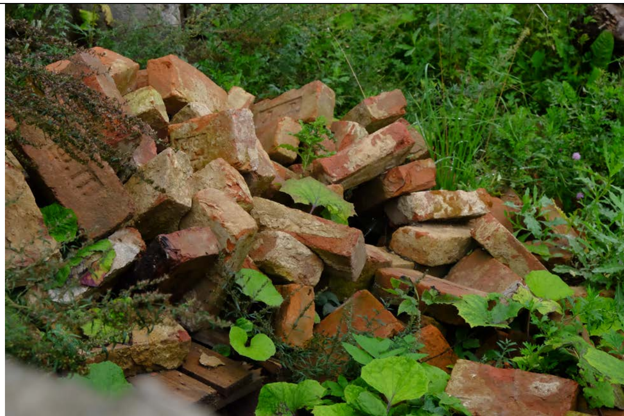
9. «Две казармы для служащих Варшавского вокзала». Малая Митрофаньевская улица, дом 7, корпус 1, литера А; Малая Митрофаньевская улица, дом 7, корпус 2, литера А. Завалы кирпичей, вид с юга.
