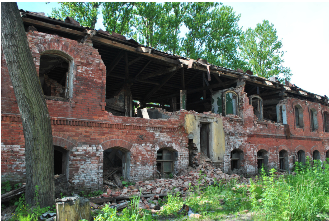
64. Попытка демонтажа казарм. Июнь 2018. Источник: Градозащитный Петербург protect812.com
