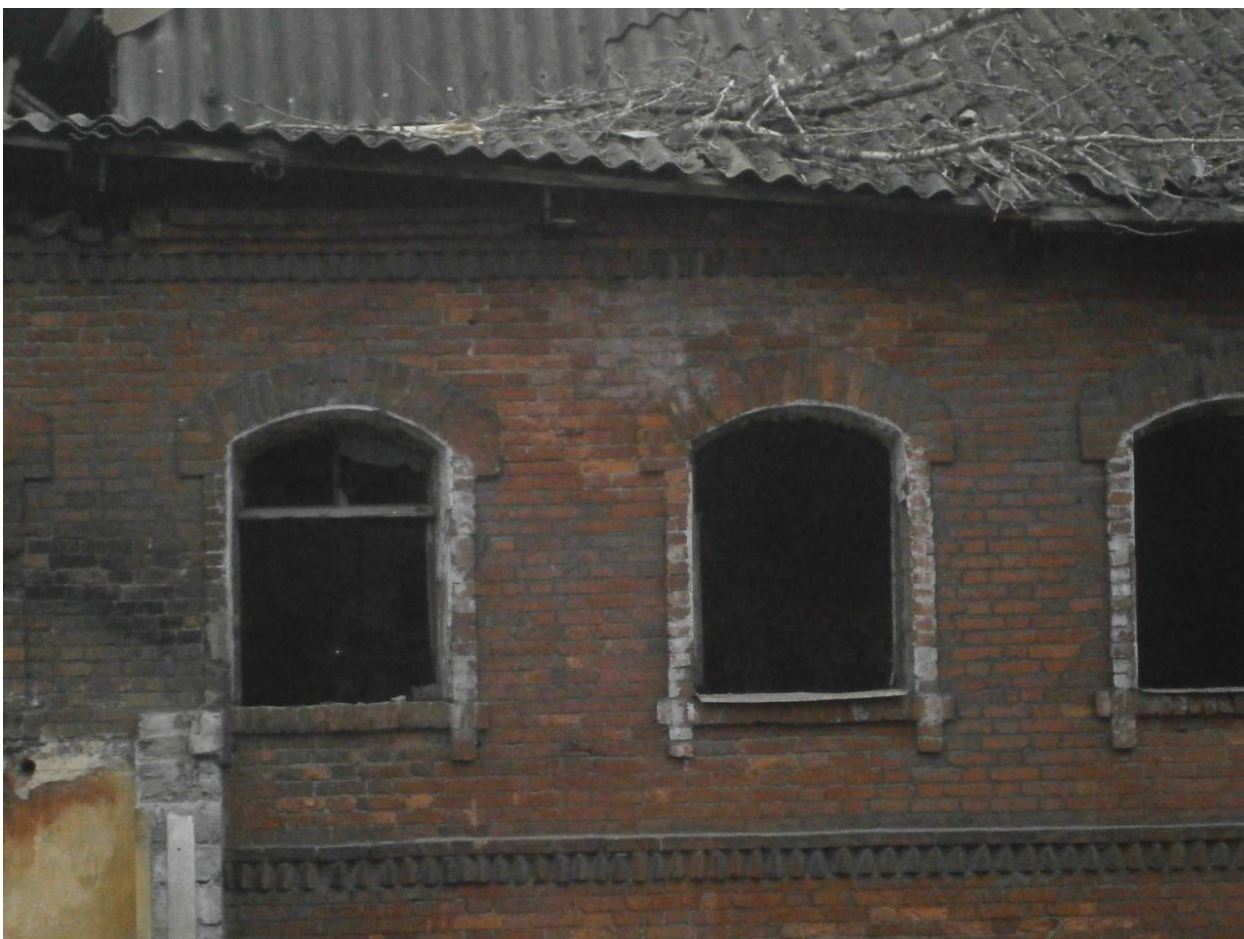
62. Восточный корпус. 2017. Источник: Архитектурный сайт Петербурга www.citywalls.ru
