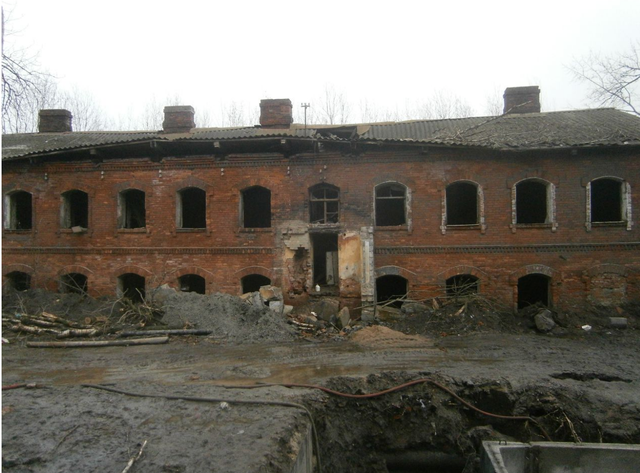
59. Восточный корпус. 2017. Источник: Архитектурный сайт Петербурга www.citywalls.ru
