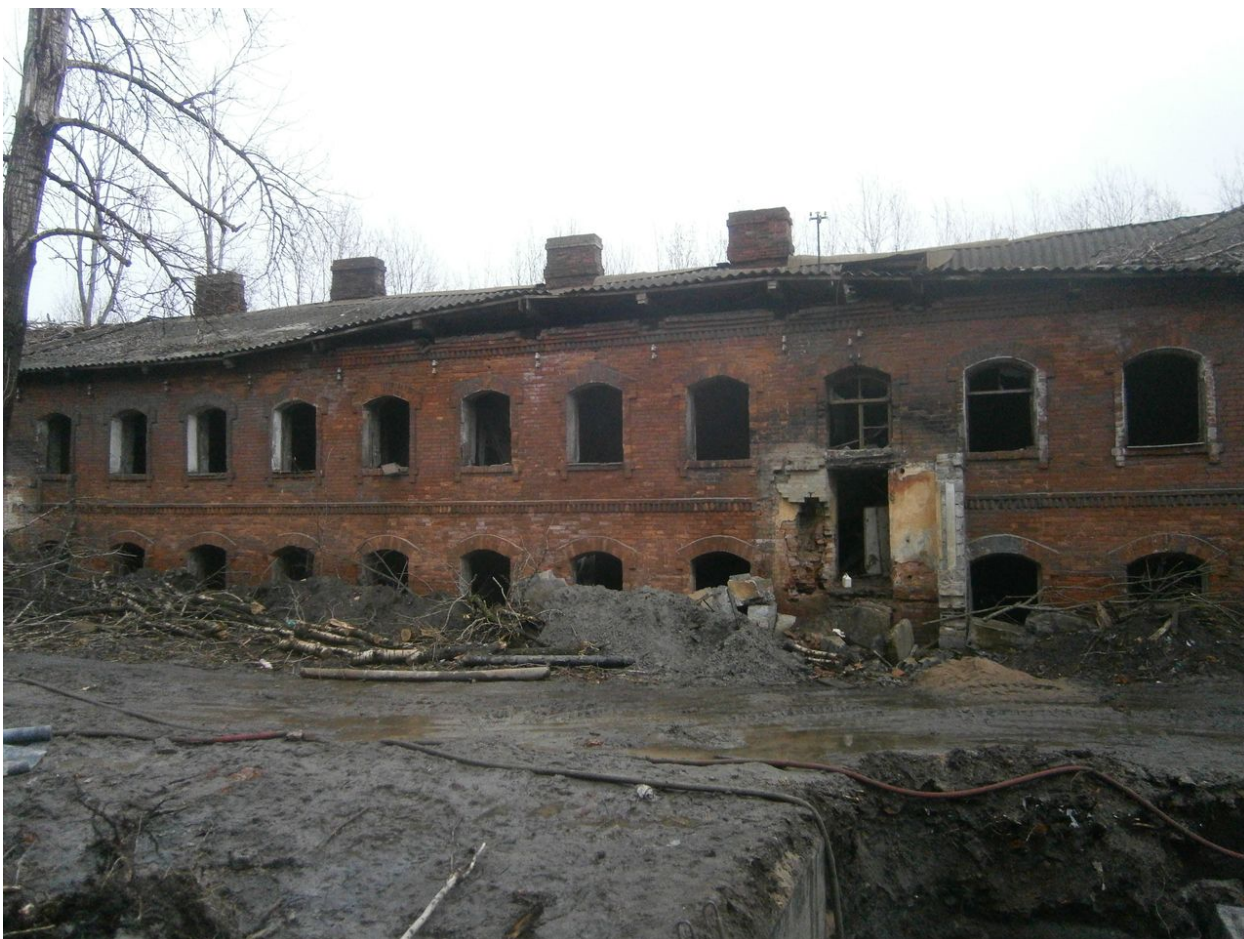
60. Восточный корпус. 2017. Источник: Архитектурный сайт Петербурга www.citywalls.ru
