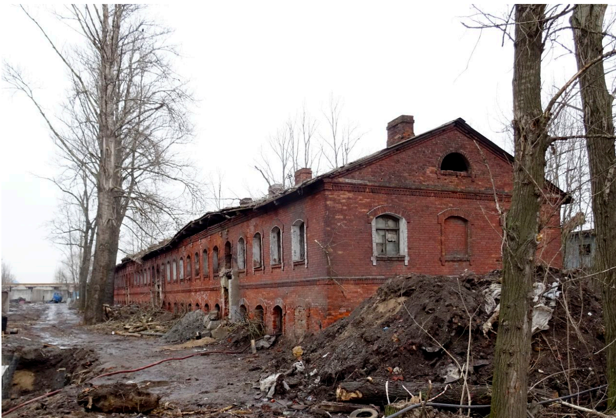
58. Восточный корпус. 2017. Источник: Архитектурный сайт Петербурга www.citywalls.ru
