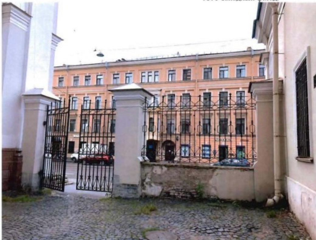
18. Фрагмент ограды (северо-западная часть) вдоль Съездовской линии. Северо-восточный фасад.
