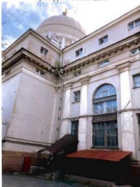
3. Фрагмент северо-западного фасада объекта культурного наследия.
