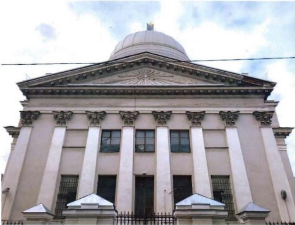
5. Северо-восточный фасад объекта культурного наследия.
