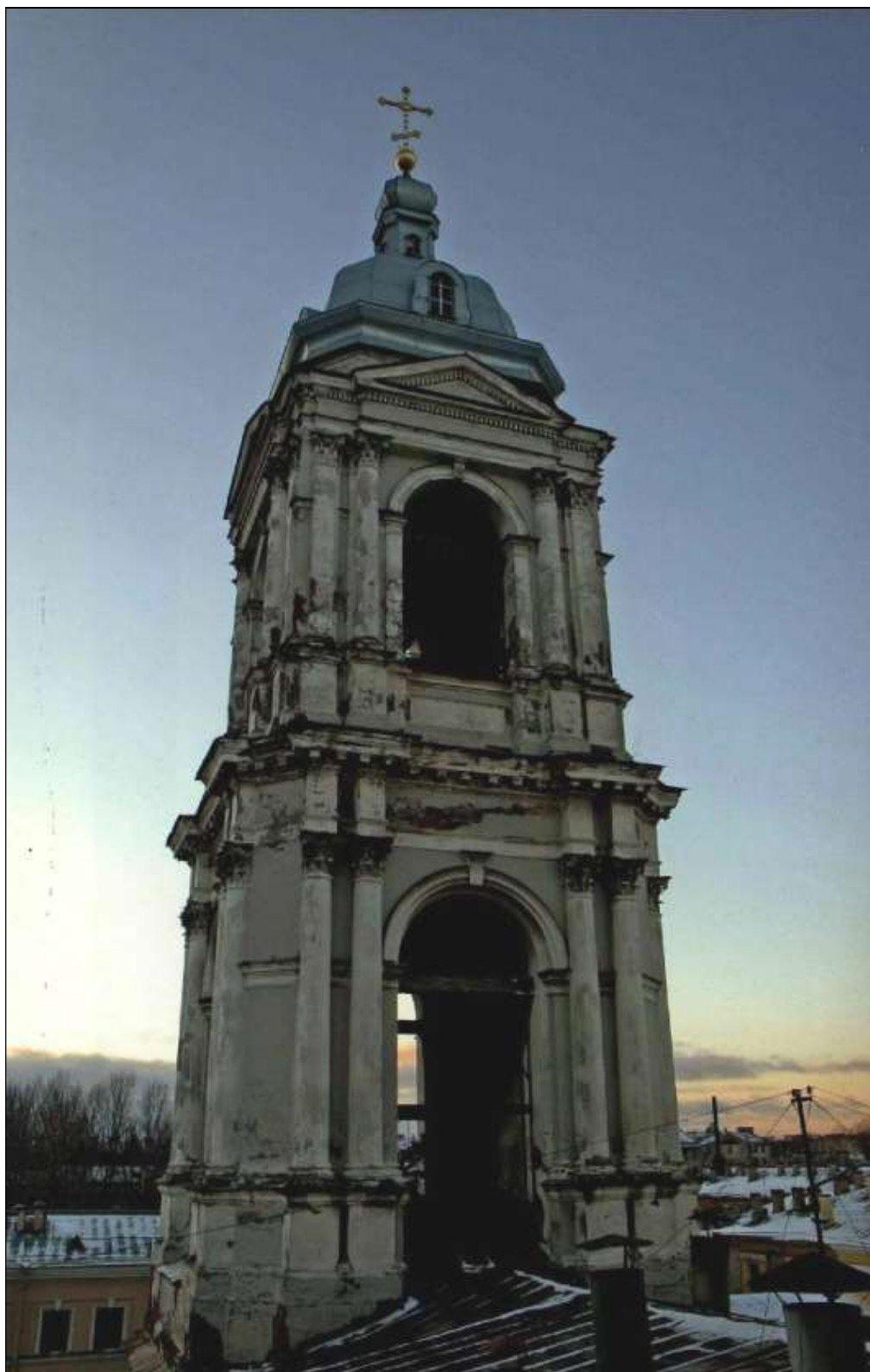
13. Натурная съёмка. Фотография колокольни. 2004 г.
