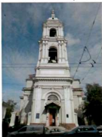
1. Западный лицевой фасад
