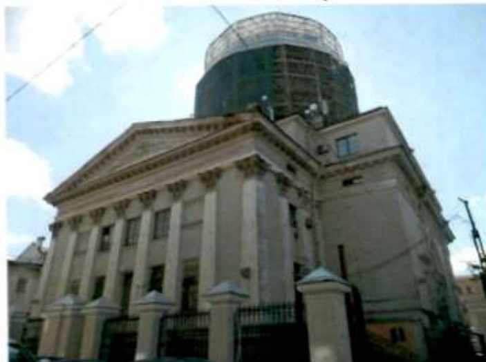
3. Восточный лицевой фасад
