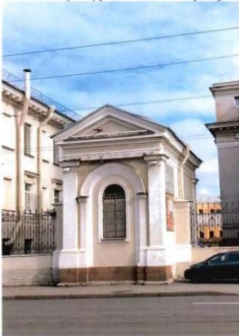
11. Юго-западный фасад северо-западной Часовни.
