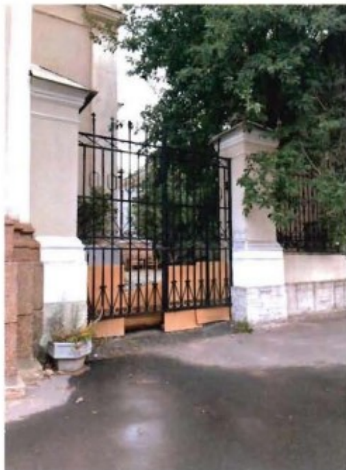
17. Фрагмент ограды (юго-восточная часть) вдоль Съездовской линии. Юго-западный фасад.
