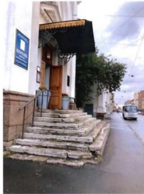
2. Юго-западный фасад объекта культурного наследия. Главный вход.
