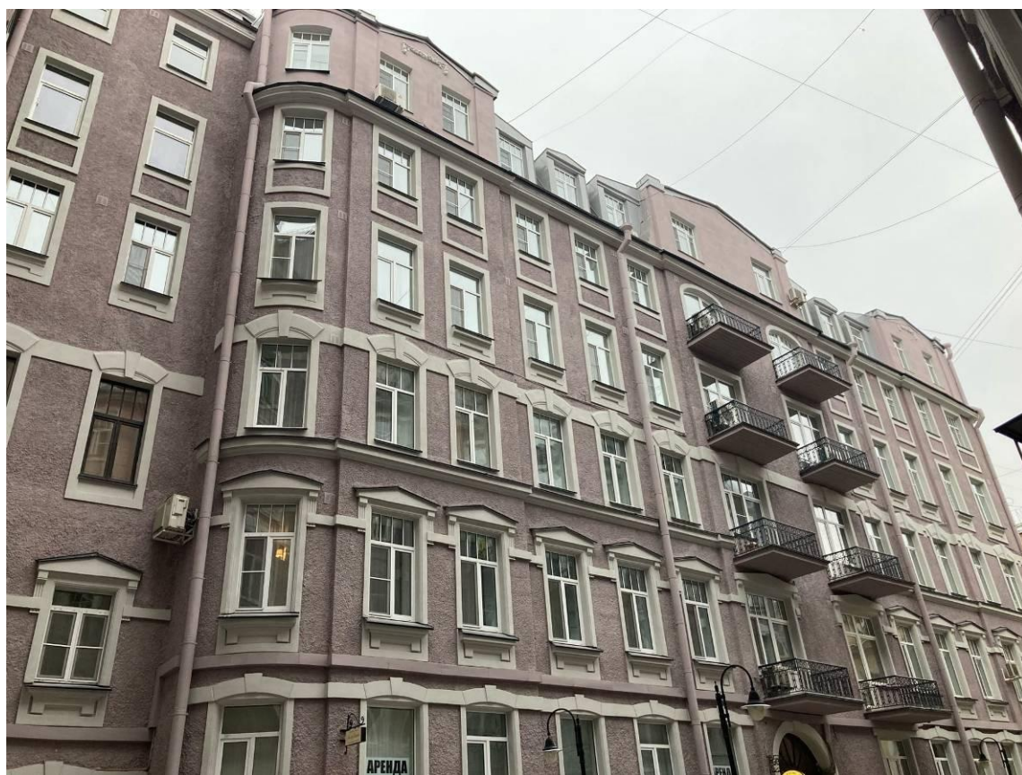
Фото 8. Фрагмент дворового фасада выявленного объекта культурного наследия «Дом О.П. Кушелевой»
