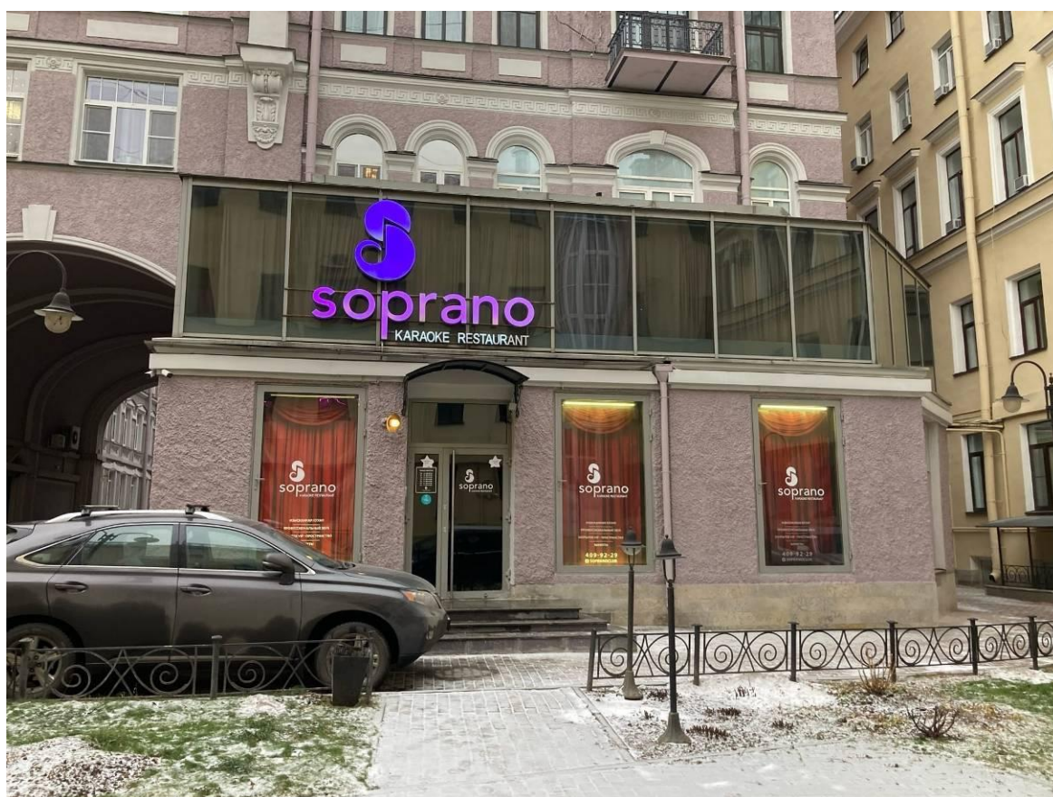
Фото 20. Фрагмент дворового фасада выявленного объекта культурного наследия «Дом О.П. Кушелевой»
