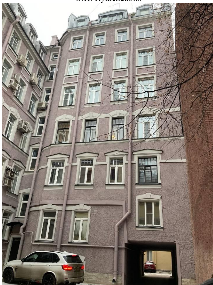
Фото 12. Фрагмент дворового фасада выявленного объекта культурного наследия «Дом О.П. Кушелевой»
