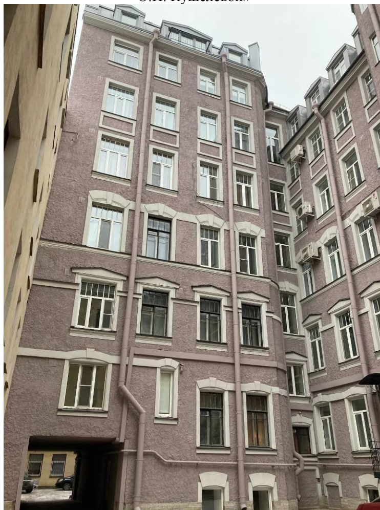
Фото 14. Фрагмент дворового фасада выявленного объекта культурного наследия «Дом О.П. Кушелевой»
