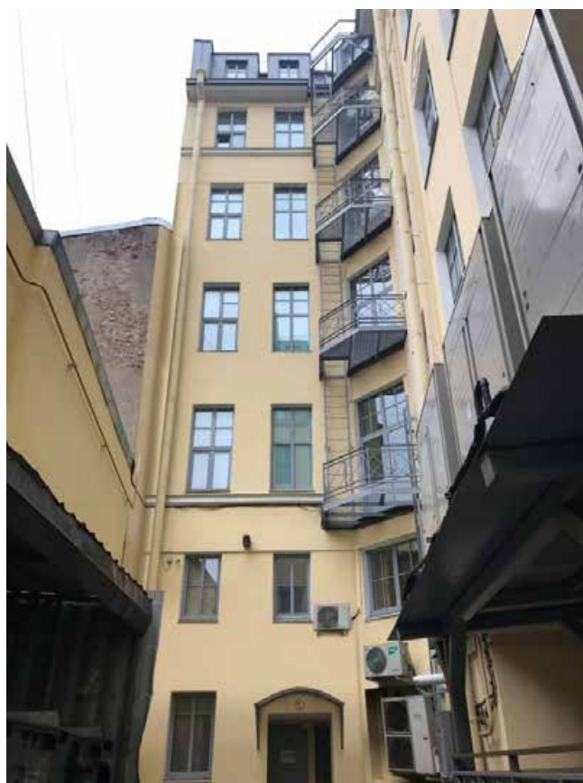
Фото 3. Фрагмент дворового фасада объекта культурного наследия регионального значения «Бывший дом Мертенса (фасады)»
