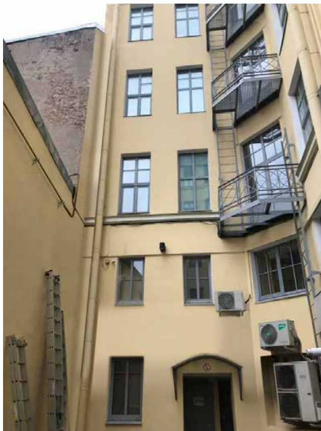
Фото 2. Фрагмент дворового фасада объекта культурного наследия регионального значения «Бывший дом Мертенса (фасады)»
