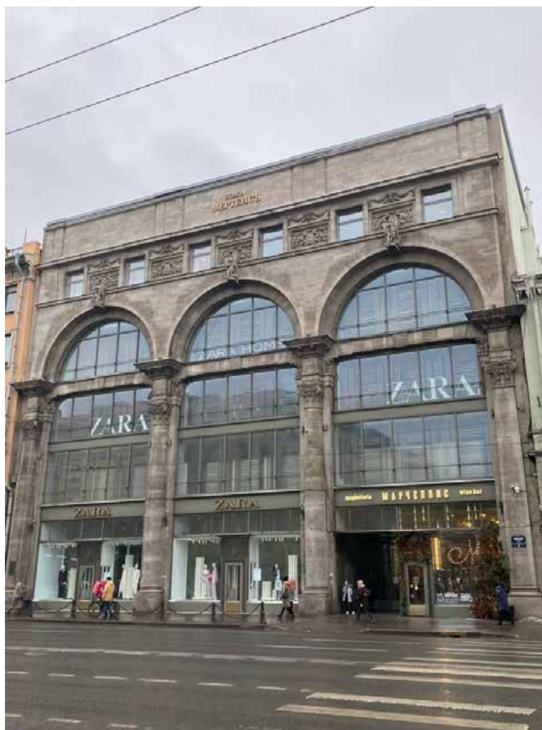
Фото 1. Лицевой фасад объекта культурного наследия регионального значения «Бывший дом Мертенса (фасады)»
