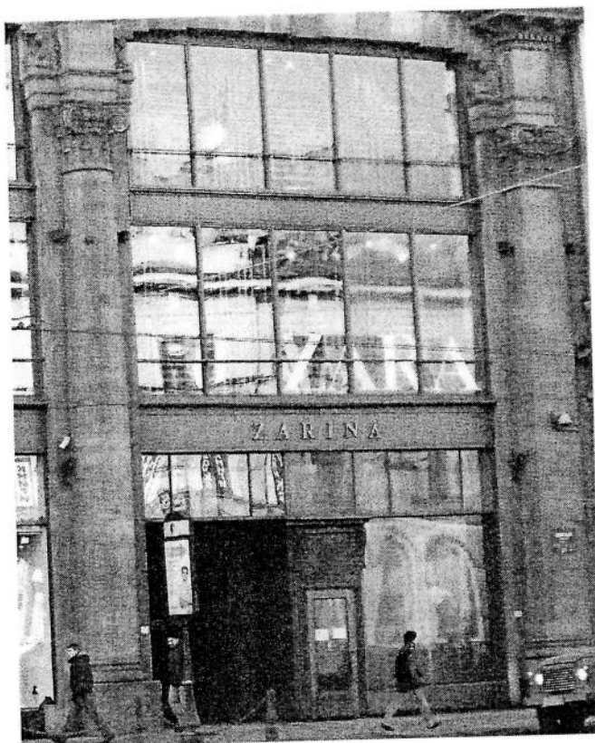
Лицевой фасад. Оконные проемы цокольного этажа. Съёмка 22.03.2012, Ю.Е. Межевич
