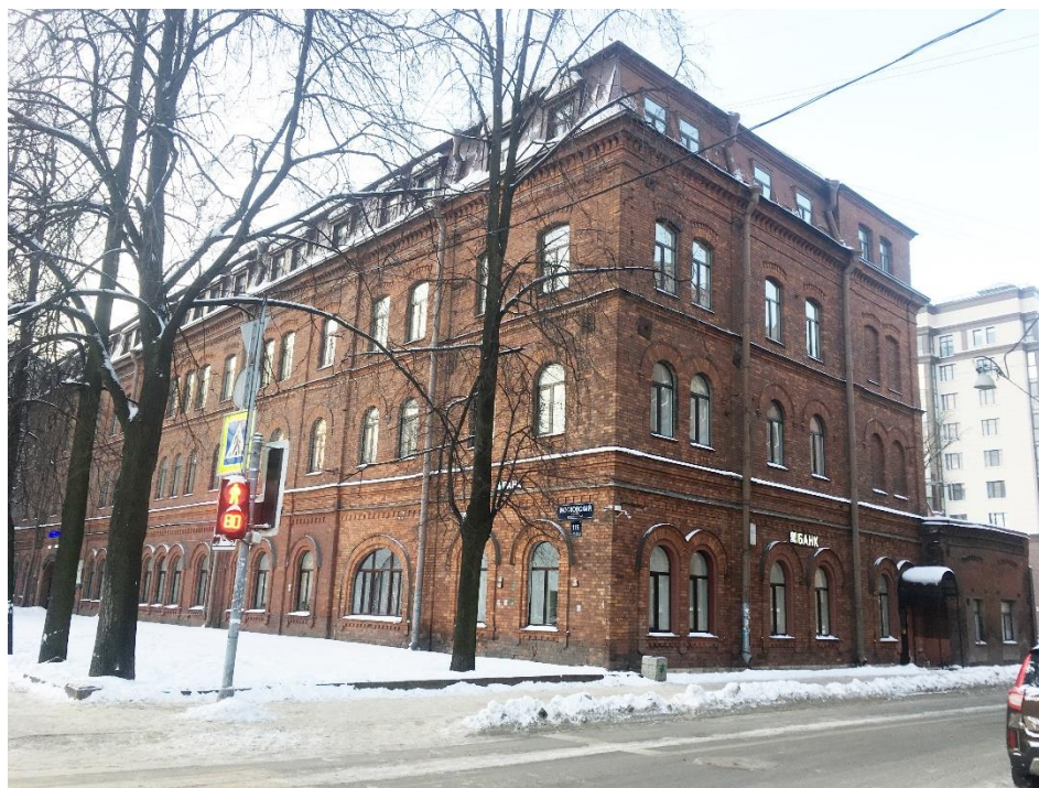
Фото 5. Перспективный вид с Московского проспекта. Лицевой и боковой фасады. Общее загрязнение цокольной части.
