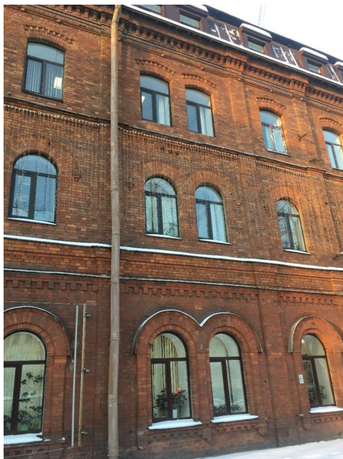
Фото 4. Фрагмент лицевого фасада по Московскому проспекту по оси «А» в осях «4-5».
