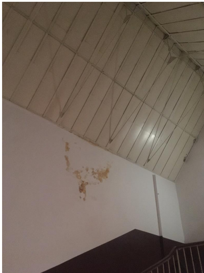
Фото 21. Световой фонарь в осях «4-3». Вид с лестницы.
