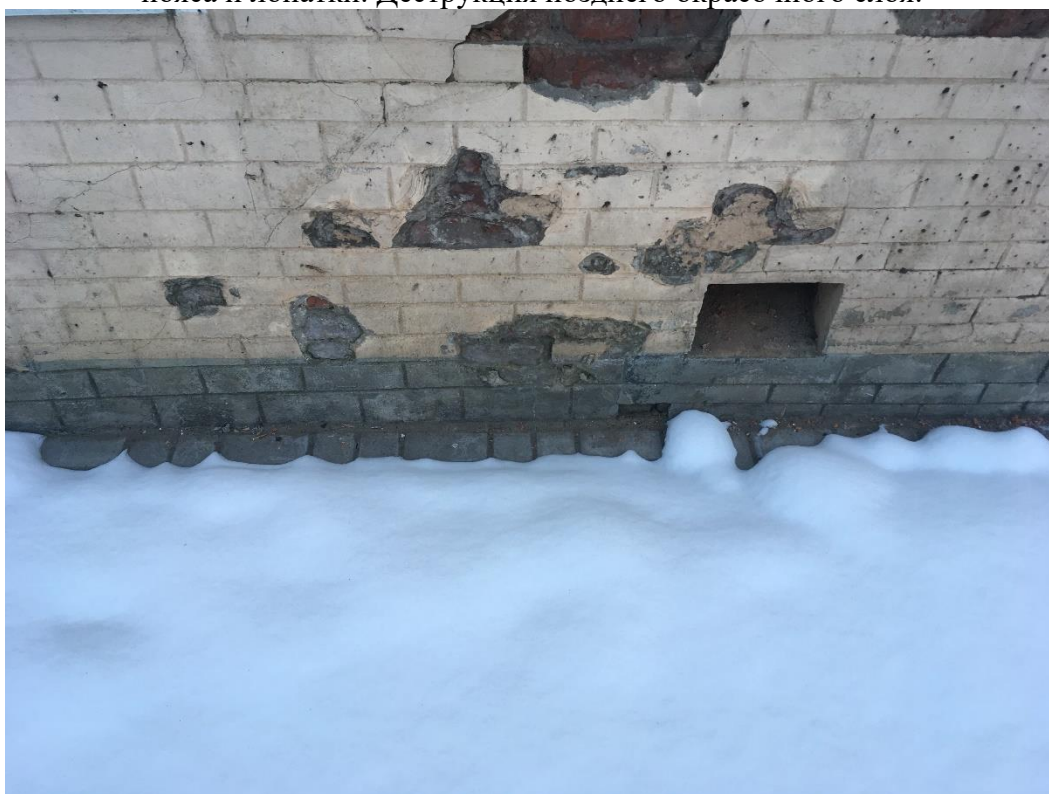
Фото 18. Фрагмент стены м/о «5-4» в уровне 1-го этажа по оси «Е». Мощение тротуара выше отметки цоколя.
