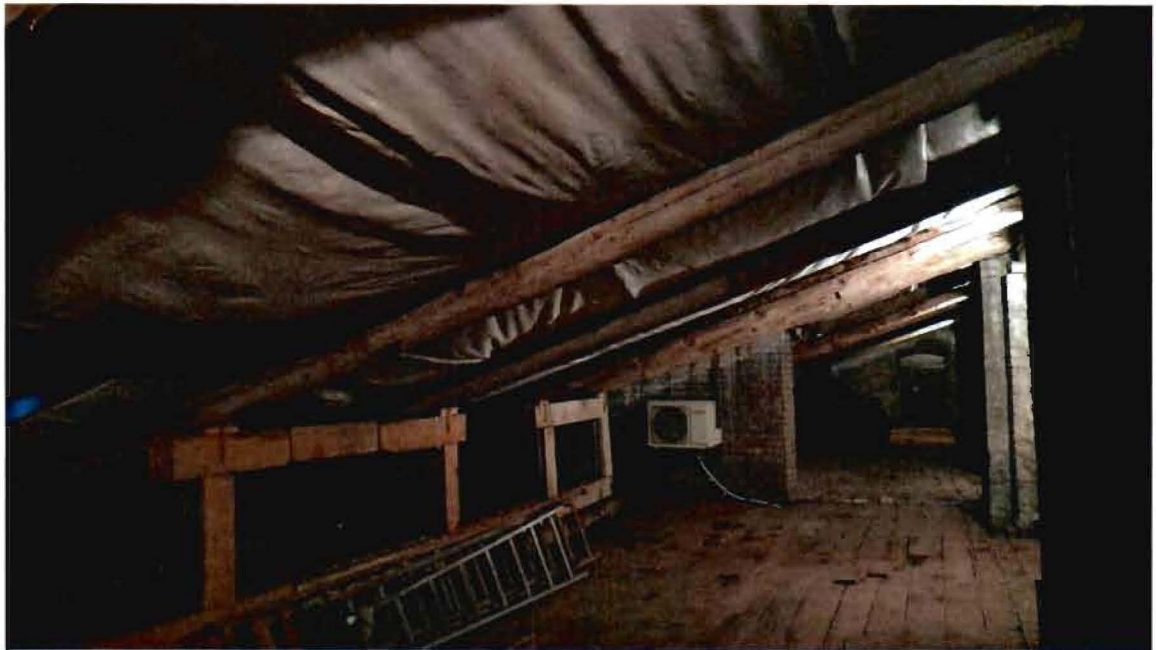
17. Стропильная система
