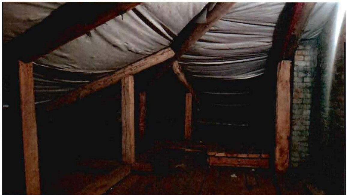
17. Стропильная система
