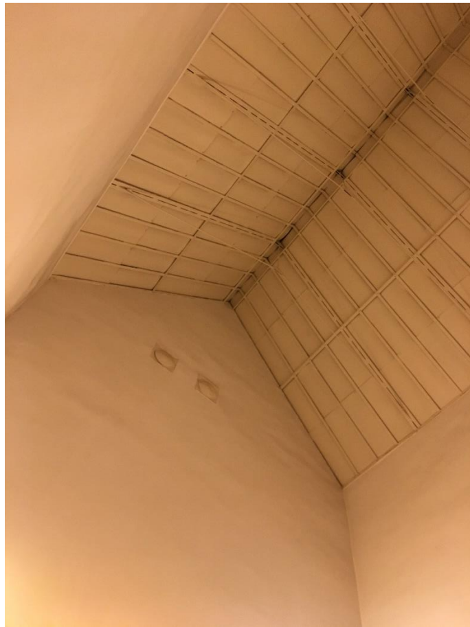
Фото 19. Световой фонарь в осях «2-1». Вид с лестницы.
