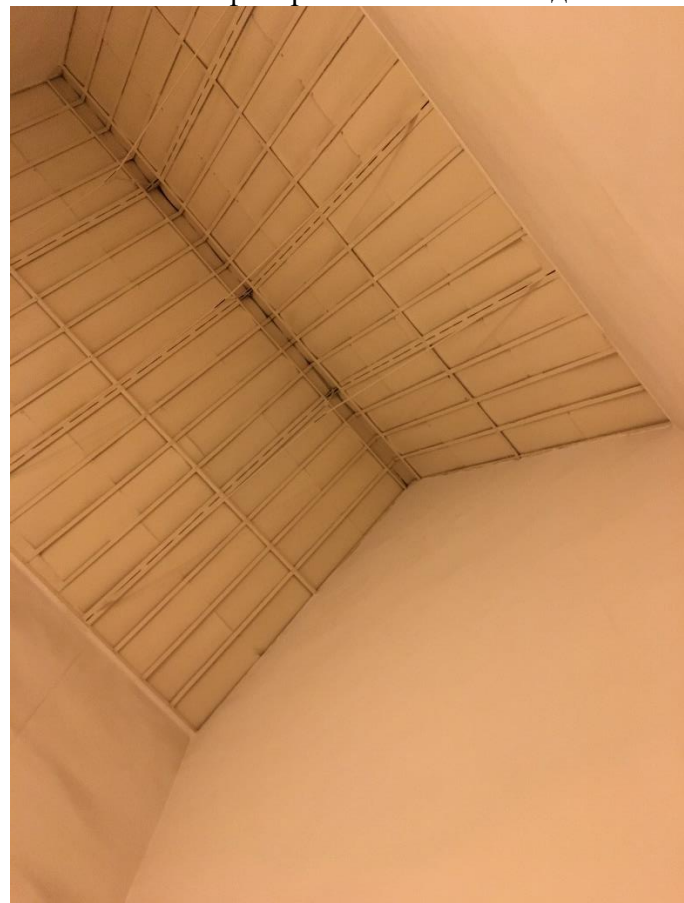
Фото 20. Световой фонарь в осях «2-1». Вид с лестницы.
