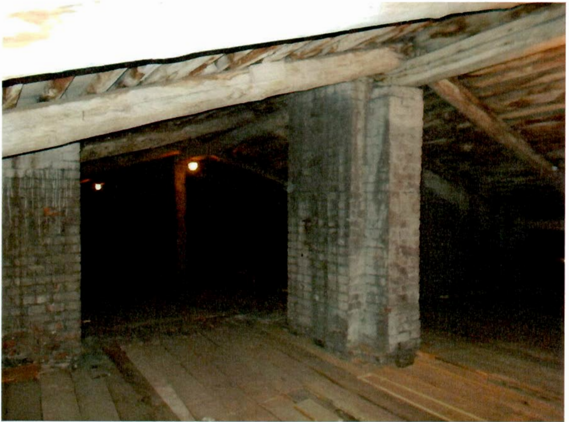
21. Стропильная система
