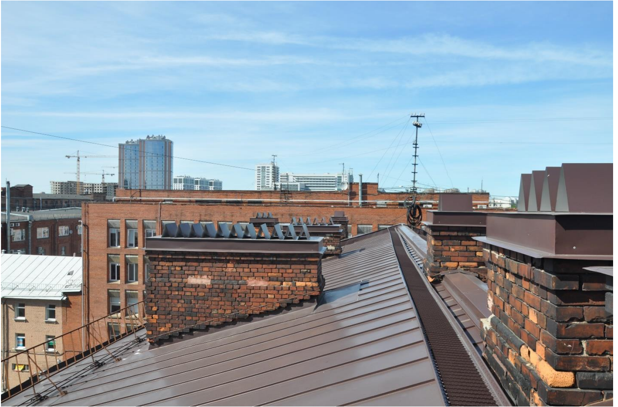
Фото 23. Вид с кровли на Заставскую улицу.
