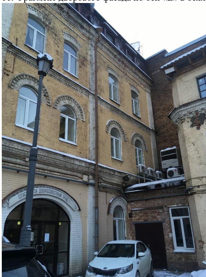
Фото 12. Фрагмент дворового фасада по оси «Е» в осях «2-1».
