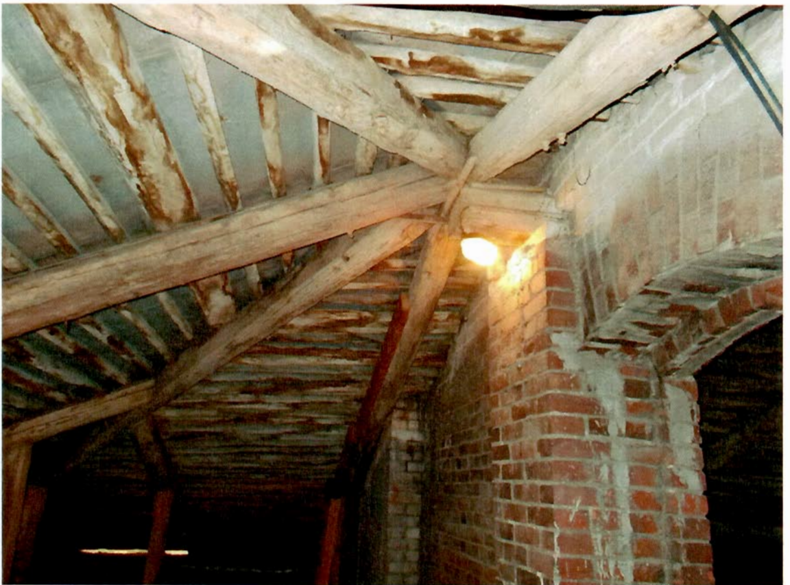
21. Стропильная система
