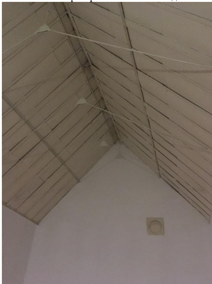
Фото 22. Световой фонарь в осях «4-3». Вид с лестницы.
