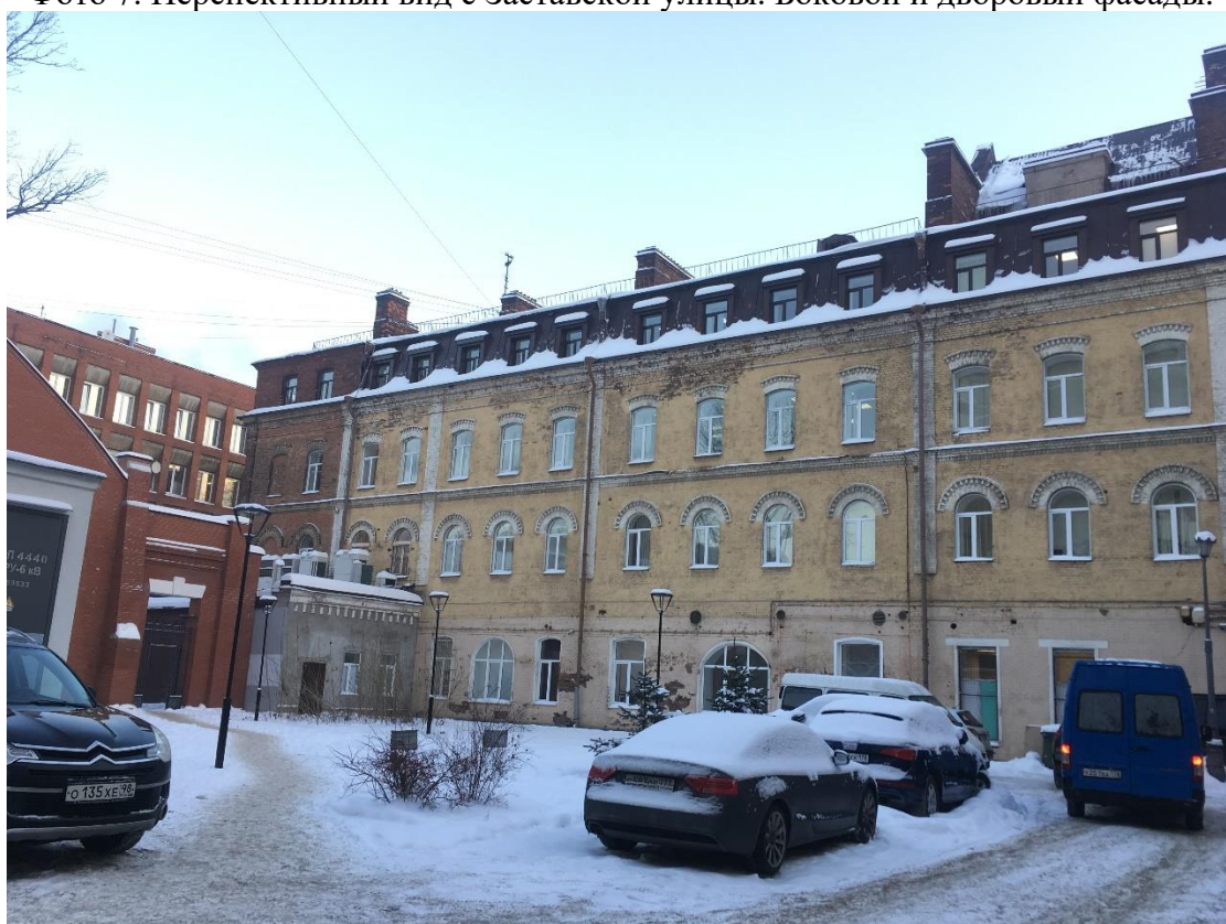
Фото 8. Общий вид дворового фасада по оси «Е» в осях «8-3».
