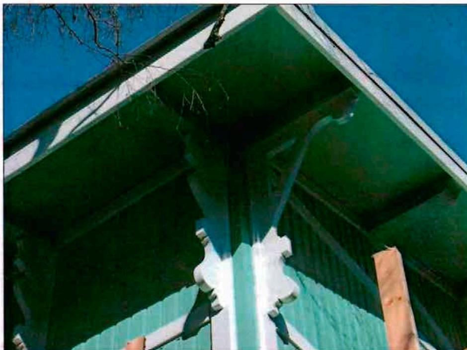
Фото 3. Южный фасад. Фрагмент. Кронштейны венчающего карниза.
