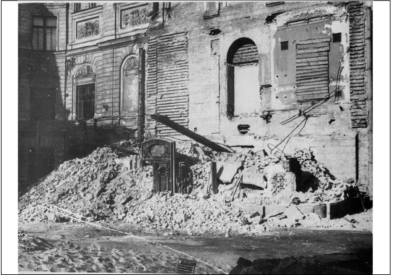
9. Развалины Царского павильона. Фото до 1943-1944 гг.
