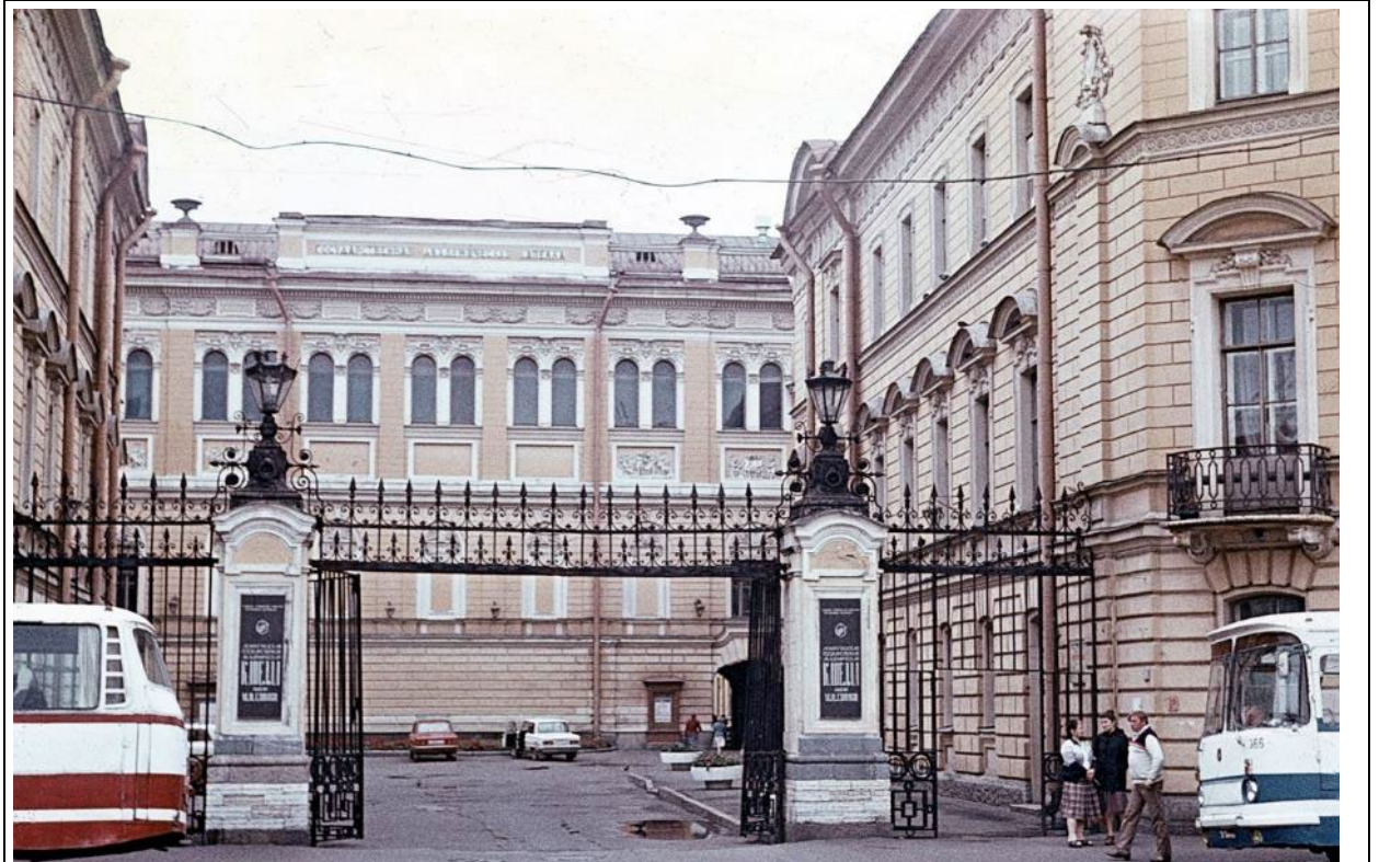
10. Вид на главный фасад капеллы, 1985 г.
