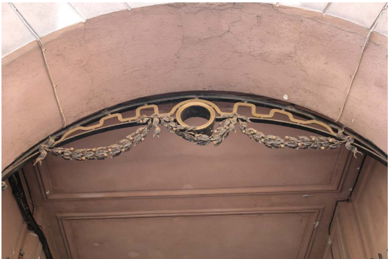
17. Фрагмент оформления проездной арки. Вид с северо-востока
