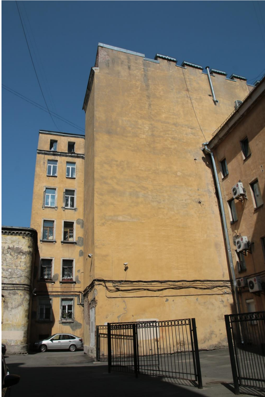
4. Общий вид дворовых фасадов. Вид с юго-востока
