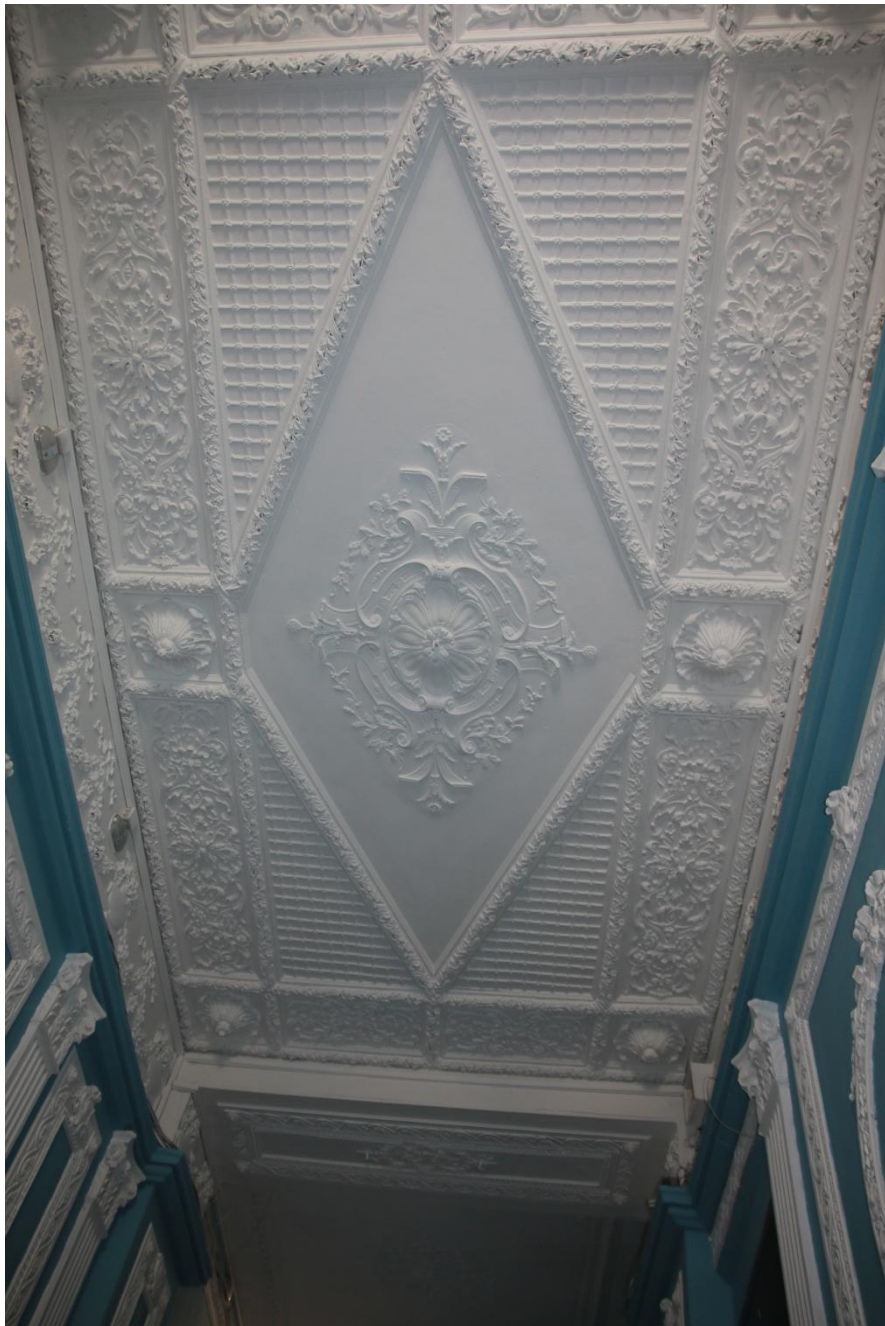
31. Интерьер вестибюля парадного входа. Оформление потолка
