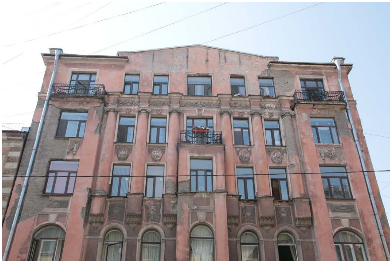
9. Фрагмент главного фасада. Вид с северо-востока
