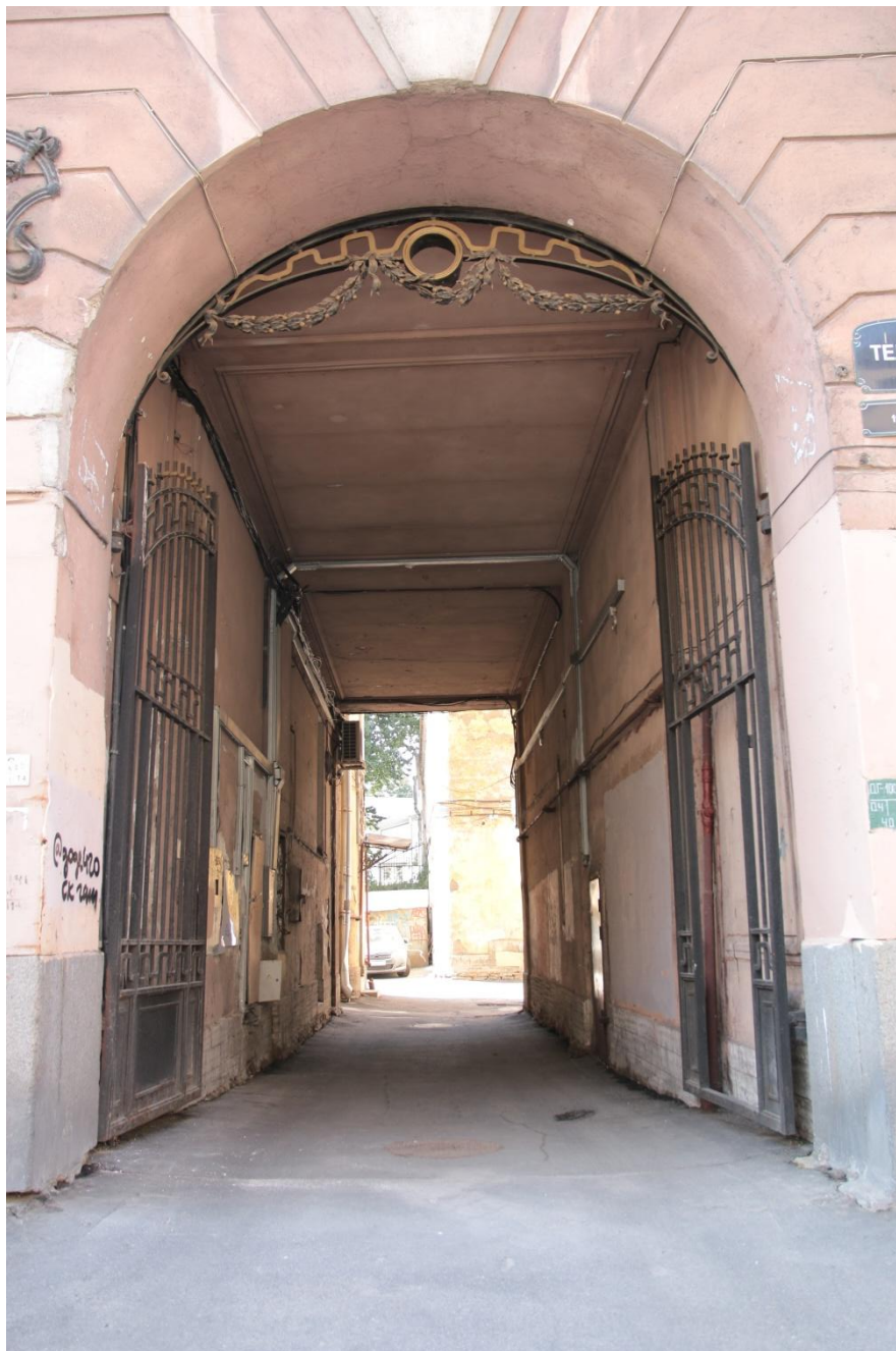
15. Фрагмент главного фасада. Проездная арка. Вид с северо-востока
