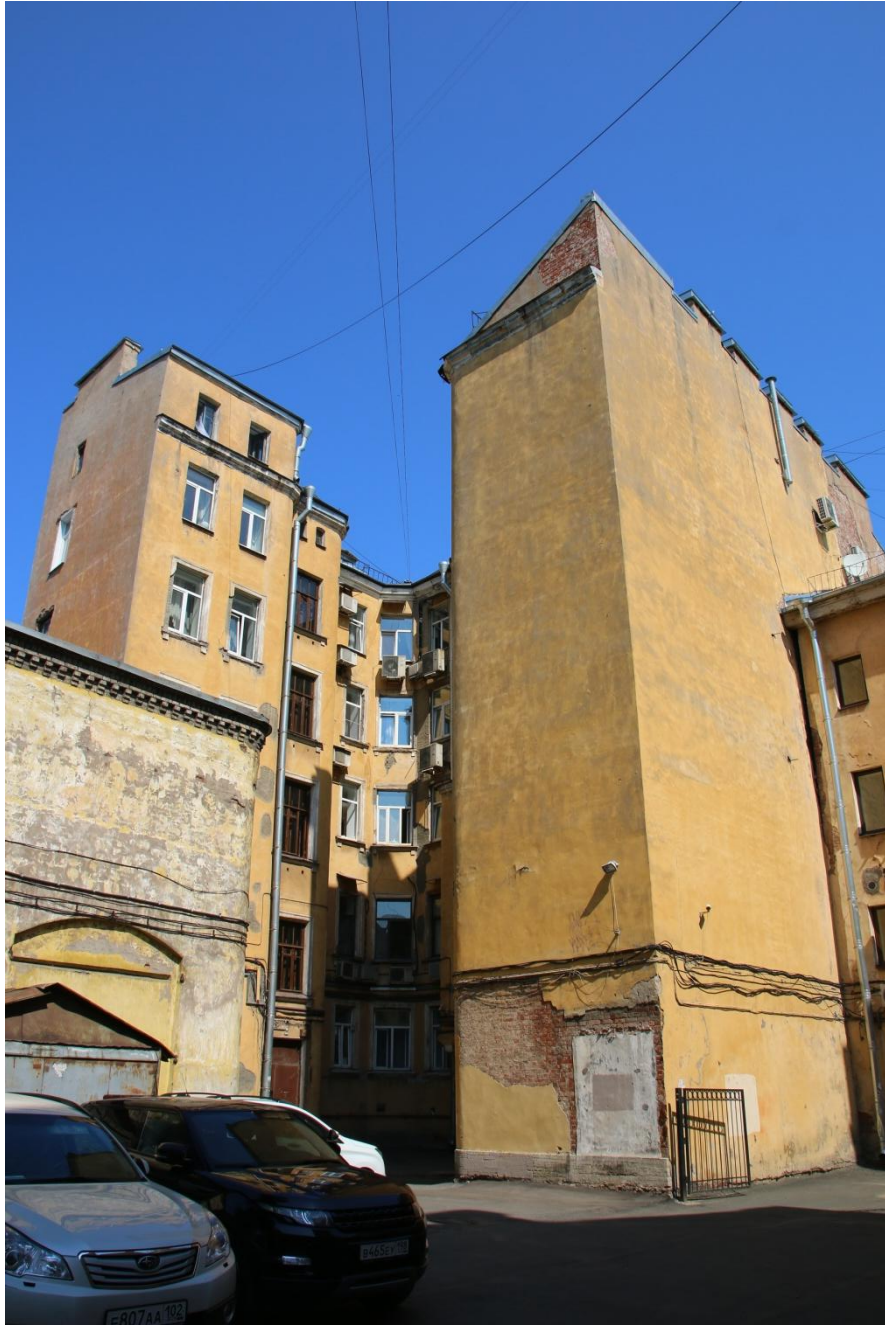
5. Общий вид дворовых фасадов. Вид с юга
