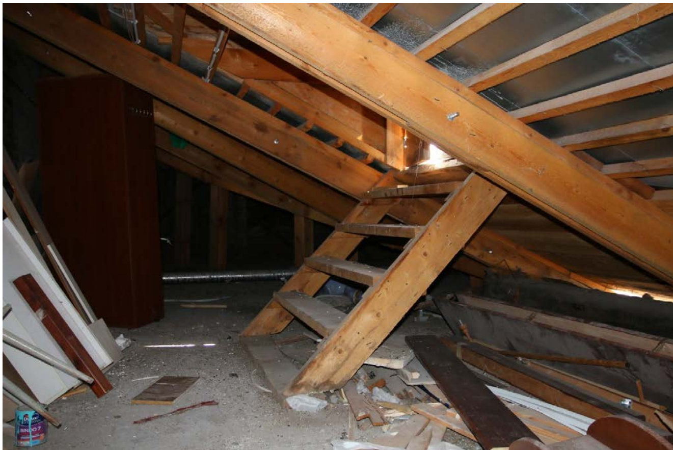
82. Фрагмент интерьера чердачного помещения дворовой парадной
