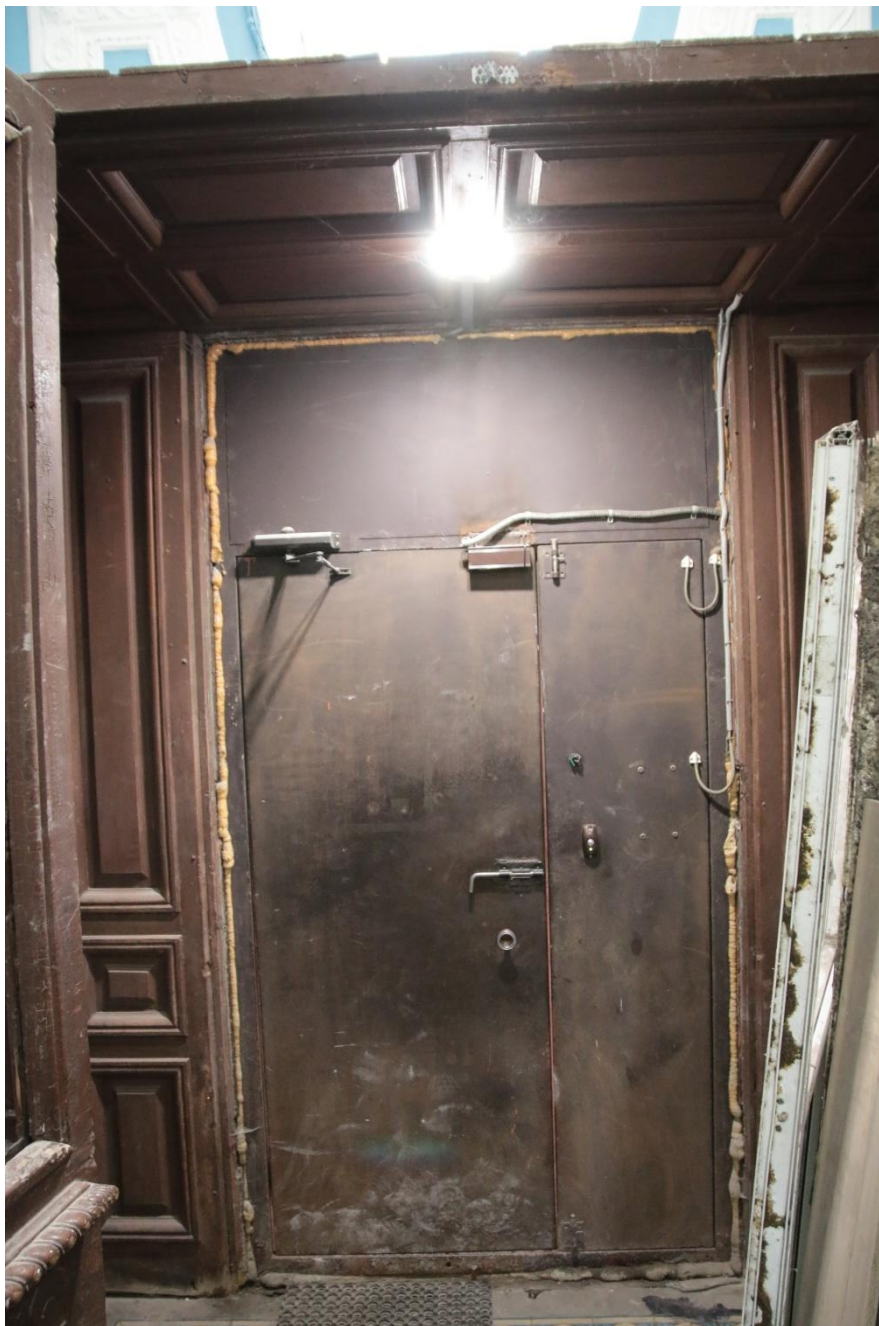
47. Интерьер вестибюля парадного входа. Дверь парадного входа
