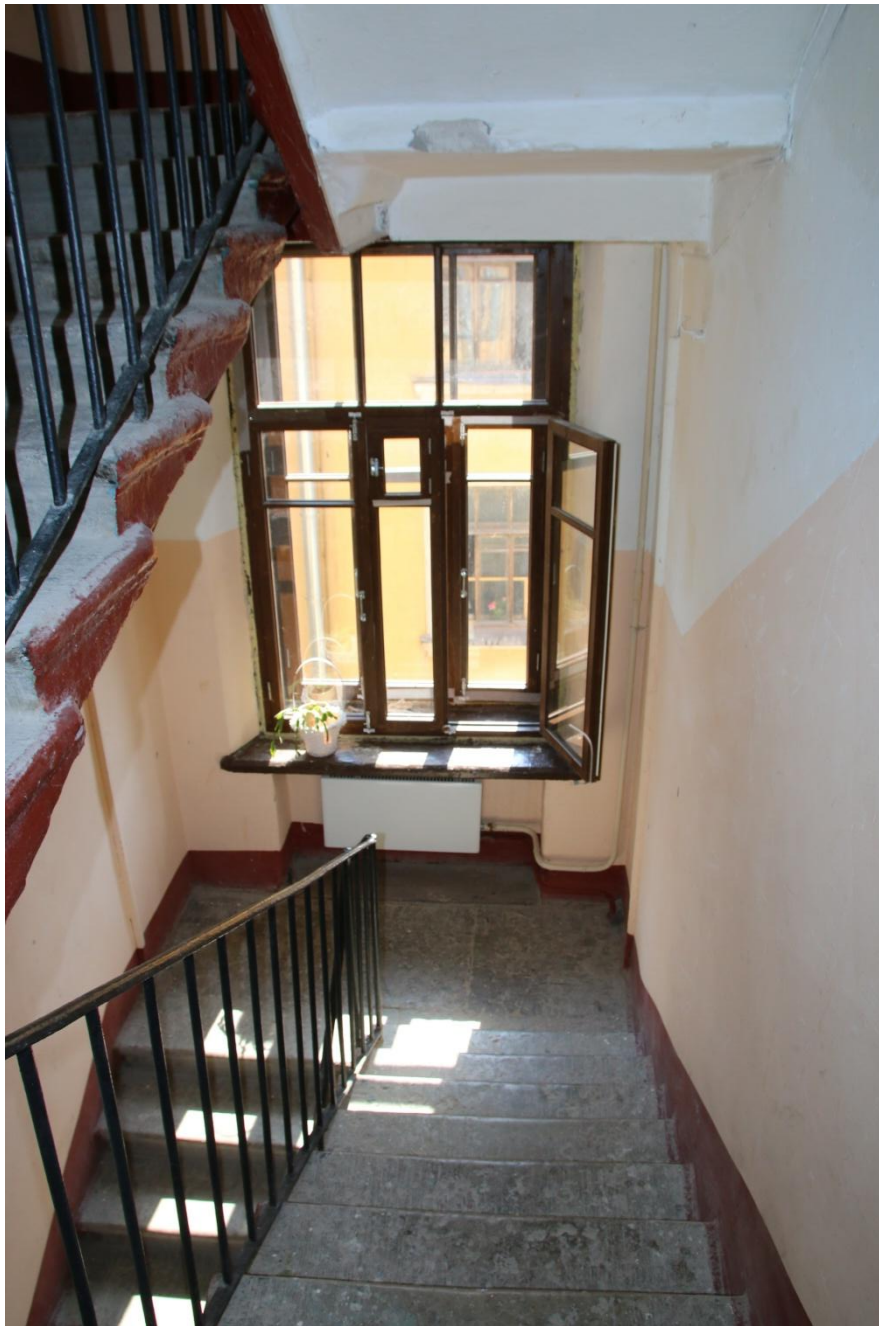
85. Интерьер дворовой парадной. Оконный проем лестничной площадки
