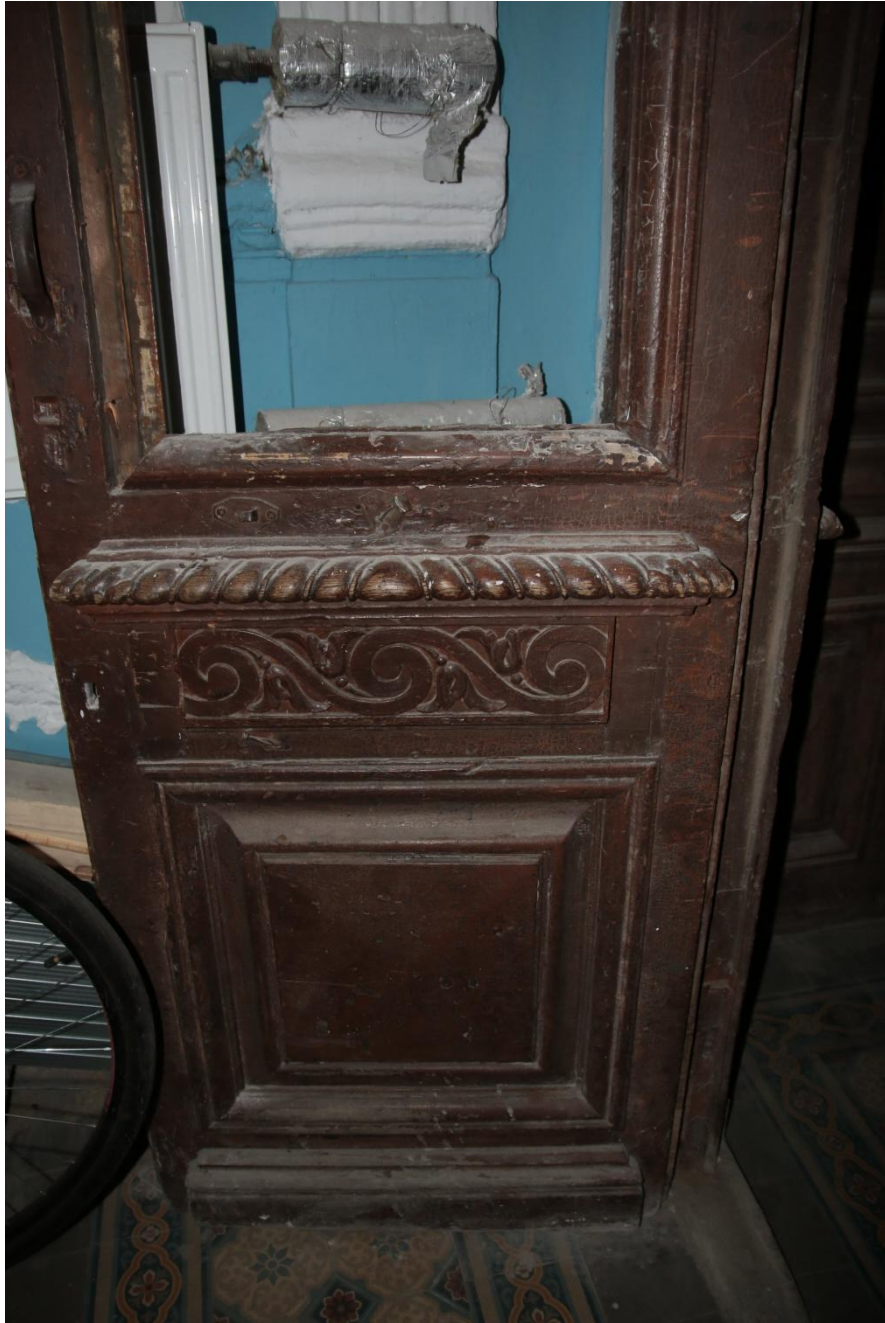
49. Интерьер вестибюля парадного входа. Тамбур парадного входа
