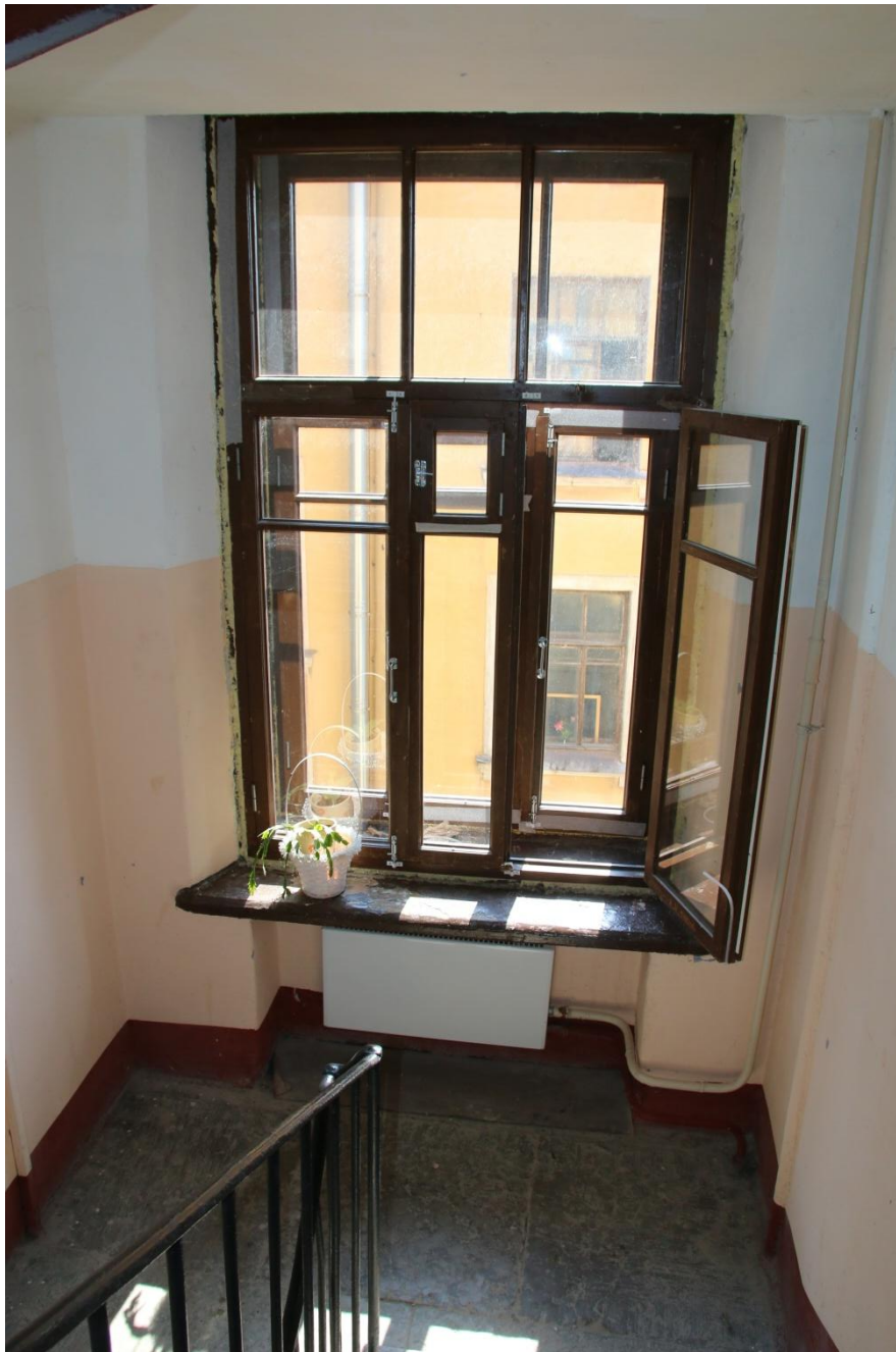
86. Интерьер дворовой парадной. Оконный проем лестничной площадки
