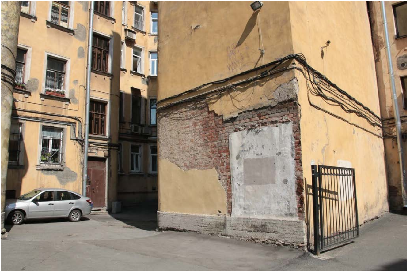
19. Фрагмент дворового фасада. Вид с юга
