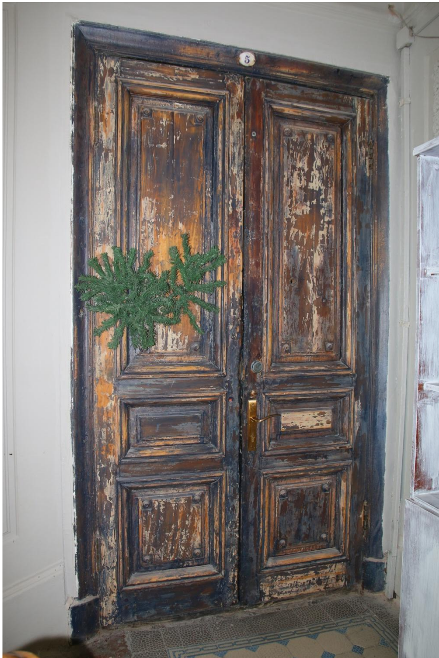
60. Интерьер парадного входа. Дверь жилого помещения
