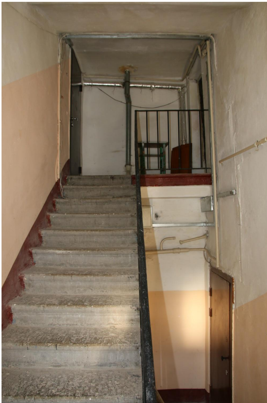
78. Интерьер дворовой парадной. Лестничная площадка шестого этажа
