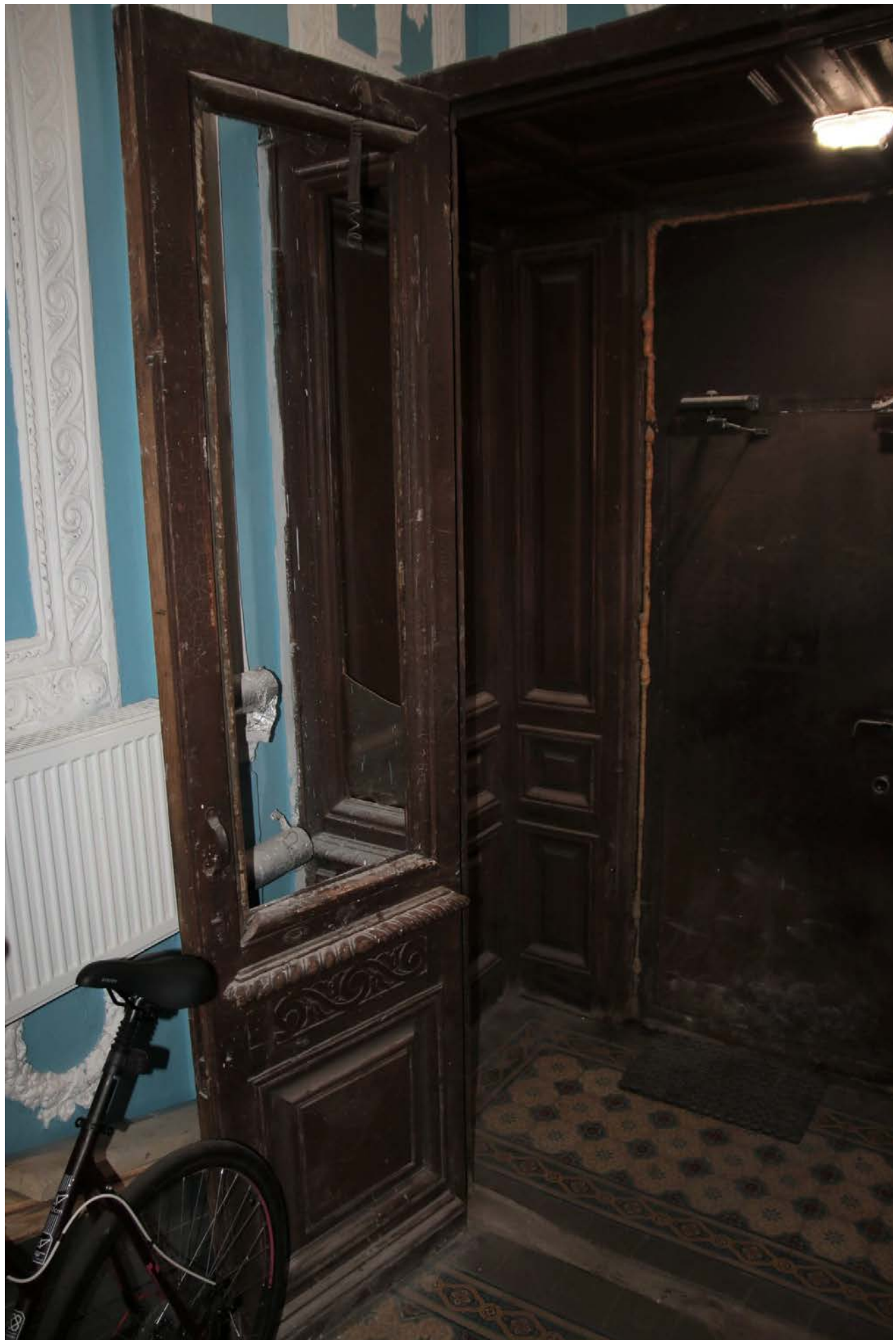
48. Интерьер вестибюля парадного входа. Тамбур парадного входа
