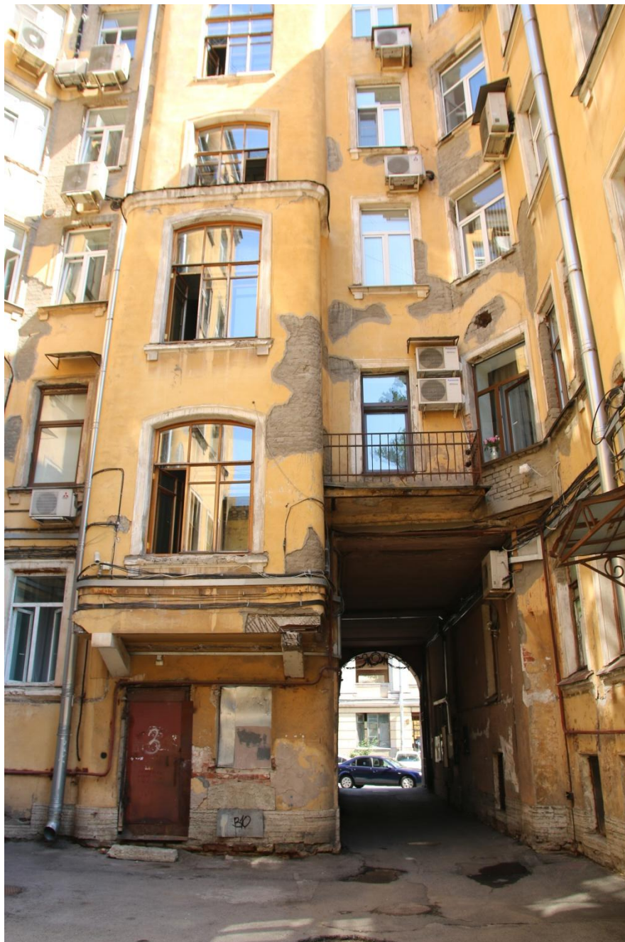
24. Фрагмент дворового фасада. Вид с юго-запада
