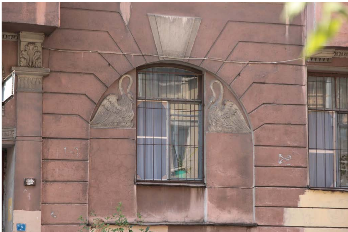
12. Фрагмент главного фасада. Вид с северо-востока
