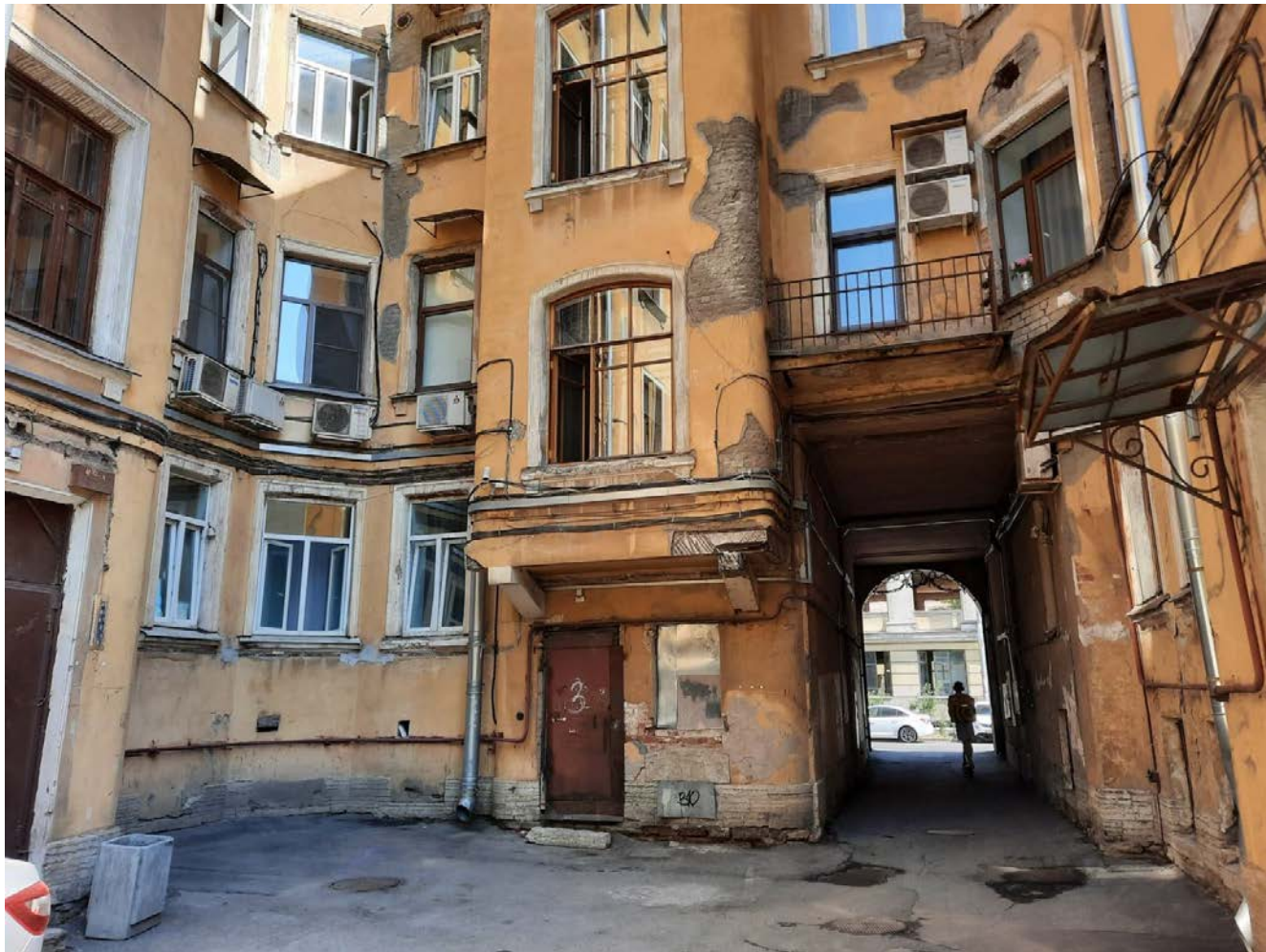
23. Фрагмент дворового фасада. Оформление оконных проемов. Вид с юго-запада
