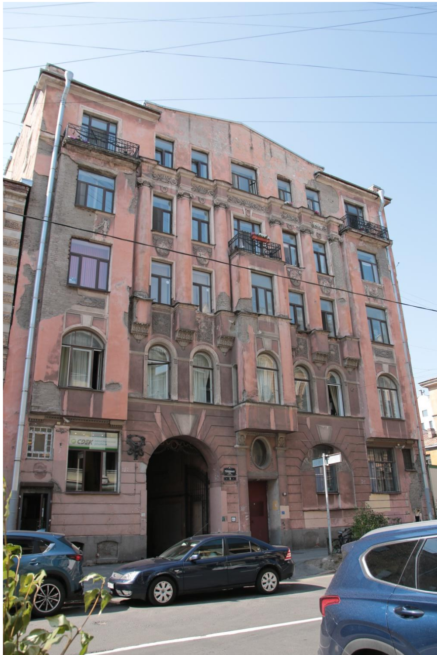
3. Общий вид главного фасада. Вид с северо-востока
