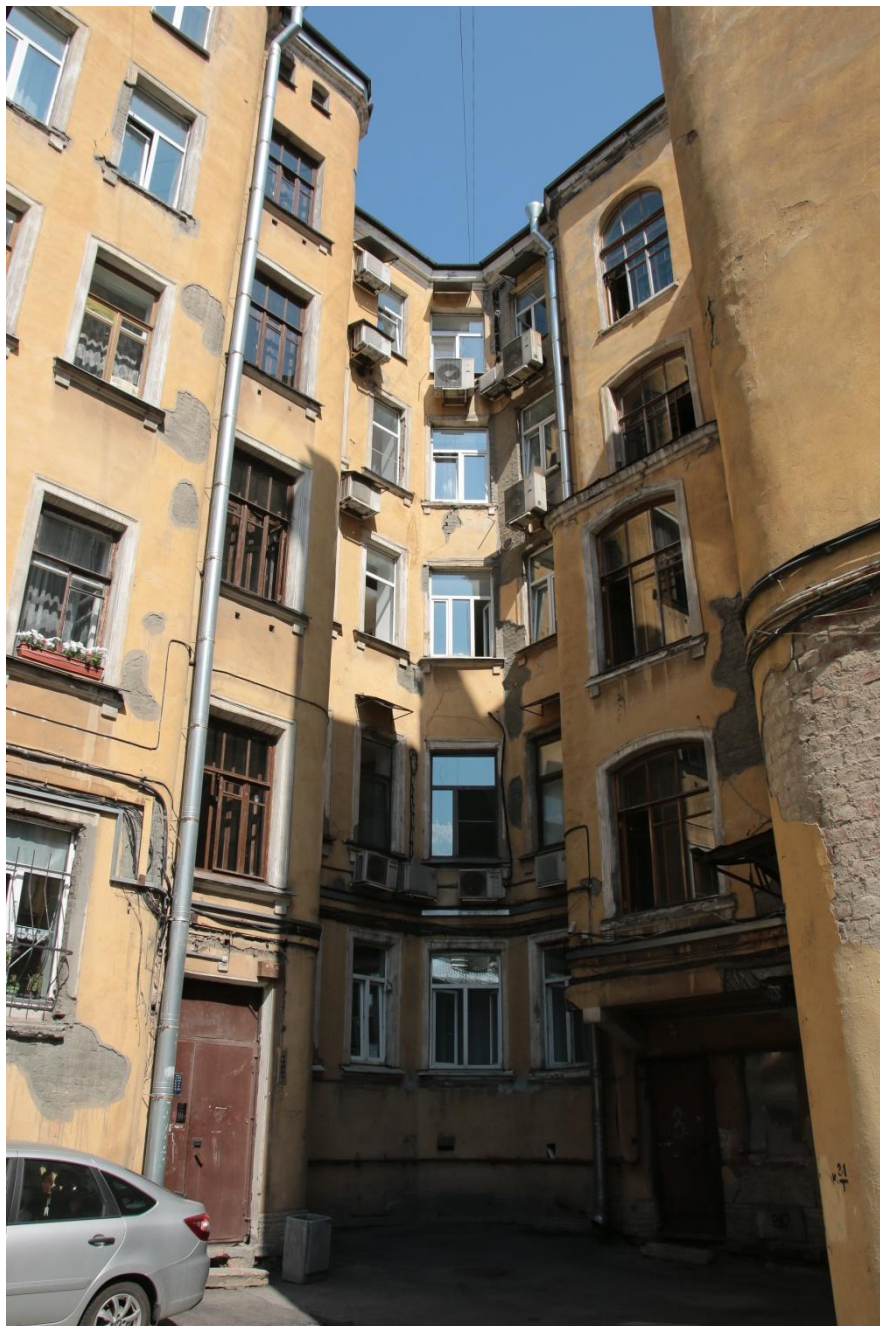
8. Фрагмент дворового фасада. Вид с юга
