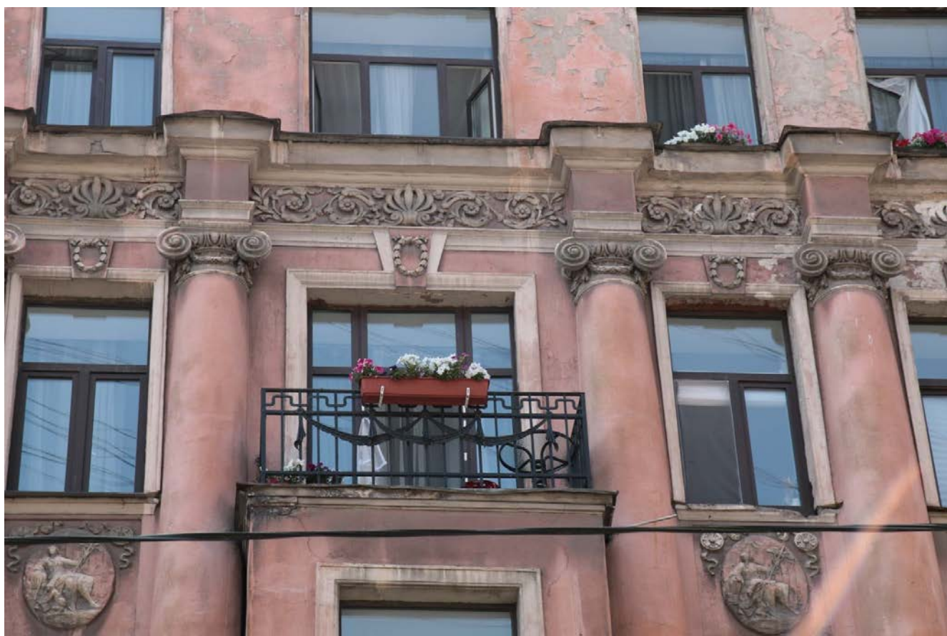
10. Фрагмент центральной части главного фасада. Вид с северо-востока
