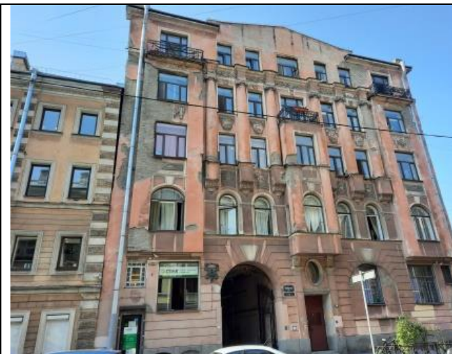
главный фасад с аттиком, эркерами и проездной аркой
