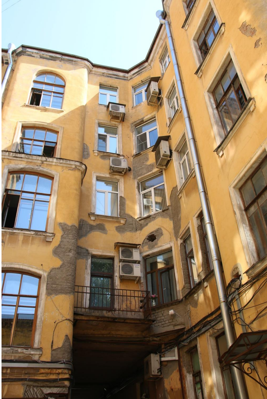
25. Фрагмент дворового фасада. Оформление оконных проемов. Вид с юго-запада
