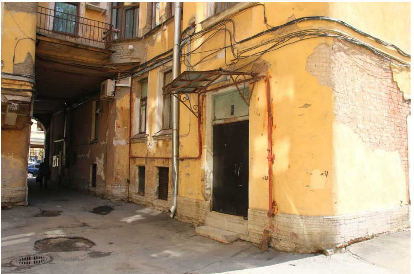
20. Фрагмент дворового фасада. Вид с запада
