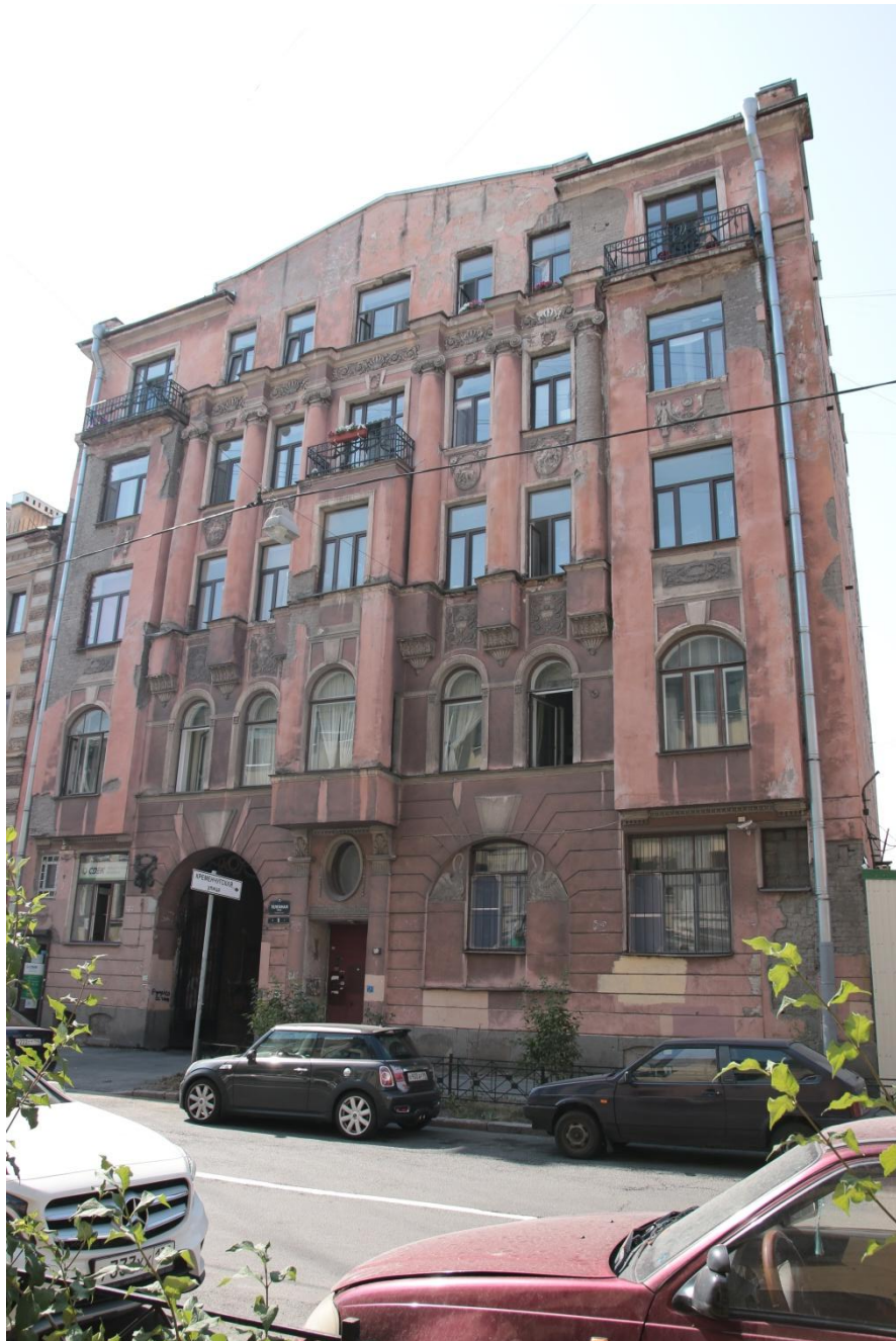
2. Общий вид главного фасада. Вид с севера
