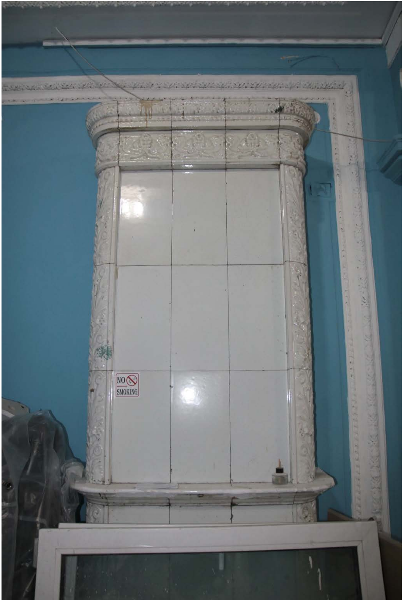
39. Интерьер вестибюля парадного входа. Белая изразцовая печь
