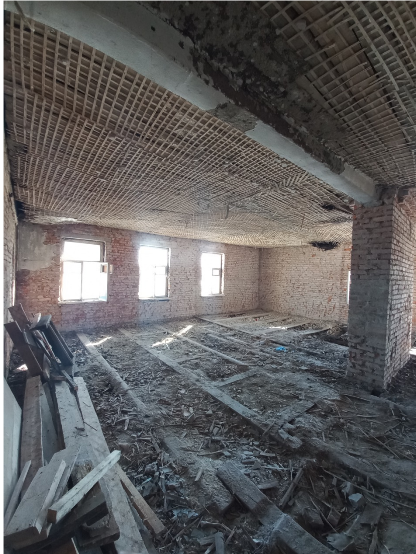
Фото 46. Помещения второго этажа.
