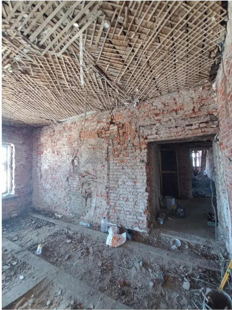
Фото 44. Помещения второго этажа.
