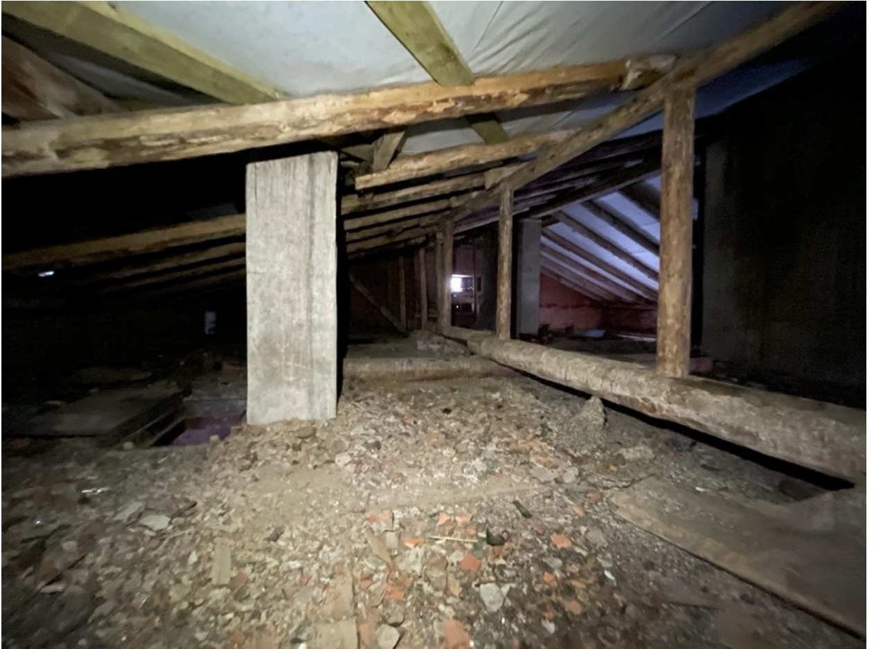
Фото 47. Помещения второго этажа.
