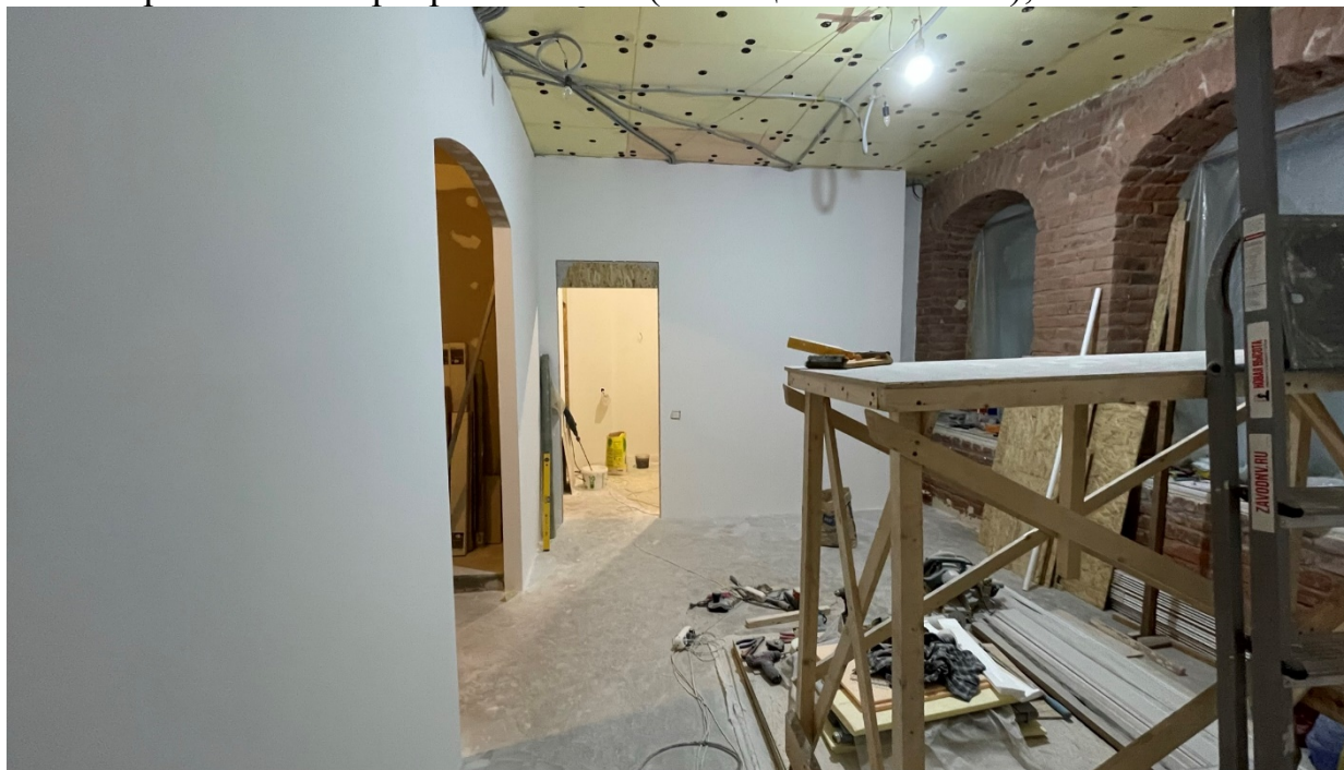
12.Фрагмент интерьера гостиной (помещение №3/20.9);
