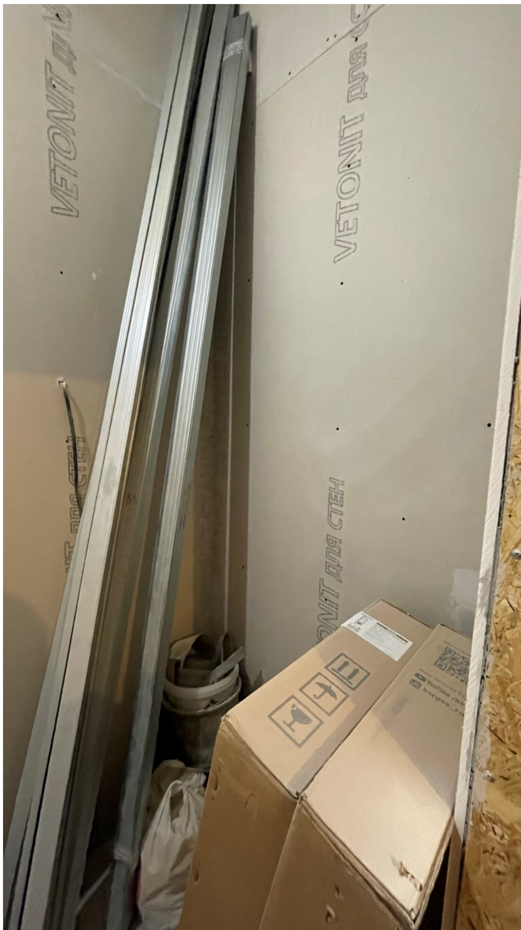
9. Фрагмент интерьера санузла (помещение №4/3.5);
