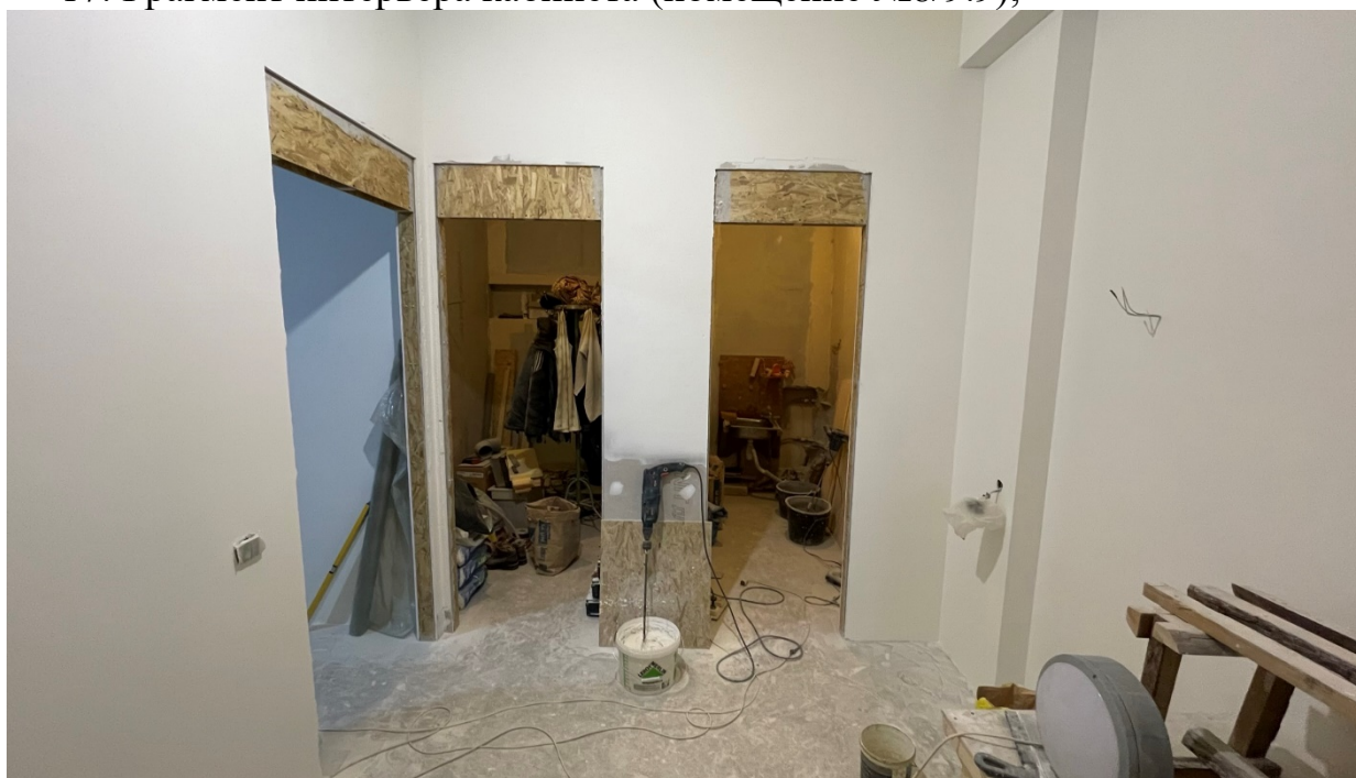
18.Фрагмент интерьера кабинета (помещение №8/9.9);
