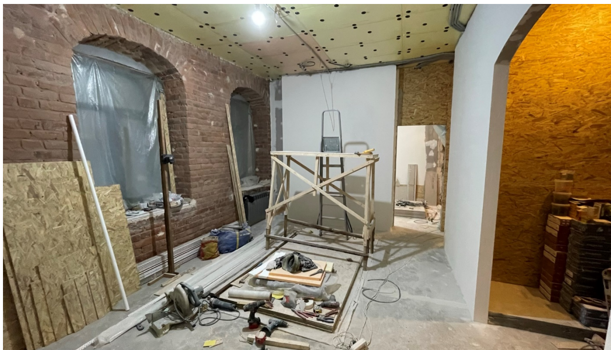
13.Фрагмент интерьера гостиной (помещение №3/20.9);
