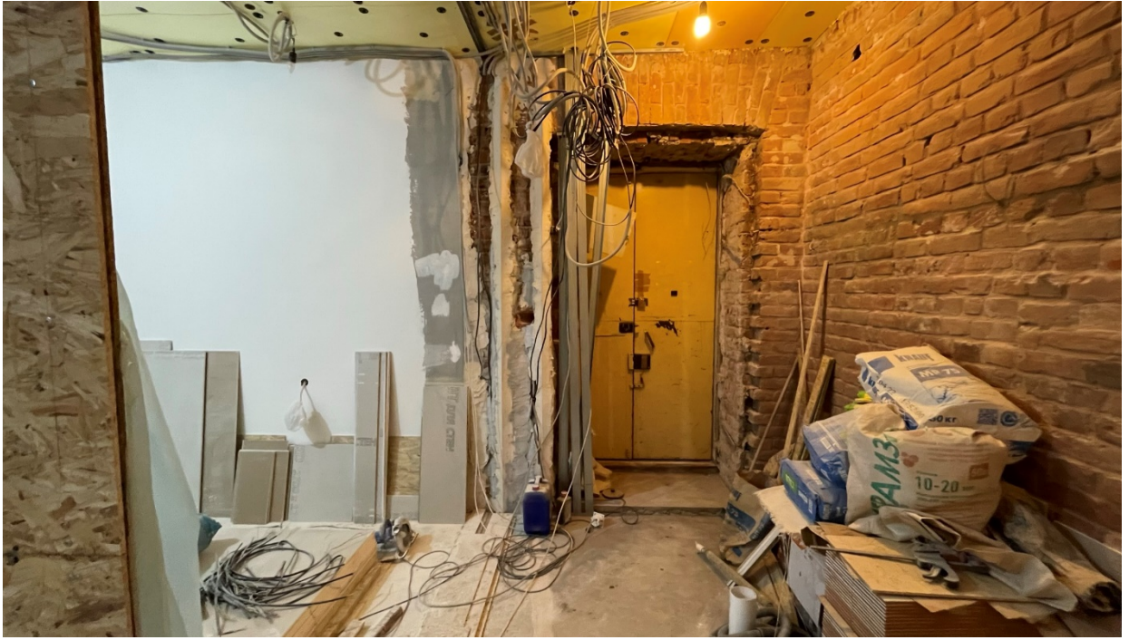
8. Фрагмент интерьера коридора (помещение №1/6.8);
