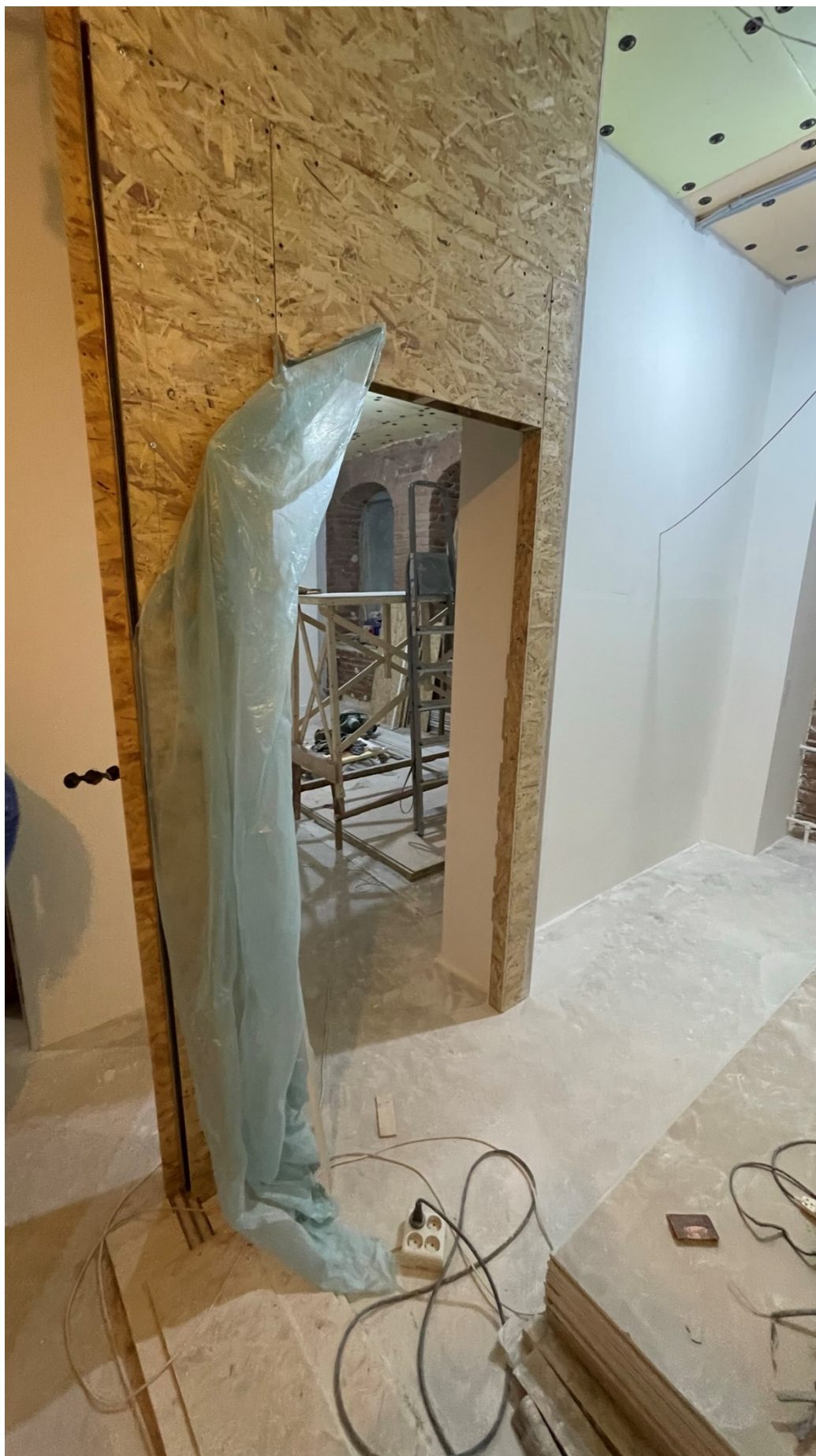
6. Фрагмент интерьера комнаты (помещение №2/11.0);
