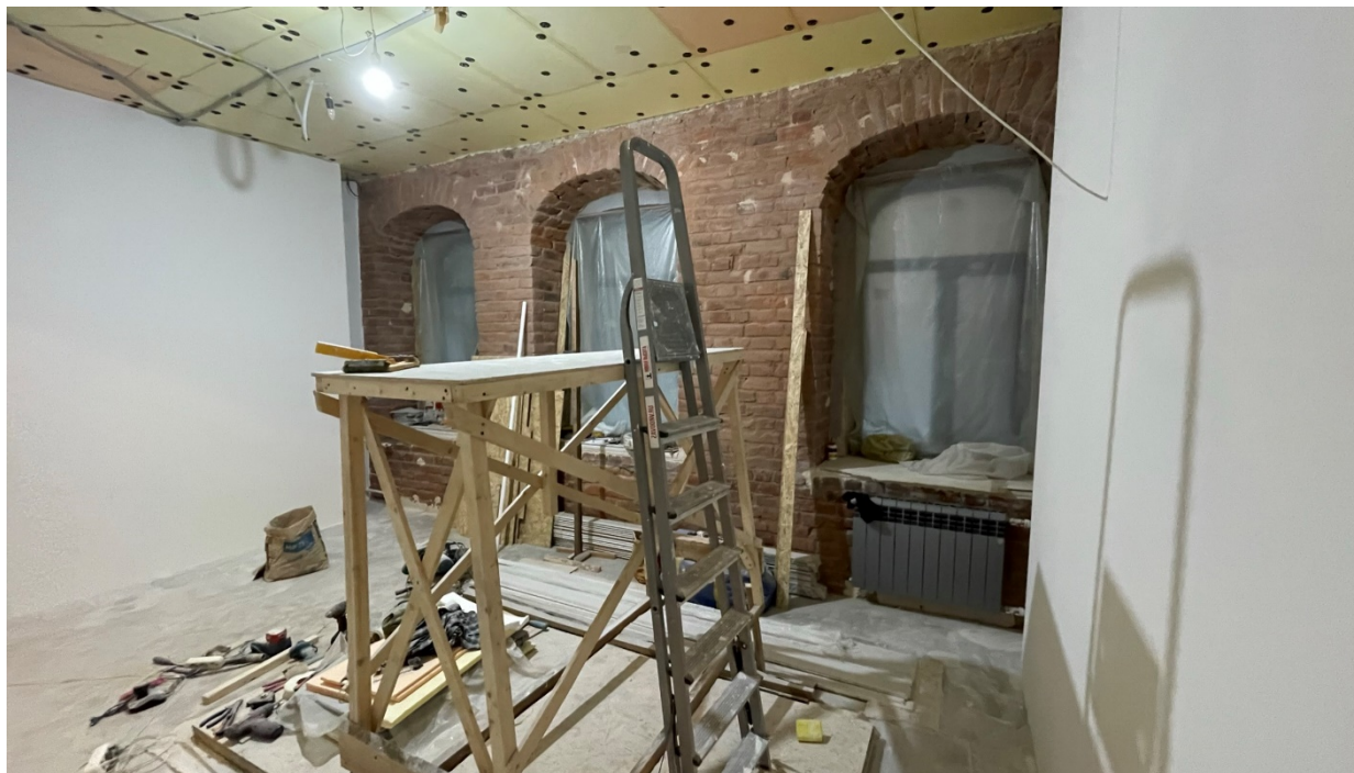
11.Фрагмент интерьера гостиной (помещение №3/20.9);
