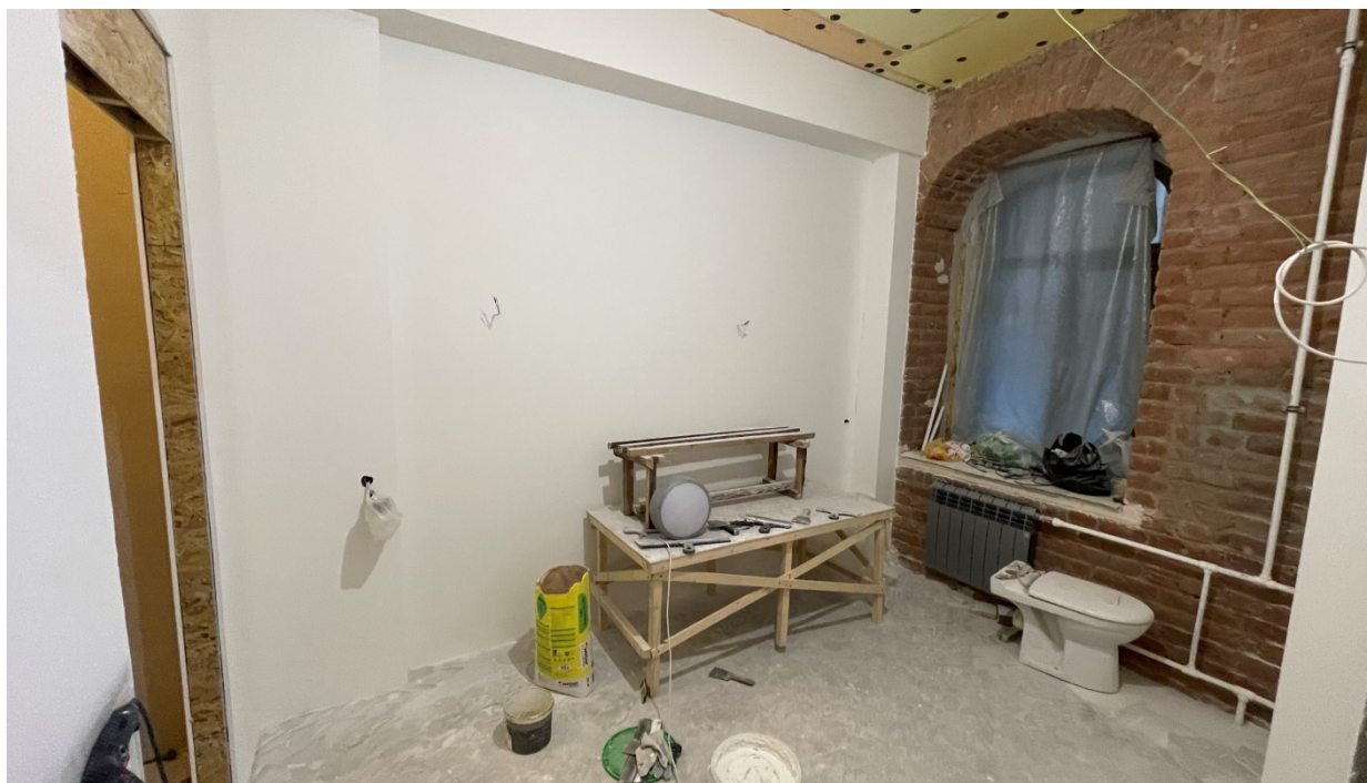
17.Фрагмент интерьера кабинета (помещение №8/9.9);
