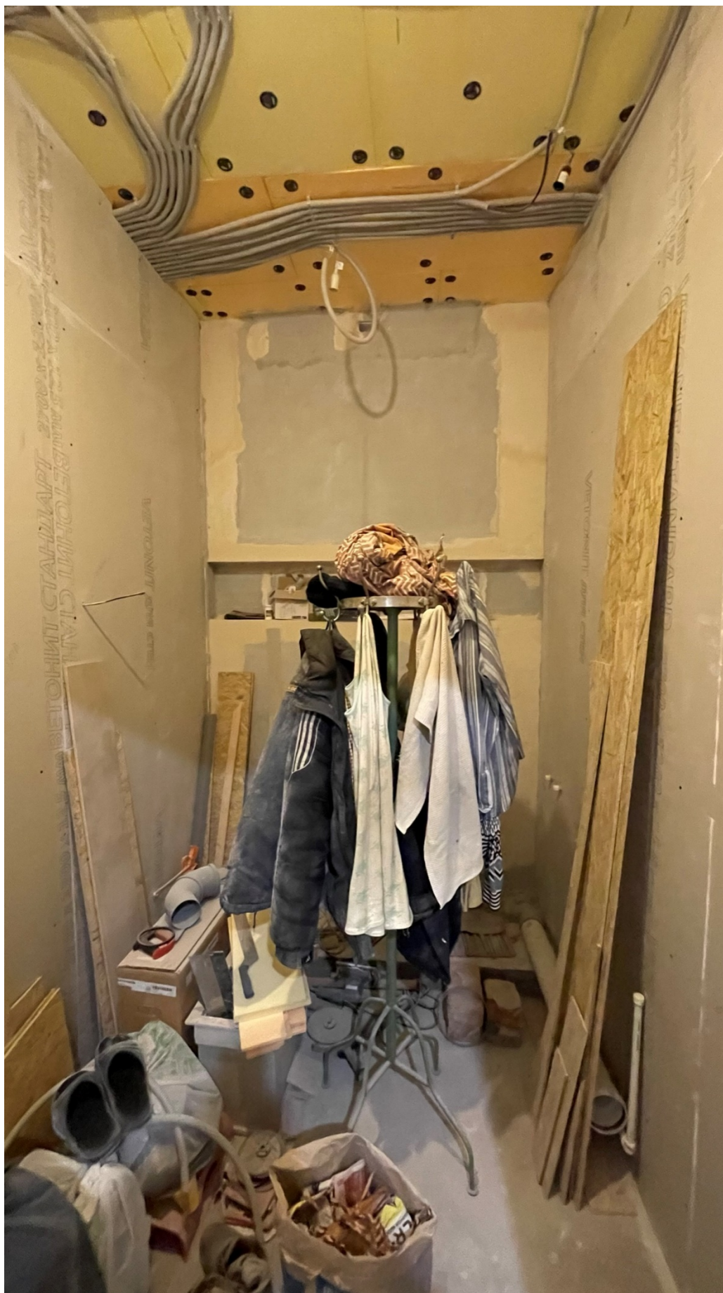
19.Фрагмент интерьера санузла (помещение №6/4.3);
