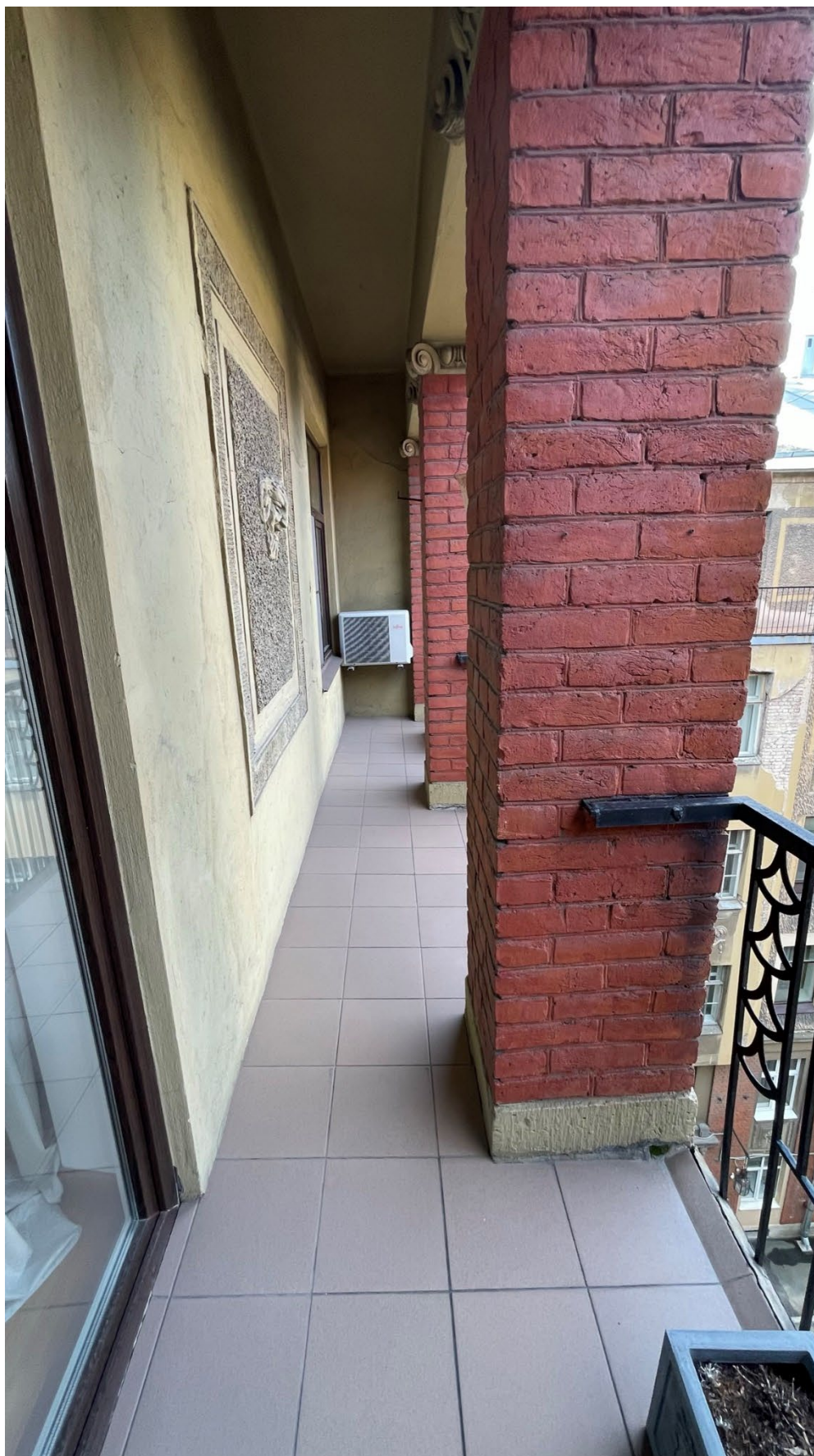
47. Общий вид на балкон;
