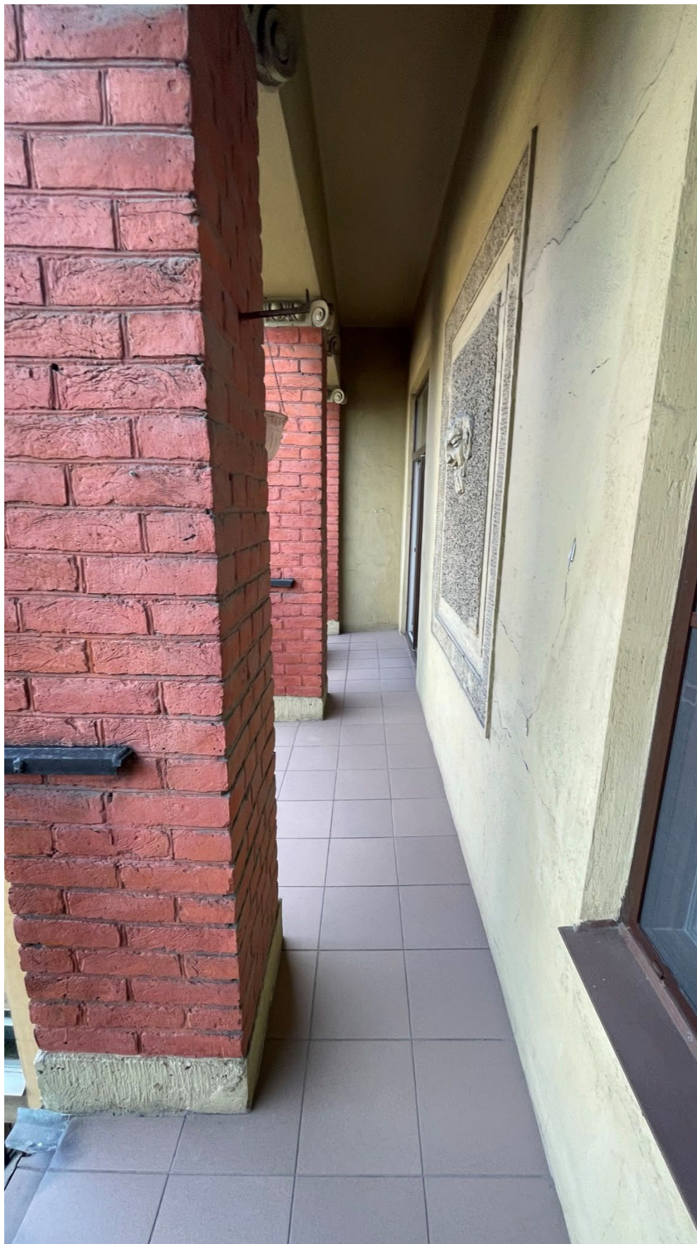
48. Общий вид на балкон;
