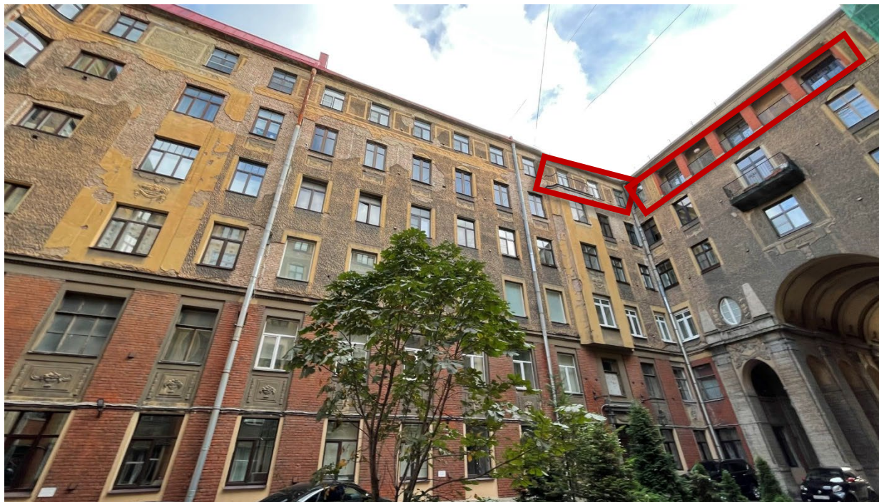
1. Вид на дворовой фасад и окна квартиры по адресу: г. Санкт-Петербург, ул. Рубинштейна, д. 15-17, лит. А.;
