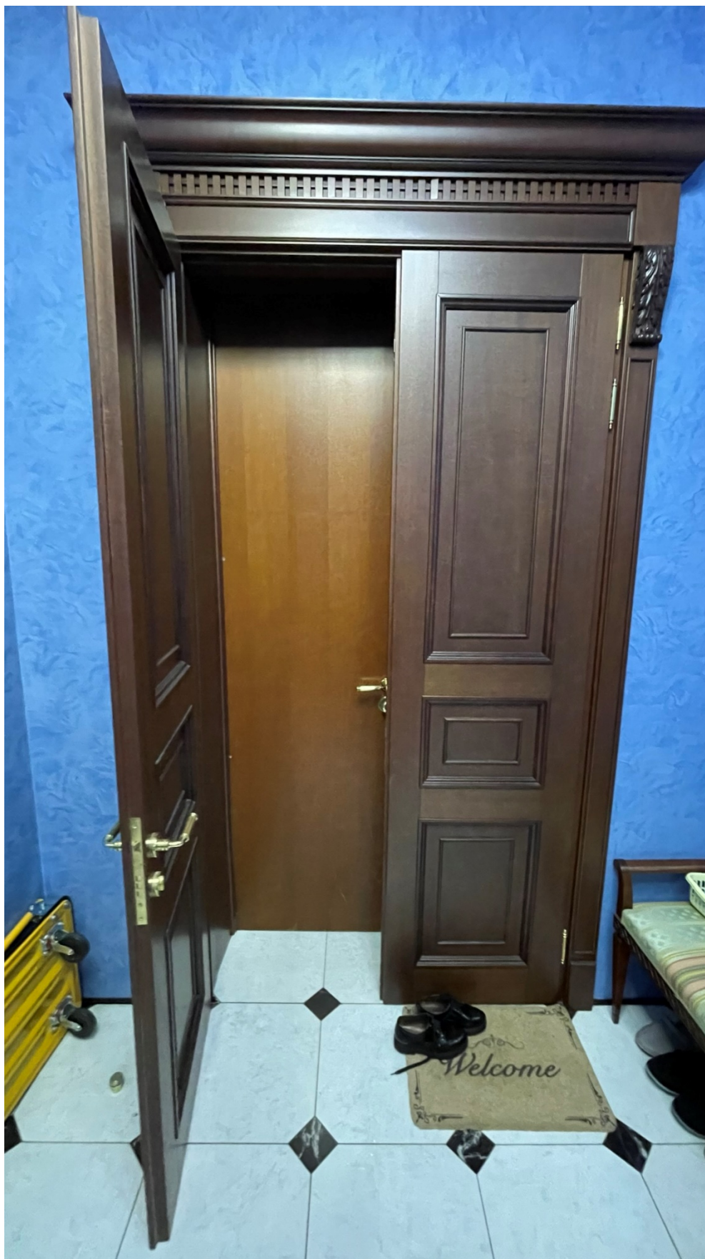
7. Вид на входную дверь в квартире №633;
