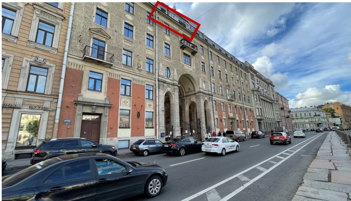
2. Вид на главный фасад с наб. р. Фонтанки и окна квартиры №633;
