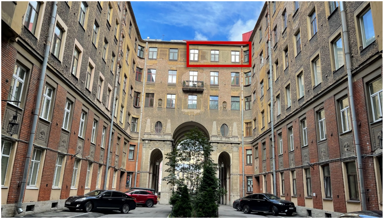
4. Вид на дворовой фасад и окна квартиры №633;
