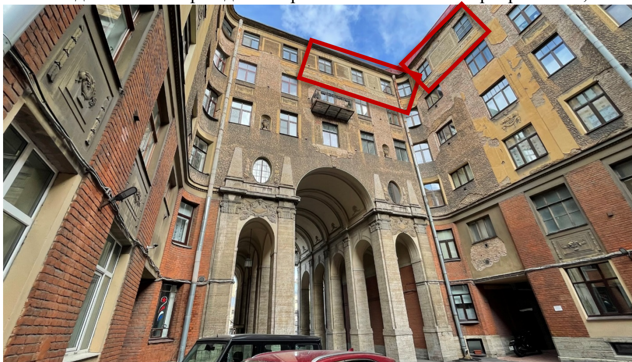
3. Вид на дворовой фасад и окна квартиры №633;
