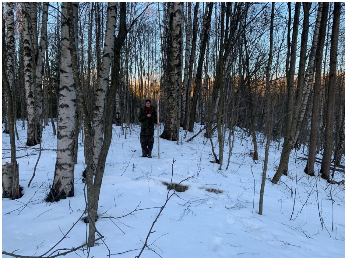
Рис. 20. Газопровод ГРС Восточная-2 - граница СПБ-2022. Точка фотофиксации 4, вид на восток.
