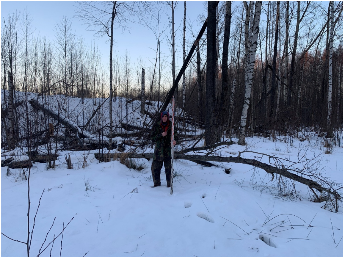
Рис. 14. Газопровод ГРС Восточная-2 - граница СПб-2022. Точка фотофиксации 1, вид на запад.
