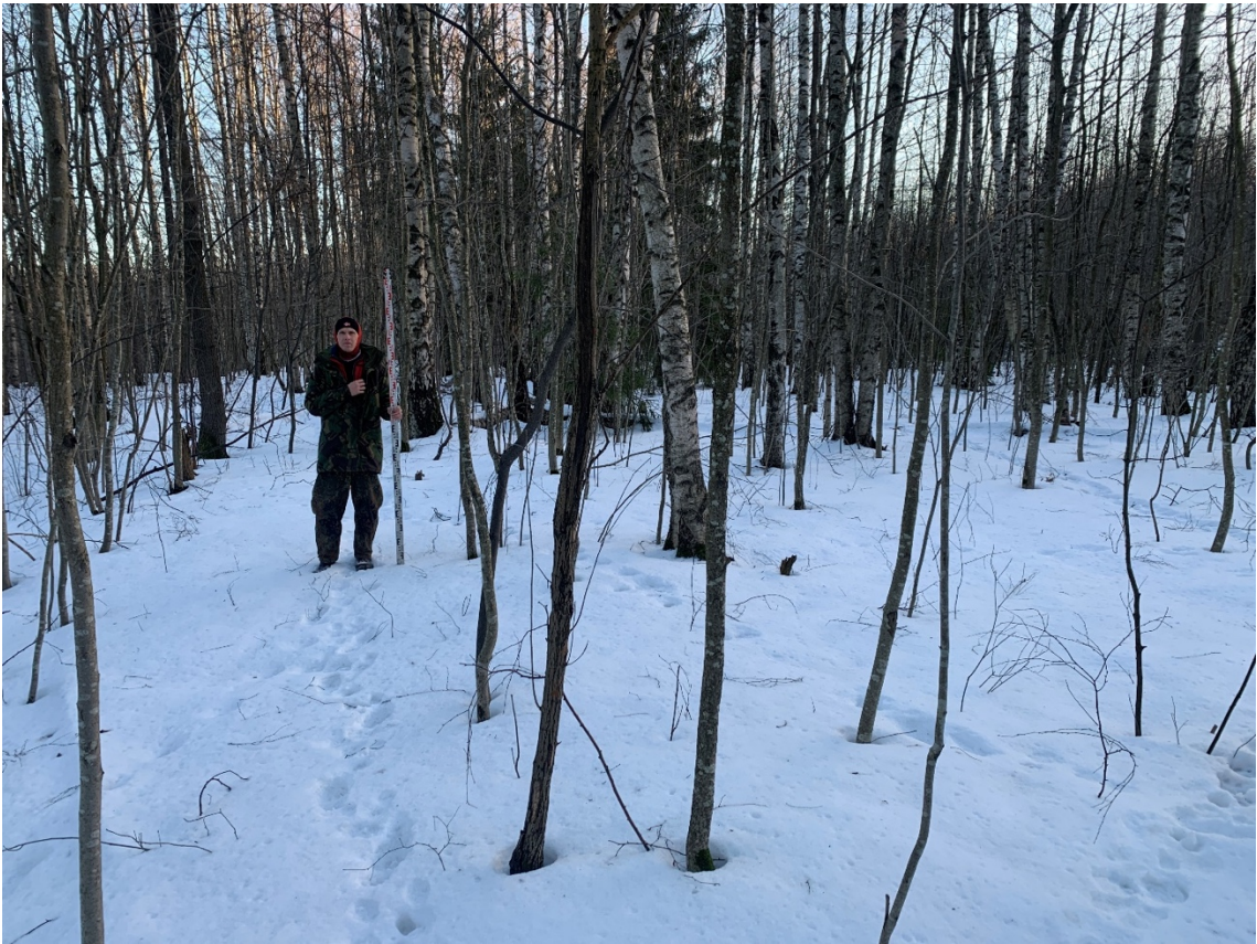
Рис. 21. Газопровод ГРС Восточная-2 - граница СПб-2022. Точка фотофиксации 4, вид на запад.
