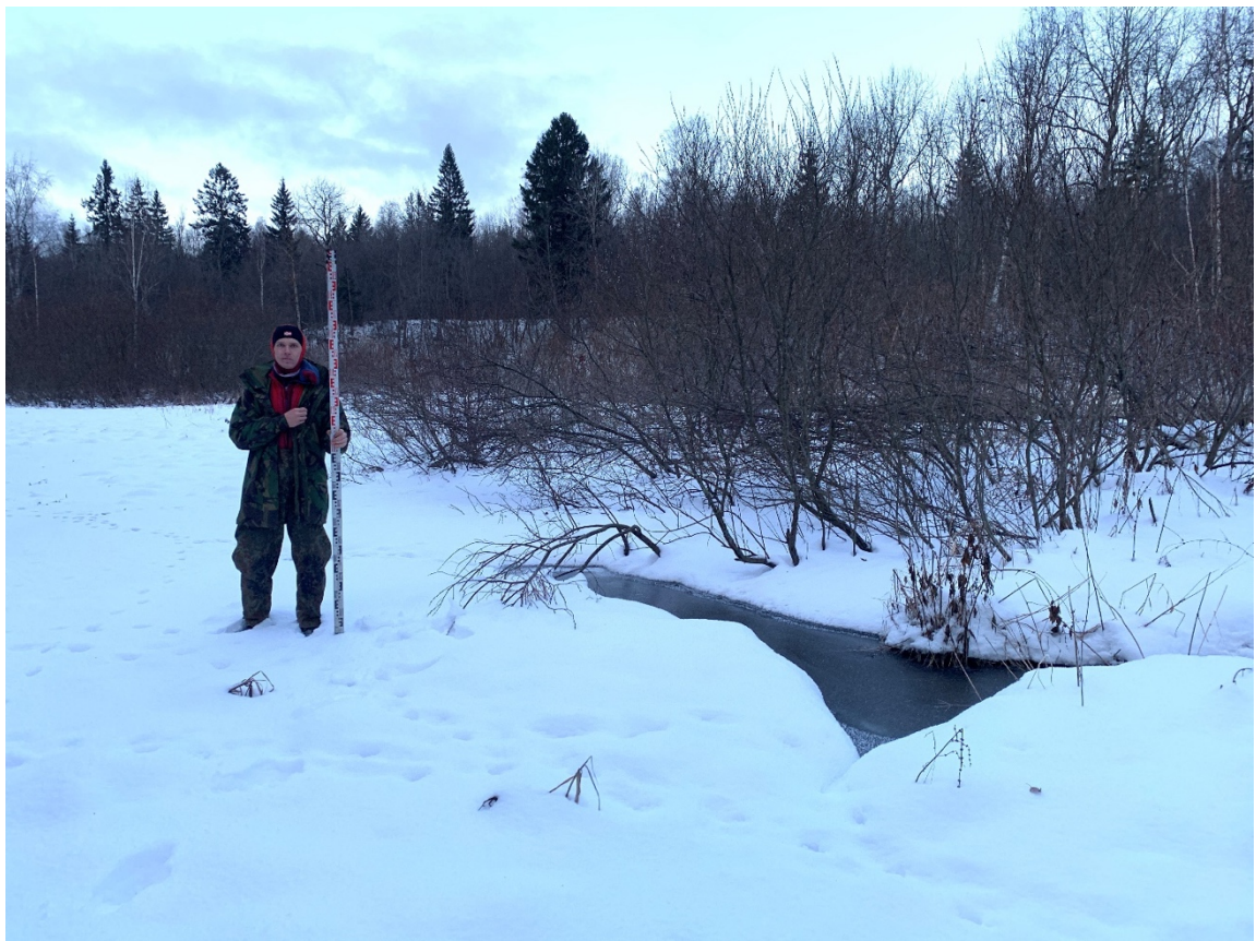
Рис. 24. Газопровод ГРС Восточная-2 - граница СПб-2022. Точка фотофиксации 6, вид на север.
