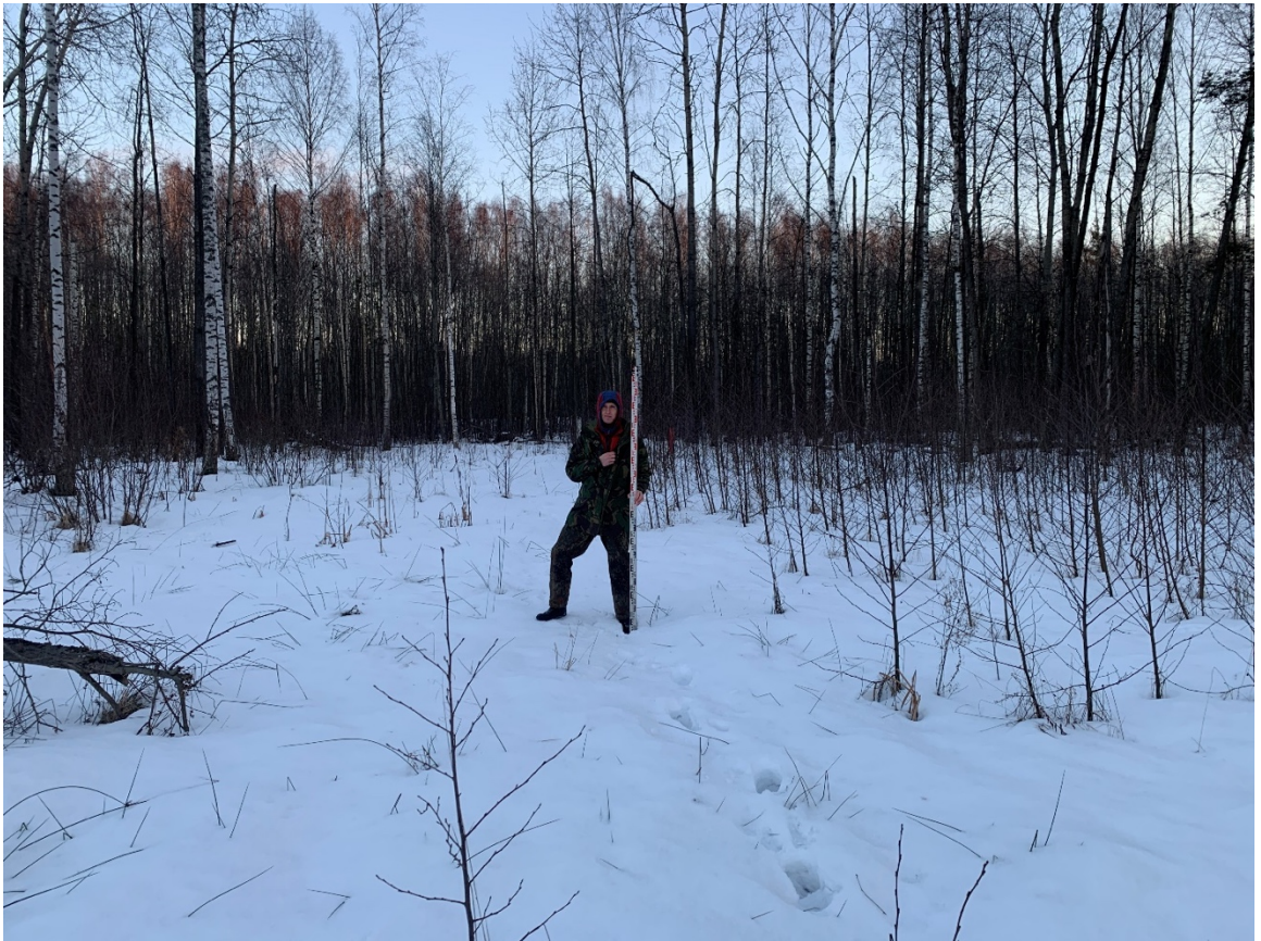
Рис. 13. Газопровод ГРС Восточная-2 - граница СПб-2022. Точка фотофиксации 1, вид на север.
