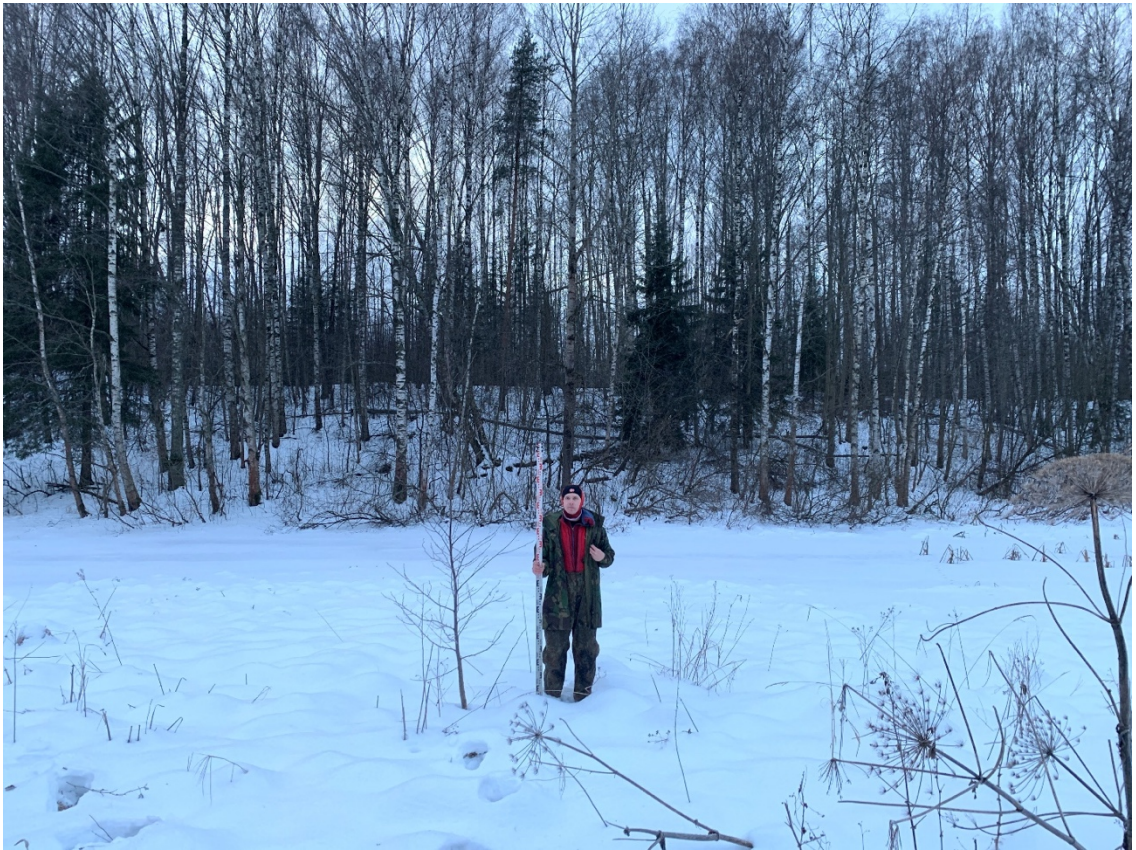
Рис. 27. Газопровод ГРС Восточная-2 - граница СПб-2022. Точка фотофиксации 7, вид на запад.
