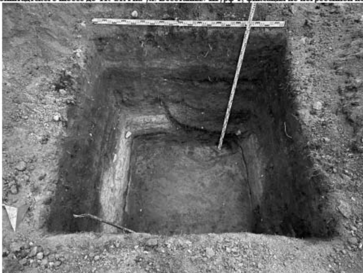
Рис. 25. СПб 2022. Кронштадтский район. «Реконструкция тепловых сетей г. Кронштадт, вдоль Кронштадтского шоссе до ТК-21А на ул. Восстания» Шурф 1 фиксация по матерiku
