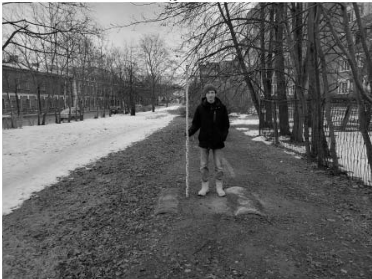
Рис. 10. СПб 2022. Кронштадтский район. «Реконструкция тепловых сетей г. Кронштадт, вдоль Кронштадтского шоссе до ТК-21А на ул. Восстания» Точка фотофиксации 3, вид на юго-восток
