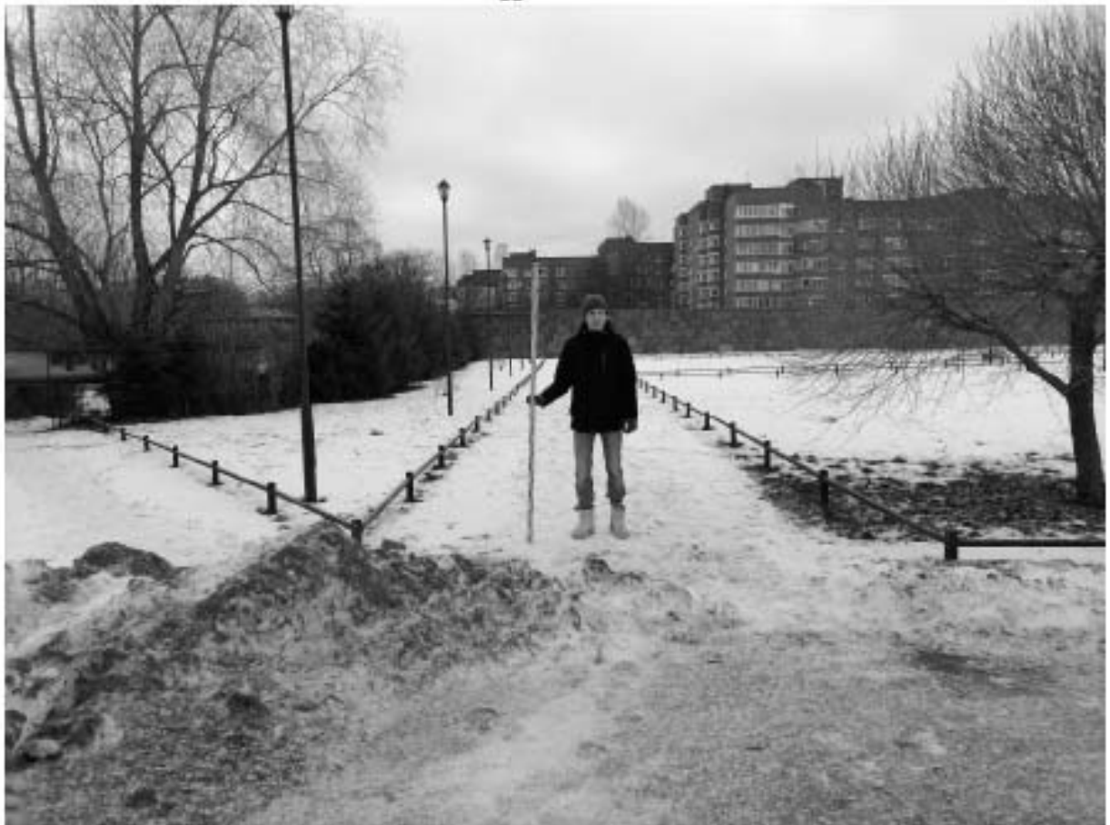
Рис. 12. СПб 2022. Кронштадтский район. «Реконструкция тепловых сетей г. Кронштадт, вдоль Кронштадтского шоссе до ТК-21А на ул. Восстания» Точка фотофиксации 5, вид на юго-восток
