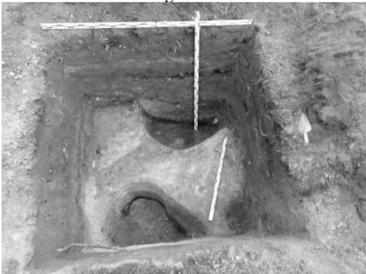
Рис. 23. СПб 2022. Кронштадтский район. «Реконструкция тепловых сетей г. Кронштадт, вдоль Кронштадтского шоссе до ТК-21А на ул. Восстания» Шурф 1, фиксация после выборки ям
