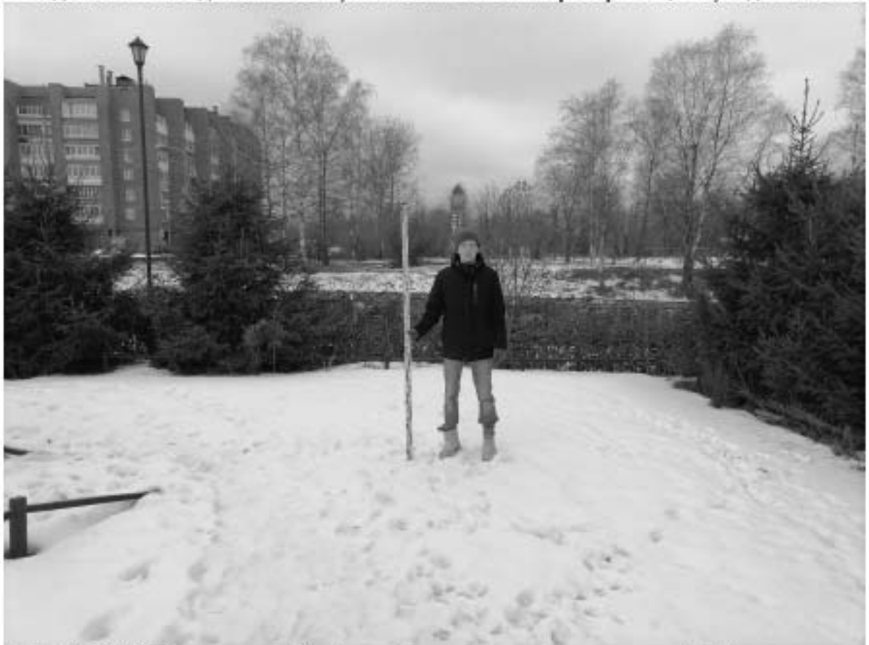
Рис. 13. СПб 2022. Кронштадтский район. «Реконструкция тепловых сетей г. Кронштадт, вдоль Кронштадтского шоссе до ТК-21А на ул. Восстания» Точка фотофиксации 6, вид на запад
