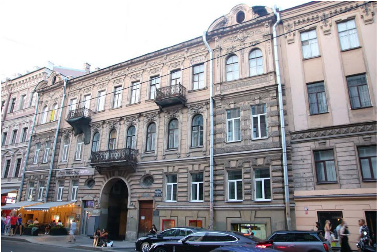
1. Общий вид главного фасада по улице Рубинштейна. Вид с юго-запада
