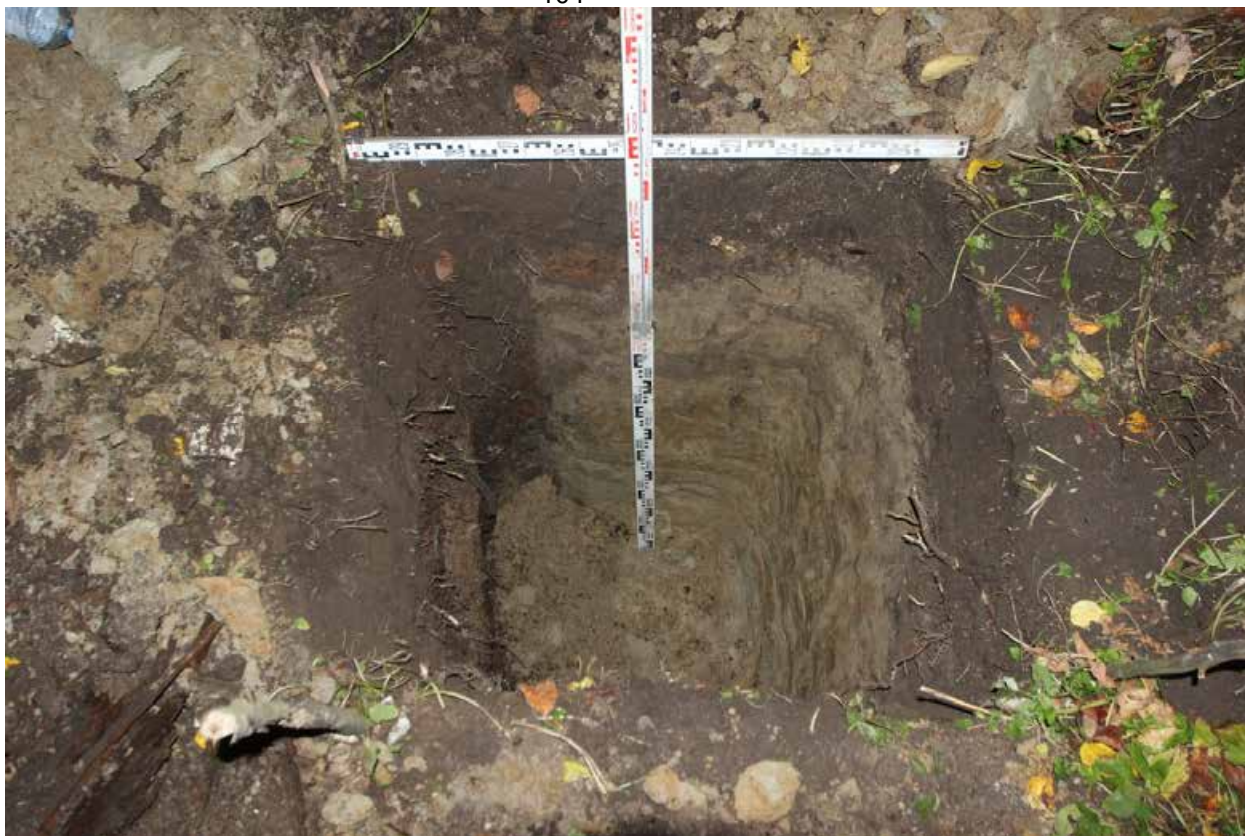
Рис. 54. Усть-Славянка-2022. КН_78120000007579. Шурф 3, фиксация по уровню окончания работ, вид на восток.
