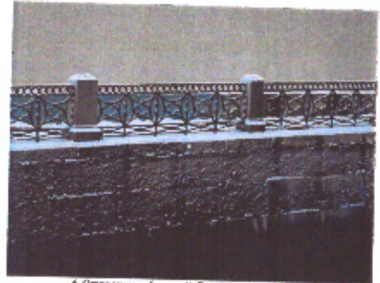
6. Вид на левый берег. Ленточная стена
