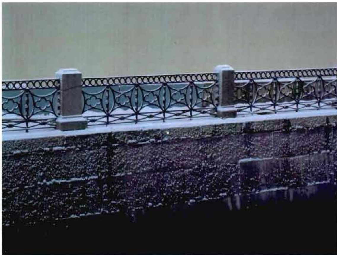
6. Ограждение набережной. Левобережная стенка
