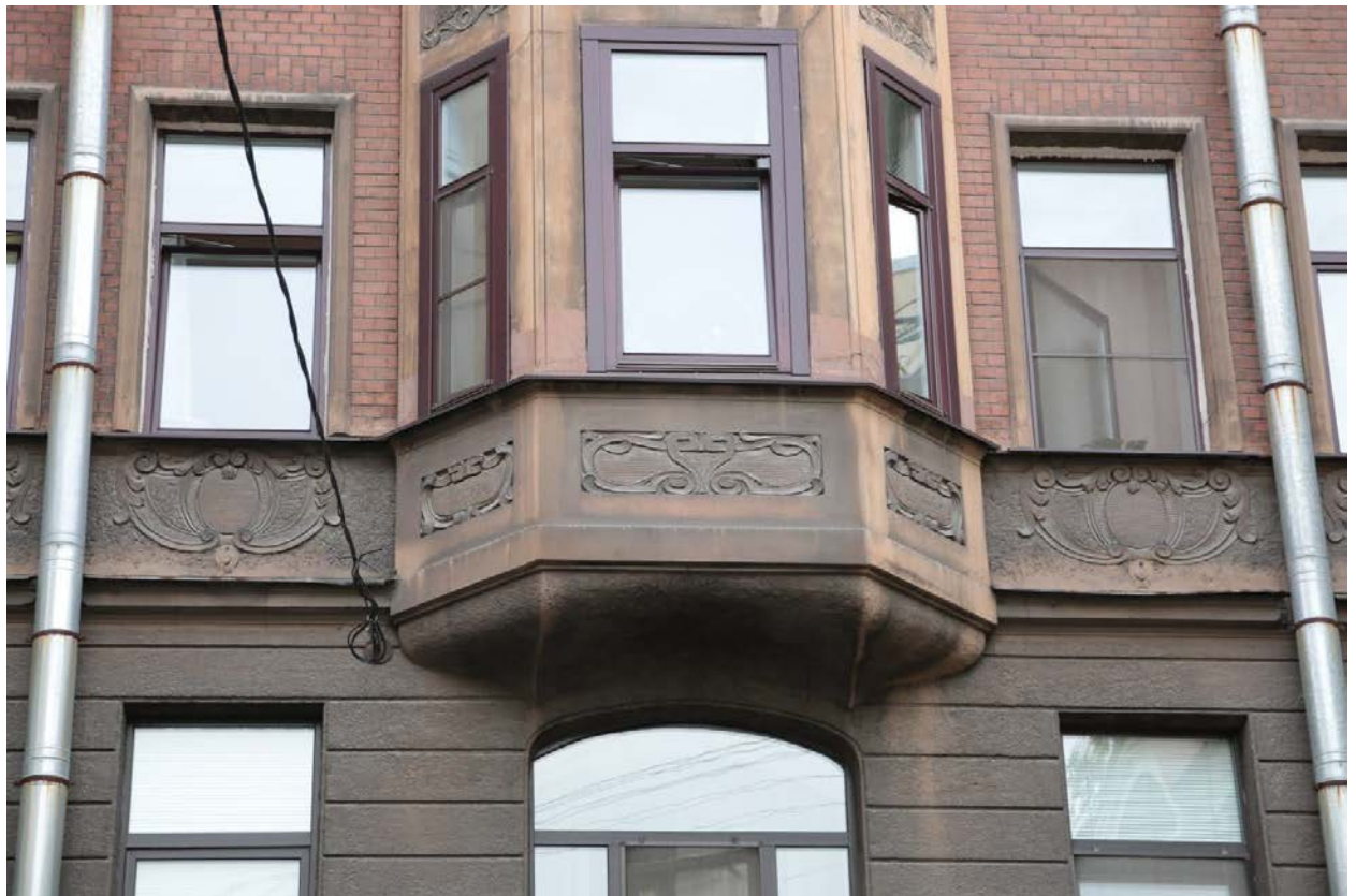
19. Фрагмент оформления центральной части фасада по Гродненскому переулку. Вид с востока
