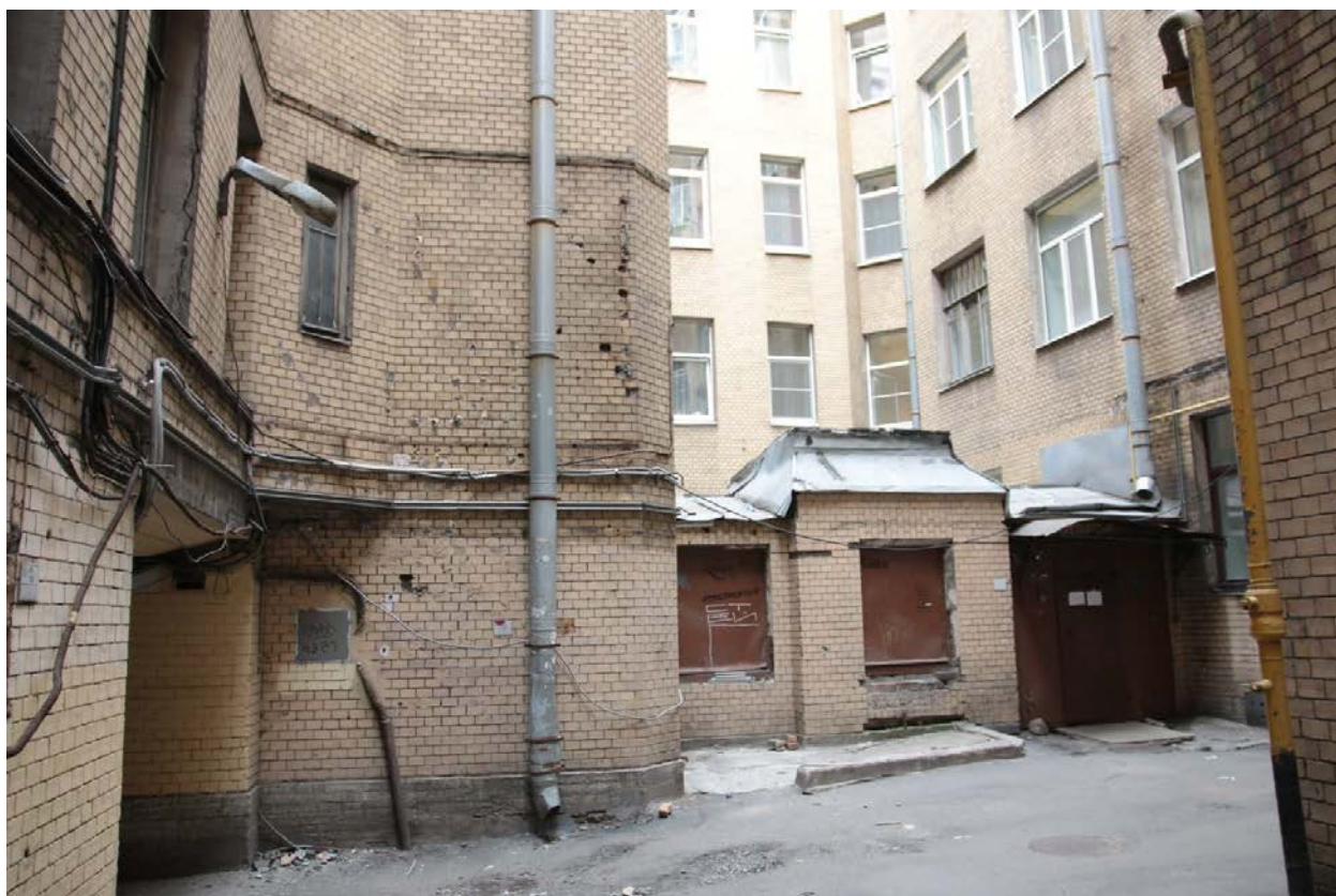
9. Фрагмент фасадов внутреннего двора. Вид с запада
