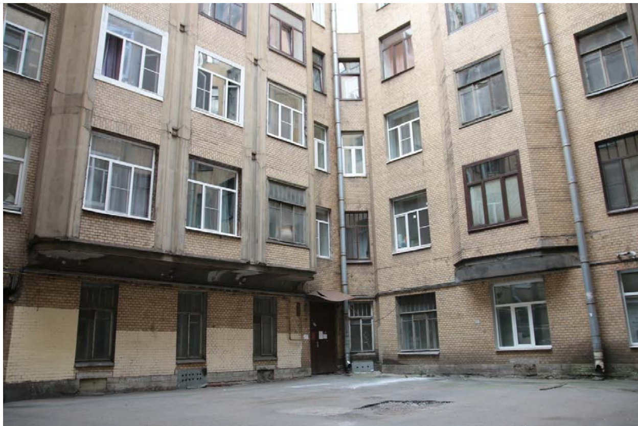
12. Фрагмент фасадов внутреннего двора. Вид с северо-запада
