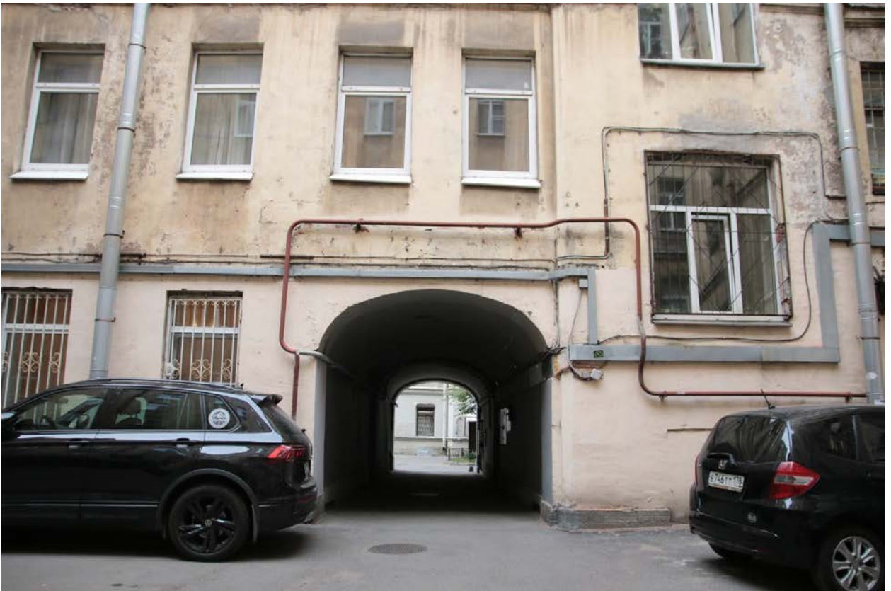
11. Проездная арка со стороны внутреннего двора
