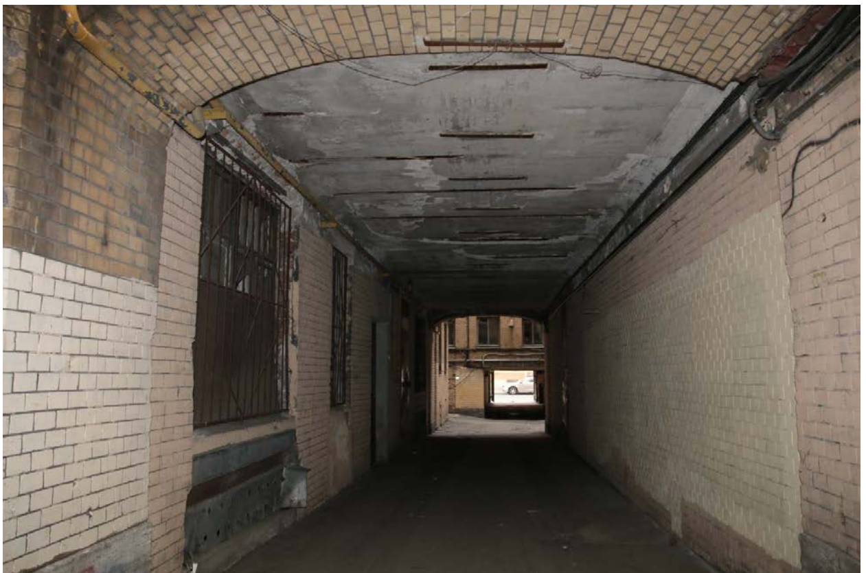
7. Оформление свода проездной арки во внутренний двор. Вид с юга
