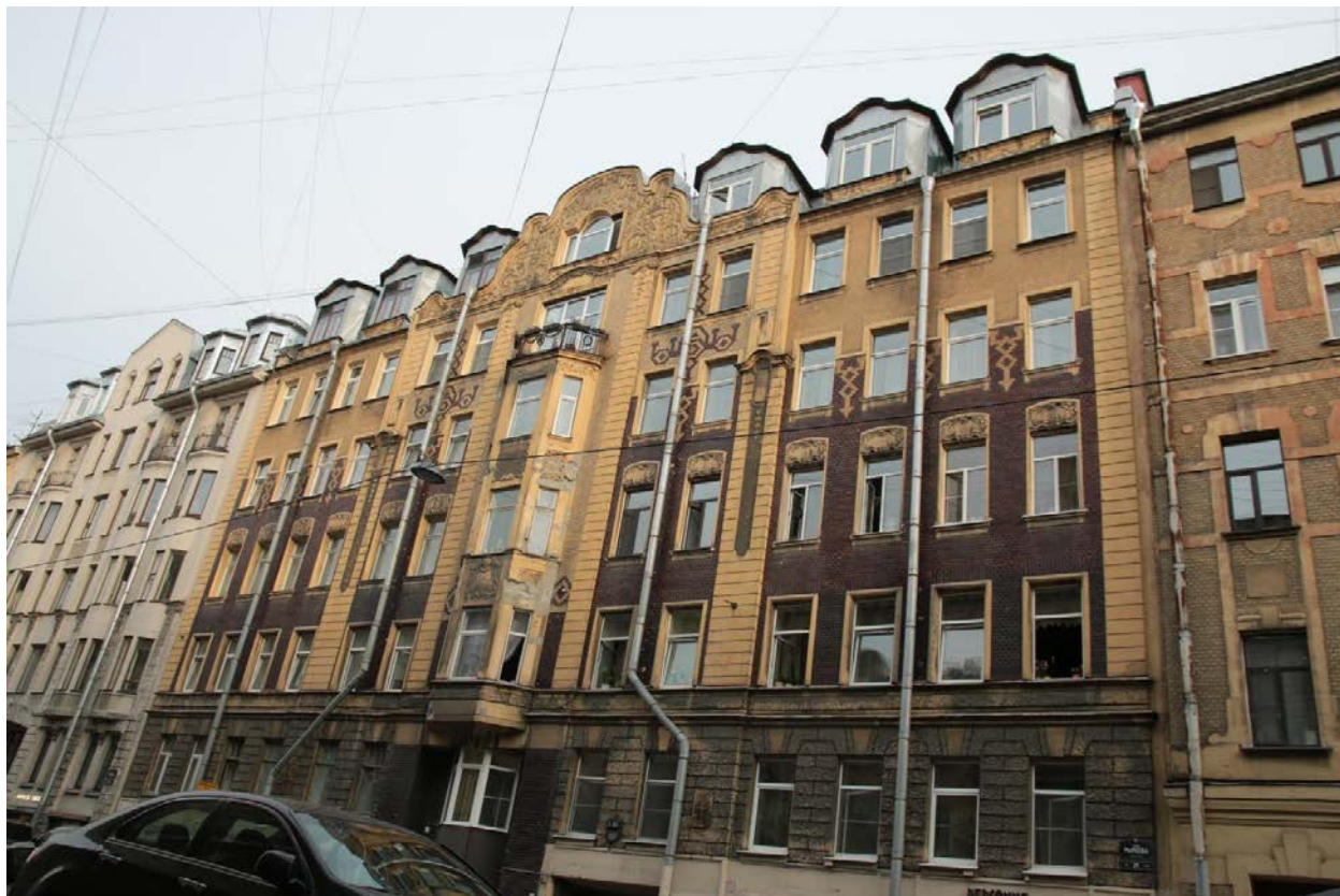
2. Общий вид фасада по улице Рылеева. Вид с северо-запада
