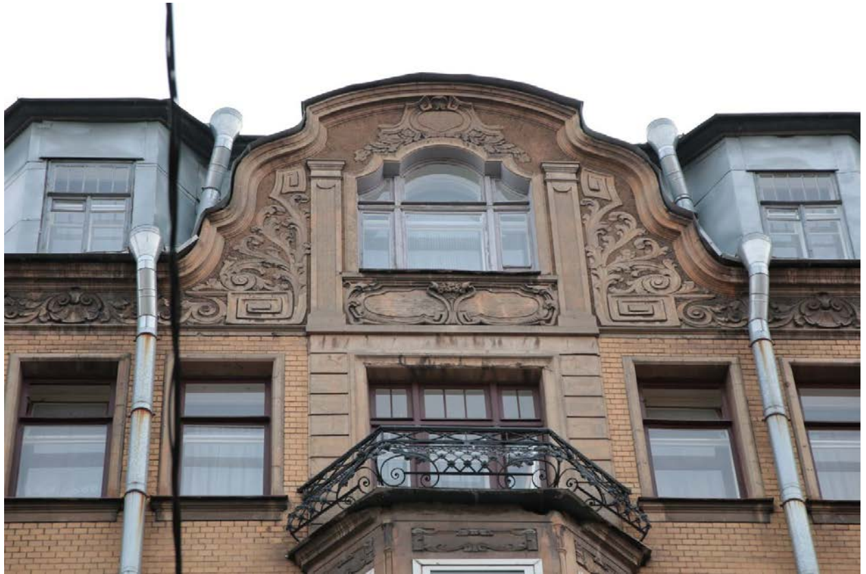
18. Фрагмент оформления центральной части фасада по Гродненскому переулку. Вид с востока
