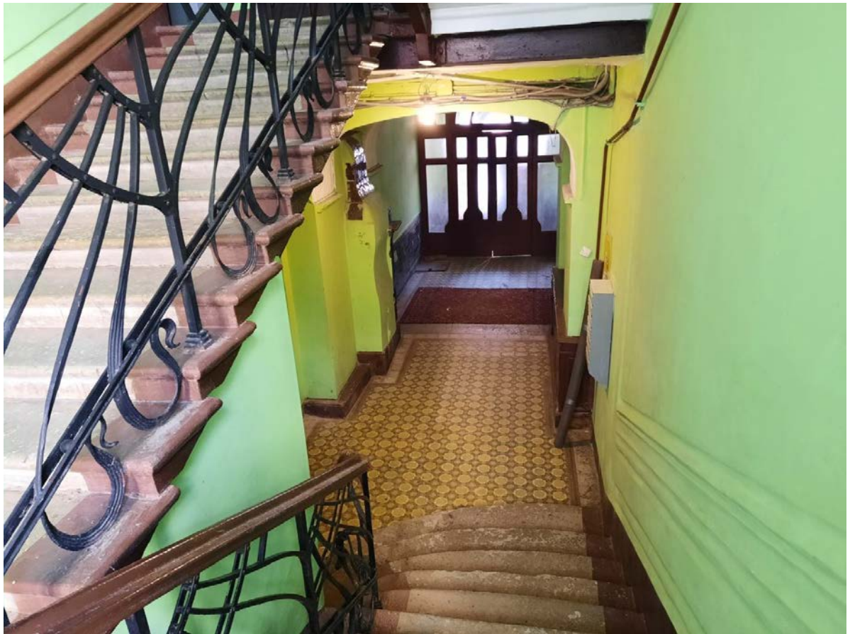
18. Интерьер вестибюля парадной. Фрагмент ограждения парадной лестницы
