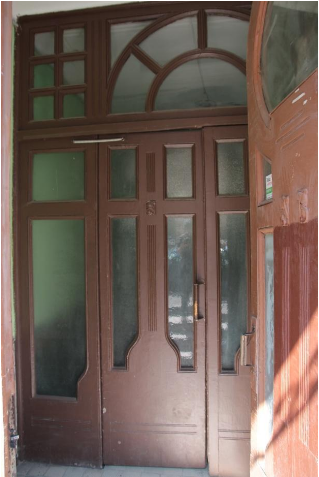
12. Фрагмент главного фасада. Внутренняя дверь тамбура парадного входа
