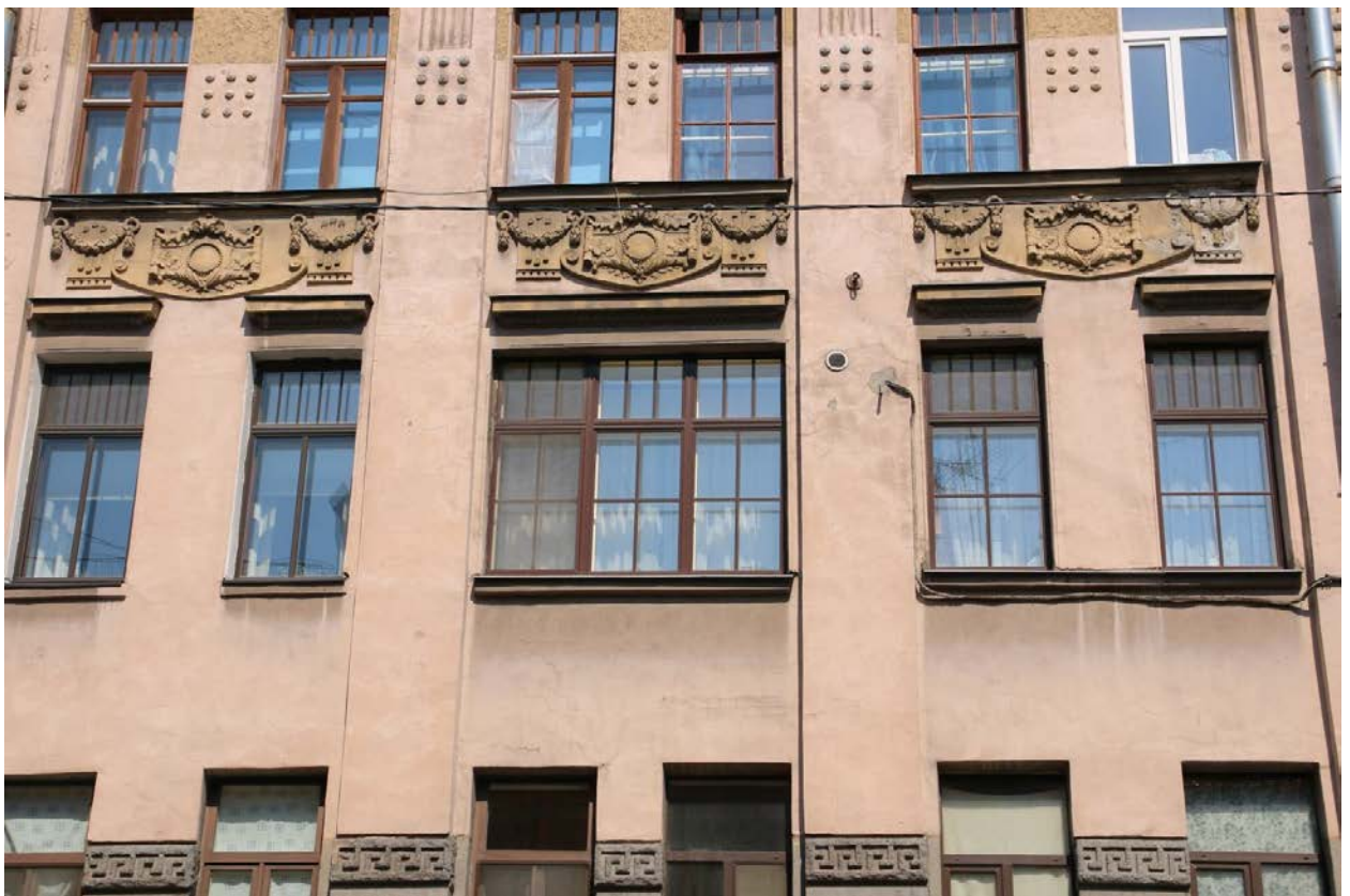
3. Фрагмент центральной части главного фасада. Оформление оконных проемов. Вид с юго-запада
