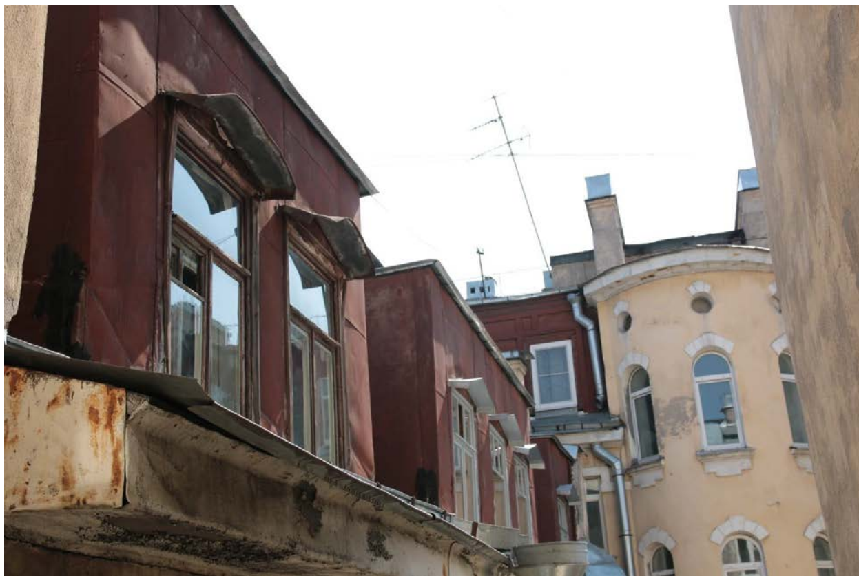
9. Фрагмент дворового фасада. Мансарда. Вид с северо-востока
