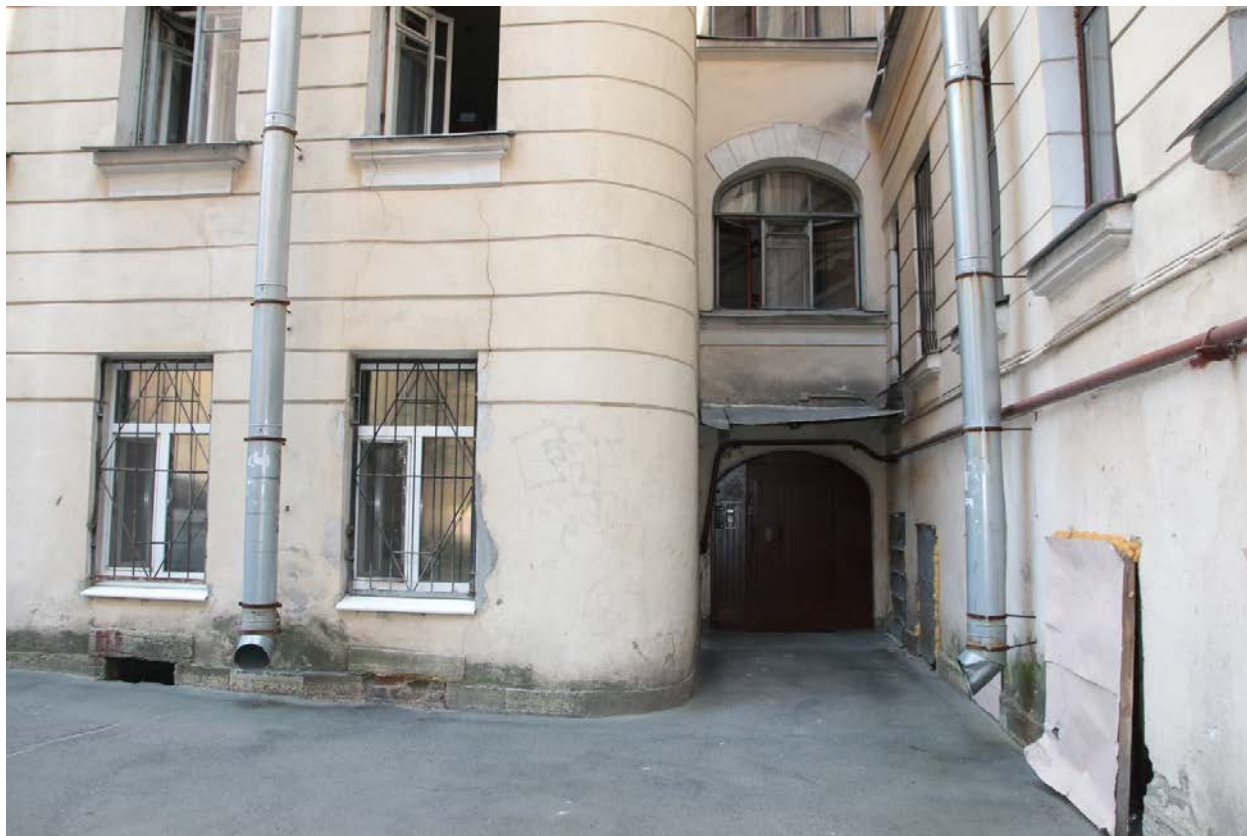
8. Фрагмент дворового фасада. Оформление оконных проемов и дверей входа. Вид с юго-запада
