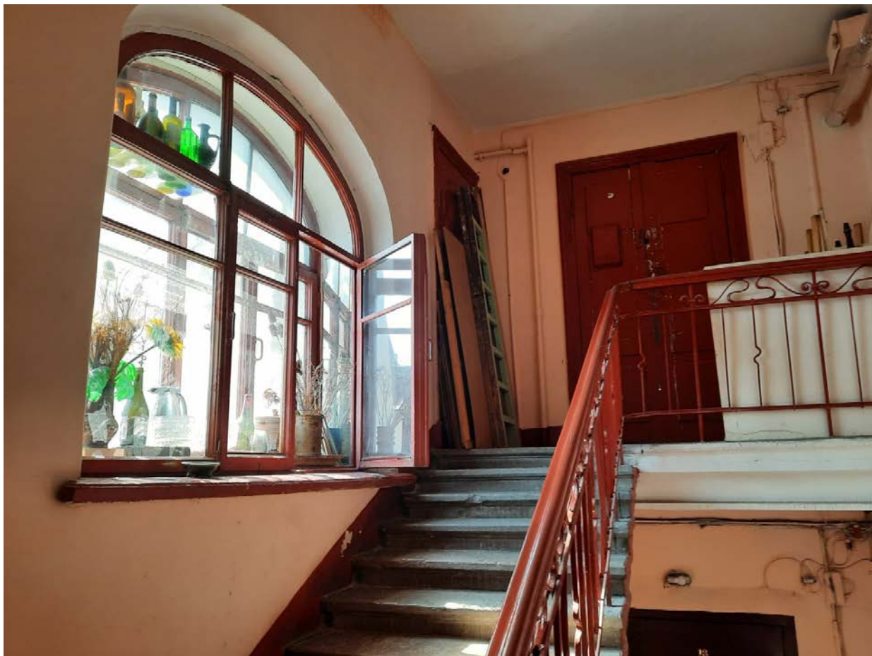
24. Интерьер парадной. Оформление оконного и дверного проема мансардного этажа
