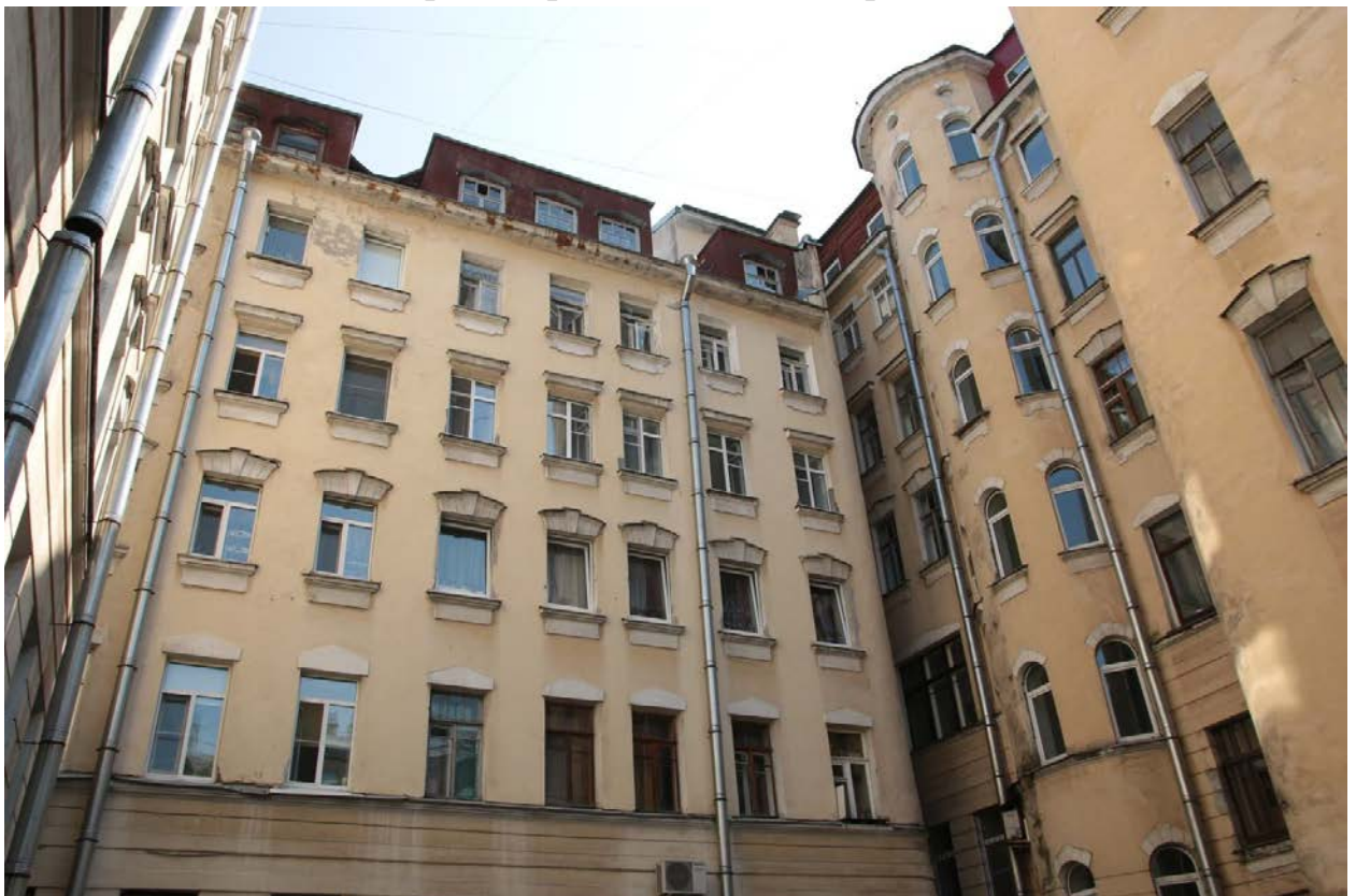
5. Фрагмент дворового фасада. Вид с севера
