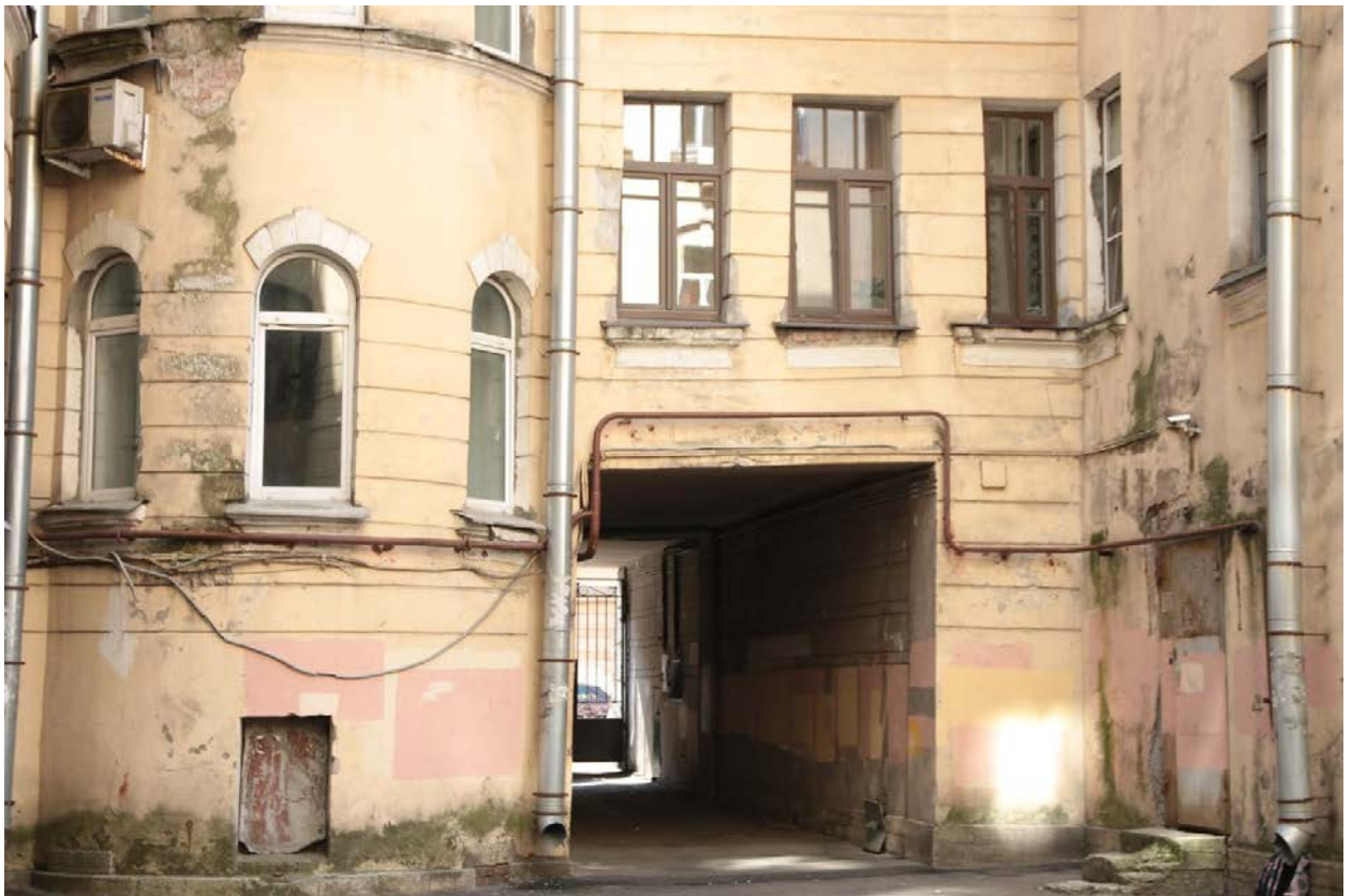
7. Фрагмент дворового фасада. Проездная арка. Вид с северо-востока
