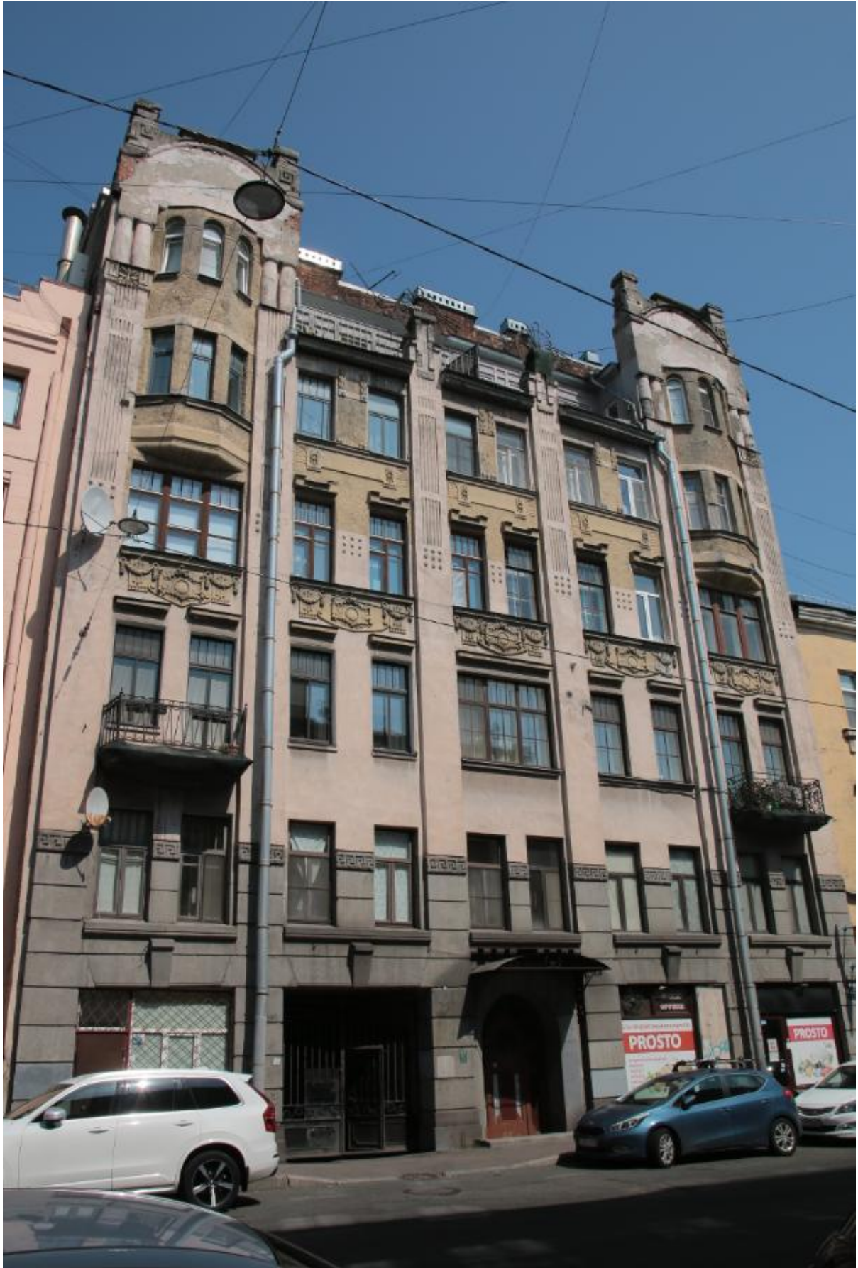
1. Главный фасад по 7-й Советской улице. Вид с юго-запада
