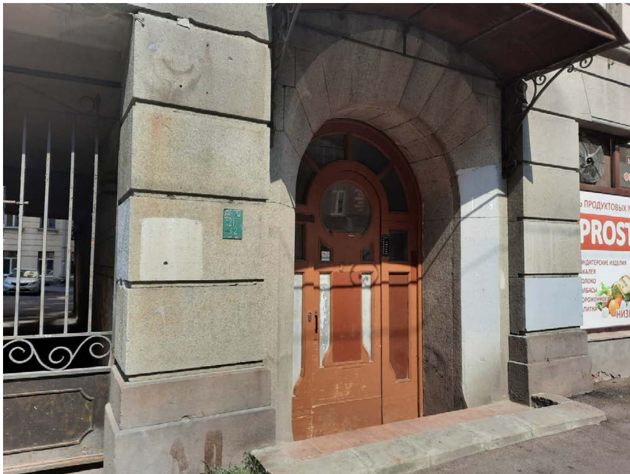
10. Фрагмент главного фасада. Оформление дверей парадного входа
