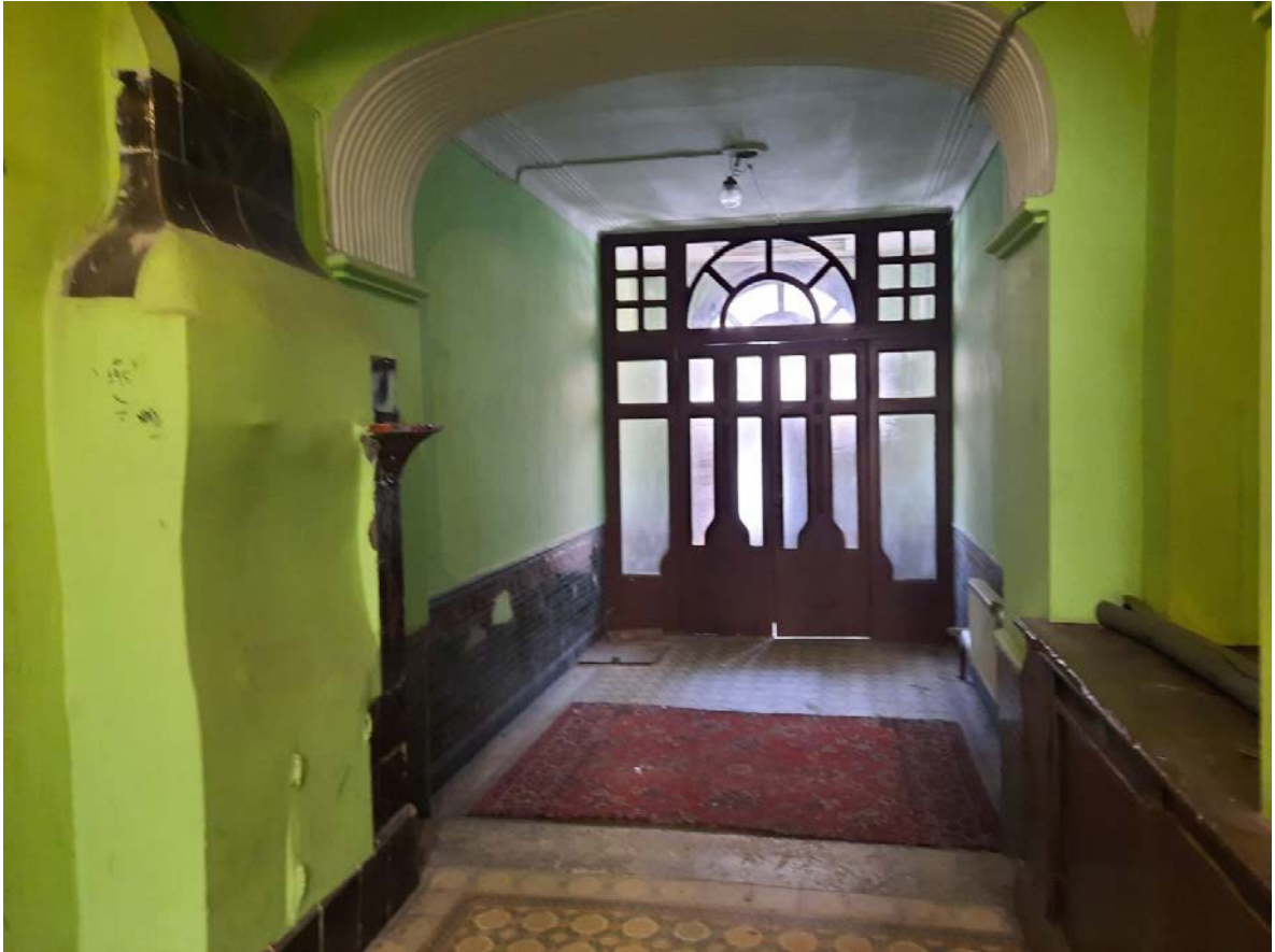
15. Интерьер вестибюля парадной. Оформление внутренней двери тамбура входа
