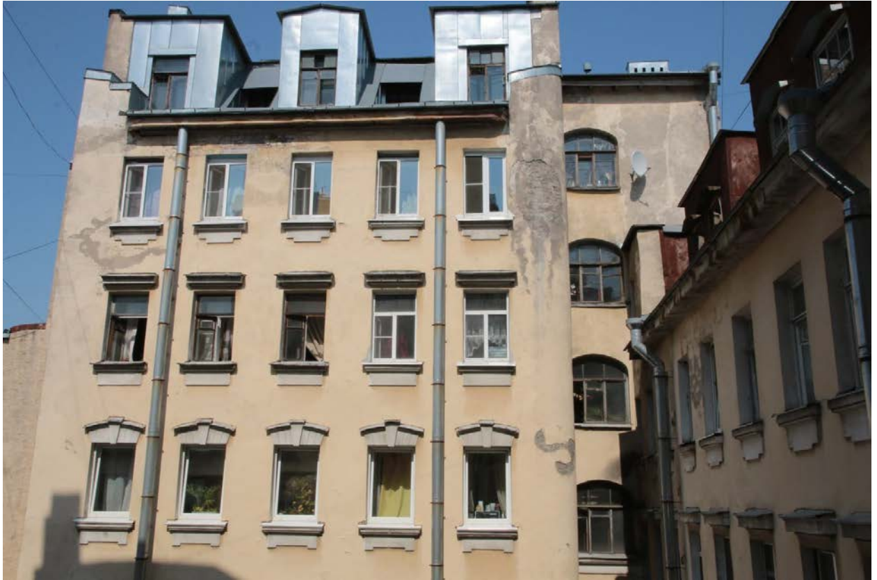
6. Фрагмент дворового фасада. Вид с юго-запада
