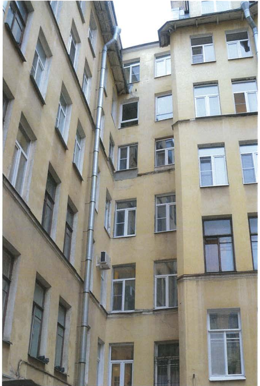
10. Выявленный объект культурного наследия «Дом И.Я.Романова» (Санкт-Петербург, 10-я Советская ул., д.19, лит.А). Вид из первого двора на юго-западный фасад среднего дворового корпуса. Два верхних окна в «кармане» - жилой комнаты кв. № 87.
