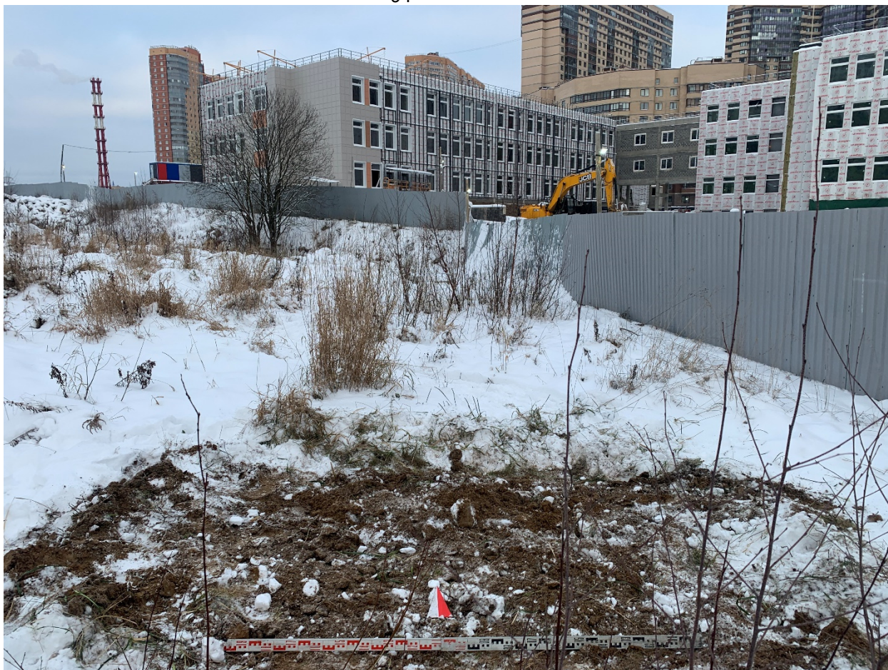
Рис. 32. Муринская дорога, уч. 4, КН:1008. Шурф 1 после рекультивации, вид на север.
