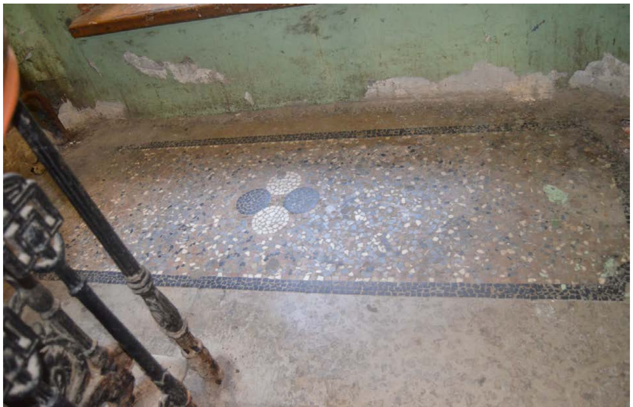
44. Выявленный объект культурного наследия «Дом Сироткиных». Лестница юго-восточного дворового флигеля (ЛЗ). Мозаичное оформление пола межэтажной площадки между первым и вторым этажами. Вид с юго-востока. Съемка 26.04.2021.
