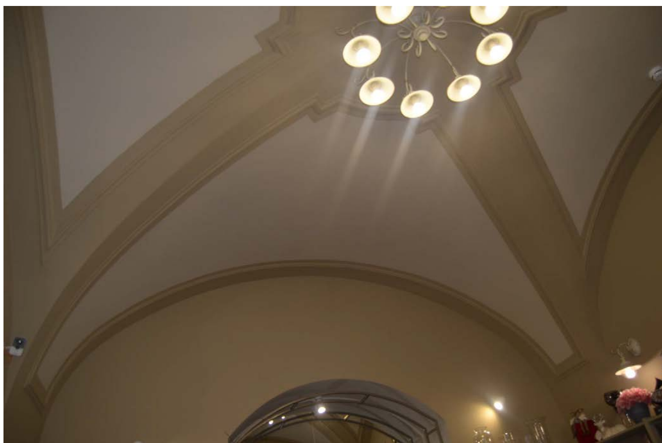
51. Выявленный объект культурного наследия «Дом Сироткиных». Оформление сводов в помещении 2-Н(1). Вид с северо-запада. Съемка 26.04.2021.
