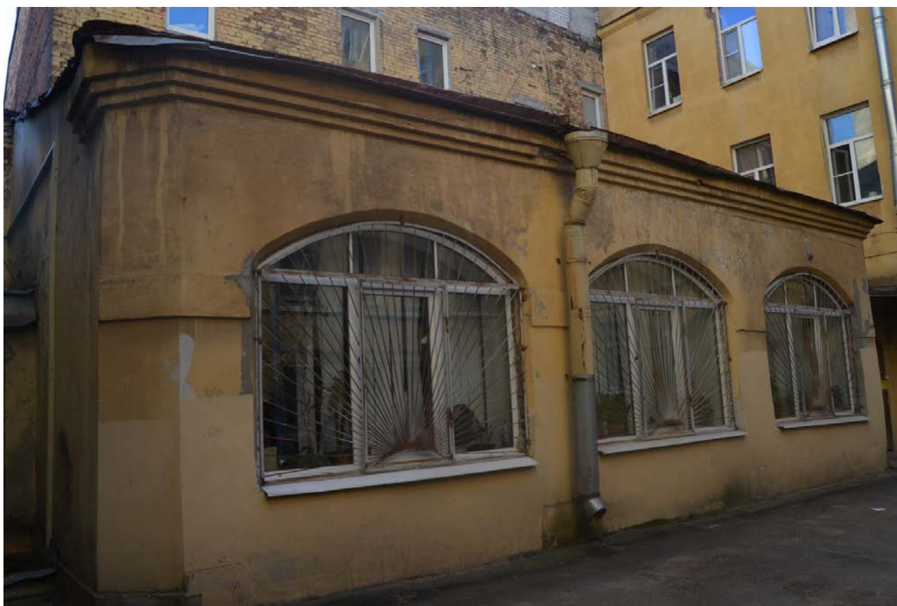
18. Выявленный объект культурного наследия «Дом Сироткиных». Западная дворовая пристройка во втором (южном) дворе. Вид с востока Съёмка 26.04.2021
