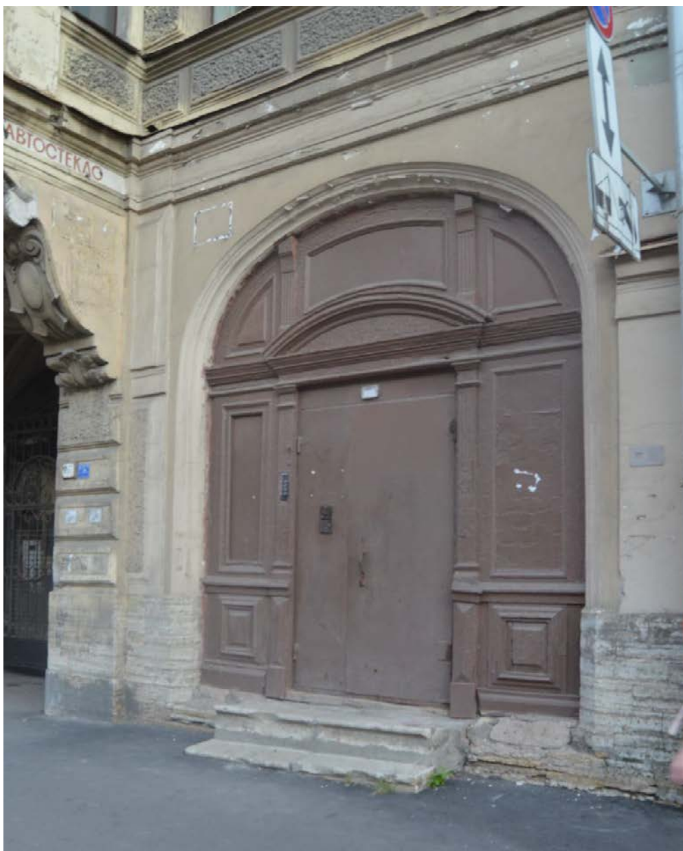
5. Выявленный объект культурного наследия «Дом Сироткиных». Оформление портала парадной лестницы по лицевому фасаду. Вид с северо-запада. Съемка 26.04.2021
