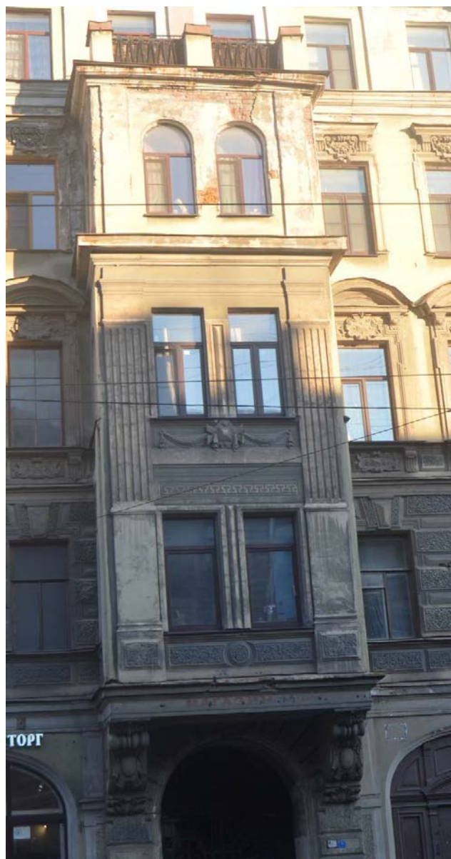
2. Выявленный объект культурного наследия «Дом Сироткиных». Эркер по центральным осям лицевого фасада. Вид с северо-запада. Съемка 26.04.2021
