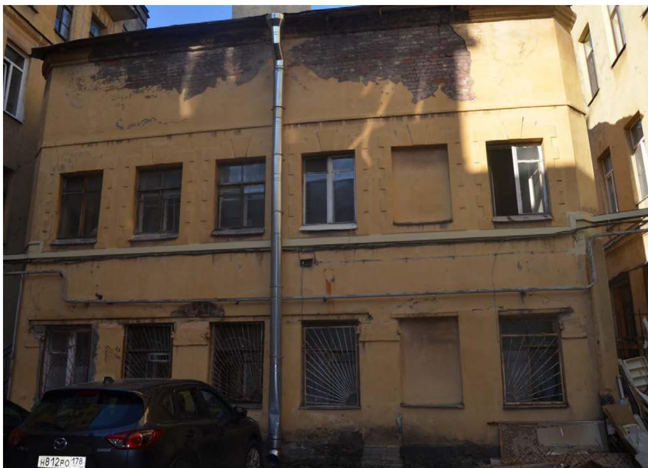
17. Выявленный объект культурного наследия «Дом Сироткиных». Восточная дворовая пристройка во втором (южном) дворе. Вид с запада. Съемка 26.04.2021
