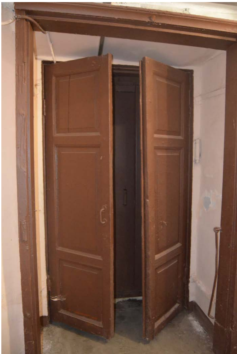
48. Выявленный объект культурного наследия «Дом Сироткиных». Лестница северного дворового флигеля (Л4). Исторический деревянный тамбур. Вид с северо-востока. Съемка 26.04.2021
