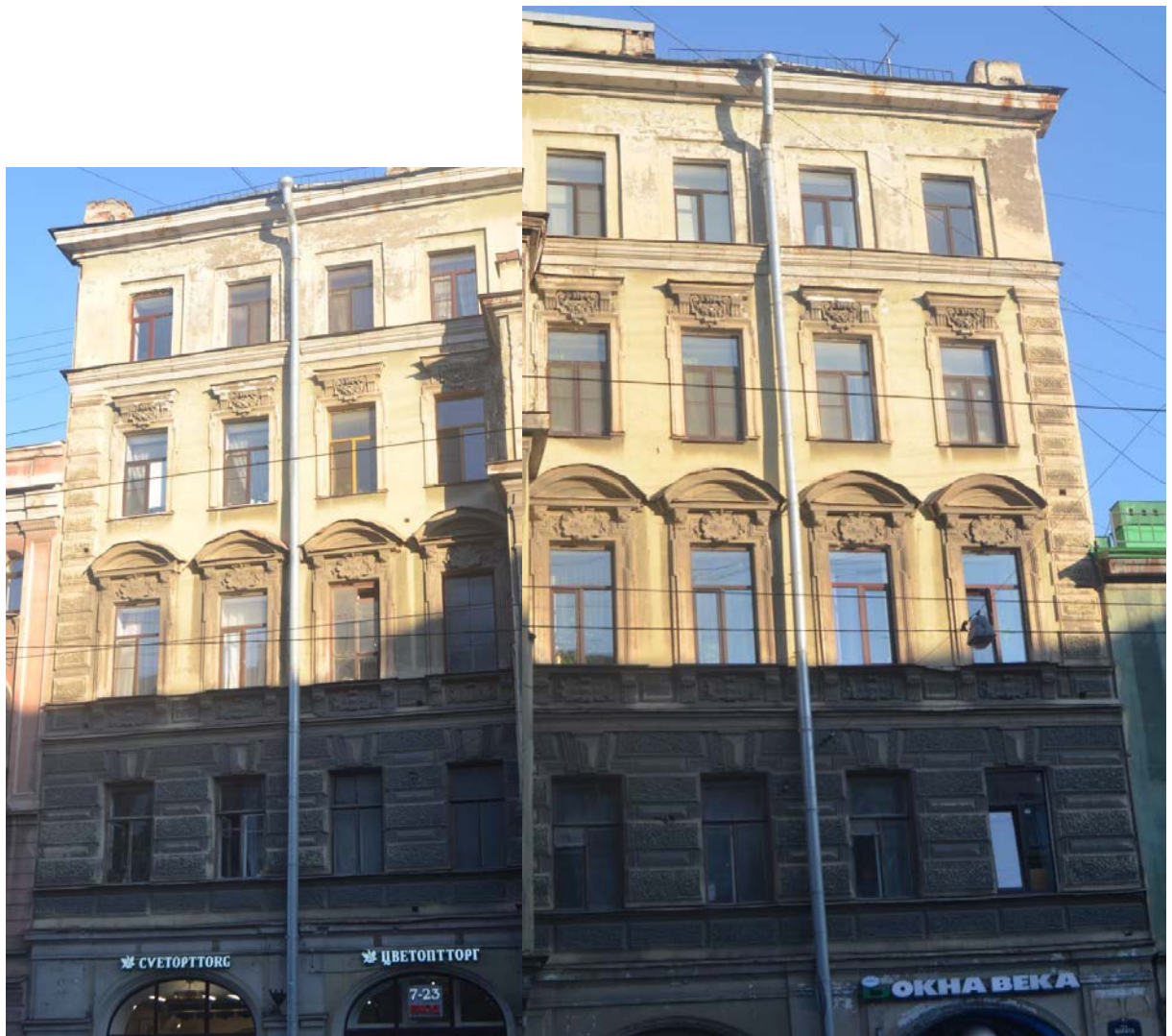
3. Выявленный объект культурного наследия «Дом Сироткиных». Западная и восточная часть лицевого фасада. Вид с северо-запада. Съемка 26.04.2021
