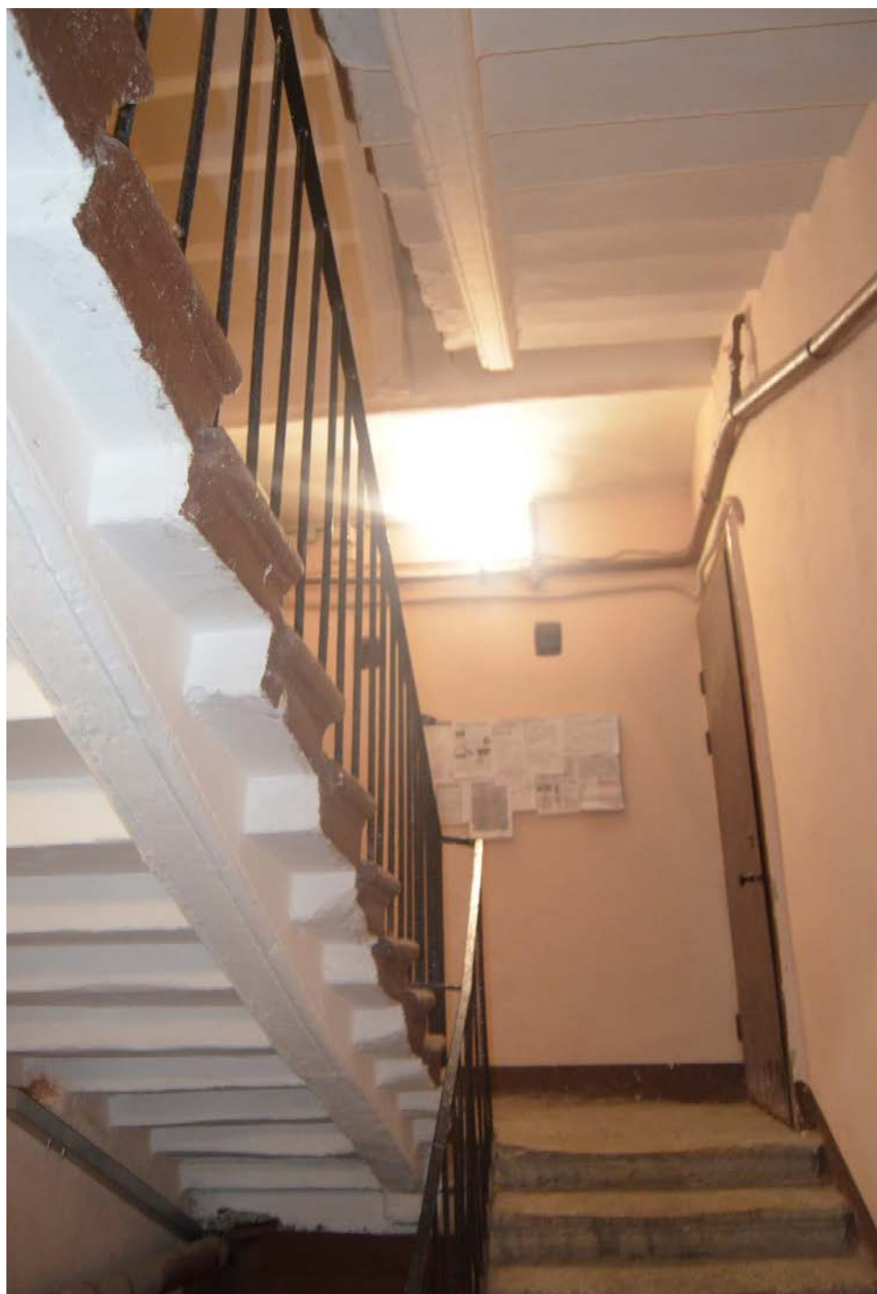
49. Выявленный объект культурного наследия «Дом Сироткиных». Лестница северного дворового флигеля (Л4). Конструкции лестничных маршей. Вид с юго-запада. Съемка 26.04.2021
