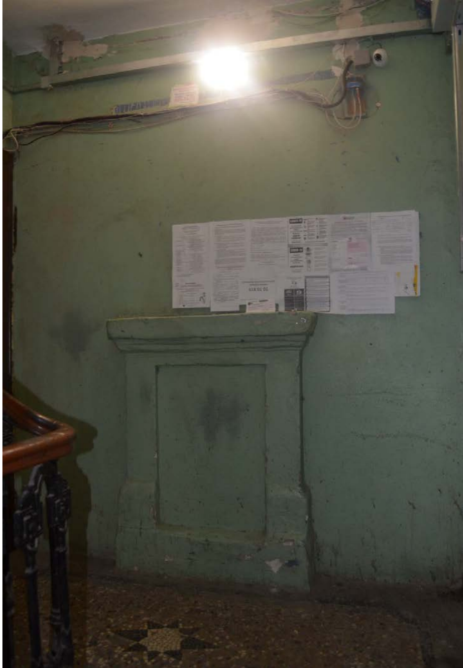
41. Выявленный объект культурного наследия «Дом Сироткиных». Лестница юго-восточного дворового флигеля (ЛЗ). Площадка первого этажа. Вид с северо-запада. Съемка 26.04.2021.
