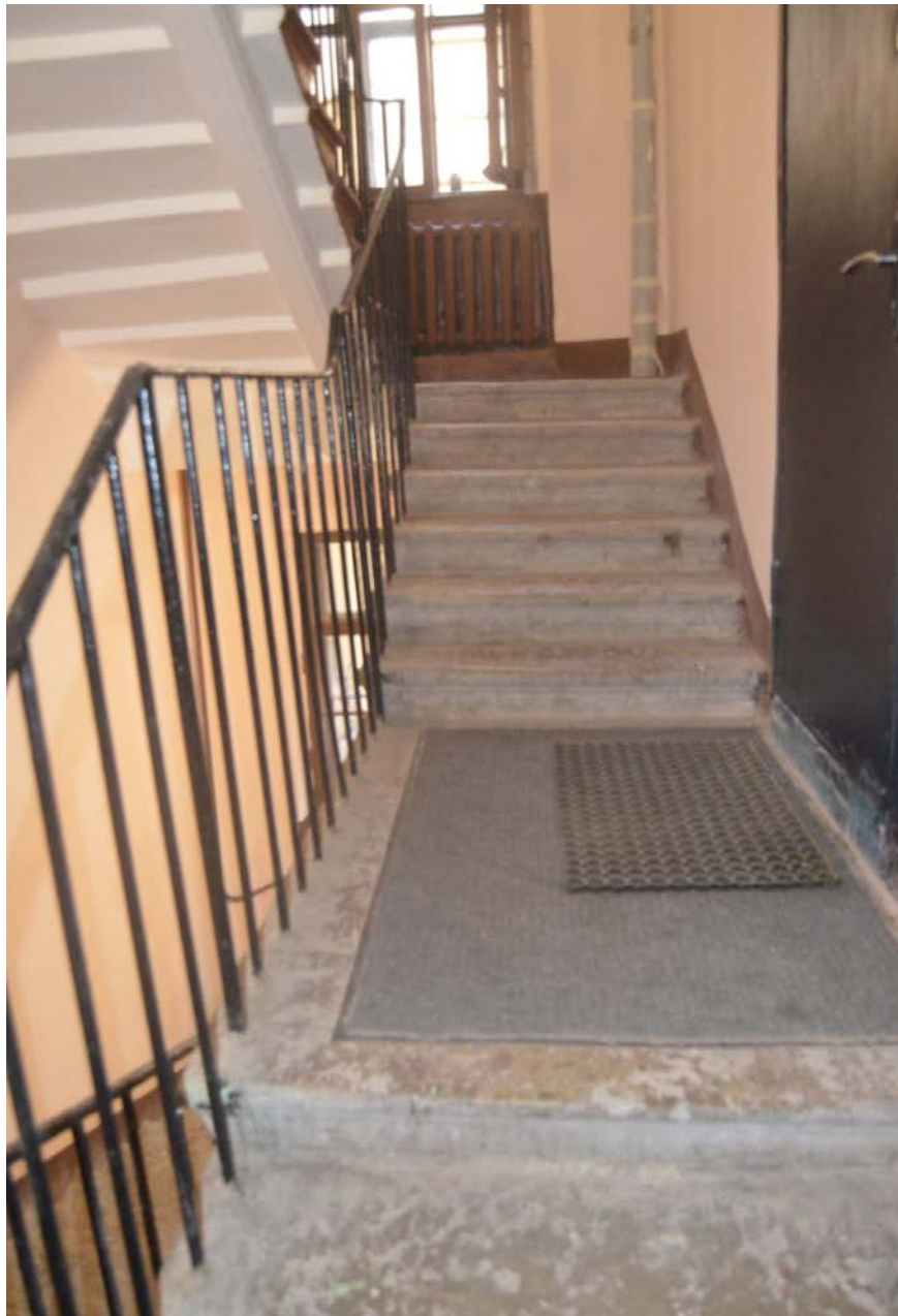
50. Выявленный объект культурного наследия «Дом Сироткиных». Лестница северного дворового флигеля (Л4). Конструкция лестничных маршей в уровне третьего этажа. Вид с северо-востока. Съемка 26.04.2021.
