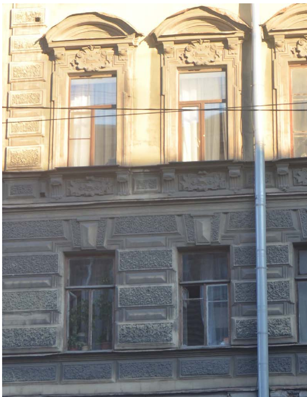
7. Выявленный объект культурного наследия «Дом Сироткиных». Оформление оконных проемов второго-третьего этажей по лицевому фасаду. Вид с северо-запада. Съемка 26.04.2021
