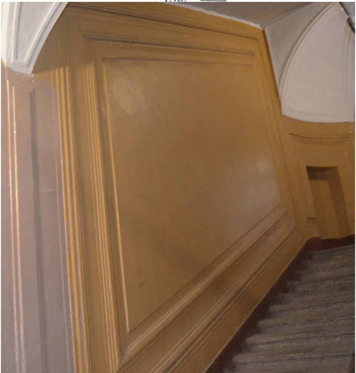
27. Выявленный объект культурного наследия «Дом Сироткиных». Парадная лестница (Л1). Оформление стен объема лестничной клетки. Вид с запада. Съемка 26.04.2021
