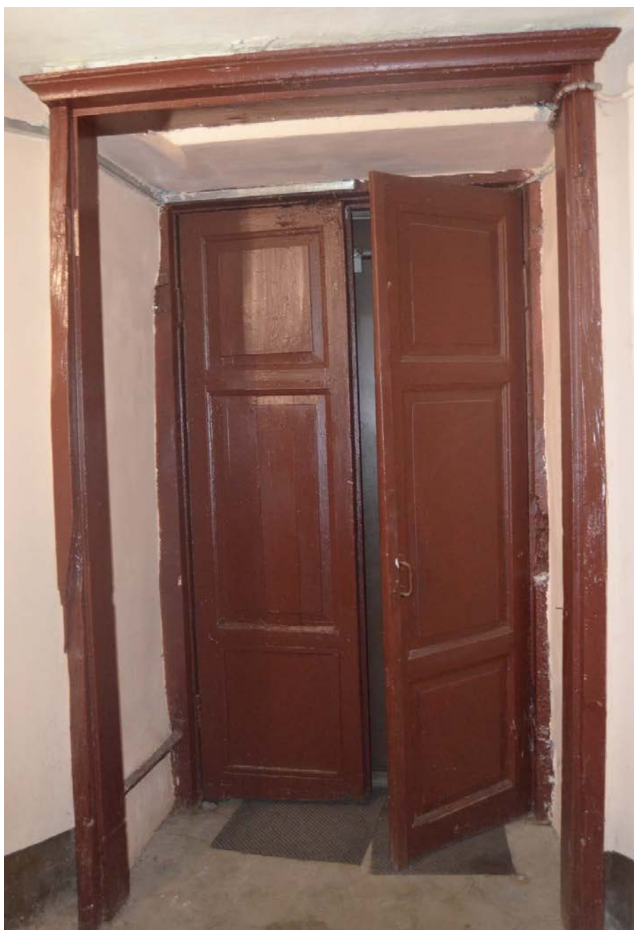
35. Выявленный объект культурного наследия «Дом Сироткиных». Лестница южного дворового флигеля (Л2). Исторический деревянный тамбур. Вид с юго-запада. Съемка 26.04.2021
