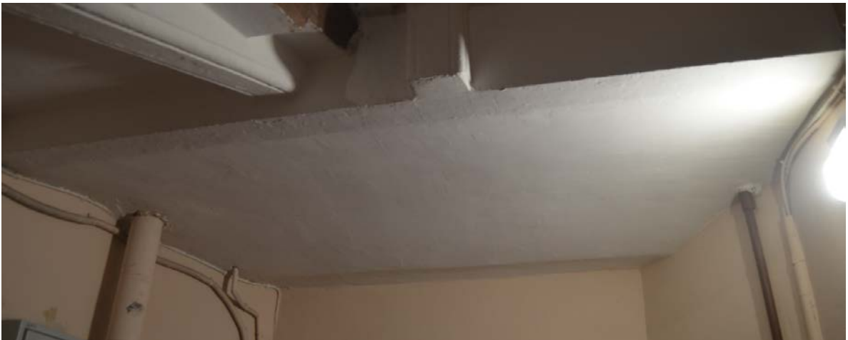
38. Выявленный объект культурного наследия «Дом Сироткиных». Лестница южного дворового флигеля (Л2). Конструкции лестничных площадок. Вид с северо-востока и северо-запада. Съемка 26.04.2021.
