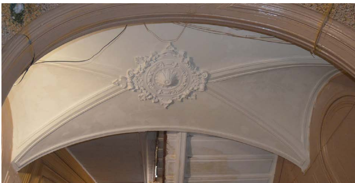
26. Выявленный объект культурного наследия «Дом Сироткиных». Парадная лестница (Л1). Конструкция и отделка подшивки этажной площадки первого этажа. Вид с северо-запада. Съемка 26.04.2021
