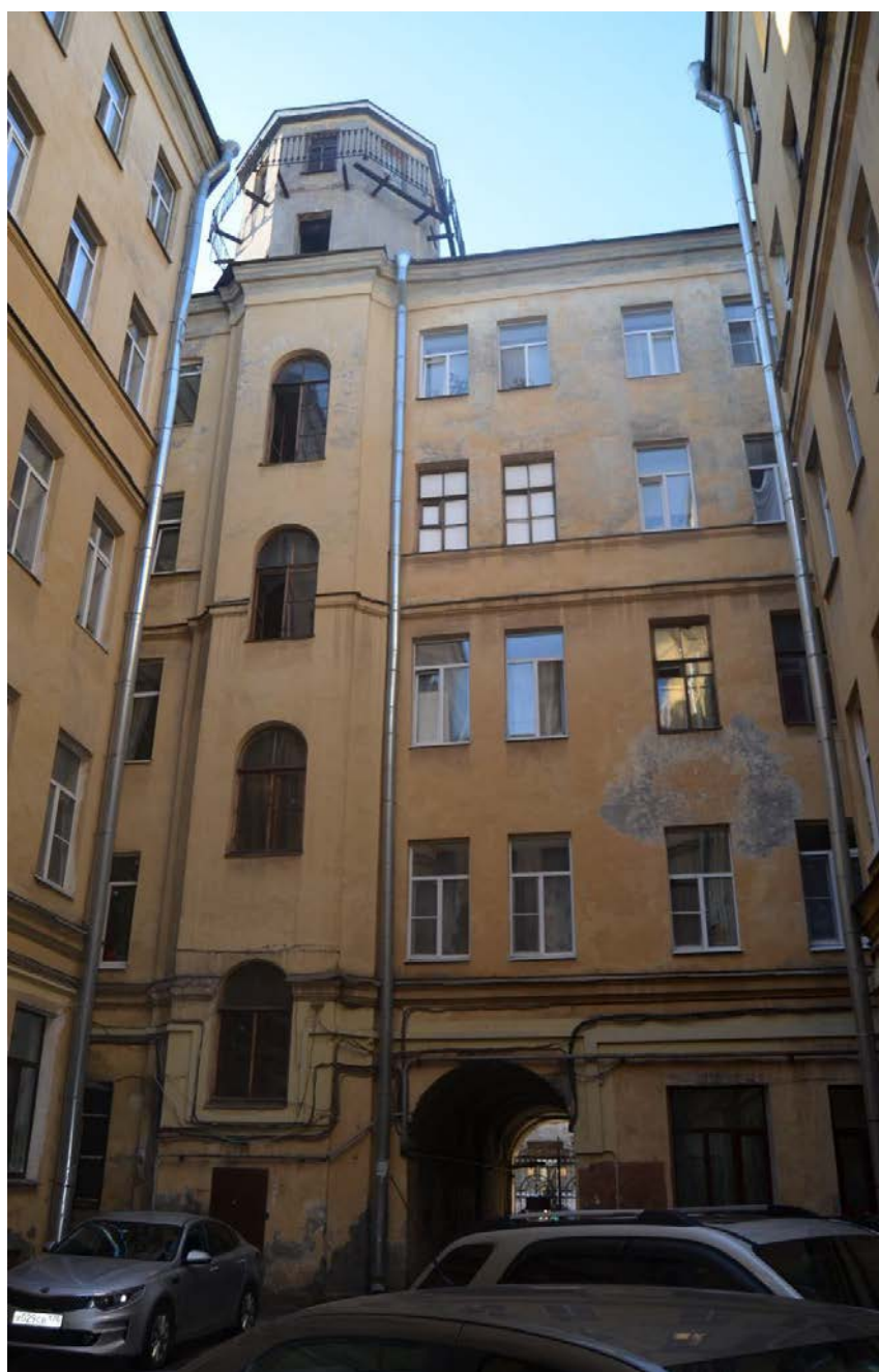
12. Выявленный объект культурного наследия «Дом Сироткиных». Дворовый (юго-восточный) фасад лицевого дома с лестничным ризалитом парадной лестницы и башенным объемом. Вид с юго-востока. Съемка 26.04.2021
