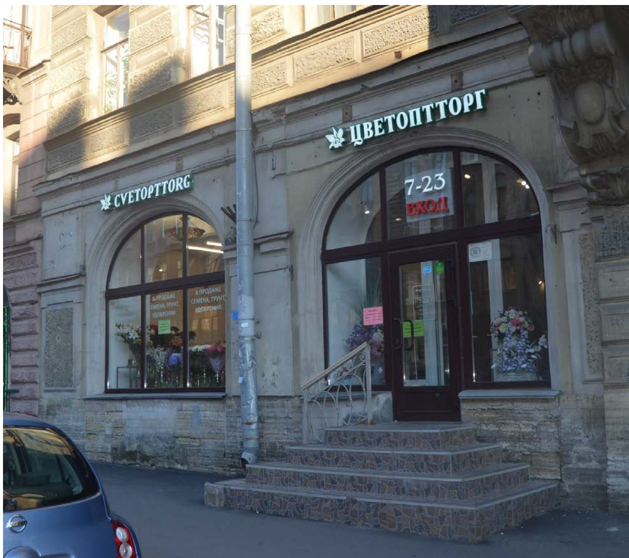
4. Выявленный объект культурного наследия «Дом Сироткиных». Оформление витринных проемов первого этажа лицевого фасада. Вид с северо-запада. Съемка 26.04.2021
