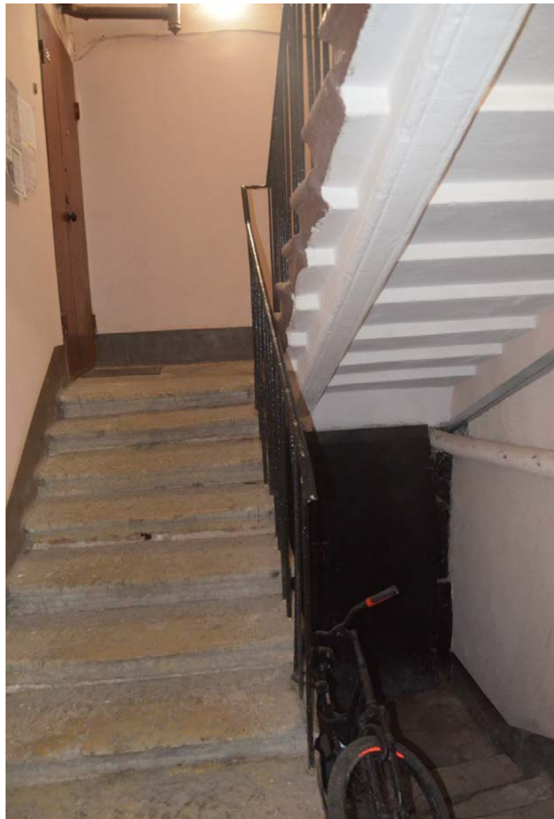
36. Выявленный объект культурного наследия «Дом Сироткиных». Лестница южного дворового флигеля (Л2). Конструкции лестничных маршей. Вид с северо-востока. Съемка 26.04.2021
