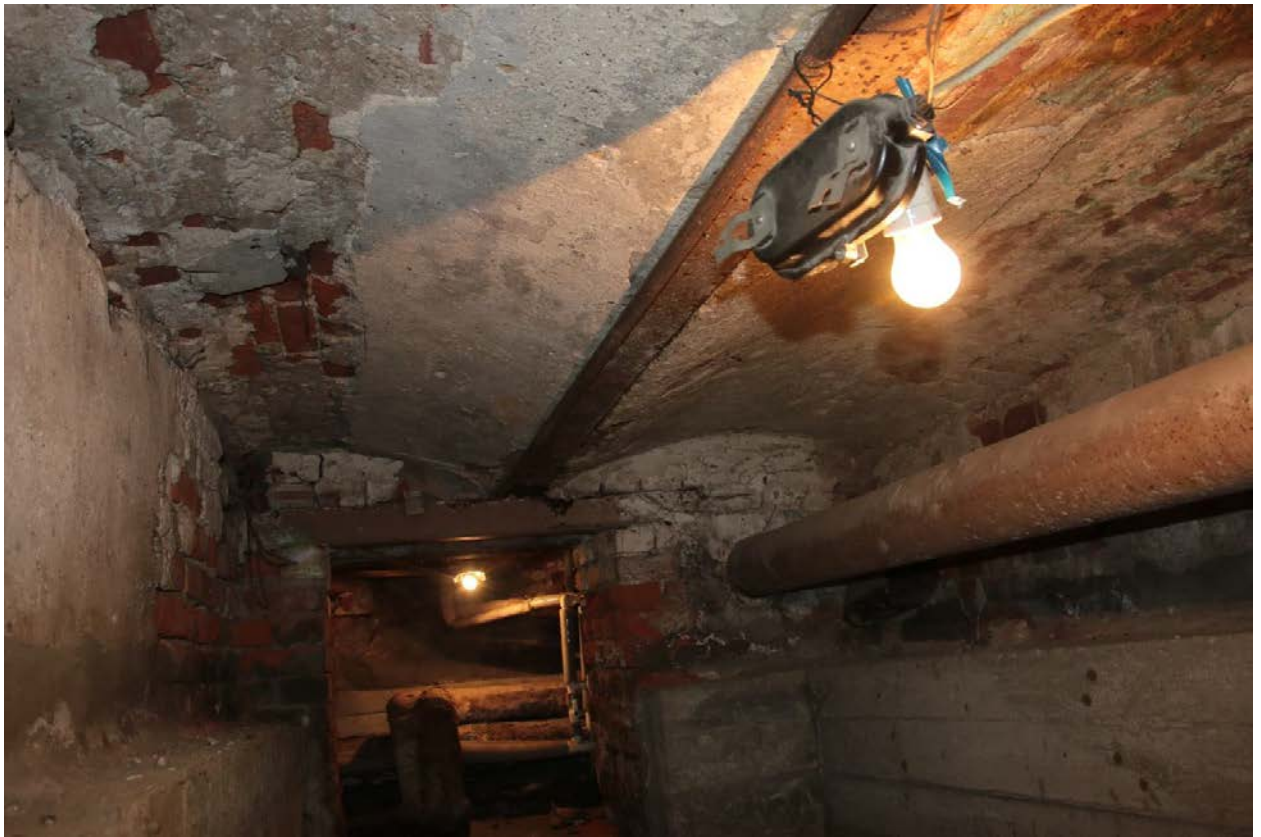
17. Фрагмент оформления потолка подвального помещения
