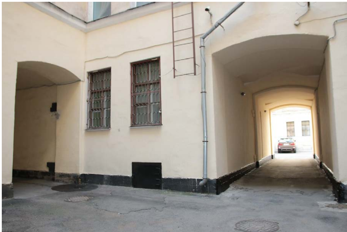
9. Фрагмент фасада. Вид с юго-запада
