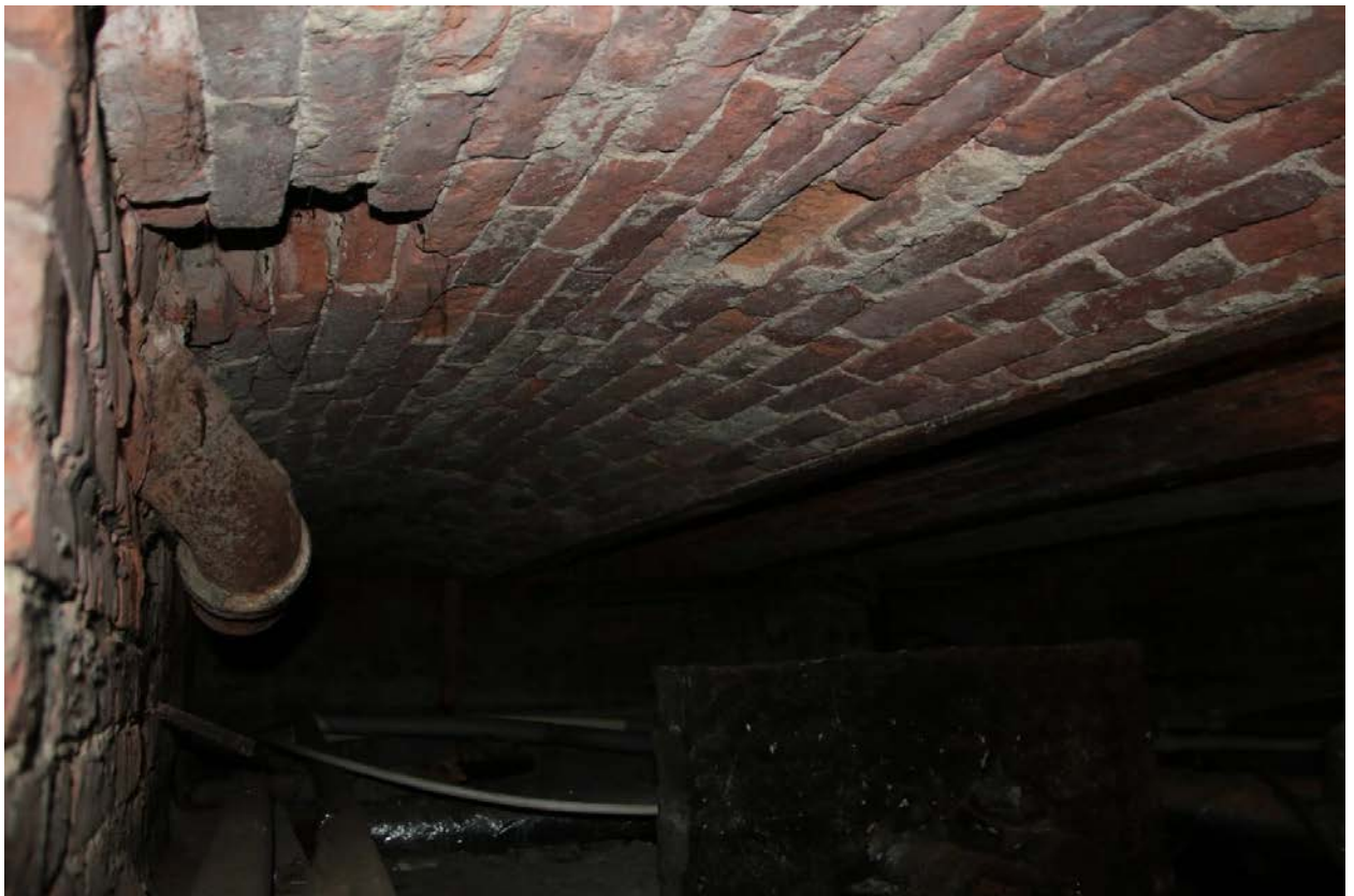
18. Фрагмент оформления потолка подвального помещения
