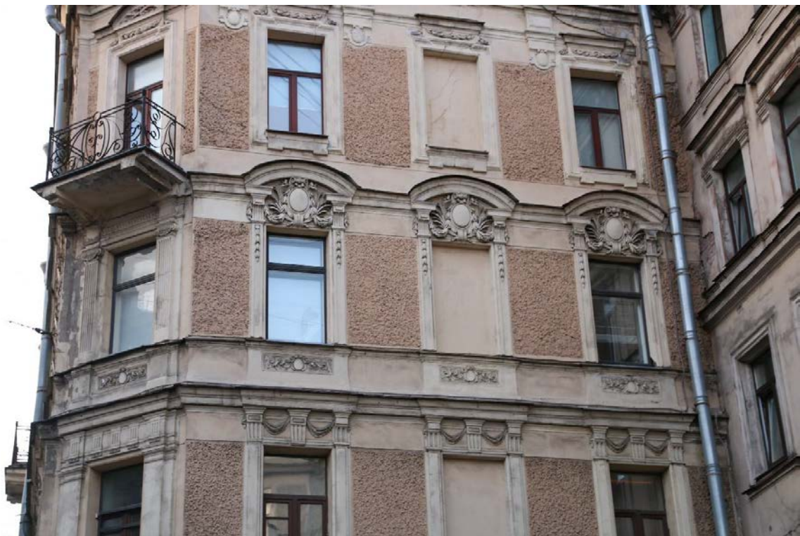
4. Фрагмент фасада. Вид с юго-запада
