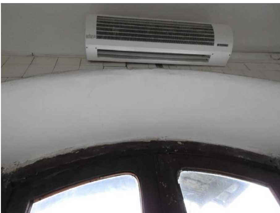
20. «Главное здание», входящее в состав объекта культурного наследия федерального значения «Институт ортопедический», Александровский парк, д. 5 литера А. Вход со стороны Троицкой площади. Тамбур. Фрагмент. Фото 11.03.2021 г.
