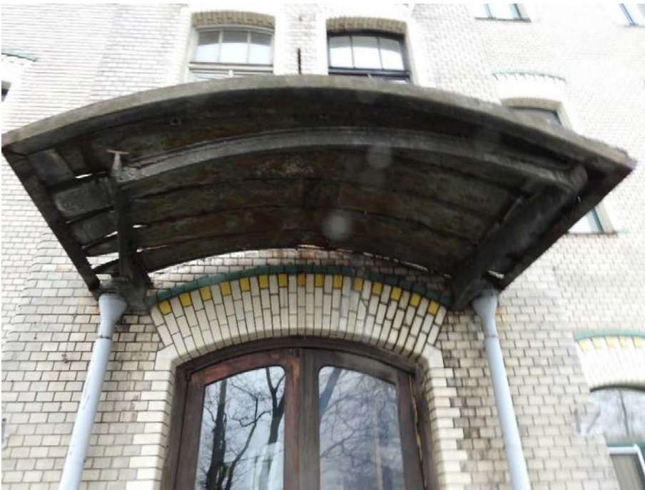
4. «Главное здание», входящее в состав объекта культурного наследия федерального значения «Институт ортопедический», Александровский парк, д. 5 литера А. Вход со стороны Троицкой площади. Юго-восточный фасад. Фрагмент. Фото 11.03.2021 г.
