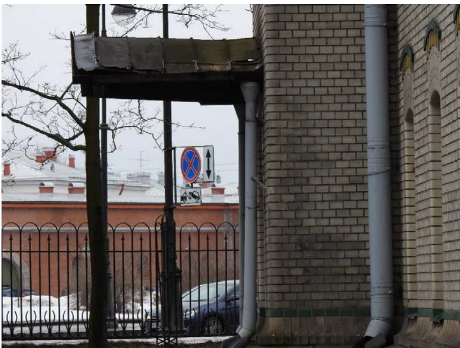
7. «Главное здание», входящее в состав объекта культурного наследия федерального значения «Институт ортопедический», Александровский парк, д. 5 литера А. Вход со стороны Троицкой площади. Юго-восточный фасад. Фрагмент. Фото 11.03.2021 г.
