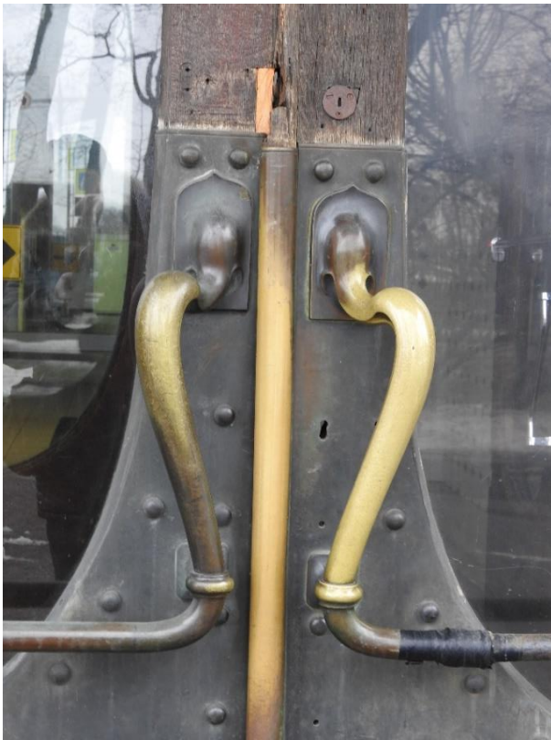
11. «Главное здание», входящее в состав объекта культурного наследия федерального значения «Институт ортопедический», Александровский парк, д. 5 литера А. Вход со стороны Троицкой площади. Юго-восточный фасад. Фрагмент. Фото 11.03.2021 г.
