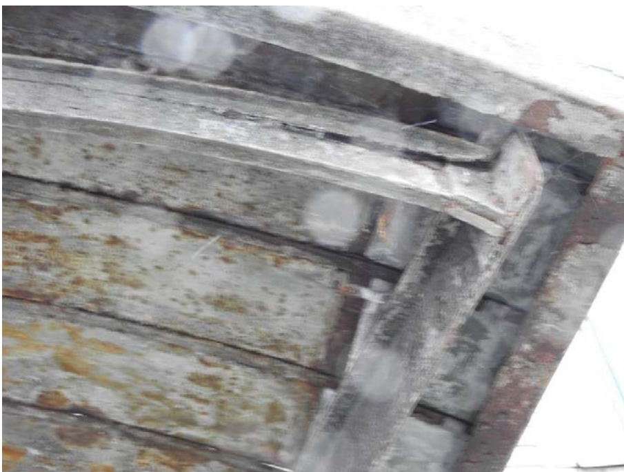
5. «Главное здание», входящее в состав объекта культурного наследия федерального значения «Институт ортопедический», Александровский парк, д. 5 литера А. Вход со стороны Троицкой площади. Юго-восточный фасад. Фрагмент. Фото 11.03.2021 г.
