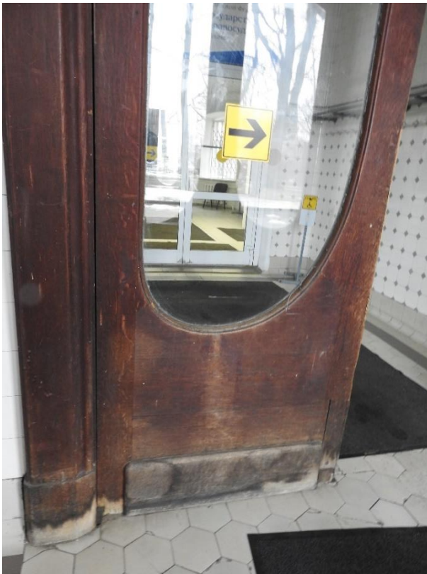
25. «Главное здание», входящее в состав объекта культурного наследия федерального значения «Институт ортопедический», Александровский парк, д. 5 литера А. Вход со стороны Троицкой площади. Тамбур. Фрагмент. Фото 11.03.2021 г.
