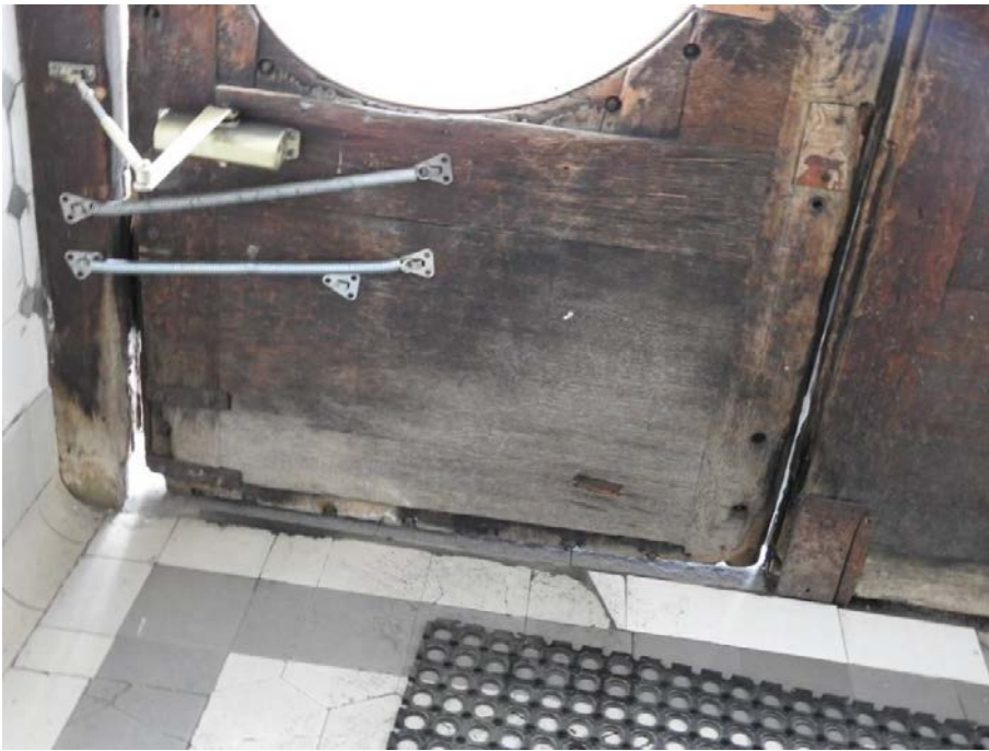
17. «Главное здание», входящее в состав объекта культурного наследия федерального значения «Институт ортопедический», Александровский парк, д. 5 литера А. Вход со стороны Троицкой площади. Тамбур. Фрагмент. Фото 11.03.2021 г.
