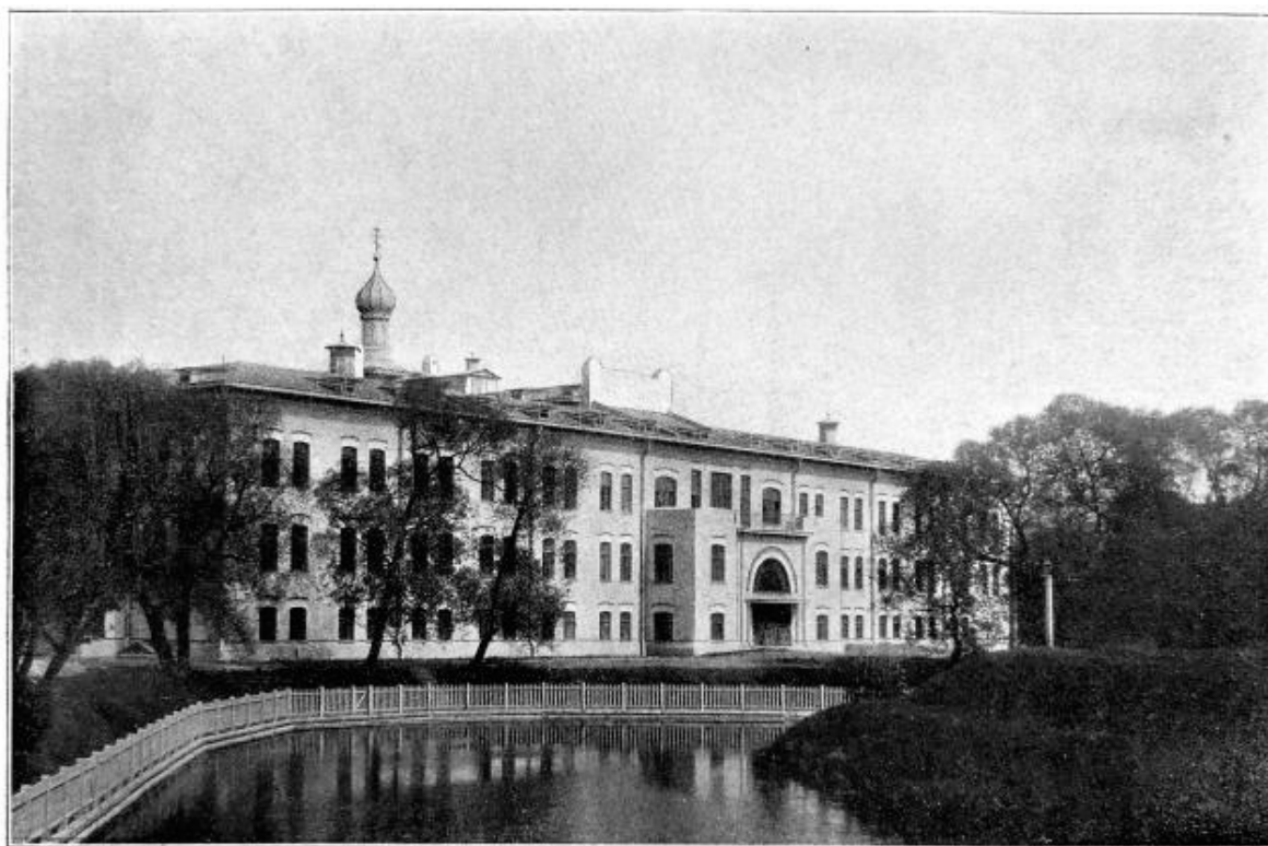
С.-Петербургскій Ортопедическій Клиническій Институтъ. Александровскій паркъ. С.-Петербургъ. Фасадъ на каналъ. Р. Ф. МЕЛЬЦЕРЪ, Художн.-Архитект. С.П.Бургъ.
