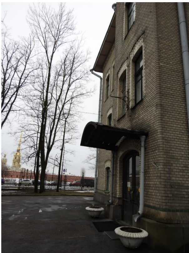
2. «Главное здание», входящее в состав объекта культурного наследия федерального значения «Институт ортопедический», Александровский парк, д. 5 литера А. Вход со стороны Троицкой площади. Юго-восточный фасад. Фрагмент. Фото 11.03.2021 г.
