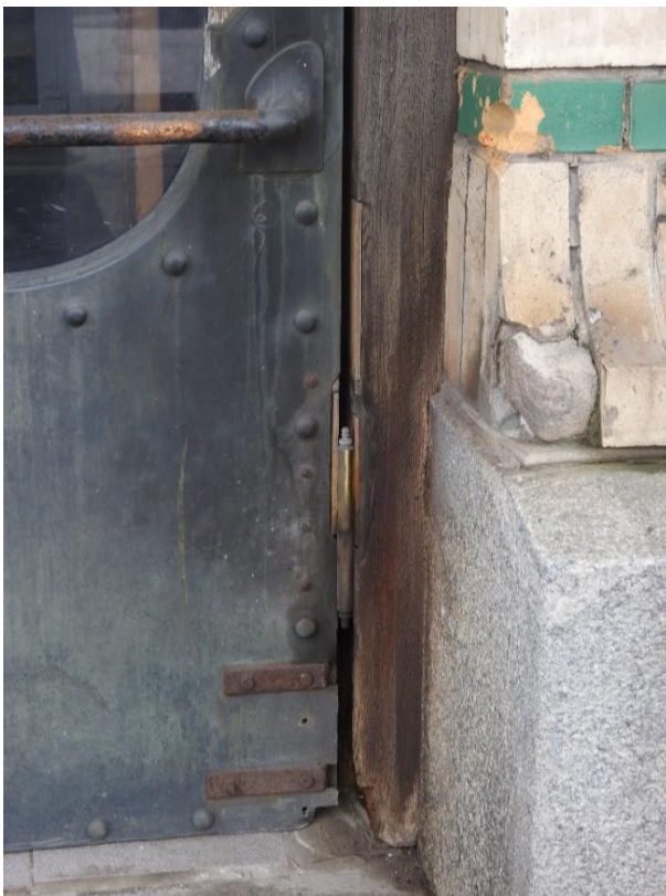
10. «Главное здание», входящее в состав объекта культурного наследия федерального значения «Институт ортопедический», Александровский парк, д. 5 литера А. Вход со стороны Троицкой площади. Юго-восточный фасад. Фрагмент. Фото 11.03.2021 г.
