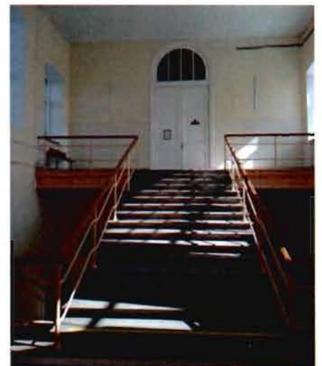
8. Лестница в центральной части здания.
