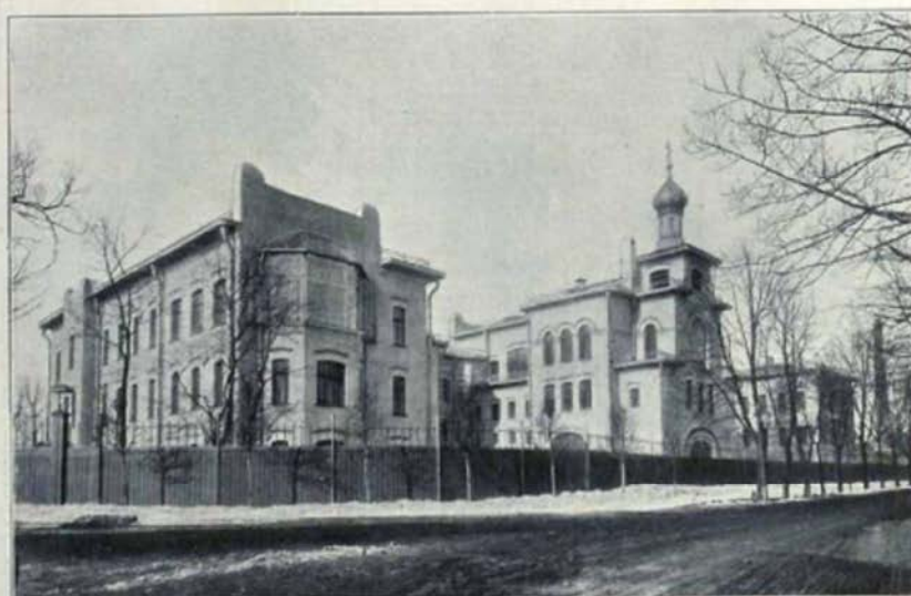
С.-Петербургский Ортопедический Клинический Институт. Александровский парк. С.-Петербург. Фасад со стороны парка. Р. Ф. МЕЛЬЦЕРЪ, Художн.-Архитект. С.П.Бурга.
