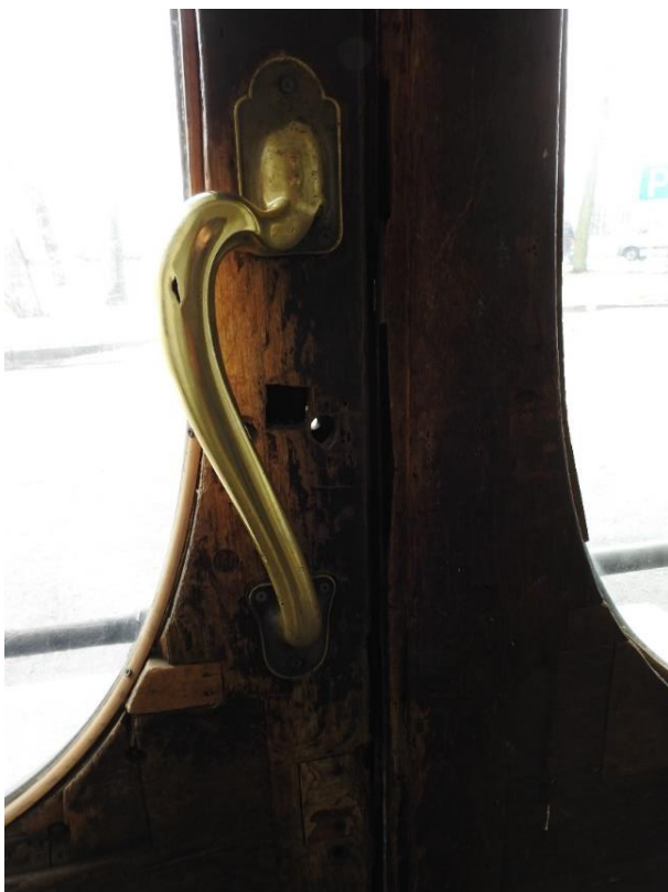
15. «Главное здание», входящее в состав объекта культурного наследия федерального значения «Институт ортопедический», Александровский парк, д. 5 литера А. Вход со стороны Троицкой площади. Тамбур. Фрагмент. Фото 11.03.2021 г.
