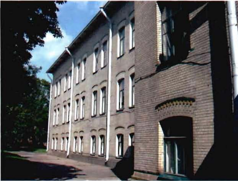
2. Вид на объект культурного наследия с юго-западной стороны.
