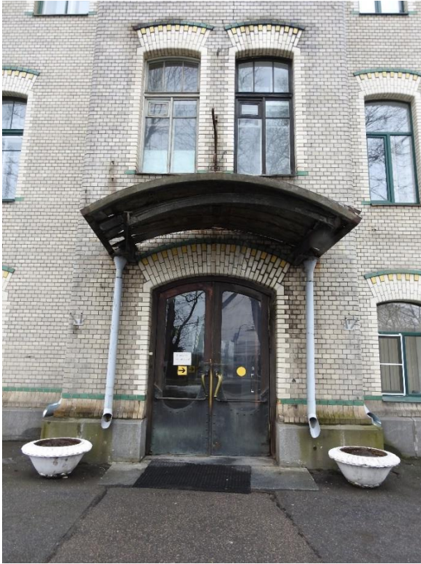
3. «Главное здание», входящее в состав объекта культурного наследия федерального значения «Институт ортопедический», Александровский парк, д. 5 литера А. Вход со стороны Троицкой площади. Юго-восточный фасад. Фрагмент. Фото 11.03.2021 г.
