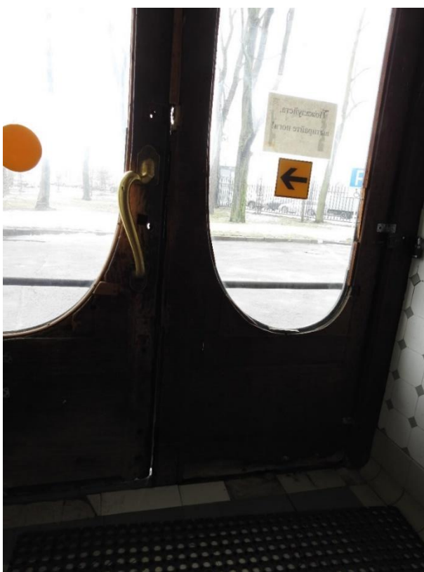
14. «Главное здание», входящее в состав объекта культурного наследия федерального значения «Институт ортопедический», Александровский парк, д. 5 литера А. Вход со стороны Троицкой площади. Тамбур. Фрагмент. Фото 11.03.2021 г.
