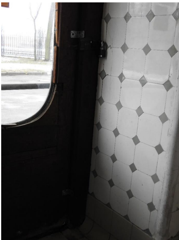
19. «Главное здание», входящее в состав объекта культурного наследия федерального значения «Институт ортопедический», Александровский парк, д. 5 литера А. Вход со стороны Троицкой площади. Тамбур. Фрагмент. Фото 11.03.2021 г.
