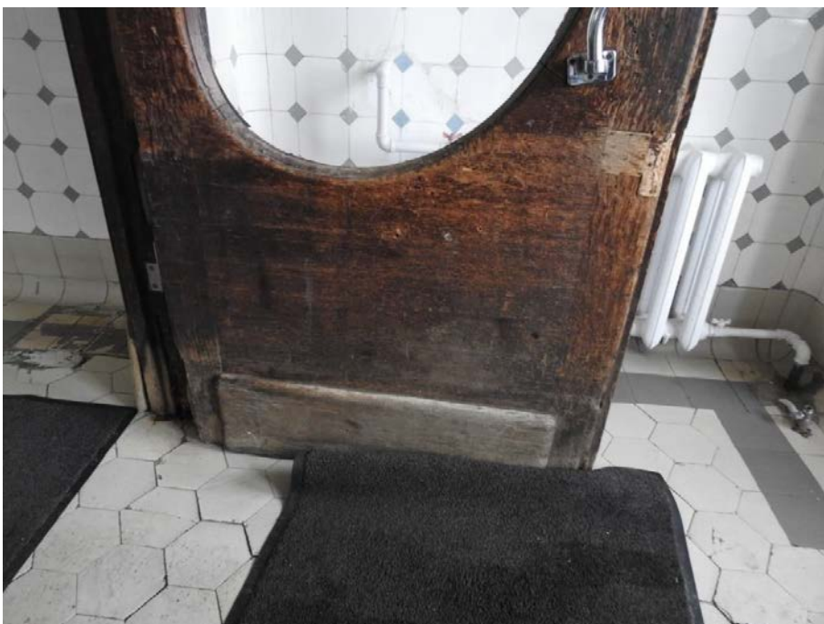
27. «Главное здание», входящее в состав объекта культурного наследия федерального значения «Институт ортопедический», Александровский парк, д. 5 литера А. Вход со стороны Троицкой площади. Тамбур. Фрагмент. Фото 11.03.2021 г.
