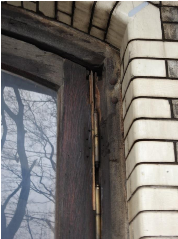
9. «Главное здание», входящее в состав объекта культурного наследия федерального значения «Институт ортопедический», Александровский парк, д. 5 литера А. Вход со стороны Троицкой площади. Юго-восточный фасад. Фрагмент. Фото 11.03.2021 г.
