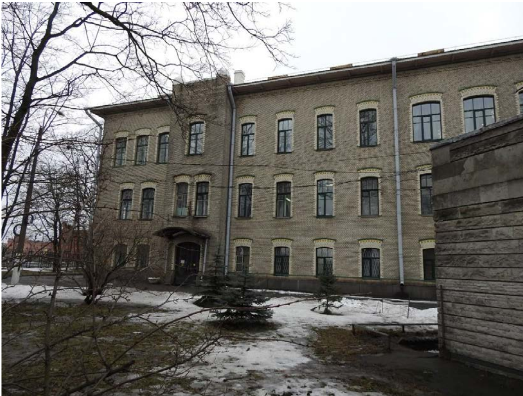
1. «Главное здание», входящее в состав объекта культурного наследия федерального значения «Институт ортопедический», Александровский парк, д. 5 литера А. Вход со стороны Троицкой площади. Юго-восточный фасад. Общий вид. Фото 11.03.2021 г.
