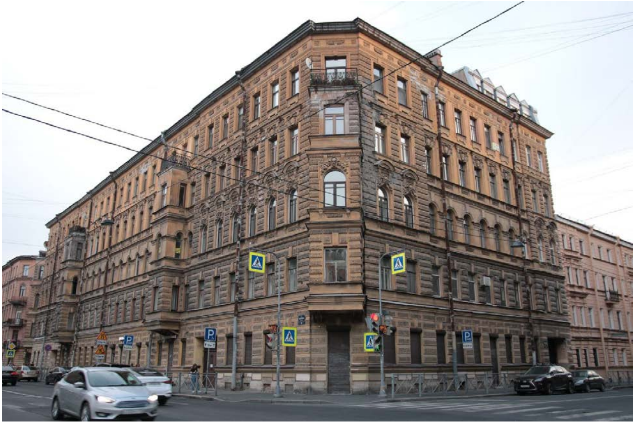
1. Общий вид здания с северо-востока
