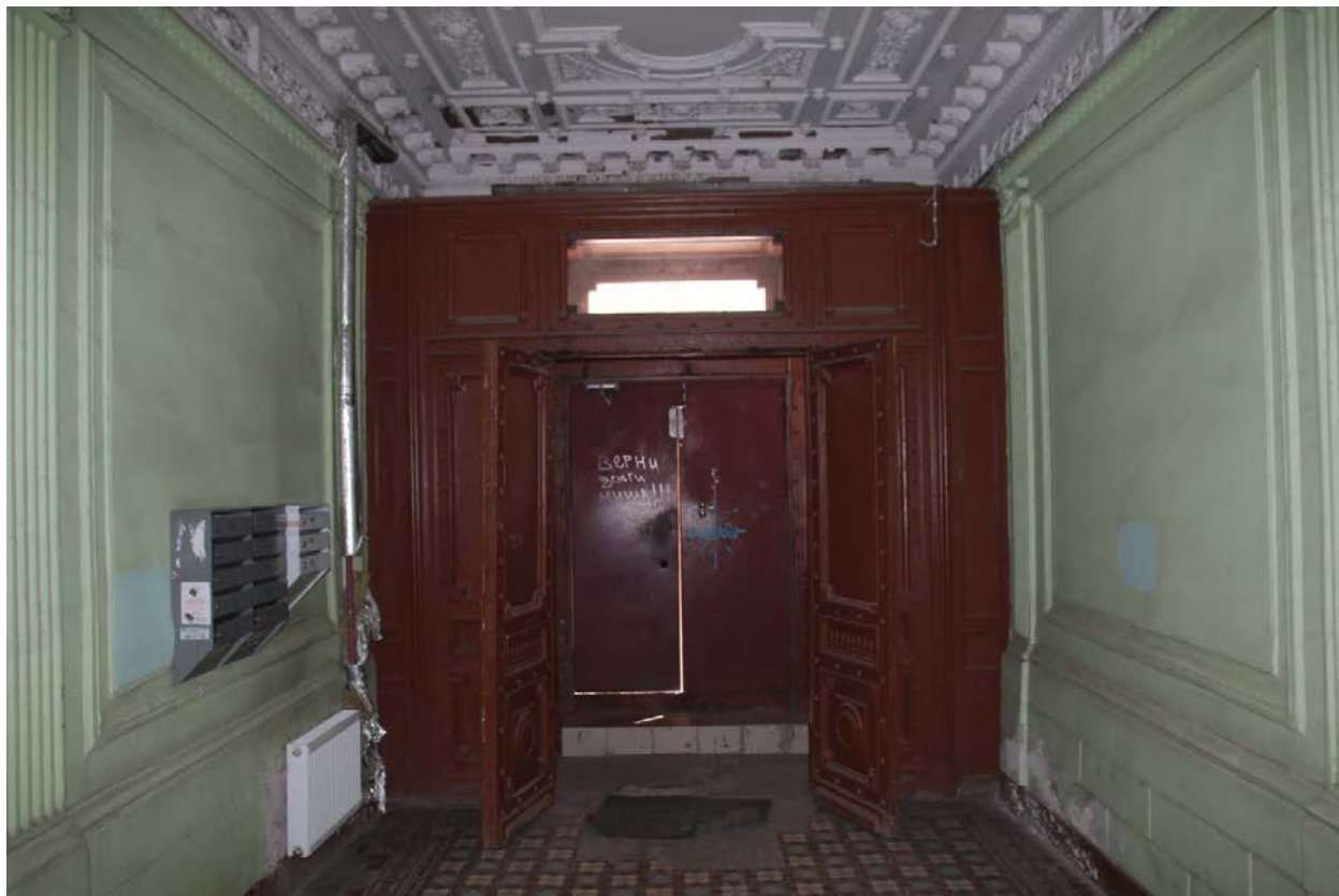
8. Интерьер вестибюля парадной. Тамбур входа
