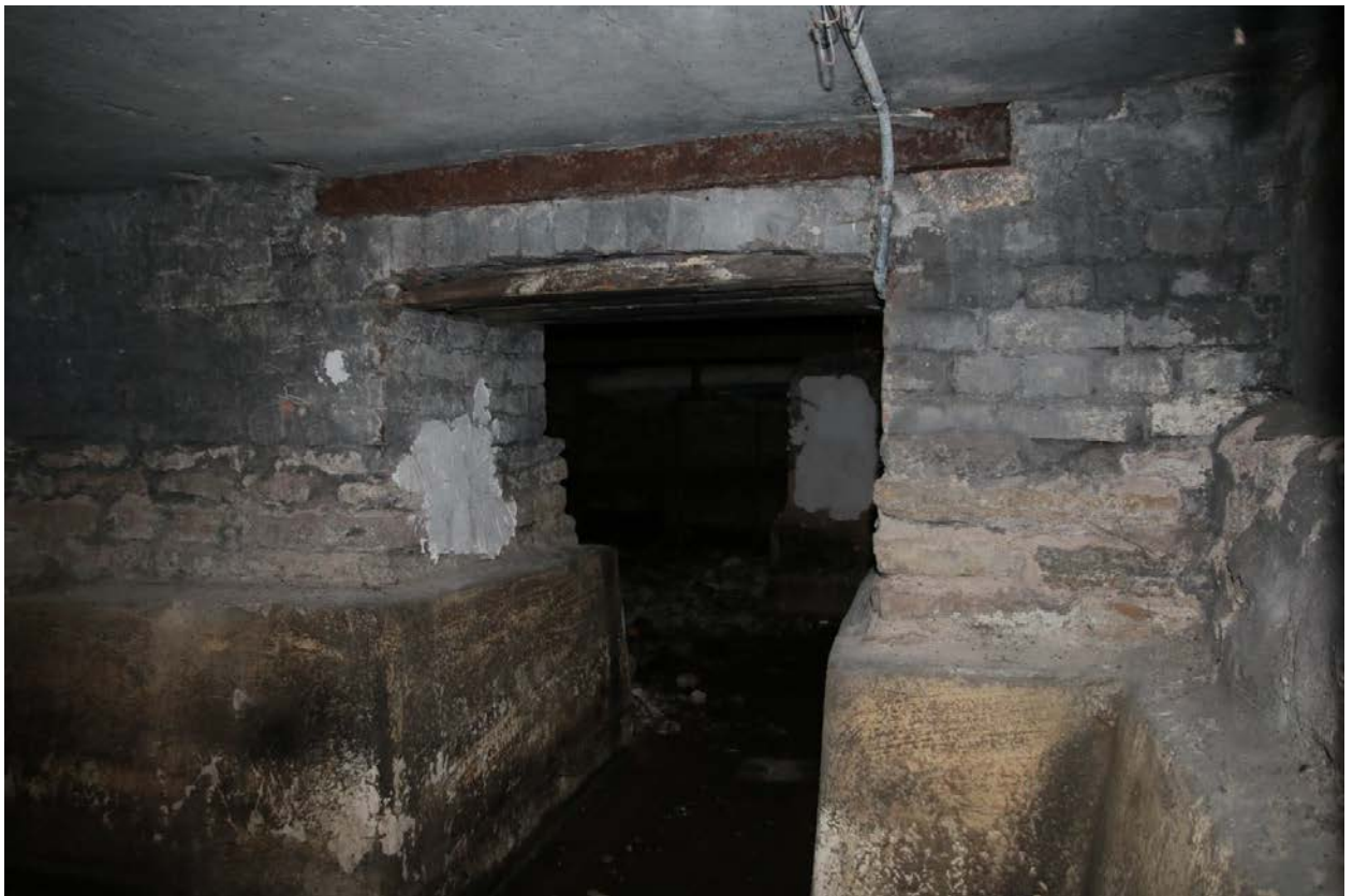
17. Фрагмент интерьера подвального помещения
