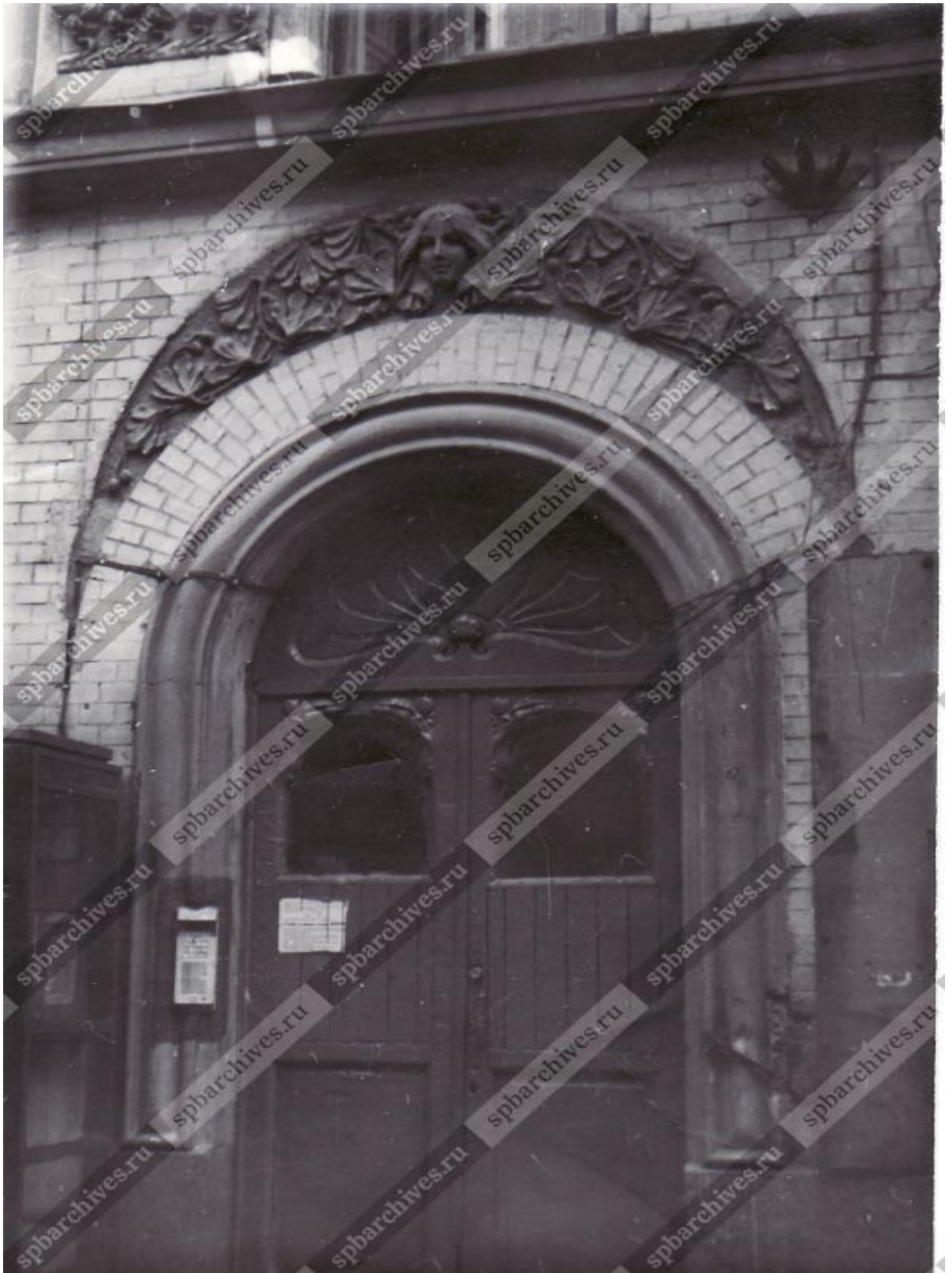
21. 1986 г. Парадный вход в дом по ул. Рубинштейна, 4. Фасад дома по ул. Рубинштейна, 4. ЦГАКФФД СПб, Ар 217844.
