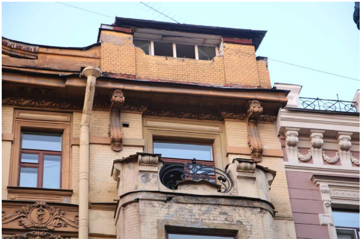
4. Фрагмент главного фасада. Вид с запада
