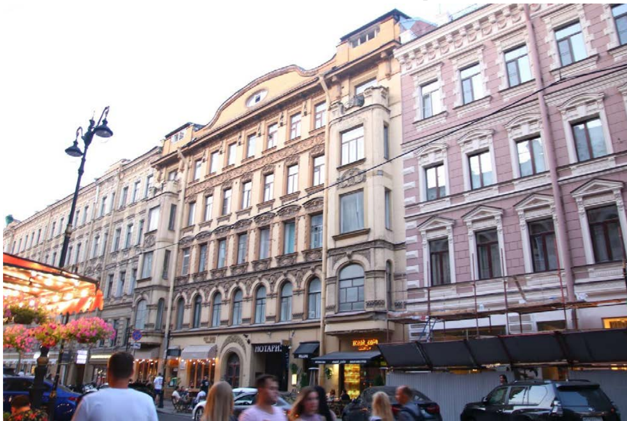
1. Общий вид главного фасада с улицы Рубинштейна. Вид с юго-запада
