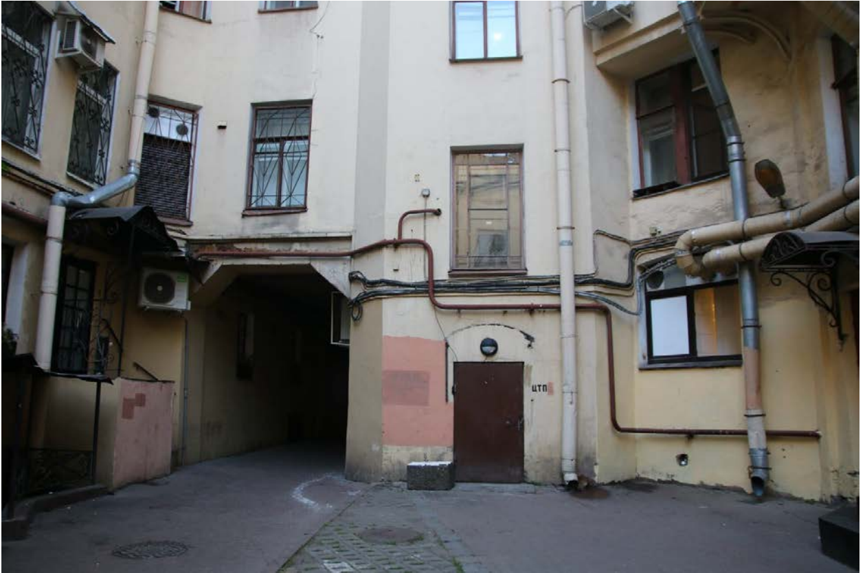
8. Фрагмент фасада внутреннего двора. Проездная арка
