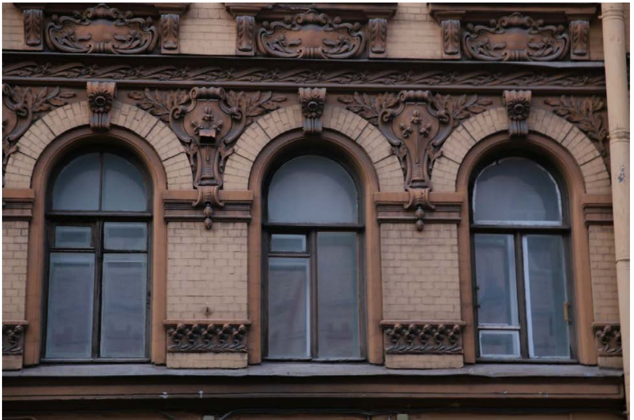
6. Фрагмент главного фасада. Оформление окон второго этажа
